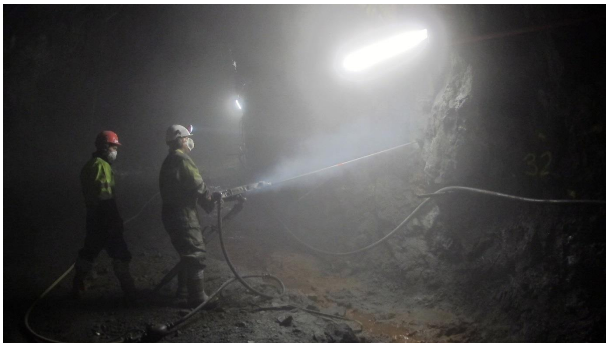
Etablering av forsøksfelt i Oslofjordtunnelen - boring av boltehull med knemater
