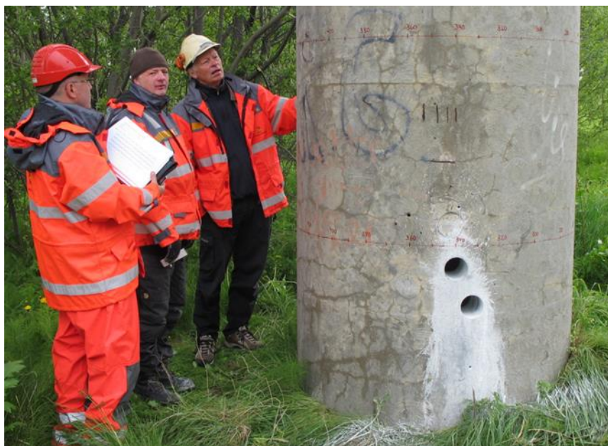
Feltarbeid på Tromsøbrua. Bård Pedersen, Tunnel og betong sammen med Olaf Sandnes og Knut Davidsen fra Region nord. Foto: Eva Rodum
