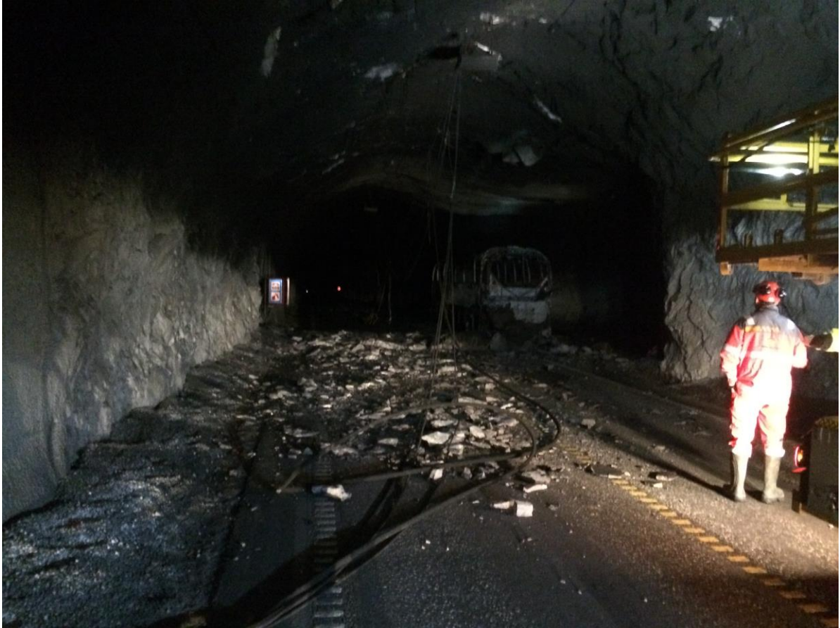
Bilde 5 Utbrent buss i Gudvangatunnelen, Foto Lars I Menes, Statens vegvesen
