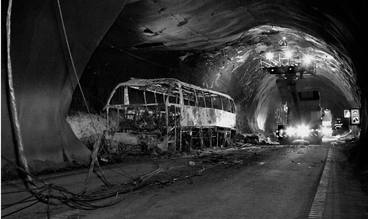
Bilde 6 Bussen var helt oppbrent etter brannen i Gudvangatunnelen i 2015. Foto: Arild P Søvik, Statens vegvesen
