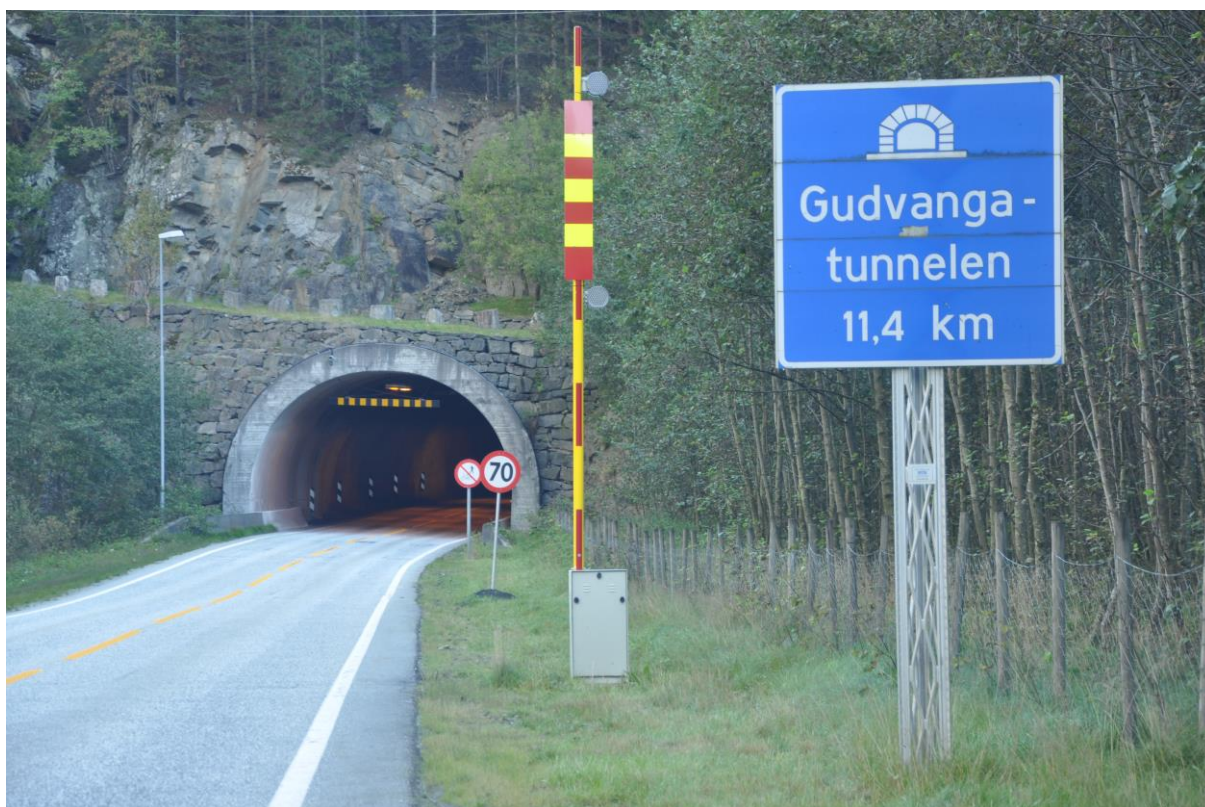
Bilde 4 Portal og innkjøring til Gudvangatunnelen, Foto: Kjell Voll, Statens vegvesen
