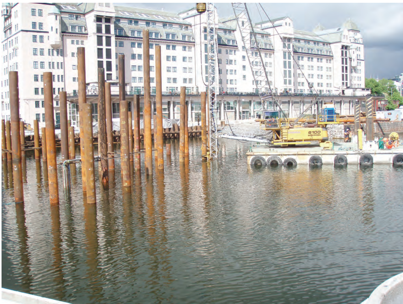
Figure 3.2.8 Fra arbeid med peler for grunnforsterkning
