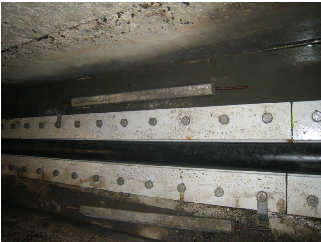
Figur 7.7- Montert Omegapakning fra innsiden.
