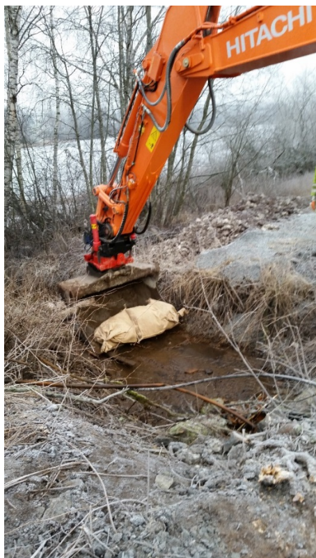
Figur 146. Jernmold i striesekkar blei lagt ut nedstraums ved utløpet i Horgenbekken ved utløpet til Jarevatn.
