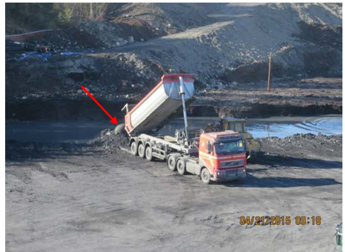
Figur 81. Bilde til venstre viser ein doser som skyv utlagd alunskifer ut i masselageret. Bilde til høgre viser ein lastebil som tippar eit lass av alunskifer ved fyllingsfronten. Pila i biletet til høgre viser ein konkresjon («bolle») med ein diameter på rundt ein meter. I masselageret blei det lagt ut fleire slike i ulike storleikar.
