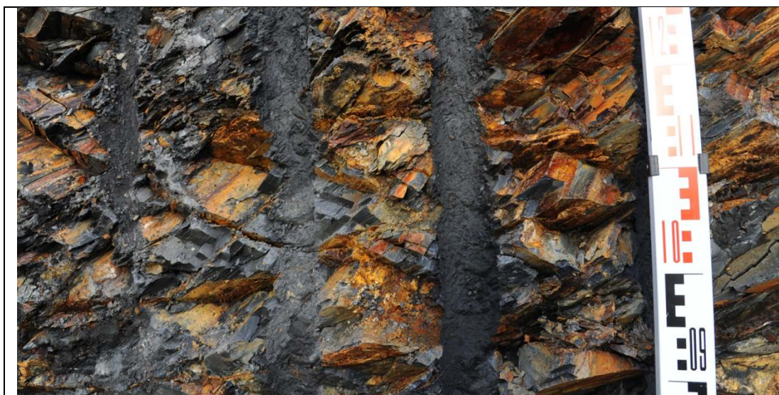
Figur 35: Galgebergledet i Tøyen fm, utsnitt av figur 34. Legg merke til oppsprekkingsmønster og farge på sprekkeflater. Snittet er fra ca 1 meter under skiferoverflaten (se figur 34 og 36).
