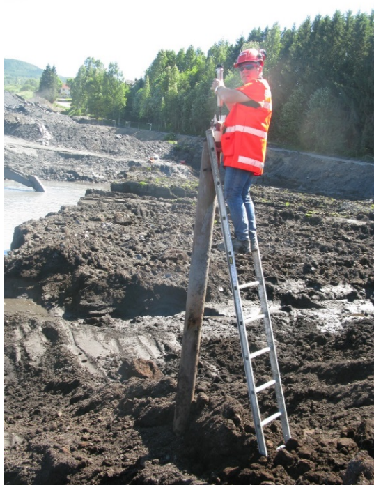
Figur 46. Her er kontrollingeniøren i ferd med å fjerne måleutstyr i brønn nr. 6. Som det kjem fram av biletet er det øvste torvlaget rundt brønnen allerede fjerna.
