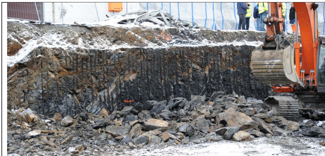
Foto 34: Overgang mellom Galgebergledet (svartskifer) til høyre og Huk fm (lysere grå til venstre). Skjæringen ble vurdert å være så ustabil at det ble etablert forbud mot å bevege seg nærmere enn to meter fra skjæringskanten over og under skjæringen.
