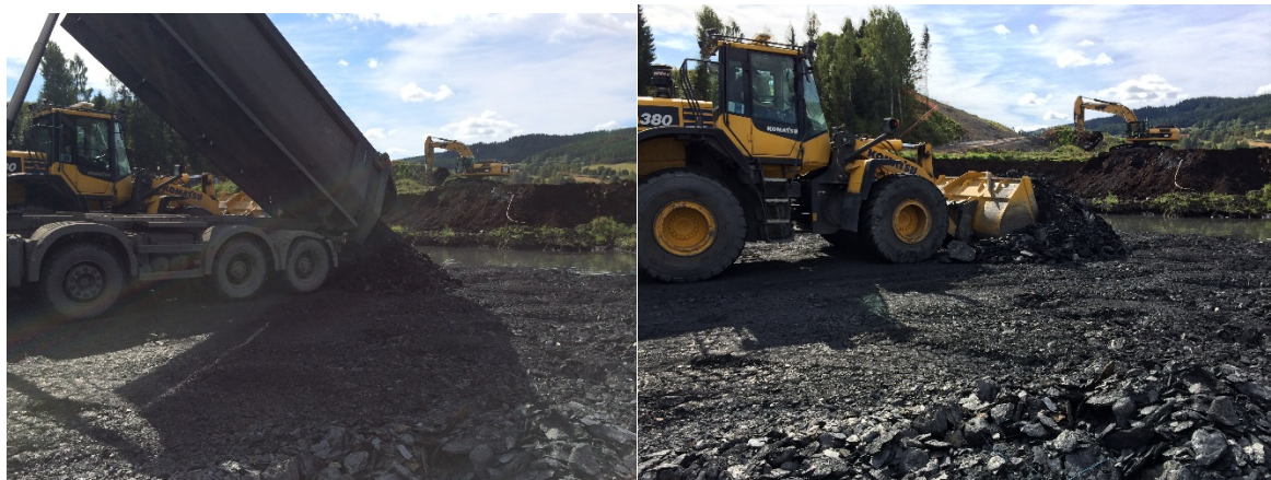
Figur 55 tømning av lass med alunskifer og dosing av massane ut frå fyllingstippen.
