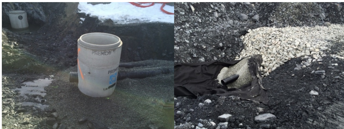
Figur 83. Utlegging av drenering langs veggana.
