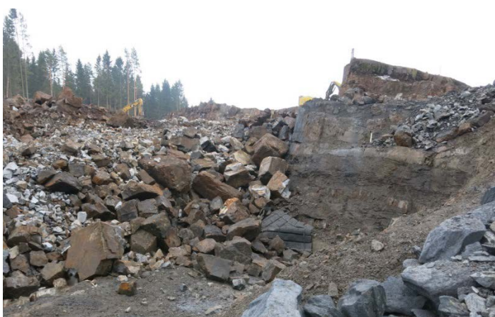
Figur 36. Området ved Nordtangen etter sprenging 27.02.2014 – Eit skiferlag kjem til syne til høgre i biletet.
