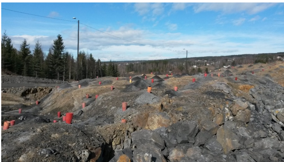
Figur 38. Ladehol med borkaks i den nordre Nordtangen-skjeringa. Det blei gjort XRF-analyser på borkakset med svartast farge. Dette var ikkje deponipliktig (sjå resultat i tabell 16 nedanfor).
