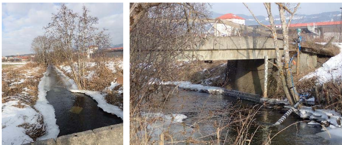
Bilde 3: Målestasjonen "HAS" stod plassert ved bro der Haslerudgutua krysser Vigga.
