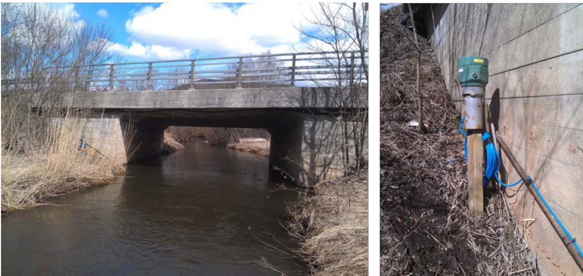
Bilde 2: Målestasjonen "Vigga nedstrøms - VN". Stasjonen er plassert nedstrøms anleggsområdet ved Hofsbrua. Stasjonen vil fange opp avrenning fra Vøien, tunnelpåslaget og avrenning fra Gran sentrum.
