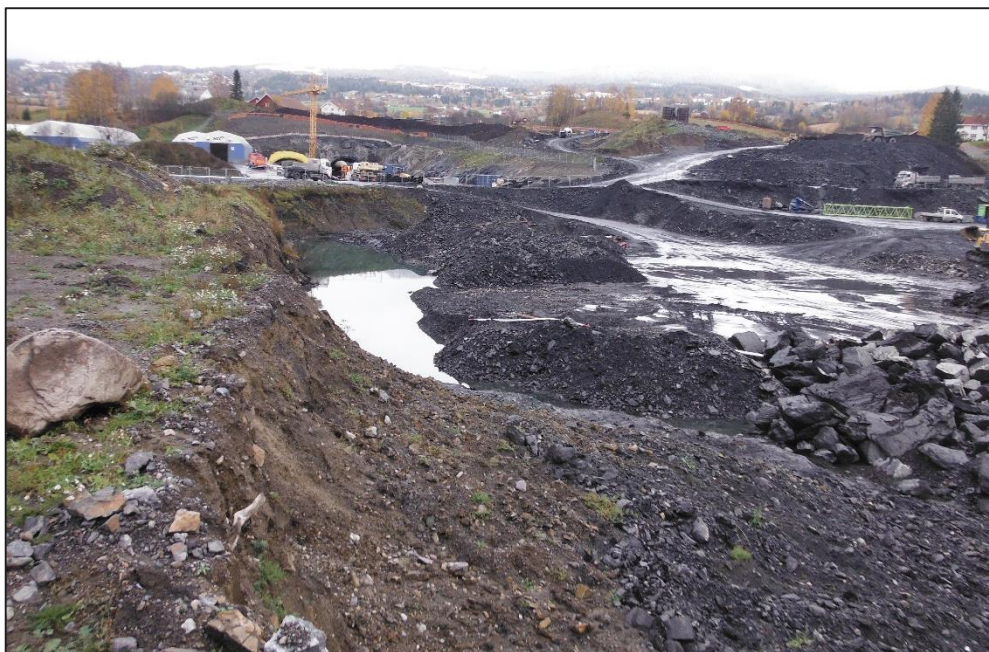
Figur 1. Deler av anleggsområdet, utenfor tunnelåpningen, langs ny Rv. ved Gran i Oppland fylke. Deponering av alunskifer vil foregå i myrområdet utenfor tunnelåpningen.
