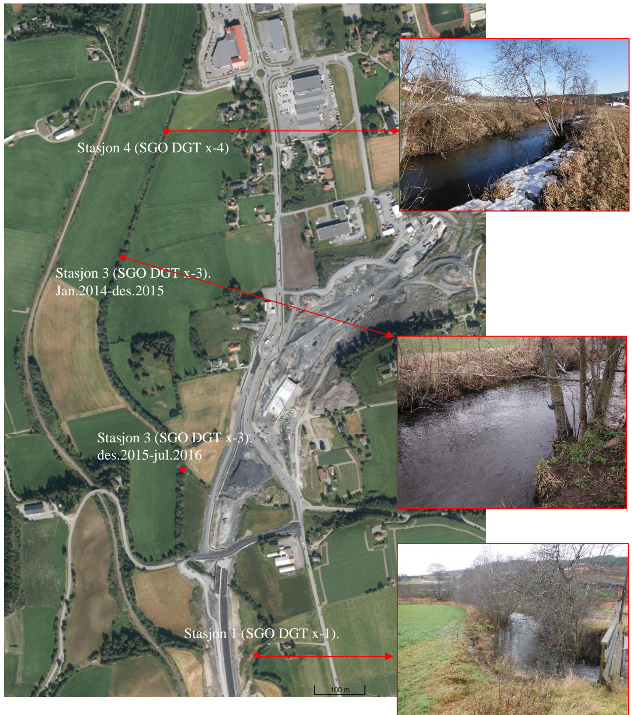
Figur 2. Lokaliseringen av tre prøvestasjoner for utplassering av DGT for måling av fritt løste og labile metaller i Vigga i forbindelse med utbygging av ny Rv. 4 og etablering av alunskiferdeponi.
