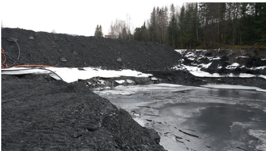
Figur 78. Skifermassar frå alunskiferformasjonen som står på vent før dei skal masseutskiftast i masselageret. 20. mars 2015.
