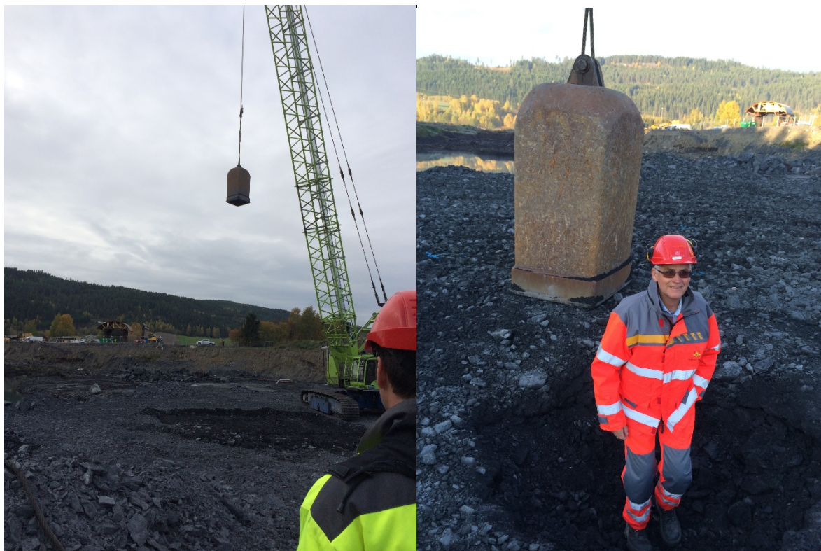
Figur 56. Forsøk med komprimering med fall-lodd.
