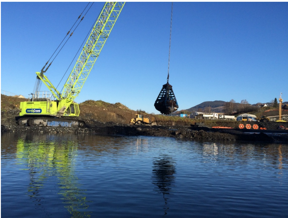
Figur 43. Utgraving av myr. De øverste to bildene viser ulike gravemaskiner, mens det store bilde nederst viser en beltekran med grabb.
