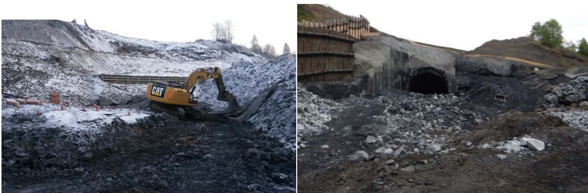
Figur 32. Sprengingsarbeid ved nordre tunnelpåhogg ved Horgenmoen 09.12.2014 (til venstre) og ved påhogget etter gjennomslaget i slutten av mai 2015 (til høgre).
