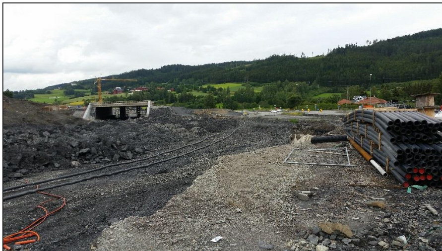
-Figur 1. Deler av anleggsområdet, utenfor tunnelåpningen, langs ny Rv. ved Gran i Oppland fylke. Deponering av alunskifer vil foregå i myrområdet utenfor tunnelåpningen.
