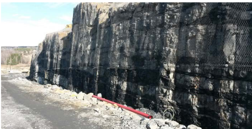
Figur 39. Den ferdige skjeringa ved Nordtangen nord.
