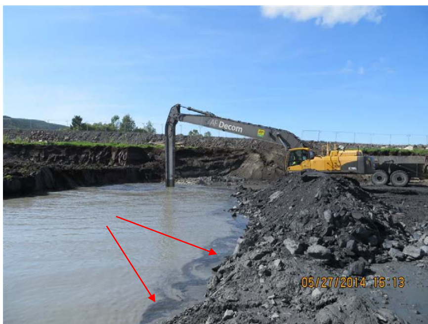
Figur 96. Finstoff flyt på vassoverflata etter utlegging av Galgebergskifer.
