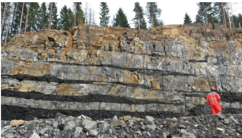
Figur 37. Området ved Nordtangenskjeringa (sør) etter ferdig sprenging. Lenger ned i skjeringa auka tjukkelsen på alunskiferlaga.
