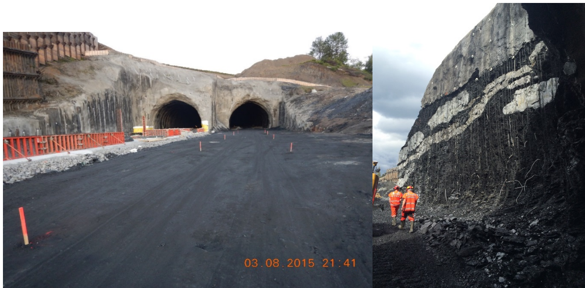
Figur 33. Tunellpåhogget etter at sprengingsarbeida var over. Alunskifer blei jevna ut opp til trau. Biletet til høgre viser stabben mellom dei to tunnellopa før denne blei heilt dekkja av sprøytebetong. Mænaitten (ultra finkorna syenittisk bergart) er tydelig som kvite lag i alunskiferen.
