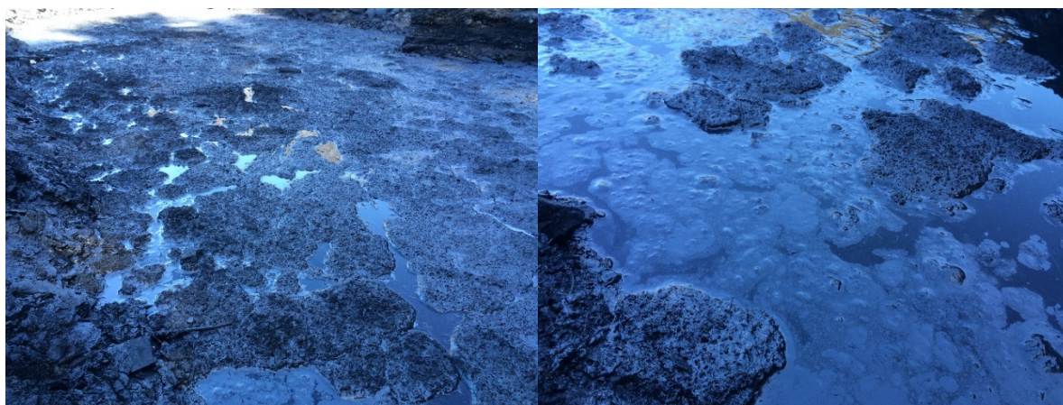
Figur 97. Flotasjonsmasse på vatn i byggegropa etter utlegging av alunskifer. Etter utlegging av alunskifer auka omfanget av finstoff som flaut på overflata og samla seg i større einingar.
