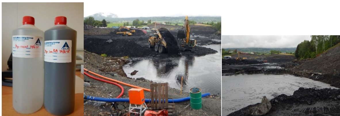
Figur 129. 18. juni blei alunskifer på mellomlageret fylt rett ved pumpa. Då var vatnet ganske turbid i sedimentasjonskonteinarane, og reinseanlegget blei starta. Som følge av skiferdeponering like ved, hadde vassprøven eit høgt innhald av suspendert stoff. Den blå slangen til venstre, blei brukt ved utpumping av vatn frå masselageret.
