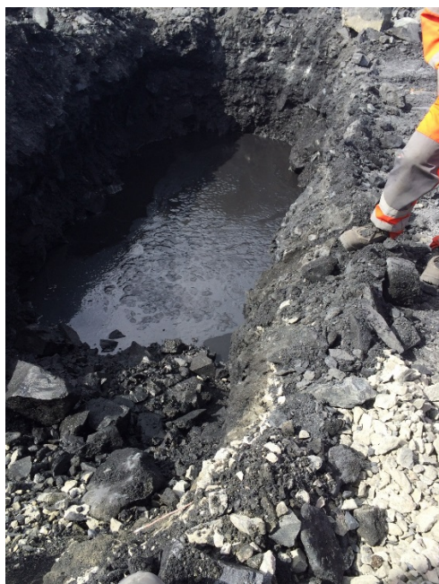
Figur 99 Graving av ei grøft for slangar for setningsmålingar. Biletet viser at noko av den fine nedknuste alunskiferen dannar eit belegg på toppen av vasspegelen og følgjer dette.
