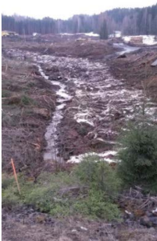
Figur 139. Nordtangenbekken i starten av anleggsperioden (vinter 2014). Det blei lagt ut kalk langs bekkekanten som eit tiltak for å unngå sur avrenning frå området for sprengningsarbeida.
