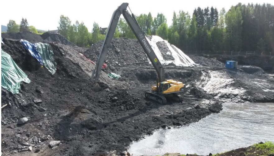
Figur 77. Massane på biletet er skifer frå galgeberg-leddet. 21.mai 2014. I denne perioden måtte massar mellomlagrast på grunn av at fleire salver med Galgebergskifer kom etter kvarandre på kort tid. Gravemaskina brukt til utfylling hadde begrensa kapasitet.
