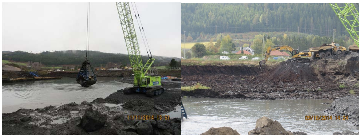
Figur 48 Utgraving av myrmassar under vatn med grabb hengande frå beltekran og vanleg gravemasking over vatn.
