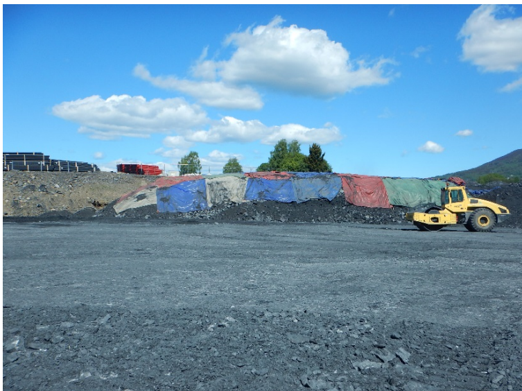
Figur 79. Mellomlagra massar av alunskifer før dei blei lagt i masselageret. 16.06.15. Ein vassett duk blei lagt over massane i ventetida før dei blei deponert. I framre deler av biletet er dekkmassar fylt over alunskiferen.
