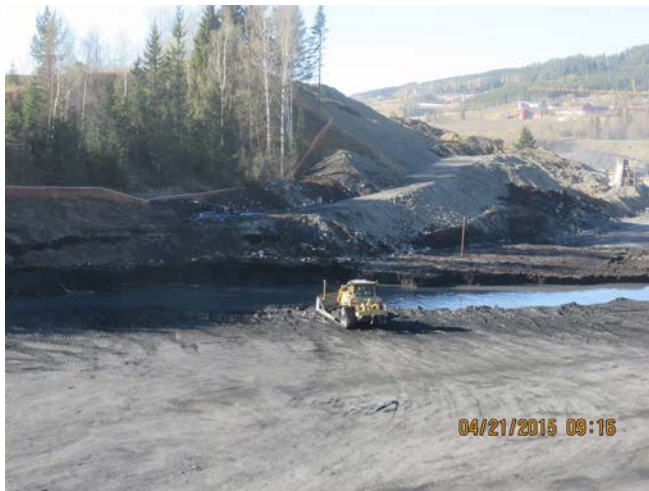
Figur 81. Bilde til venstre viser ein doser som skyv utlagd alunskifer ut i masselageret. Bilde til høgre viser ein lastebil som tippar eit lass av alunskifer ved fyllingsfronten. Pila i biletet til høgre viser ein kongresjon («bolle») med ein diameter på rundt ein meter. I masselageret blei det lagt ut fleire slike i ulike storleikar.
