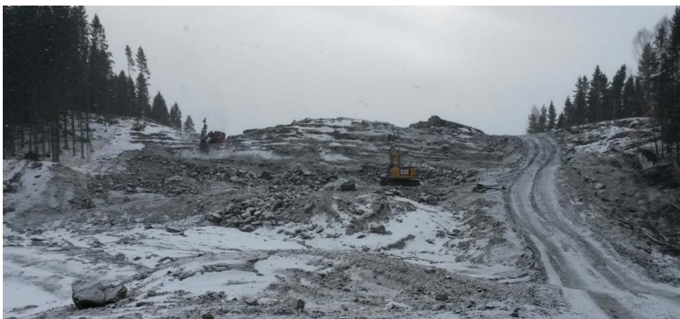
Figur 34. Området ved Nordtangen skjeringa (sør) ved starten av sprengingsarbeida, 19.02.2014.
