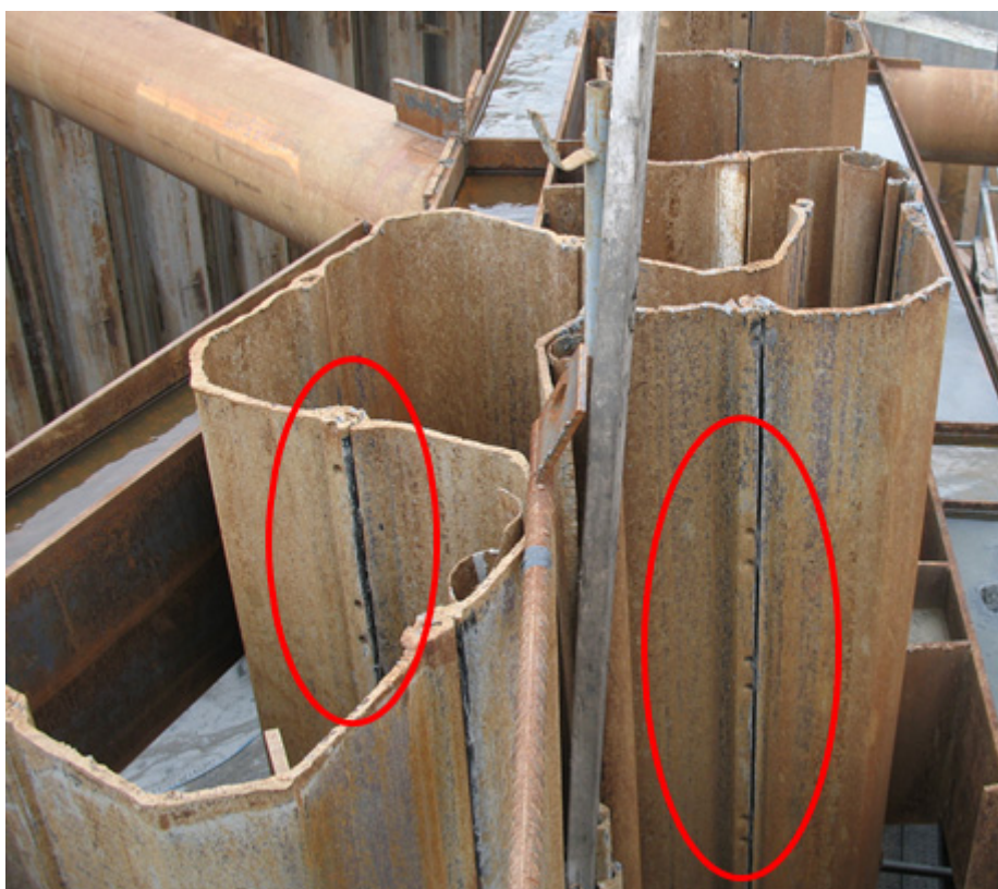
Figur 70: Klinking av spuntlåser
