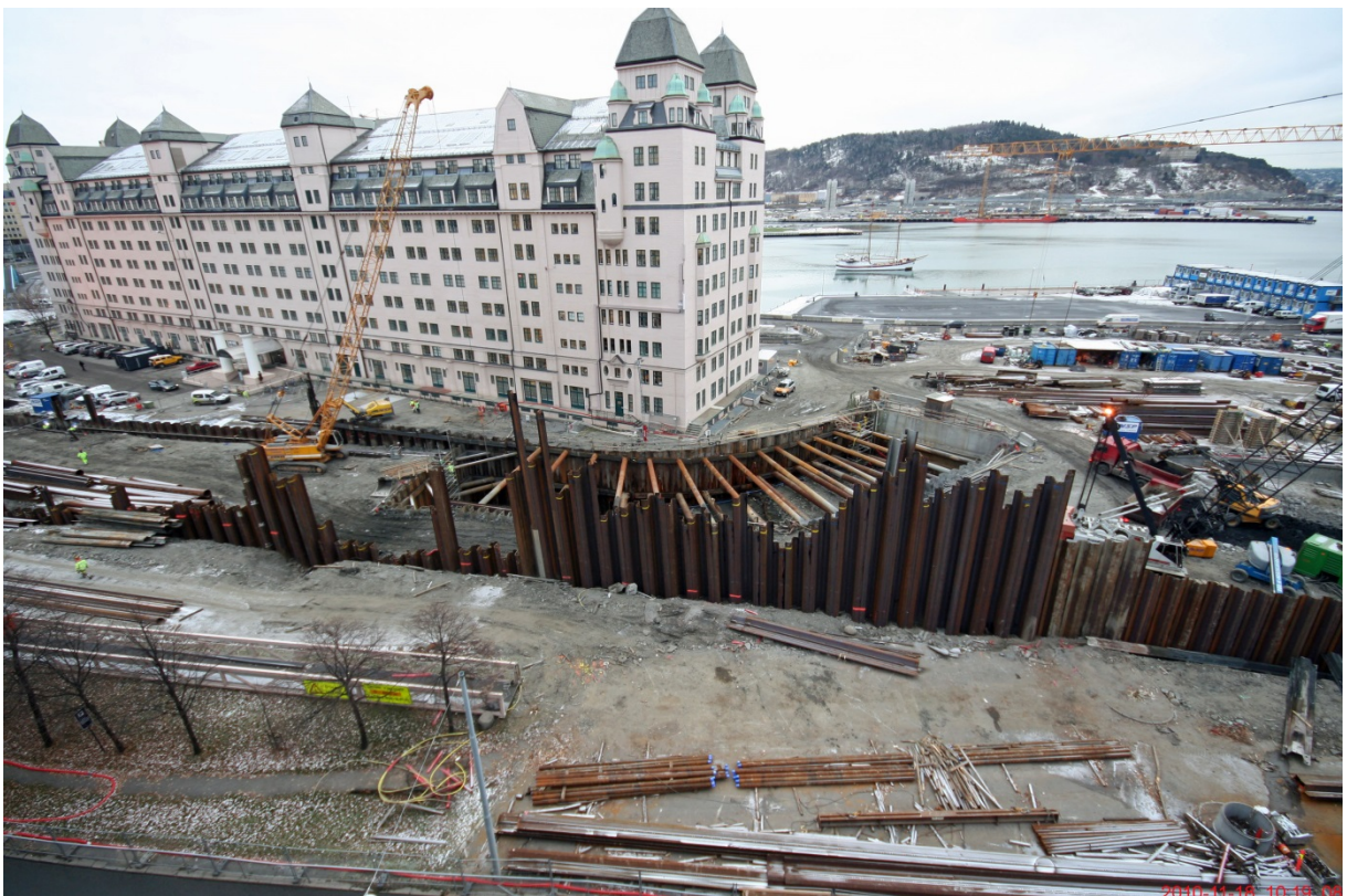
Foto 13: 18.11.2010 - Spunting videre mot Rådhusgata. Spunt ned mot Festningstunnelen. Utgraving av grop mot Havnelagerbygget
