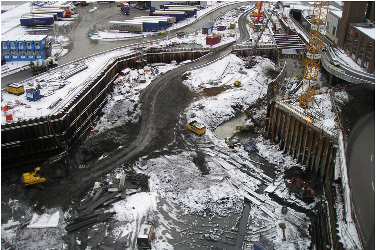
Foto 5: 12.01.2007 - Endespunt Festningstunnelen ferdig frigravd. K102 ferdig utgravn
