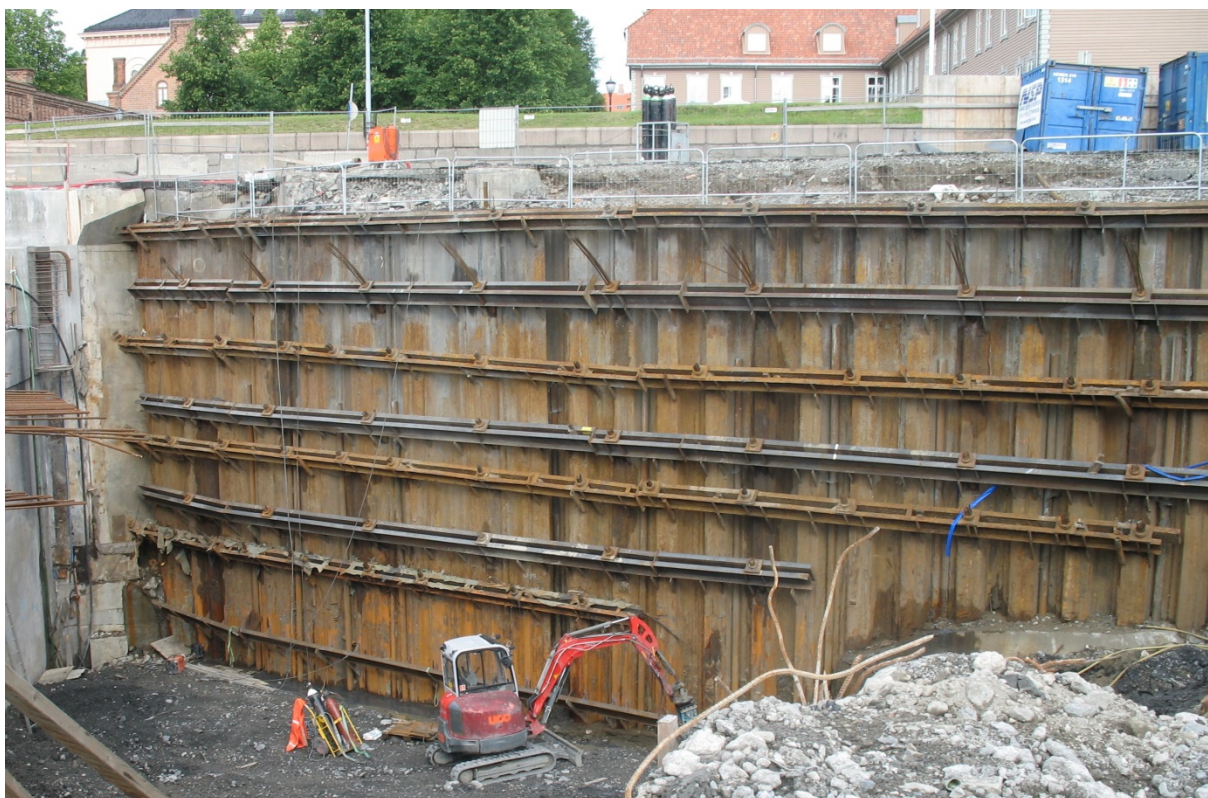
Figur 82: Spunt fra Festningstunnelen med nye stagrader
