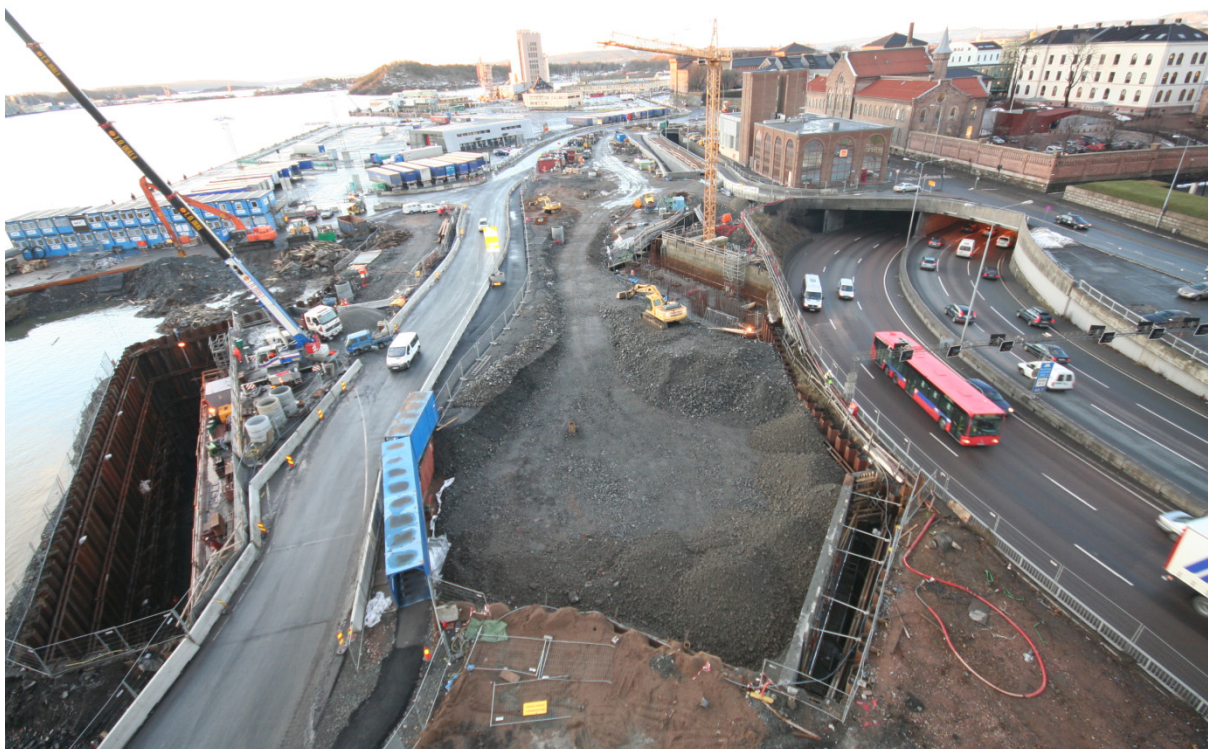
Foto 8: 11.01.2008 - Tilbakefylling. Teknisk rom ikke ferdig (inn mot Festningstunnelen)
