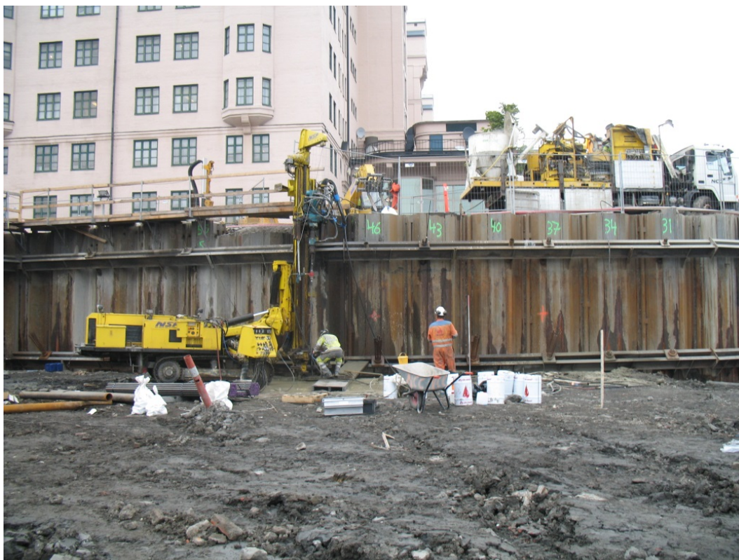
Figur 23: Løsmasseinjeksjon med Ischebeck stag
