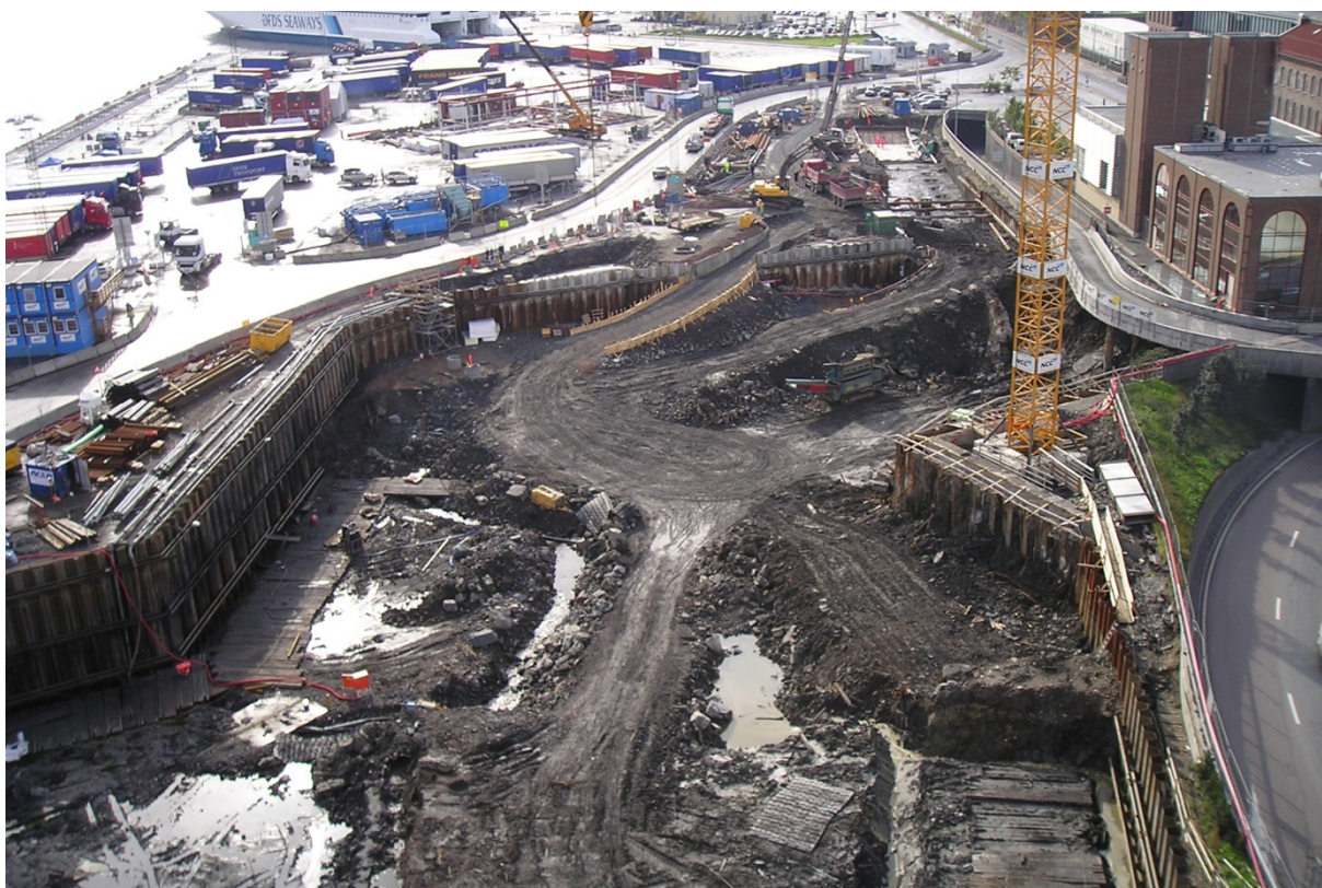
Foto 4: 28.09.2006 - Endespunt Festningstunnelen frigraves, K103 i arbeid, anleggsveg inn i gropa
