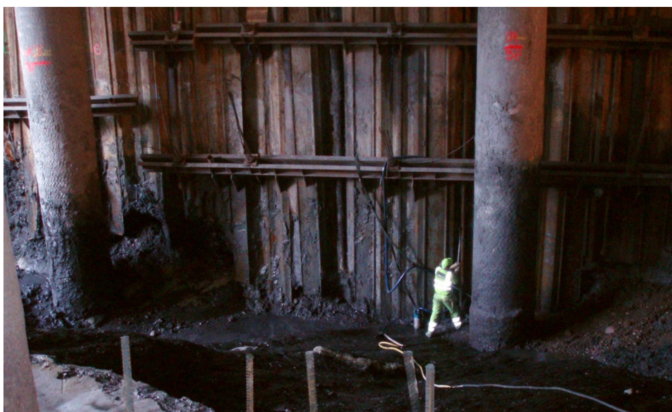
Figur 36: Pilarer og spunt fra Festningstunnelen
