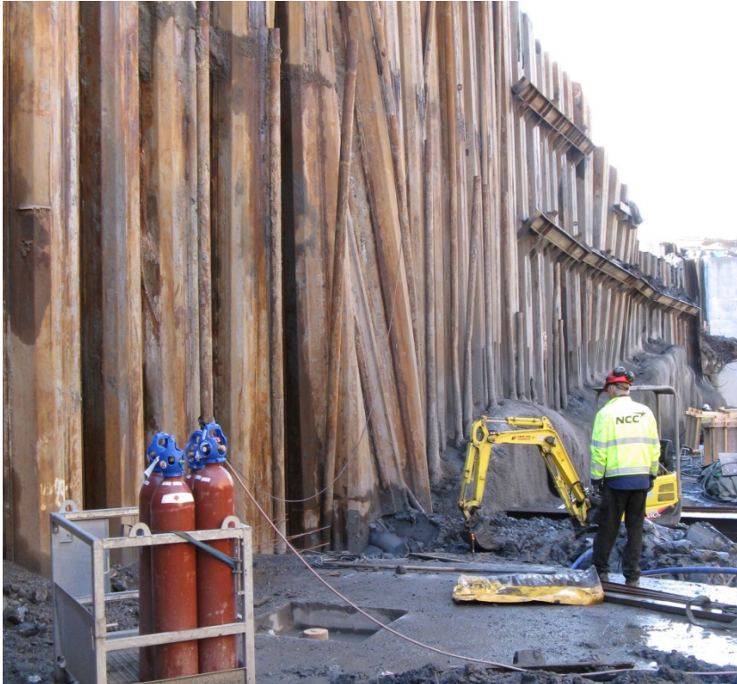
Figur 58: Brudd i fotbolt, pårampe til Festningstunnelen
