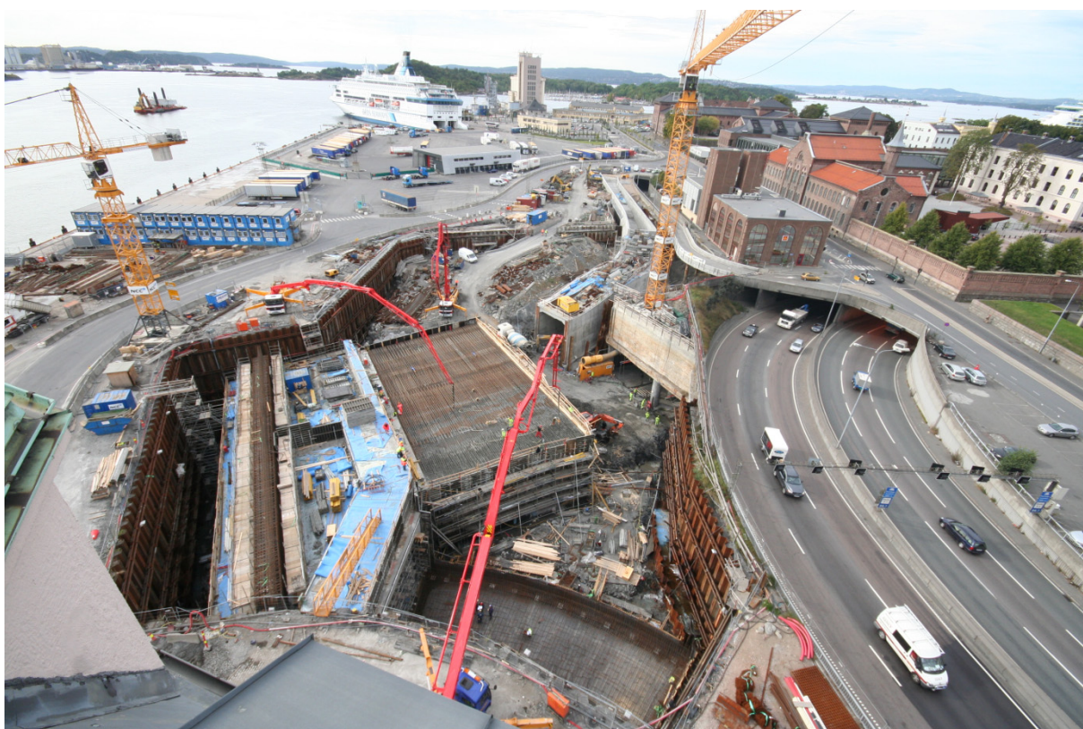
Foto 7: 06.09.2007 - Peling i hovedsak ferdig. Betongarbeider.
