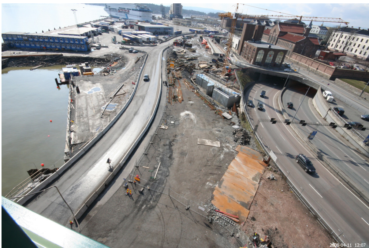
Foto 9: 11.04.2008 - Endespunt fjernet. Klar for første senketunnelelement.
