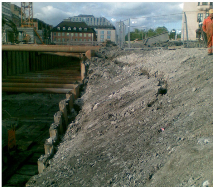
Figur 61: Deformasjoner av spunt ved pårampe
