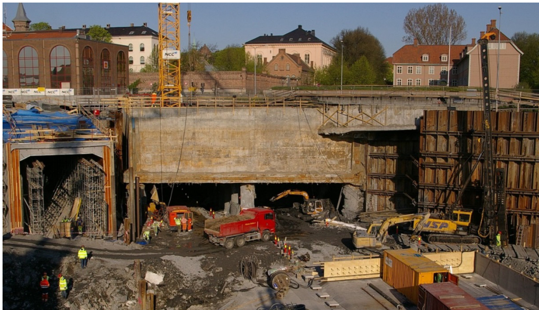
Figur 35: Utgraving under bunnplate på Festningstunnelen
