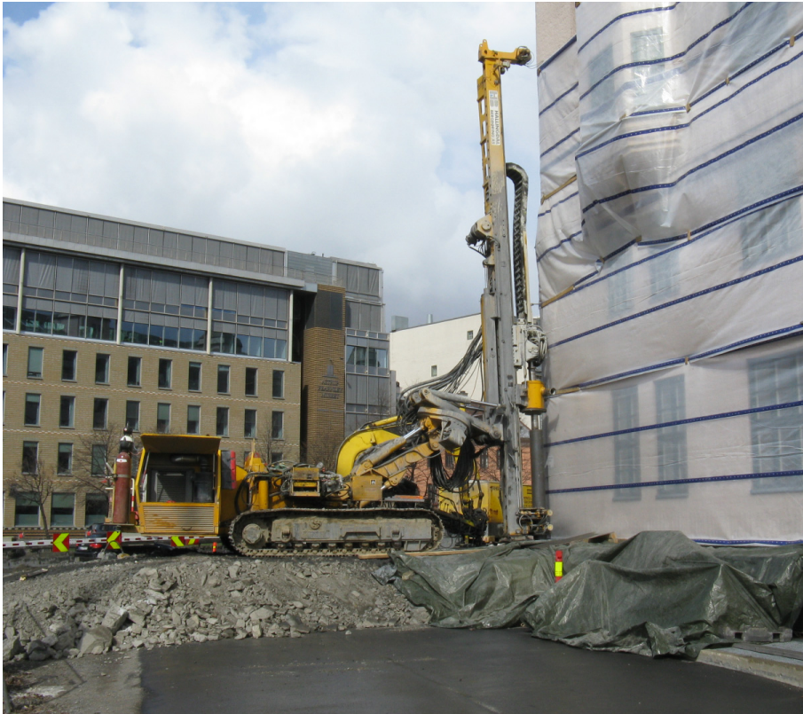
Figur 49: Boring for stålkernepelers inntil Havnelagerbygget:
