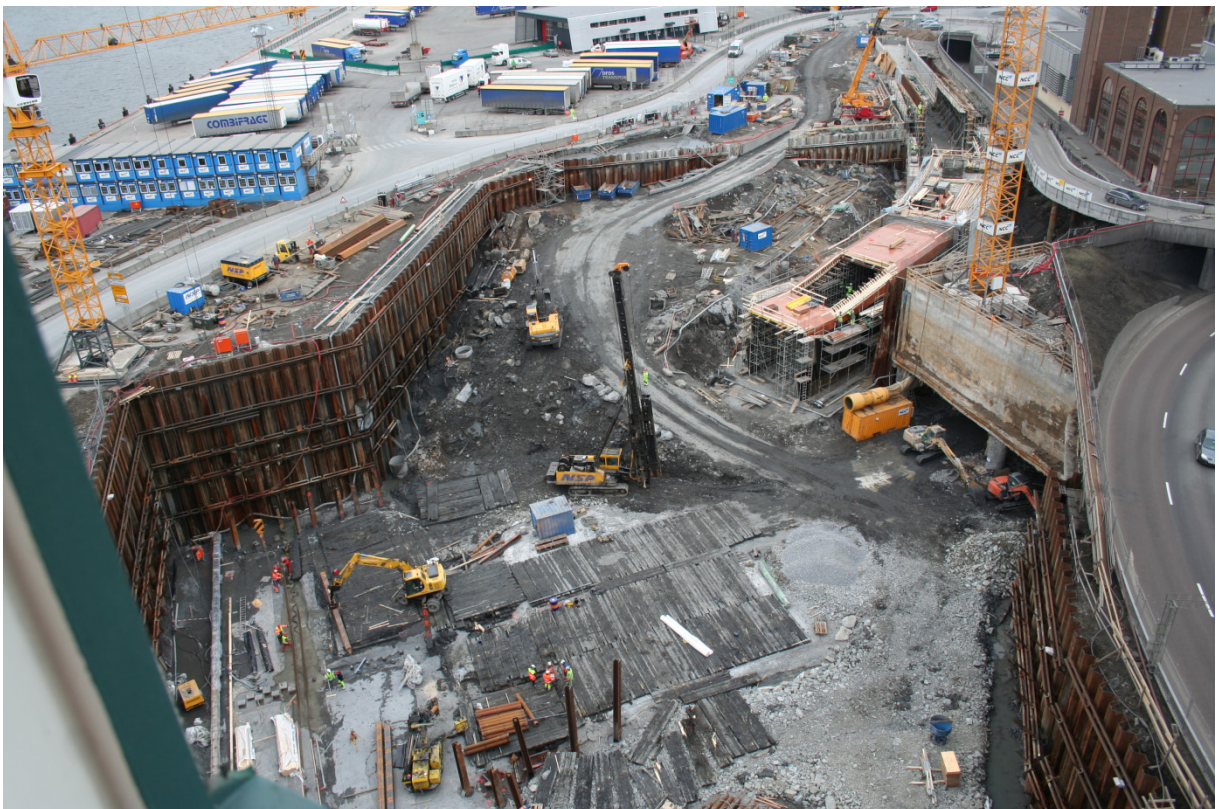
Foto 6: 16.03.2007 - Ferdig utgravn. Oppstart peling. Oppstart utgraving inn under Festningstunnelen.
