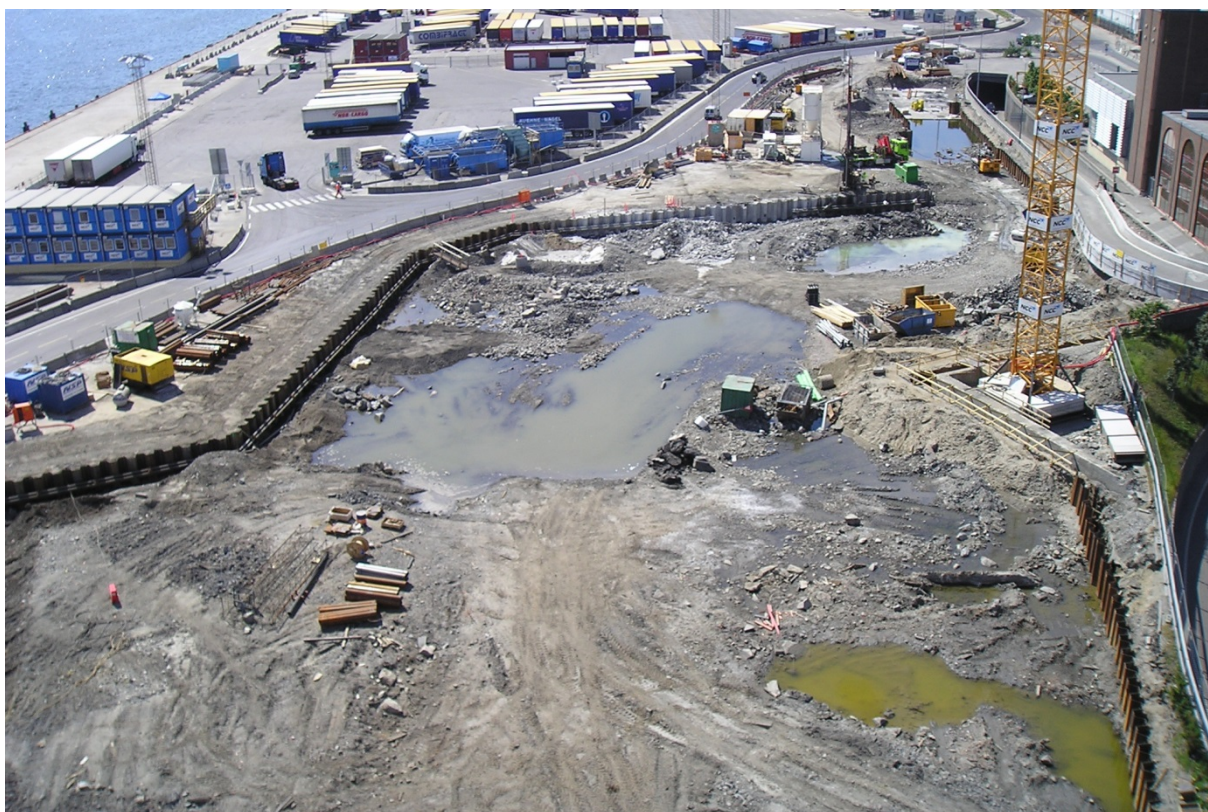
Foto 3: 16.06.2006 - Jetpeler settes i overgangen spunt og berg
