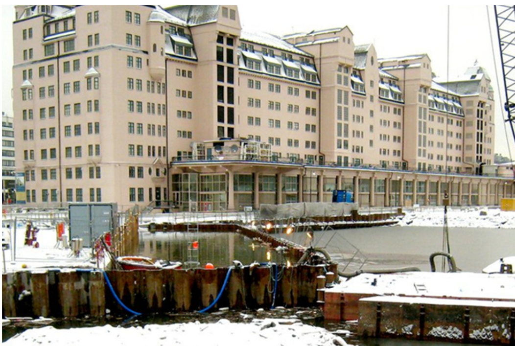
Figur 24: Vannfyllingstest, maksimal oppfylling med vann på endeskottet
