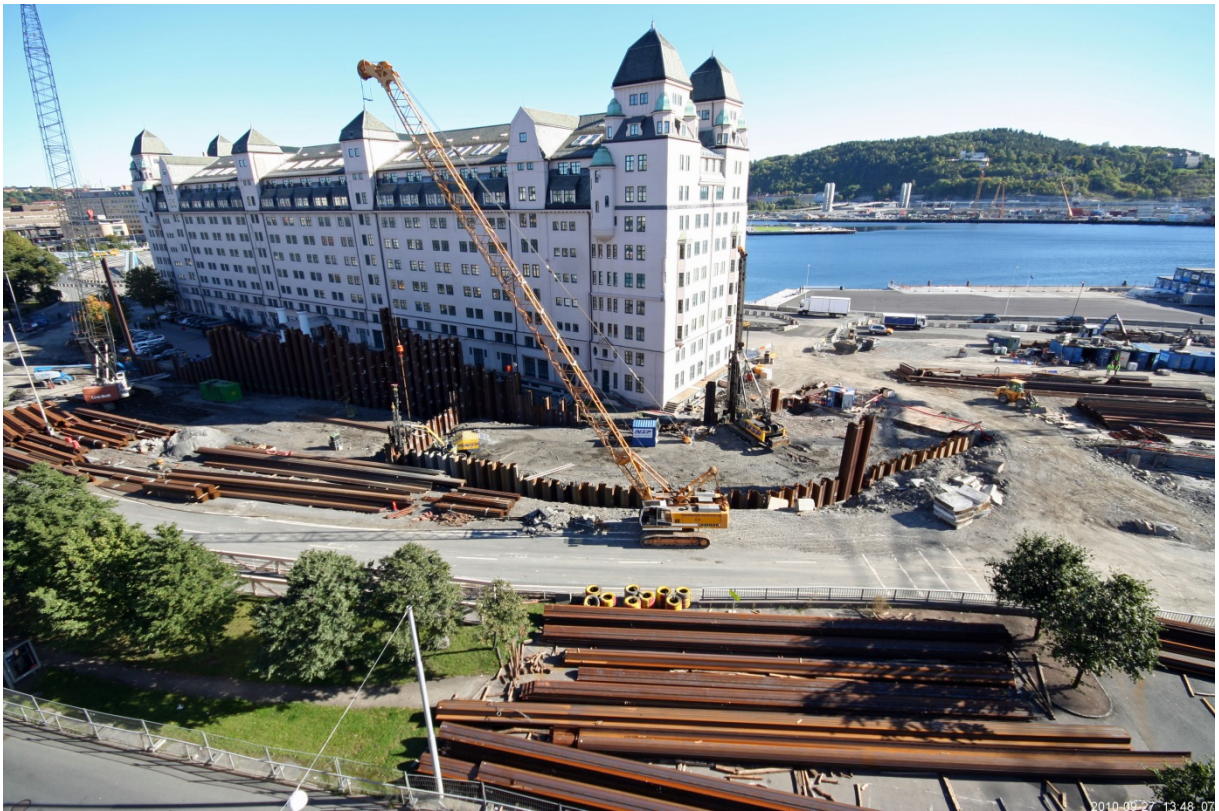
Foto 12: 27.09.2010 - E18 stengt, trafikk flyttet ned i senketunnelen. Tverrspunt. Etterramming av Hz-spunt.
