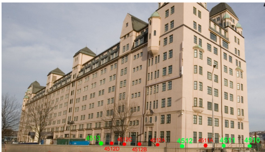
Figur 54: Plassering av setningsbolter på hjørnet
