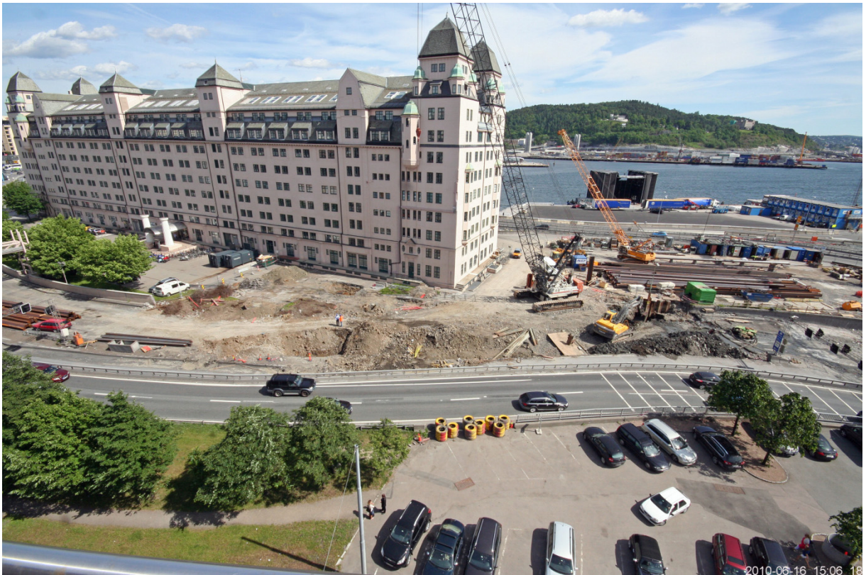
Foto 10: 16.06.2010 - Forgraving og oppstart spunting. Trafikk vestgående i Festningstunnelen
