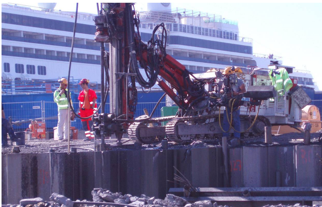
Figur 19: Installering av jetpeler ved spuntfot
