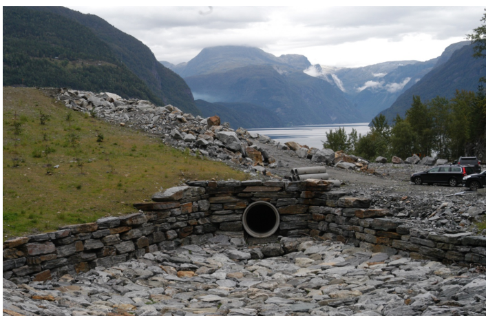
Figur 3: Skredmagasin. Foto: Geir Brekke
