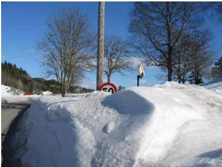
Figur 2-62 Fartsgrenseskilt delvis skjult av snø som har ligget en stund (Foto: Toralf Johansen)
