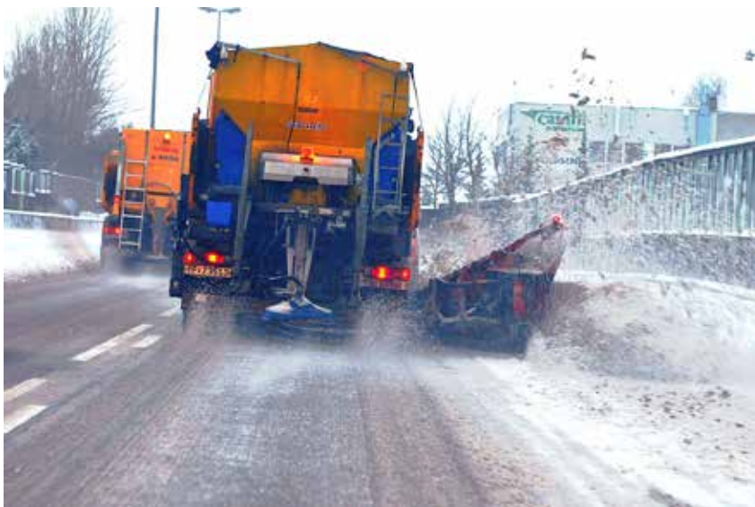
Figur 8-3 Anti-kompaktering – salting i forbindelse med snøvær (Foto: Knut Opeide, Statens vegvesen)
