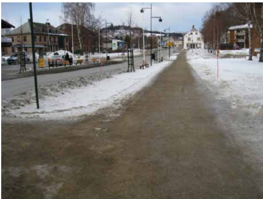
Figur 7-9 Eksempel på strøing av G/S-veg. (Foto: Øystein Larsen, Statens vegvesen.)
