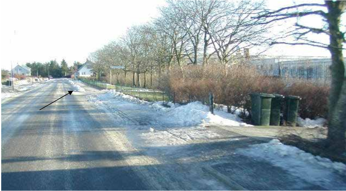
Figur 4-67 Lengst bort i bildet ser vi eksempel på riktig utførelse av brøyting av fortau
