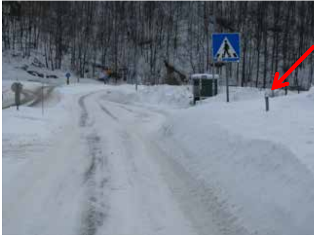
Figur 2-23 Manglende siktrydding mot kryssingspunkt på grunn av koblingskap i siktsonen (Foto: Arild Nærum)
