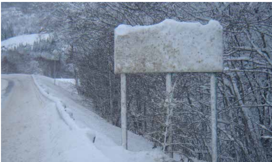
Figur 9-6 Snø på skilt som følge av sprut etter brøyting.
