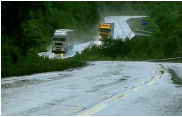
Figur 5-7 Friksjon på våt veg, \mu \approx 0,40-0,90 . (Foto: Knut Opeide, Statens vegvesen.)
