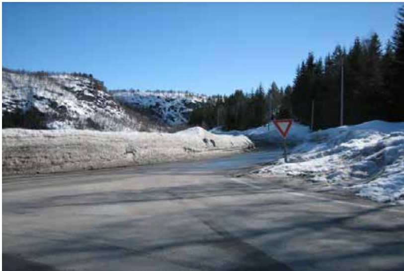
Figur 2-56 Manglende sikt i kryss (Foto: Risa)
