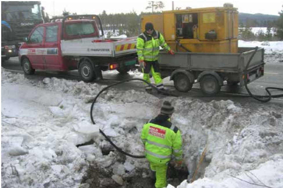
Figur 9-2 Tining av stikkrenne (Foto: Knut Magne Reitan)
