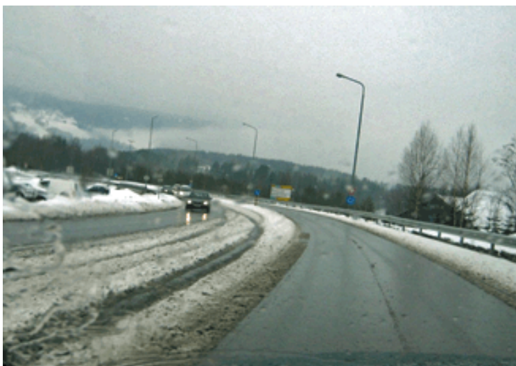
Figur 2-31 Dårlig brøytet forbikjøringsfelt (Foto: Statens vegvesen)
