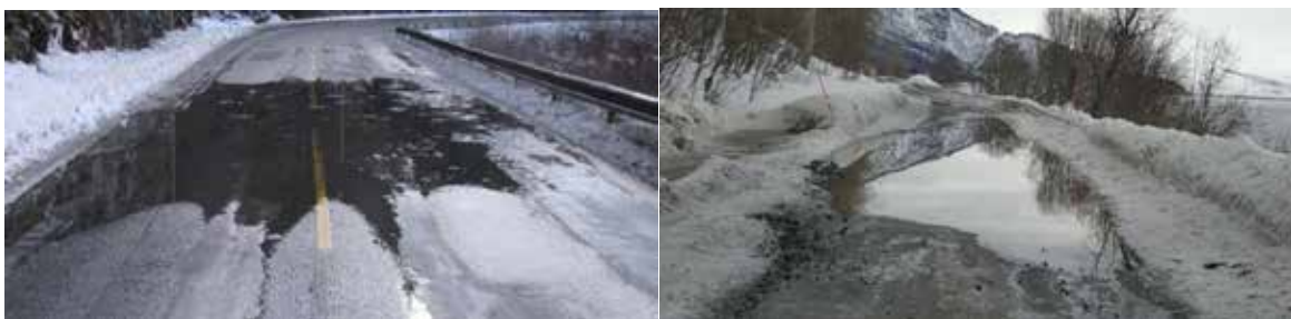
Figur 9-3 Snøkanter som hindrer avrenning (Foto: Leif J. Bakløkk, Statens vegvesen)
