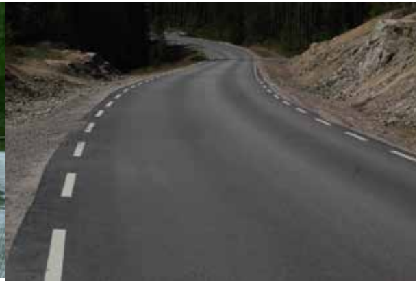
Figur 5-8 Friksjon på tørr veg, \mu \approx 0,90-1,00 . (Foto: Kjell Wold, Statens vegvesen.)
