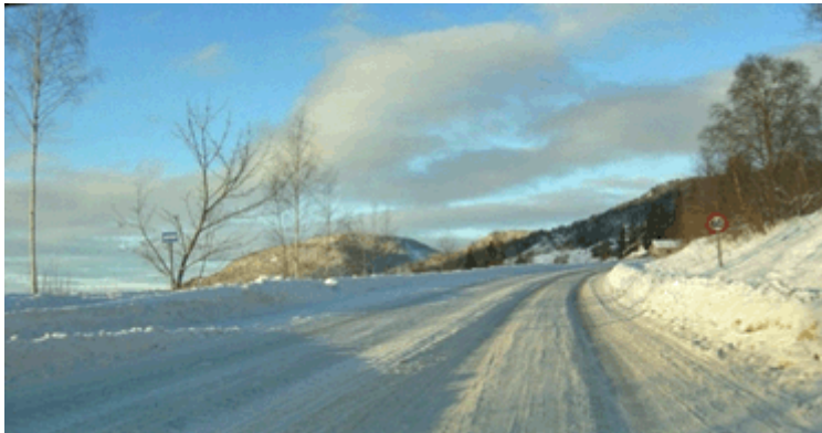
Figur 2-30 Sporete vegbane (Foto: Statens vegvesen)
