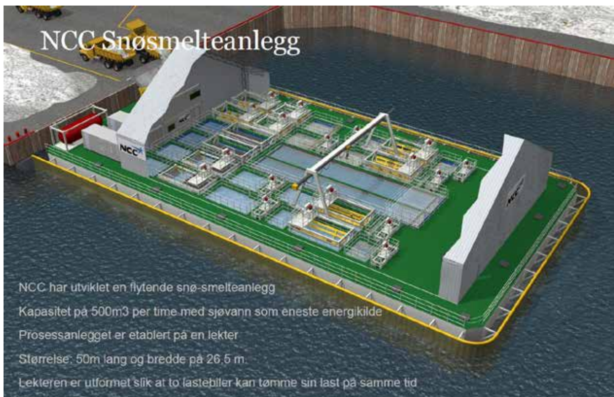
Figur 9-21 Storskala snøsmelteanlegg - Oslo havn (Kilde: NCC)
