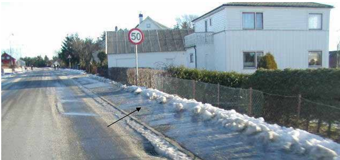
Figur 4-66 Eksempel på uheldig utførelse av brøyting av fortau
