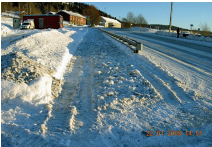
Figur 2-43 Brøyting av kjørebane etter gs-vegen. (Foto: Statens vegvesen)
