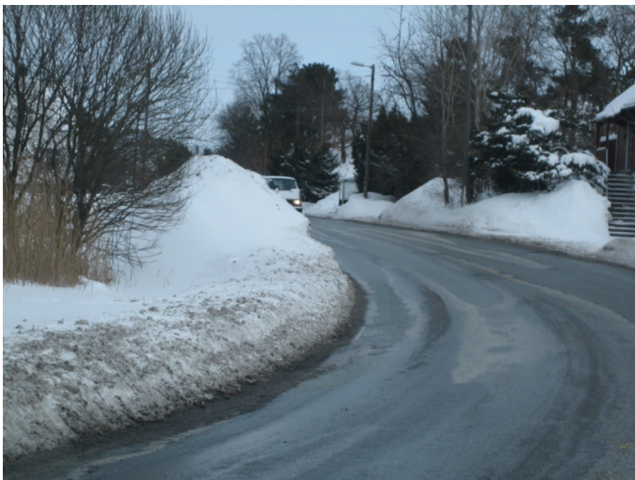
Figur 2-39 Manglende sikt rundt sving fra motsatt side av busslommen (Foto: Arild Nærum)
