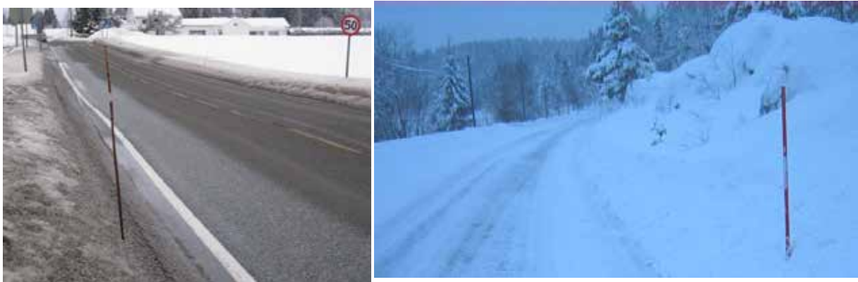
Figur 9-4 Riktig utsetting av brøytestikk er viktig for gjennomføring av vinterdrift
