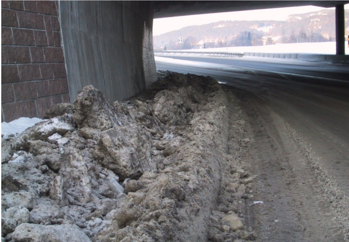
Figur 2-40 Ubrøytet fortau i undergang (Foto: Statens vegvesen)
