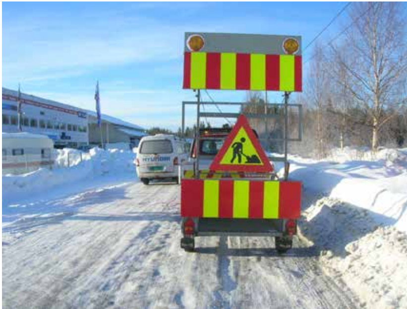
Figur 2-10 Arbeidsvarsling må gjennomføres etter retningslinjene
