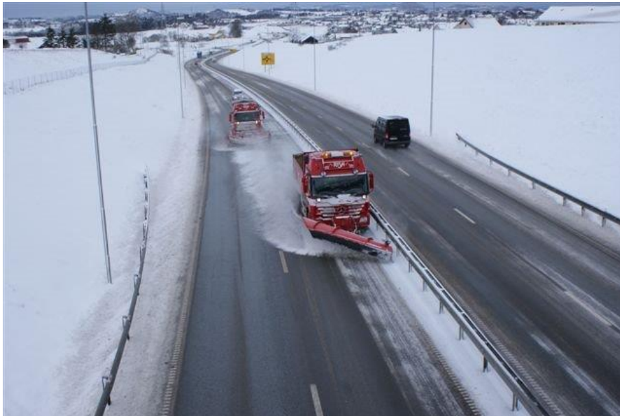
Figur 1-6 Vinterdriftsklasse DkA: Vegen brøytes og saltes slik at den blir bar kort tid etter snøfall (Foto: Risa AS)
