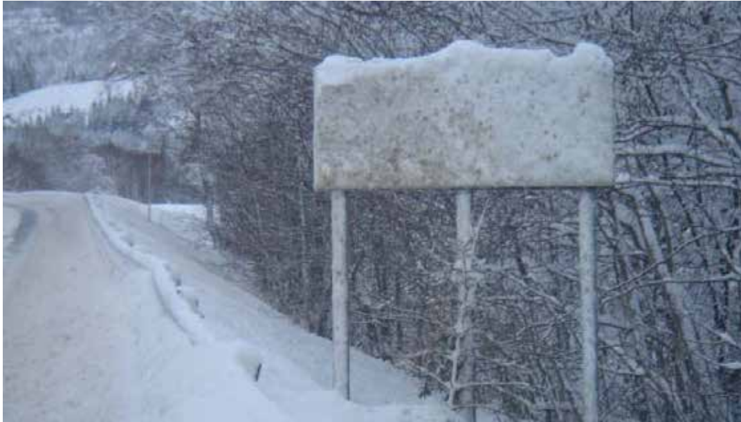
Figur 4-83 Nedsprutet trafikkskilt (Foto: SINTEF). Brøytefart over 40 km/t øker problemet med snø- og slapsesprut som dekker til skilt, og skader skilt, kantstolper, brøytestikk og andre installasjoner langs veien.
