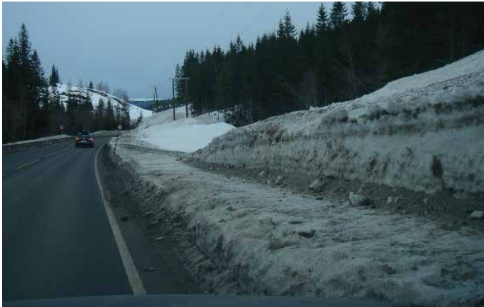
Figur 2-60 Fjerning av høye brøytekanter
