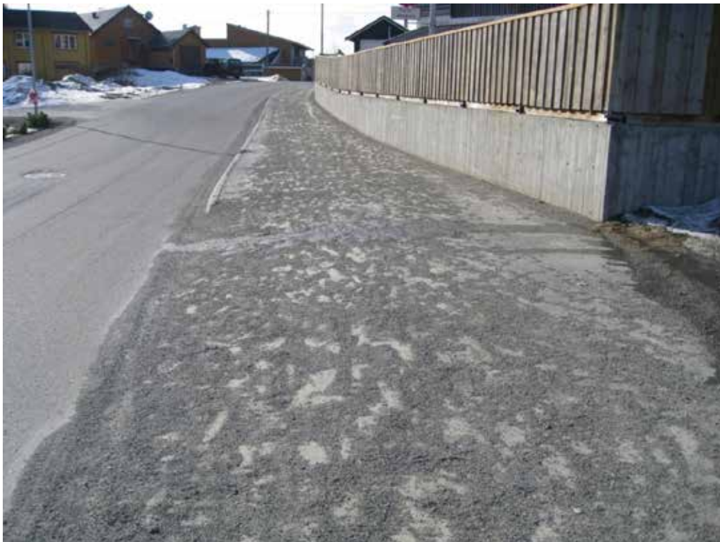
Figur 7-11 Her ligger det strøsand igjen fra hele vinteren. (Foto: Øystein Larsen, Statens vegvesen).
