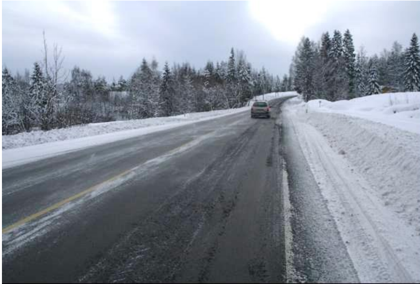
Figur 7-7 Kortvarig effekt etter strøing med saltblanda sand. (Foto: Anders Svanekil)
