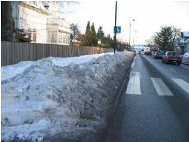
Figur 2-46 Manglende sikt og åpning i brøytekanten
