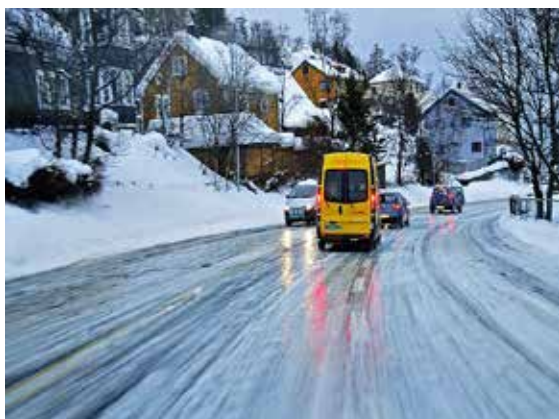
Figur 5-3 Friksjon på våt is, \mu \approx 0,05-0,15 . (Foto: Knut Opeide, Statens vegvesen)
