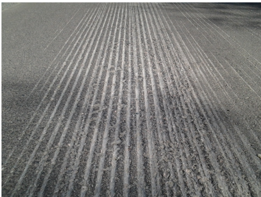
Figur 4-78 Dekkeskade grunnet uforsiktig høvling. (Foto: Håkon Svendsen)
