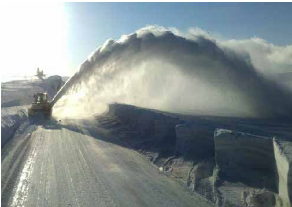
Figur 4-79 Fresing av brøytekanter, Ev6 Gratangsfjellet 2013 (Foto: Jan Lind, Statens vegvesen)
