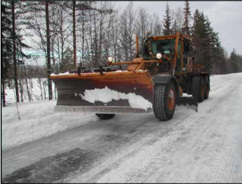
Figur 4-72 Veghøvel i arbeid
