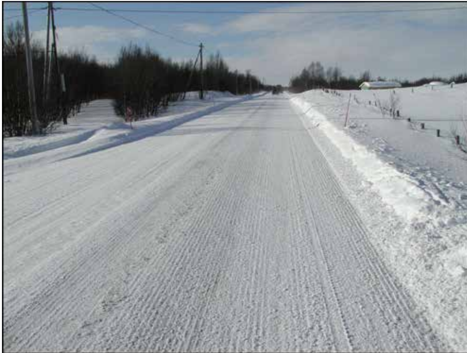
Figur 4-75 Snø- og isdekke etter høvling
