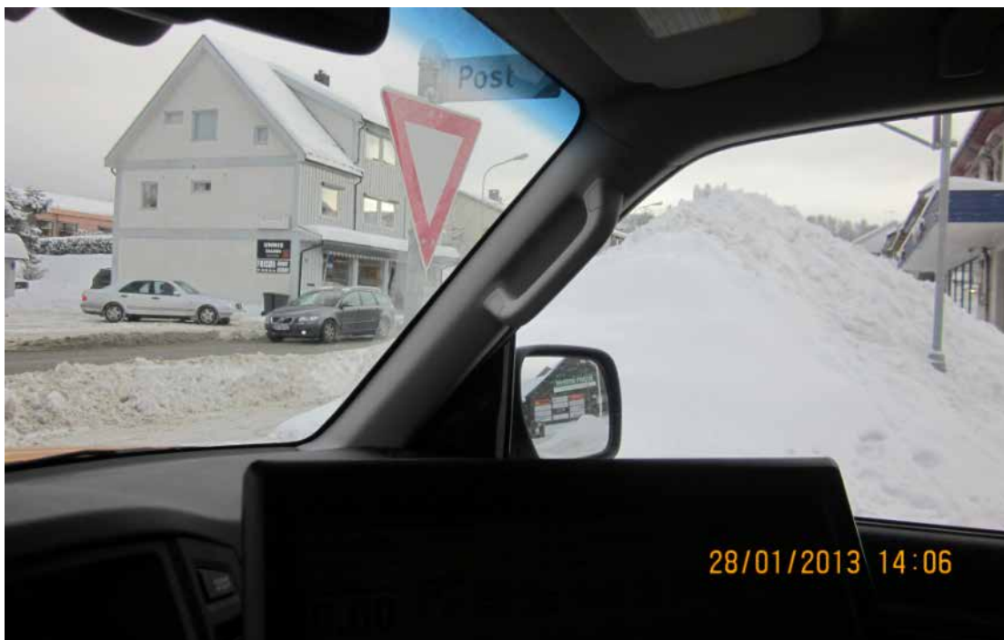
Figur 4-69 Sikt i kryss før rydding (Foto: Rudi Thomassen, Statens vegvesen)
