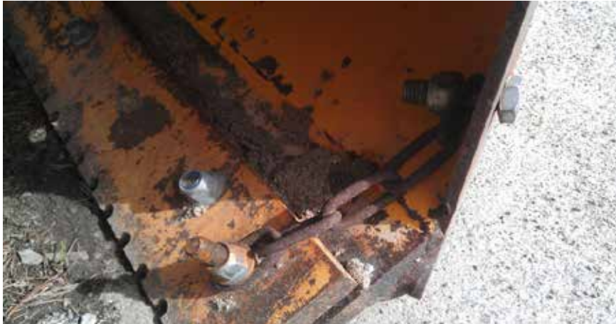
Figur 4-86 Sikring av vegstål. (Foto: Kjetil Bø, Statens vegvesen)
