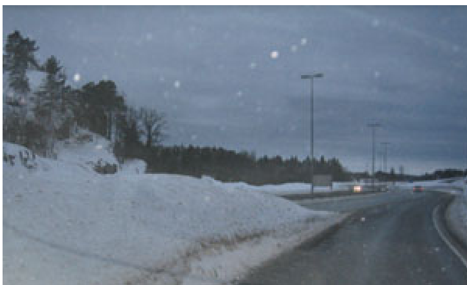
Figur 2-59 Ikke tilstrekkelig sikt fra påkjøringsrampe til motorveg (fartsgrense 100 km/t) (Foto: Arild Nærum)
