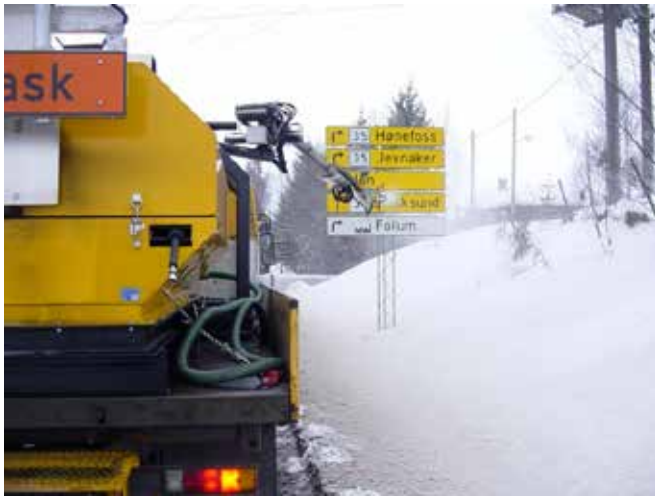
Figur 9-14 Skilt- og kantstolpevask
