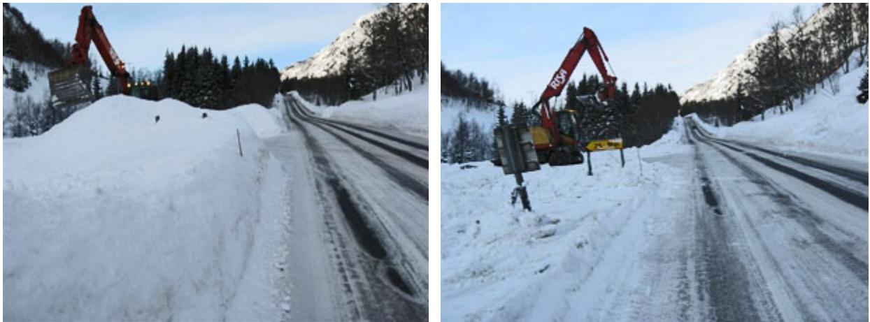
Figur 2-54 Siktrydding med hjulgående gravemaskin (Begge foto: Risa)
