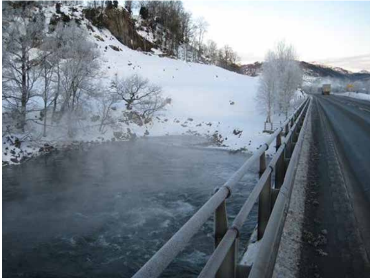
Figur 8-9 Nærhet til åpent vann vil kunne gi økt fare for utfelling av dugg/rim (Foto: Anders Svanekil)
