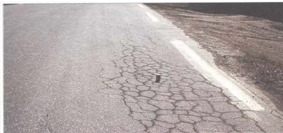
Figur 4-4 Smårutet krakelering
