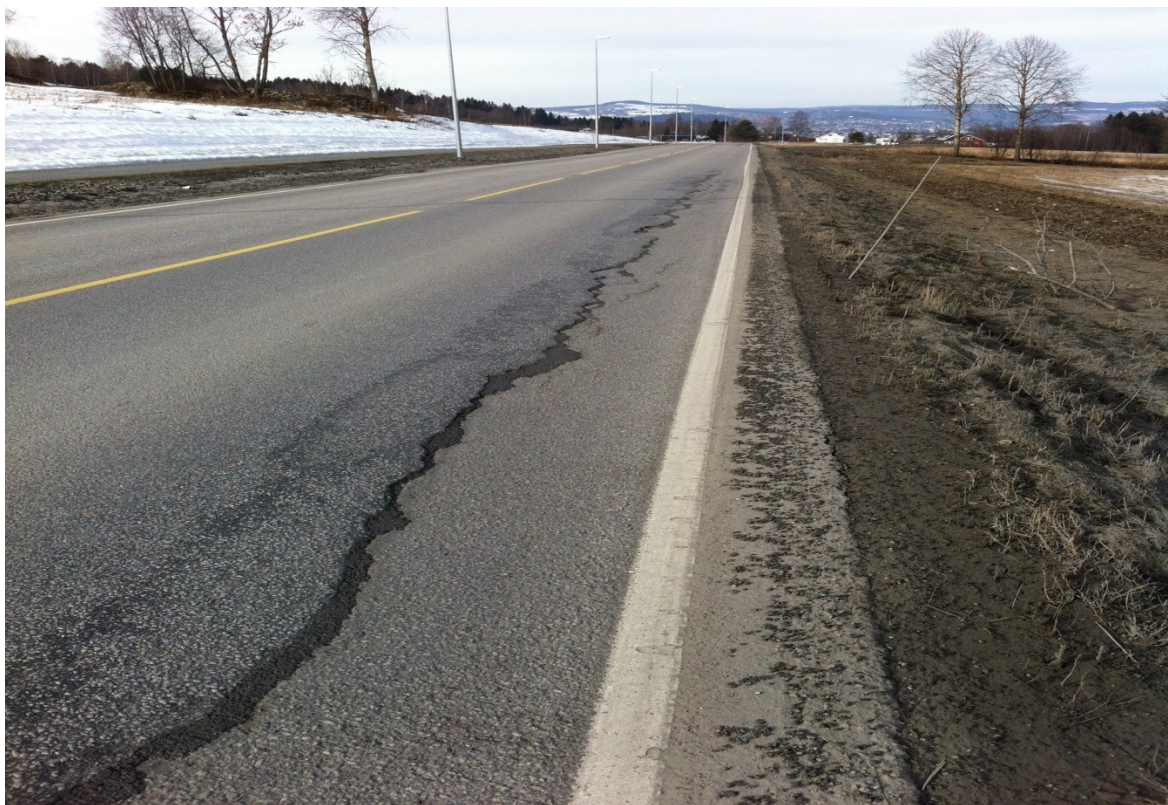
Figur 4-2 Kantsprekker
