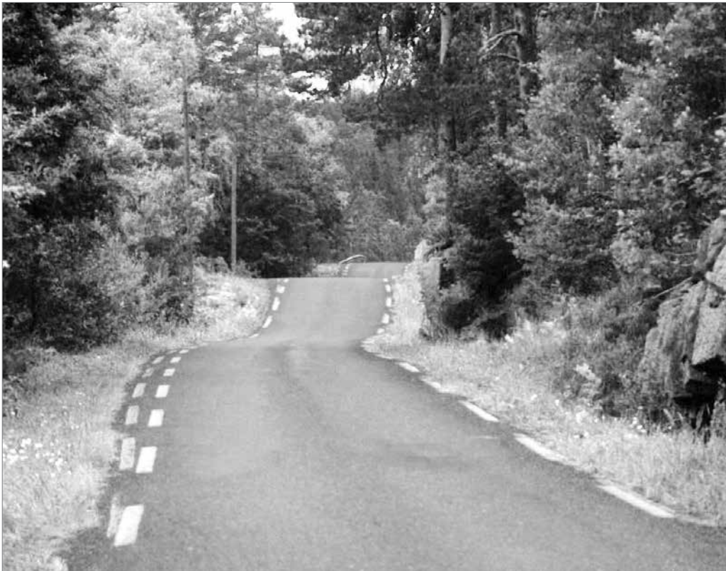
En sterkt ondulert veglinje i vertikalplanet
