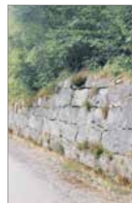
Fint håndverk, jevn overflate og murkrone
