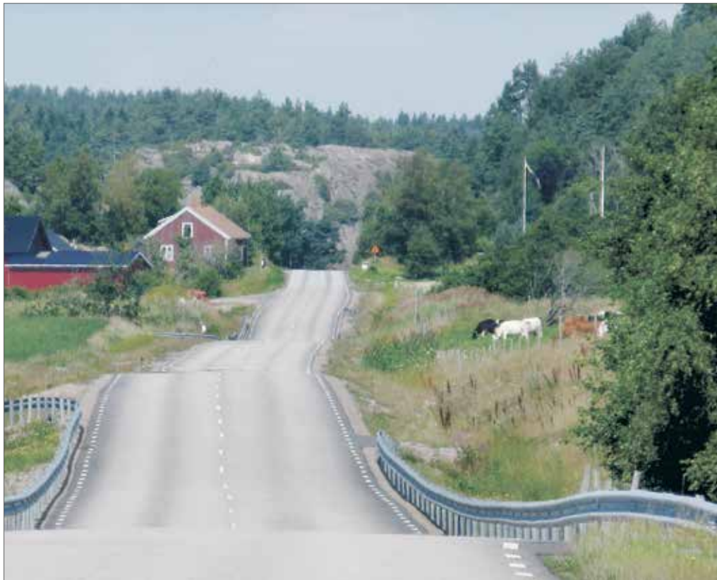
Sprang i vertikalkurven kombinert med sideforskyvning, forårsaket av en sirkelkurve i horisontalkurven, gir dårlig kontinuitet i romkurven
