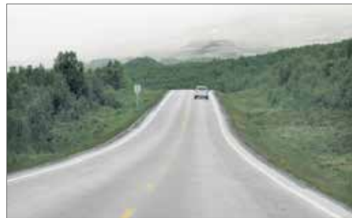
Lavbrekk sett fra vegen
