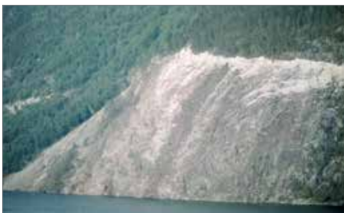
Vegen bør ikke ligge på sidebratt terreng uten forankring i mindre terrengformer
