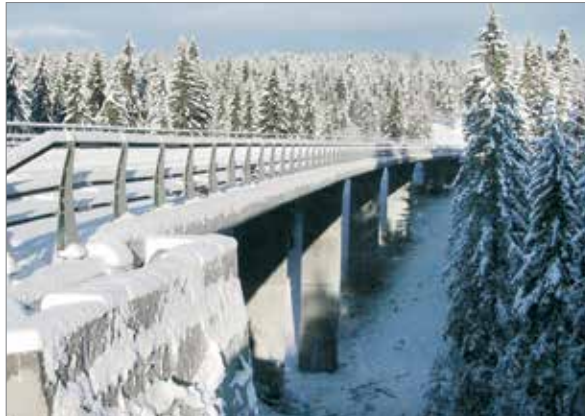
Godt utformet vegrekkverk og landkar
