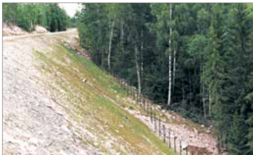
Vanlig utforming av fylling. Hellingsvinkel 1:2
