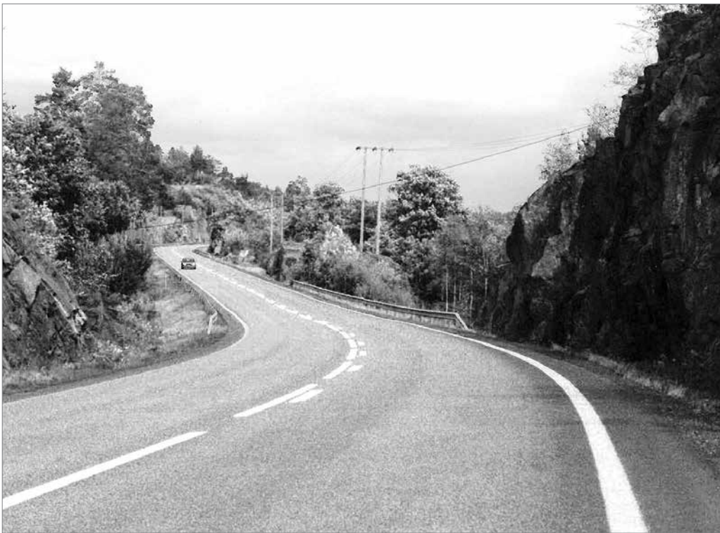
Linjeføring med lang rettlinje og sirkelkurve
