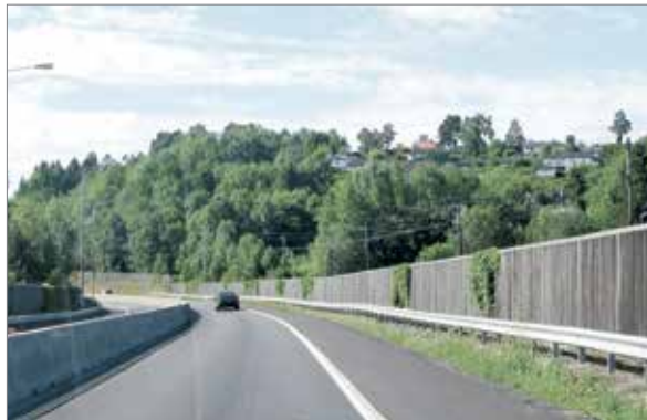
En tradisjonell løsning. Treskjerm med guardrail
