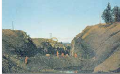
Toppen sprengt ned
