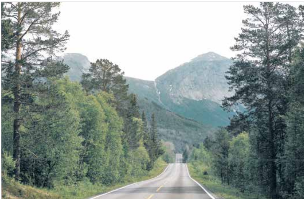
Løperen har bevegelser nedover og oppover i vertikalplanet og varierer i helling.
