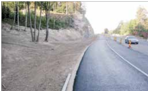
Overgang fjellskjæring/jordskjæring. Toppen og sidene på fjellskjæringen er rensket for løsmasser
