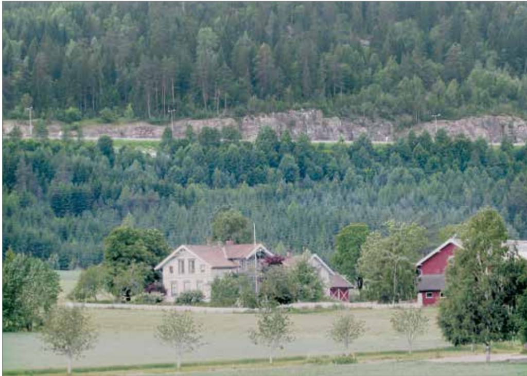
Høy og lang eksponert fjellskjæring med vanlig utforming gir skjemmende inngrep
