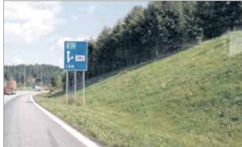
Vanlig utforming av jordskjæring. Hellingsvinkel 1:2
