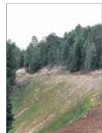
Vegen ligger lett i terrenget, høy fylling og lav fjellskjæring
