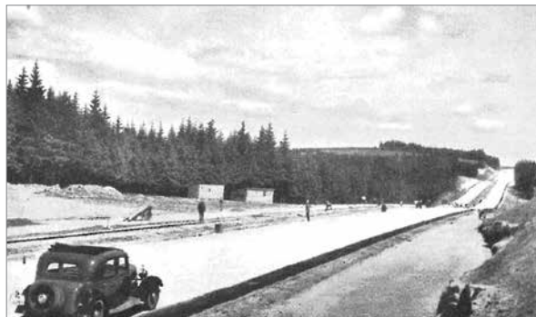
Bølgeformet eller ondulert veglinje i Tyskland 1937
