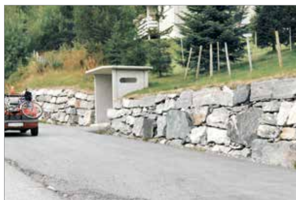
Ulik størrelse på steinen gir et rotet inntrykk. Leskur i betong forsterker det rotete inntrykket
