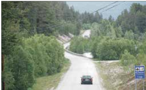
Sprang forårsaket av vegetasjon
