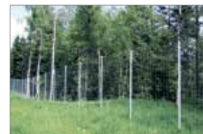
Viltgjerde med runde stolper
