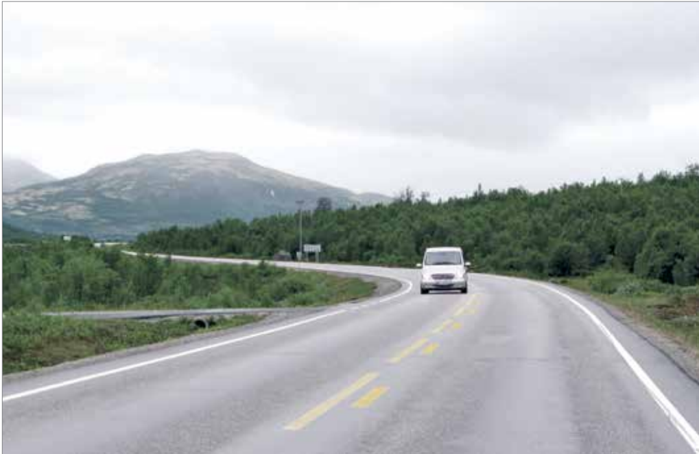
Løperen har skiftende retning og svinger i horisontalplanet. Vegen består av asfaltdekke og skulder som former et svart belte med hvite, parallelle linjer
