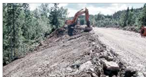
Utlegging av jord uten pakking og glatting av overflaten
