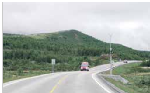
Knekk i romkurven forårsaket av knekk i vertikalplanet
