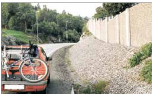
Støyskjerm av prefabrickerte betongelementer
