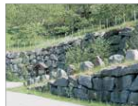
Vakker mur som reduserer skråningsutslagene
