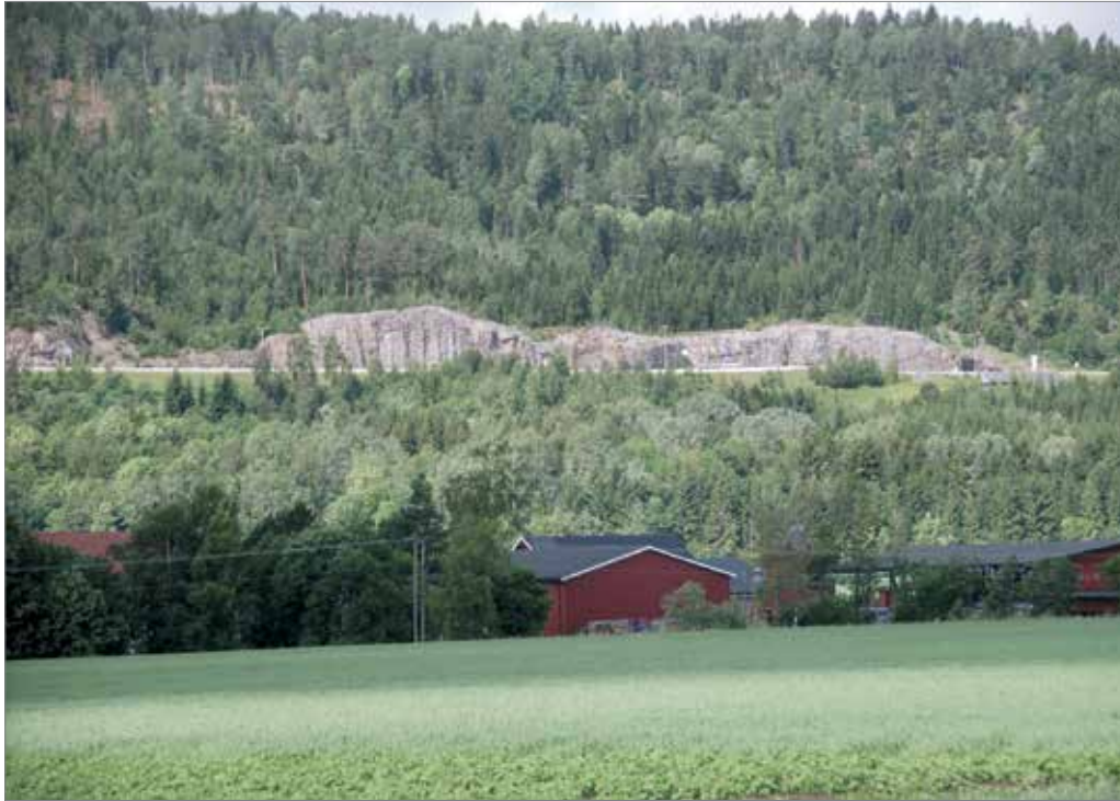
Sideterreng med eksponerte fjellskjæringer hvor lengre strekninger sees samtidig
