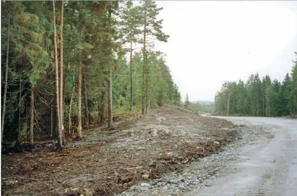
Utlagt jord som løse masser med røtter og kvister
