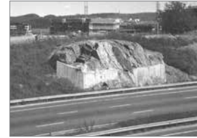
Fjellskjæring som er støttet opp med murer. Bare komisk?
