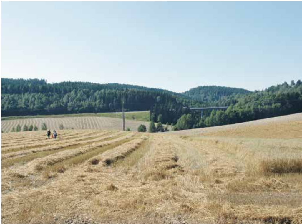
Fjernvirkning av en enkel og slank vegbru. Vakker konstruksjon i landskapet
