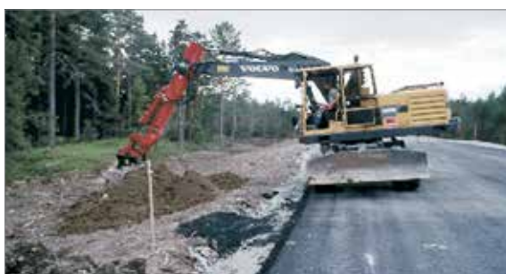
Utlegging av jord med gravemaskin
