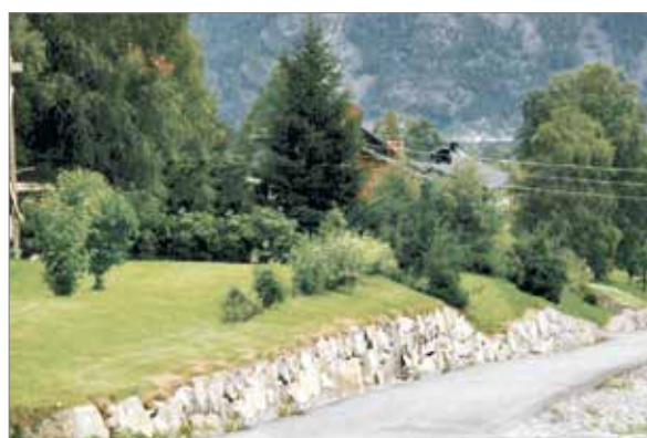
Ujevn murkroner gir dårlig inntrykk. Her kunne terrenget enkelt vært formet med oppfylling i søkkene og planering av toppene
