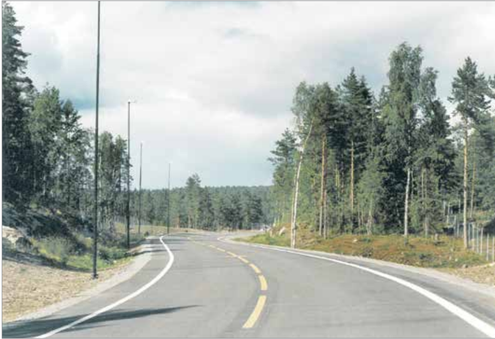
Formet sideterreng stryker langsmed vegen. Vegen ser ut som den alltid har ligget der
