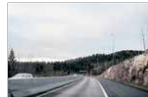
Midtrekkverk i betong
