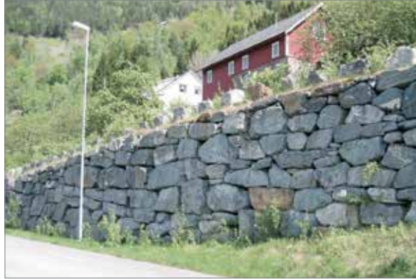
Vakker mur, med jevn overflate og murkrone. Passe stor stein uten skåret flate
