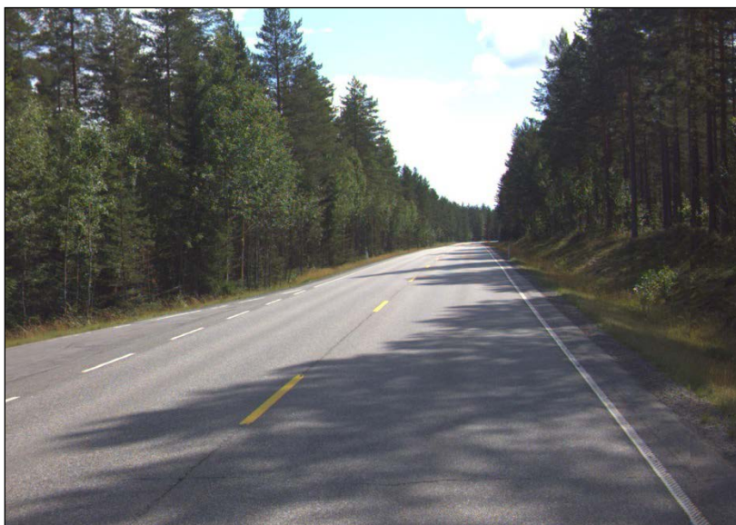
Figur 31 Lokaltet ved Åsta. Foto: svv
