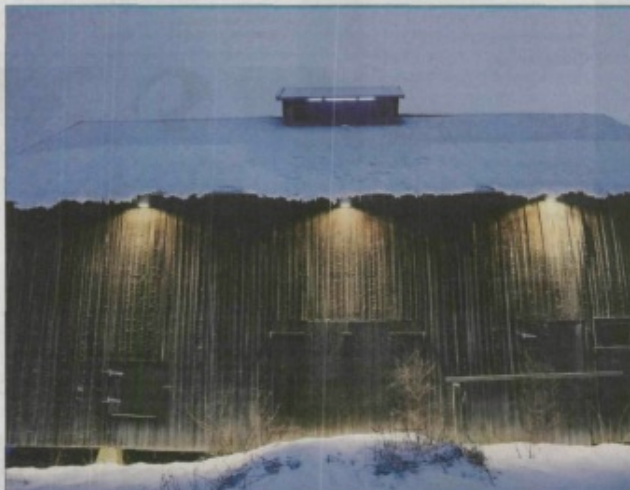
SØRVEGGEN: Langsida mot sør er solbrent, og luftetårnet er lyssett i blått.
