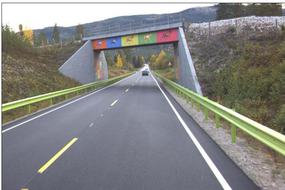
Figur 6 Jernbanebrua etter oppgradering. Foto: svv
