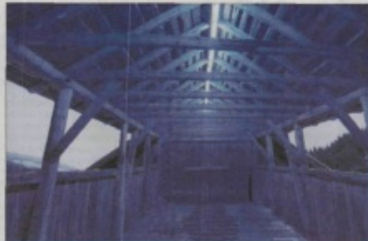
LÅVEBRUA: Den overbygde låvebrua er lyssett med blått lys.
