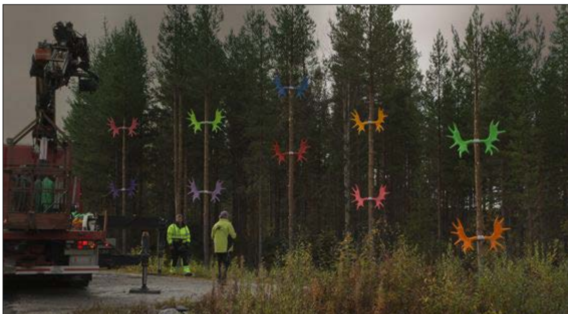
Figur 23 Arbeid med montering av gevir, Alvdal grense. Foto: svv
