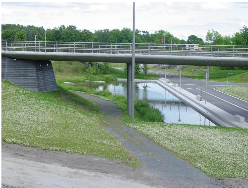
Figur 6.8. Et vått overvannsbasseng innpasset i et veganlegg på Fornebu (Foto: COWI AS).
