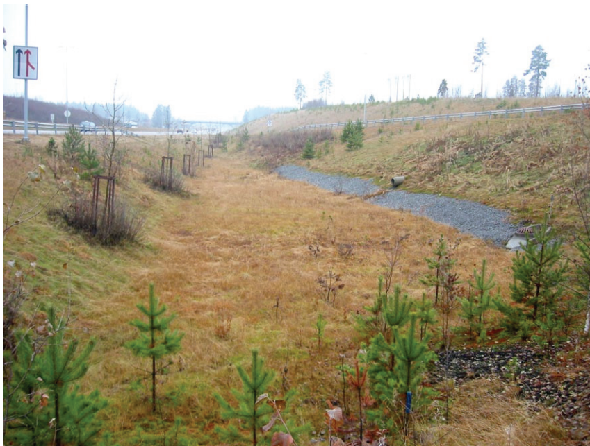
Figur 6.11. Foto av infiltrasjonsbasseng ved Rv174 i Akershus. Innløp til venstre og høyre i bildet. Oppstuvning av vann på vinteren ledes via nedløpskummer til lukket perkolasjonsmagasin (til høyre i bildet) (Foto: COWI AS).
