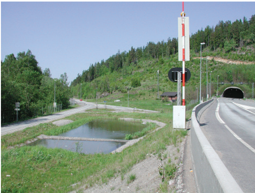
Figur 6.26. Basseng for rensing av vaskevann fra tunnel (E6 Vassum i Akershus).
