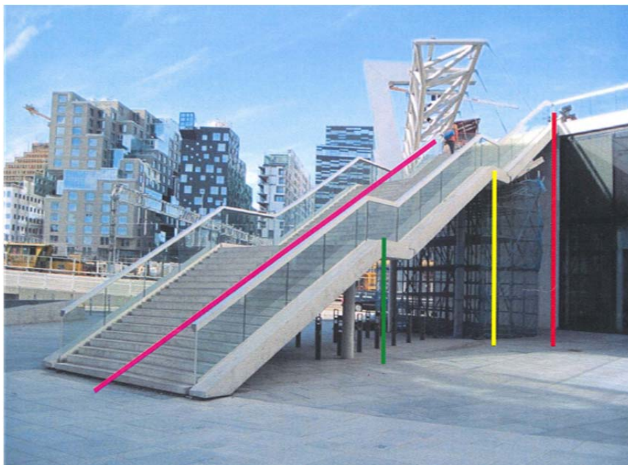
Bildet viser trappen som syklisten syklet ned. Syklisten landet på plassen, like nedenfor trappen. Rosa linje: Trappens totale lengde (23 meter). Rød linje: Trappens totale høyde (8 meter).
