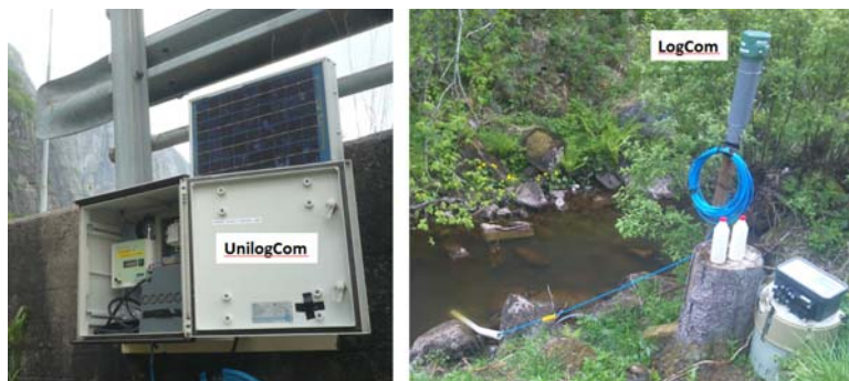
Figur 9. Loggere UnilogCom og LogCom. UnilogCom er bygd inn i skap med strømforsyning fra batteri og solcelle. LogCom montert frittstående med strømforsyning fra batteripakke.
