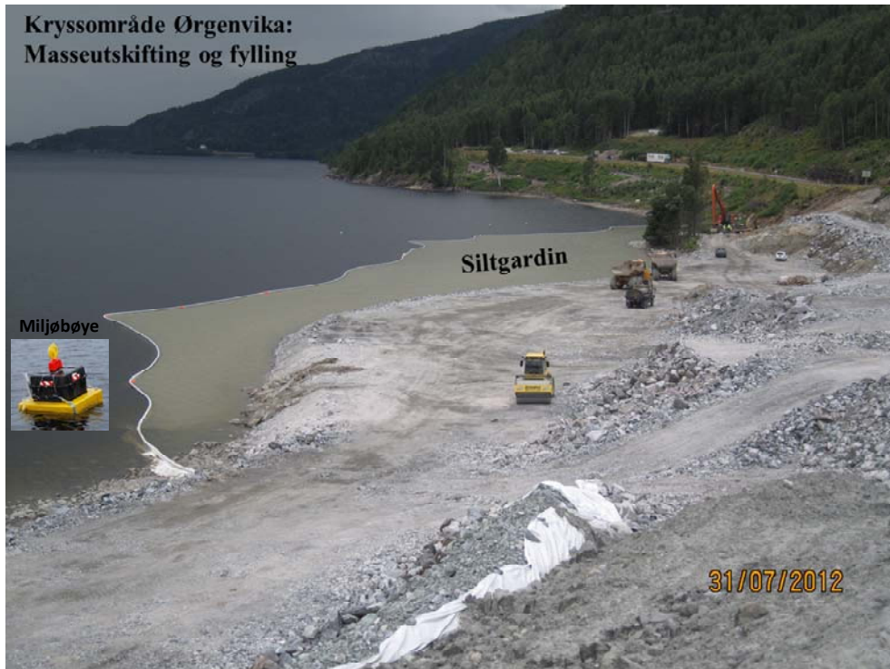
Figur 27. Anleggsarbeid med masseutskifting og utfylling langs strandsonen til Krøderen i juli 2012.
