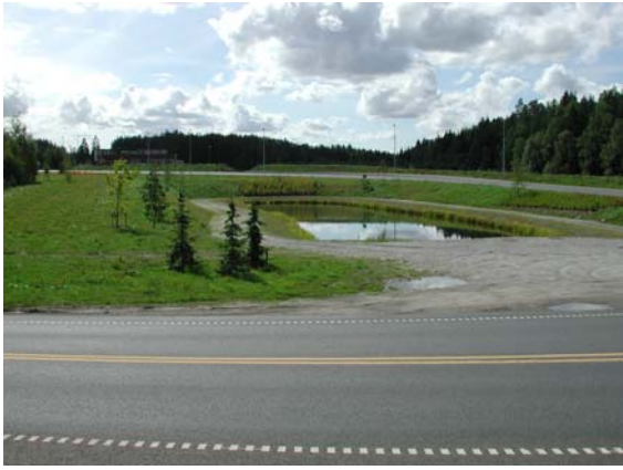
Figur 20. Rensedam ved Taraldrud langs E6 Oslo grense - Assurtjern med on-line måling ved innløp.
