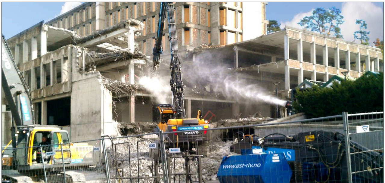
Figur 5.1 Riving av større bygård i Sandvika høsten 2012 Foto: Margaret Baumann
