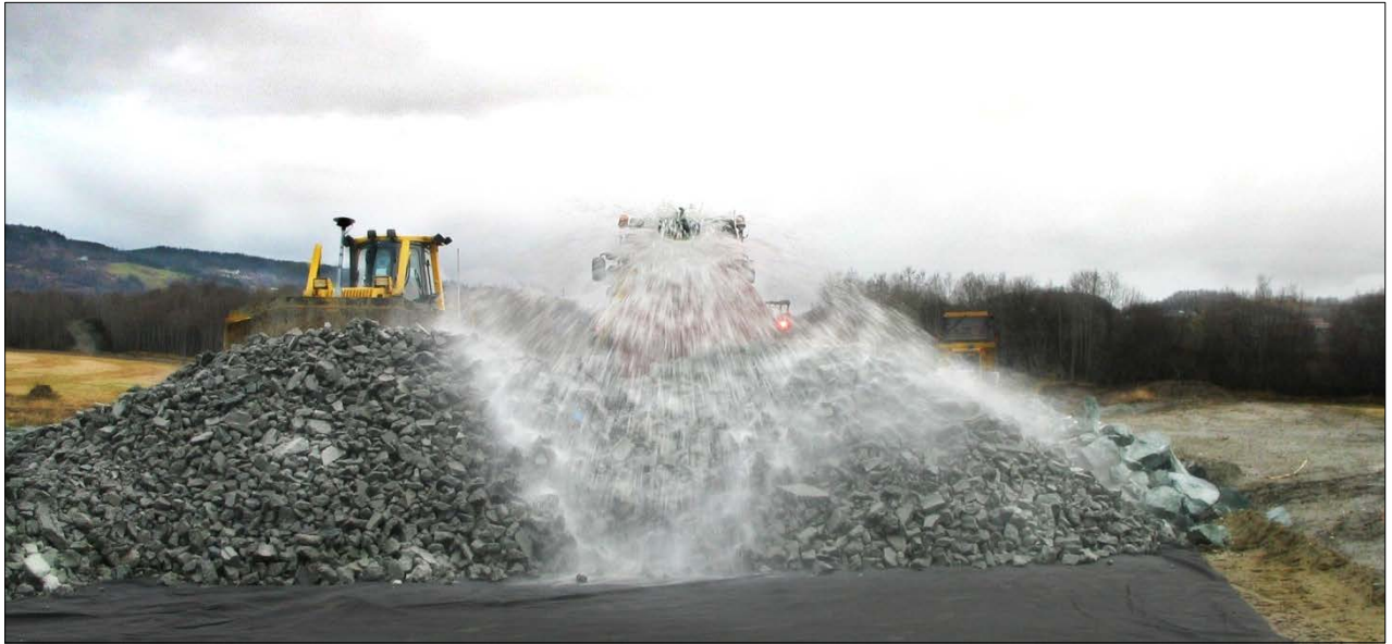
Figur 7.4 Vanning med bruk av gjødselspreder. Fra E6 Melhus Foto: Dag Atle Tangen, Statens vegvesen
