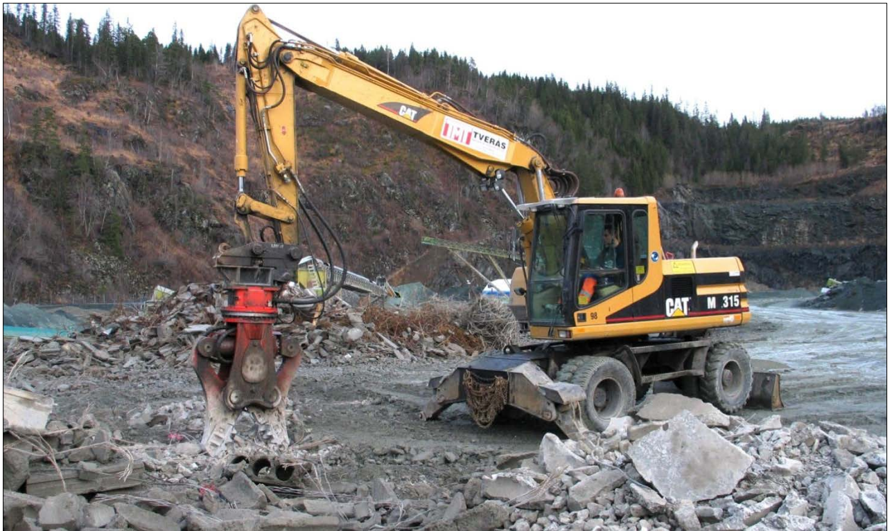
Figur 3.1 Kasserte hulldekker av betong klippes opp før knusing. Fra E6 Melhus Foto: Dag Atle Tangen, Statens vegvesen
