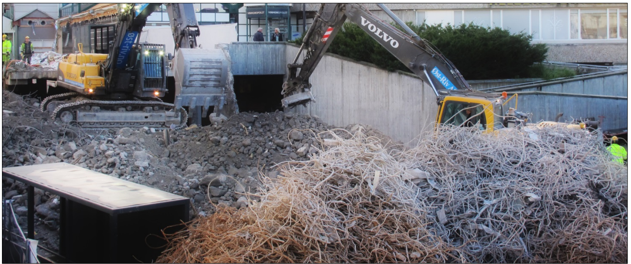
Figur 7.1 Armering plukkes ut med magnet. Fra riveprosjekt i Sandvika 2012 Foto: Margaret Baumann
