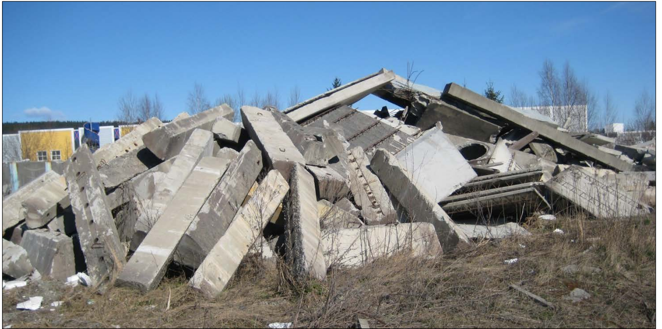
Figur 8.1 Rivebetong klar til knusing Foto: Christian Engelsen
