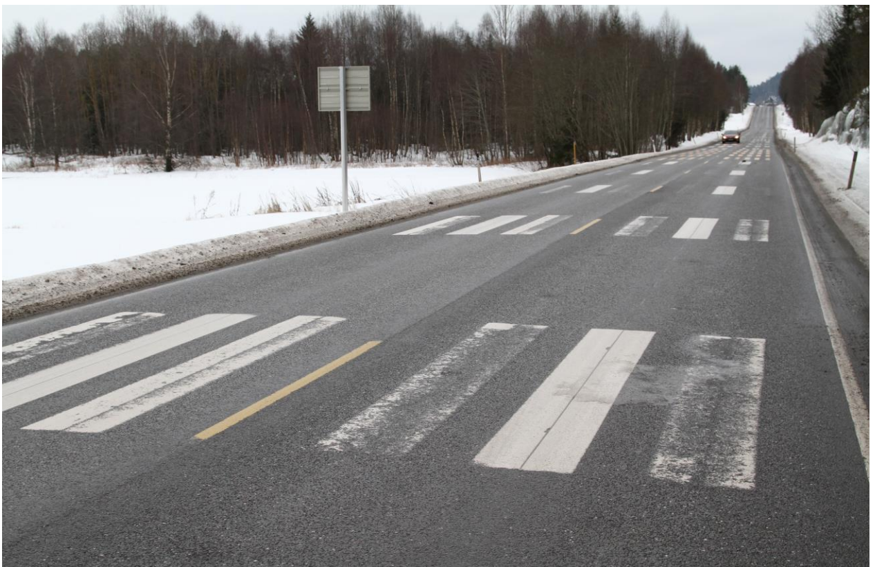
Oversiktsbilde sørover med Visafos's referansemateriale nærmest.
