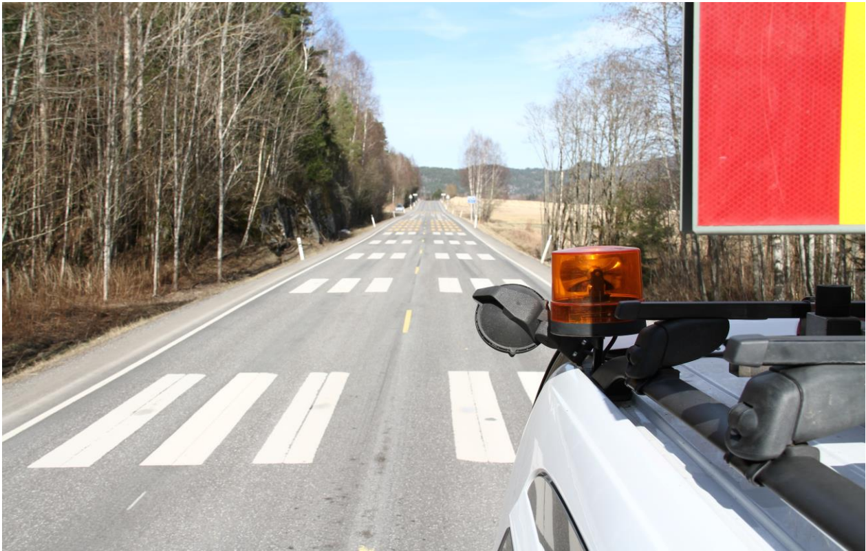
Cleanosol. System 4 nærmest.
