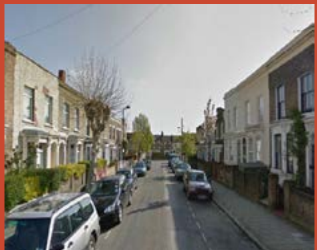
fig 3.29: Rekkehus: Clifden Road, Hackney, London (kilde: maps.google.no)
