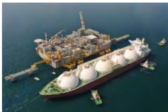
Fig. 9 The Adriatic LNG Terminal
