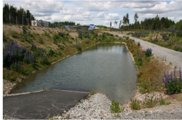
Figur 10. Elstadmoen faunapassasje rensbasseng. Bildet er tatt fra innløp. Foto: Susanne Lund Johansen.
