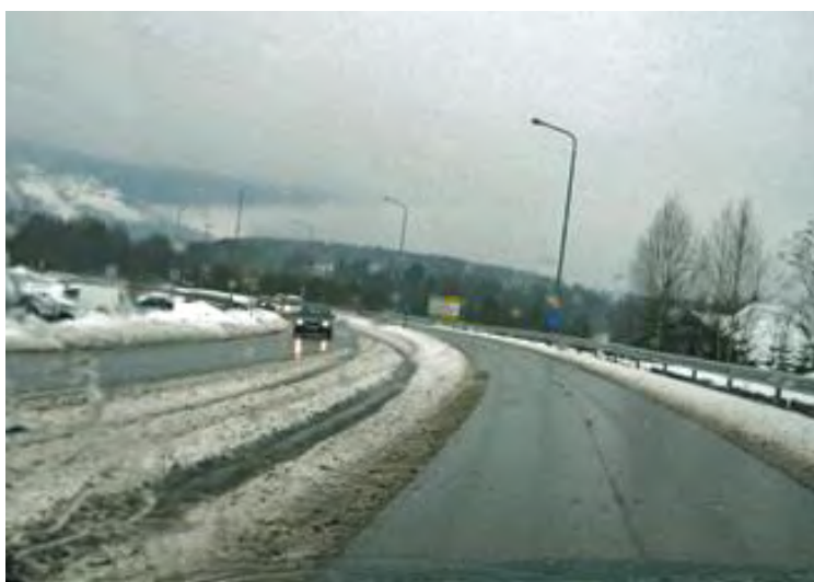
Figur 2-31 Dårlig brøytet forbikjøringsfelt (Foto: Statens vegvesen)
