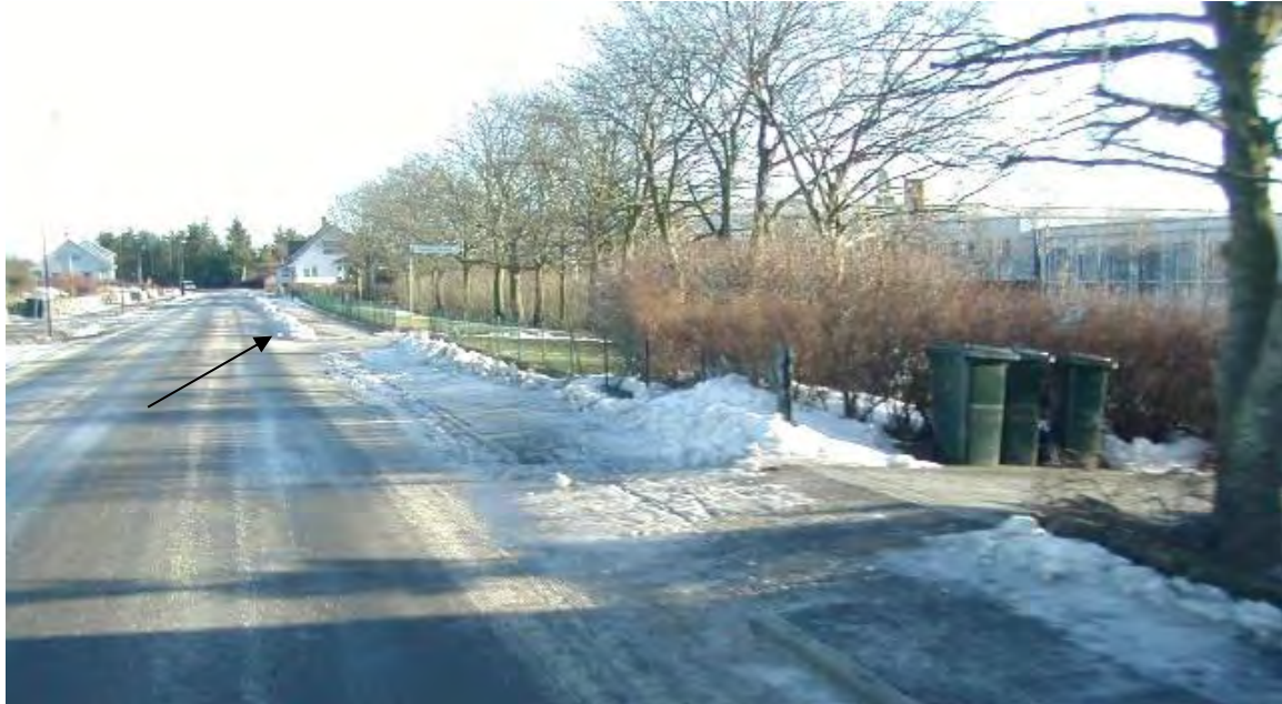
Figur 4-61 Lengst bort i bildet ser vi eksempel på riktig utførelse av brøyting av fortau
