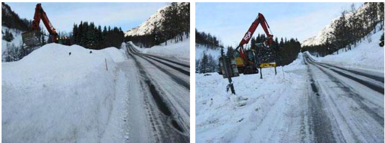
Figur 2-54 Siktrydding med hjulgående gravemaskin (Begge foto: Risa)
