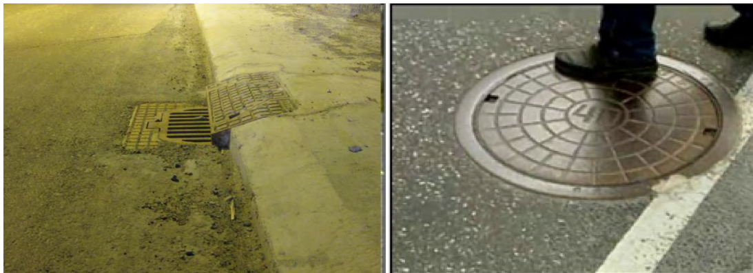
Figur 4-2 En bør stoppe opp å kontrollere sluk og kumlokk som ligger utsatt til
