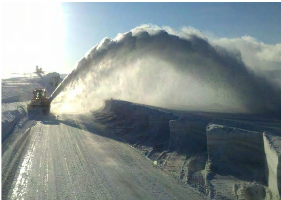
Figur 4-73 Fresing av brøytekanter, Ev6 Gratangsfjellet 2013 (Foto: Jan Lind, Statens vegvesen)
