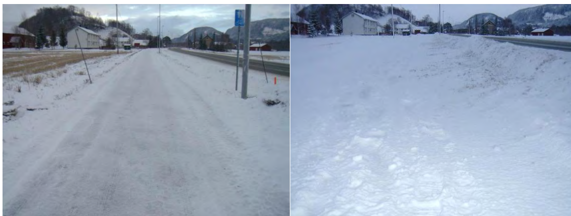
Figur 4-57 Eksempler på godt resultat (til venstre) og dårlig resultat (til høyre) etter brøyting av både hovedveg og g/s-veg
