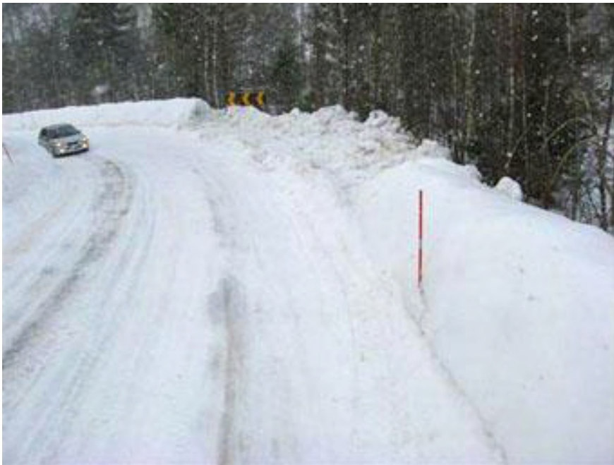
...og etter rydding. Husk supplering av brøytetikk (Begge foto: Statens vegvesen)
