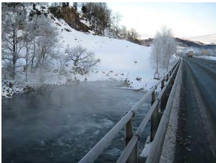
Figur 8-7 Nærhet til åpent vann vil kunne gi økt fare for utfelling av dugg/rim (Foto: Anders Svanekil)
