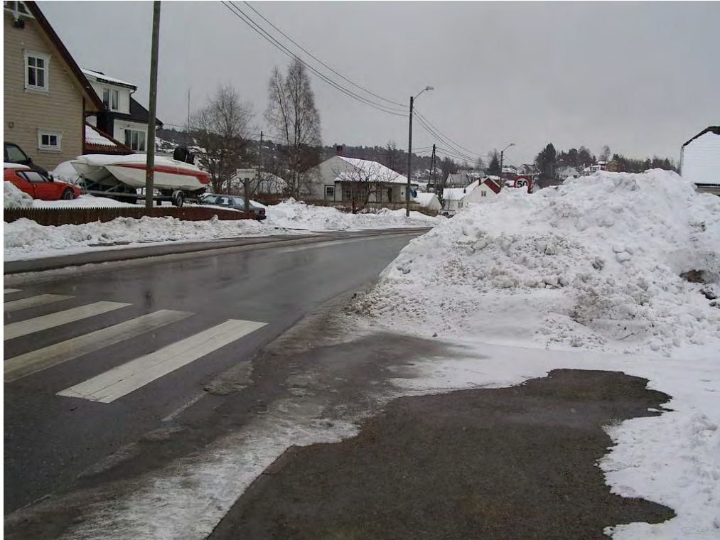
Figur 2-48 Plassering av snø i siktsonen etter at fortauet er brøytet (Foto: Arild Nærum)
