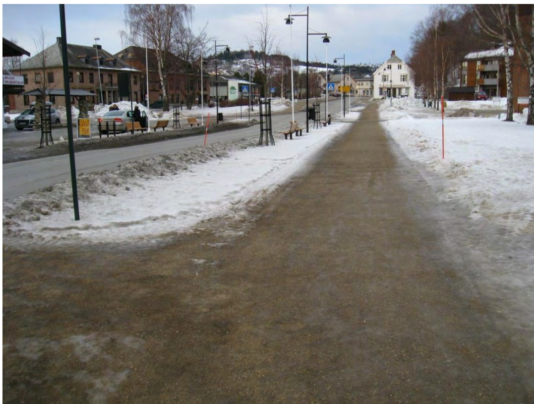
Figur 7-8 Eksempel på strøing av G/S-veg. (Foto: Øystein Larsen, Statens vegvesen.)
