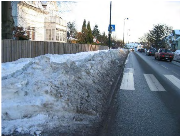
Figur 2-46 Manglende sikt og åpning i brøytekanten
