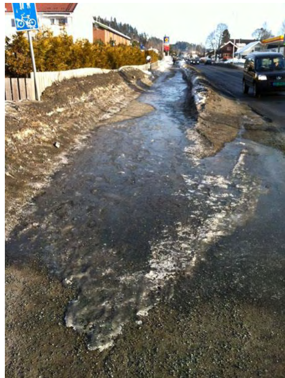
Figur 2-45 Tining og frysing på gs-veg (Begge foto: Arild Nærum)
