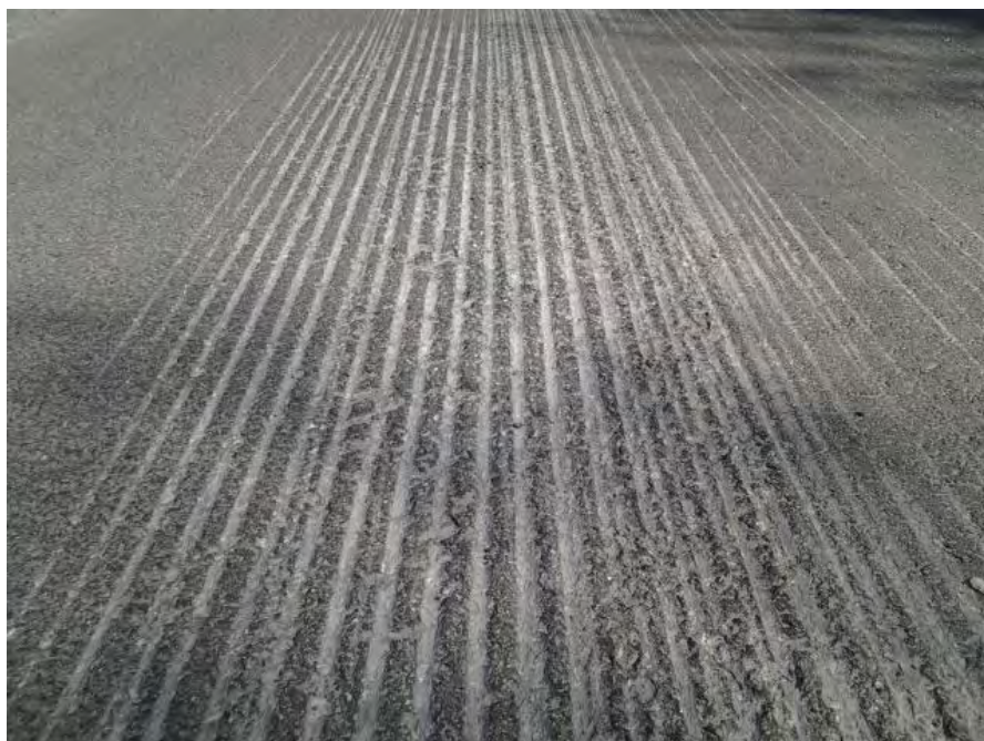
Figur 4-72 Dekkeskade grunnet uforsiktig høvling. (Foto: Håkon Svendsen)
