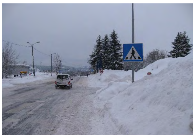
Figur 2-51 Manglende siktrydding til kryssingspunkt over hovedveg (Foto: Pål H. Paulsen)
