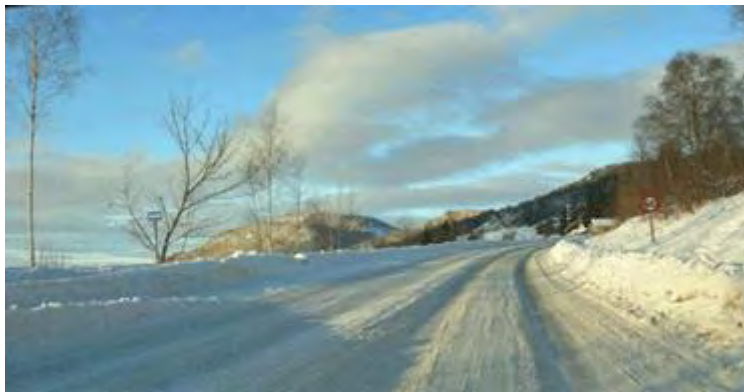
Figur 2-30 Sporete vegbane (Foto: Statens vegvesen)
