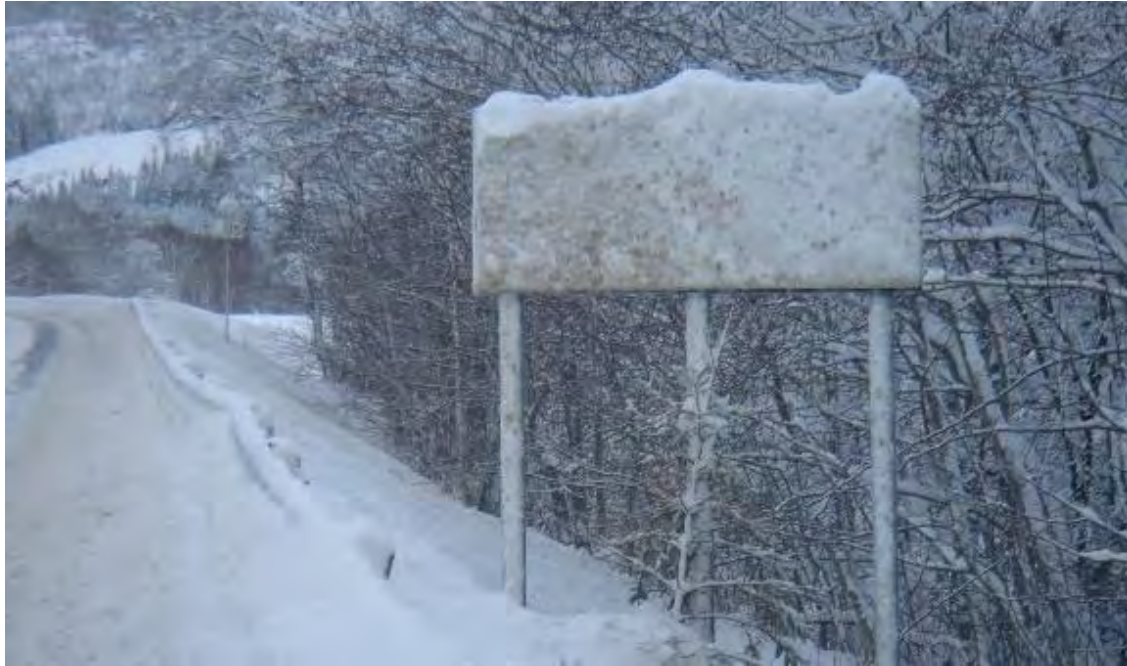
Figur 9-6 Snø på skilt som følge av sprut etter brøyting.
