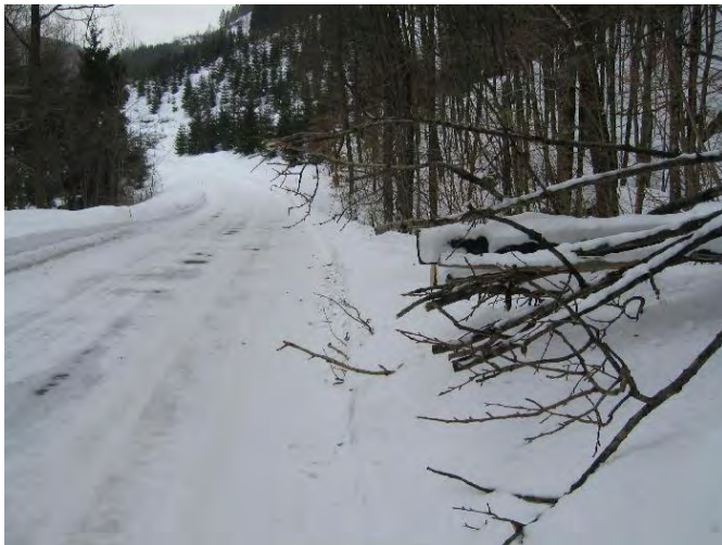
Figur 2-68 Veltet tre som er kappet og utgjør påkjørselsfare (Foto: Kjell Stangborli)
