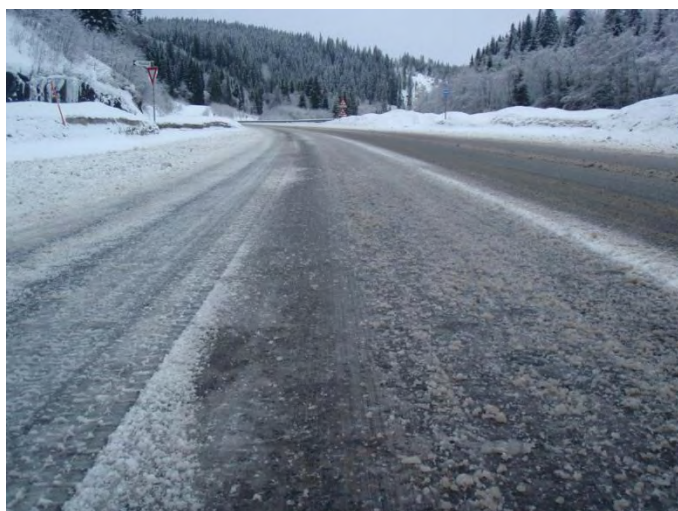
Figur 8-5 Dårlig brøyting vil gi dårlige kjøreforhold og høyt saltforbruk (Foto: Bård Nonstad, Statens vegvesen)
