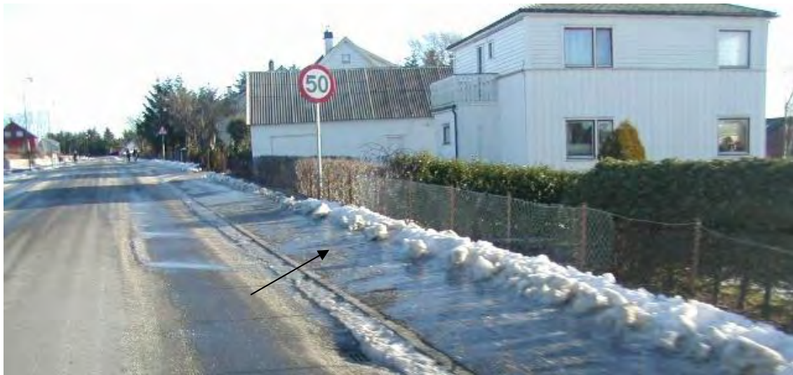
Figur 4-60 Eksempel på uheldig utførelse av brøyting av fortau
