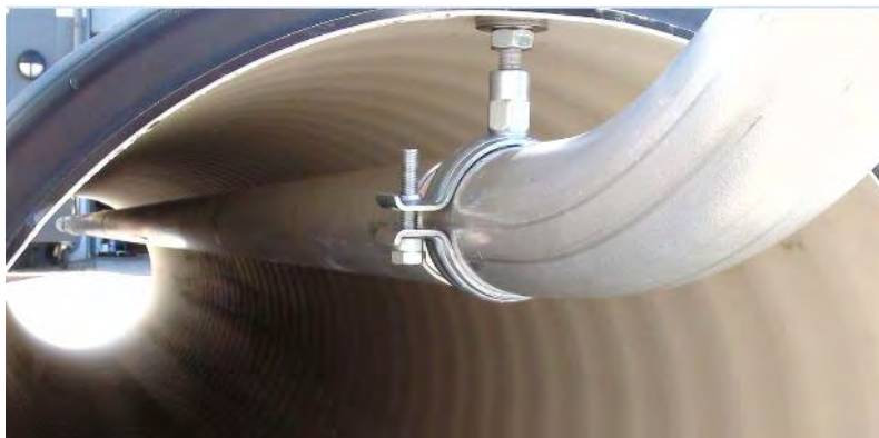
Figur 9-12 HeatWork. Tinerør montert inni stikkrenne (Foto: HeatWork)
