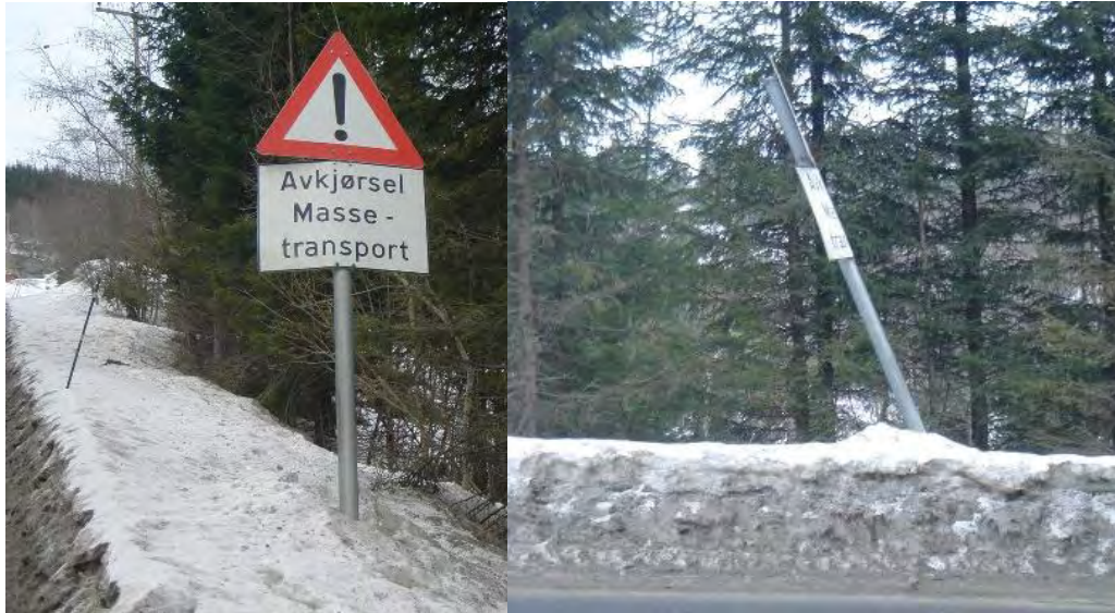
Figur 9-7 Skade på skilt
