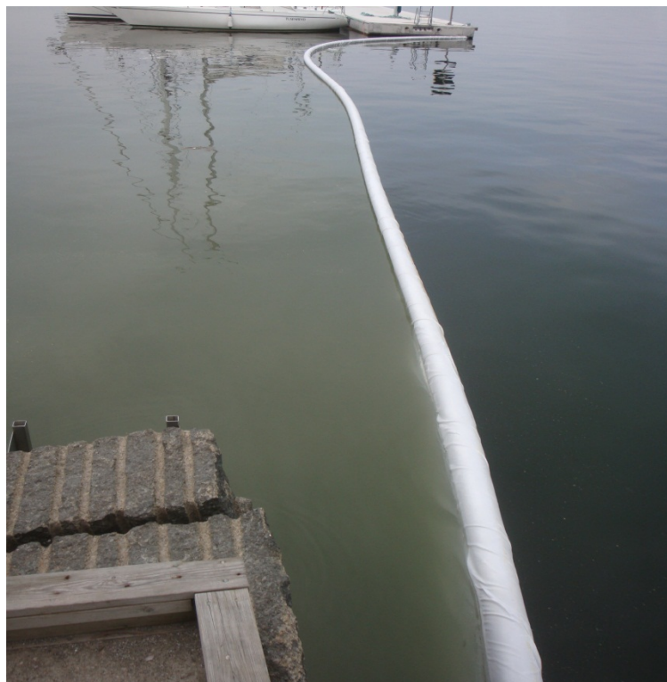
Figur 3: Siltgardin i bruk ved arbeid i småbåthavn. Foto: Rambøll. Bilde er tatt av Tom Tellefsen.
