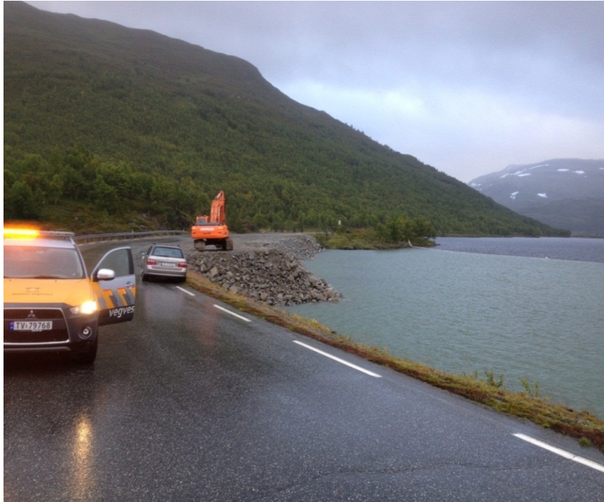
Figur 2: Siltgardin i bruk ved utfylling i fjellvann ca. 900 moh. Gardinen var ca. 180 meter, og var plassert utenfor fylling med sprengtstein. Fyllingen var på ca. 25.000 m 3 , og ble utført fra endetipp (E16 Filefjell). Foto: Statens vegvesen. Bildet er tatt av Sveinung Brude.
