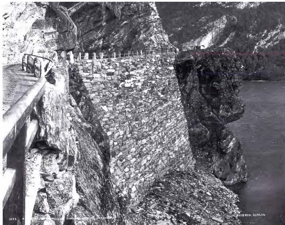
Fig. 13: «Storemuren» mellom Sandane og Reed i Nordfjord. Muren er 55 m lang og største høgd er 21 m. Muren vart bygd i 1880-åra, og er eit prov på godt handverk.
