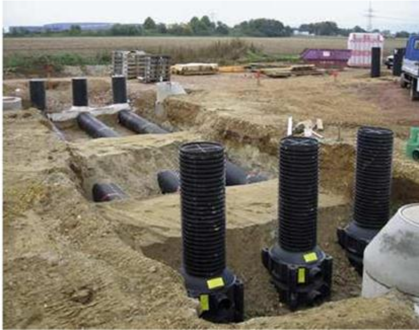
Figur 15. Eksempel på nedsetting av Sedi-pipe anlegg (Sommer og Post*, 2009)
