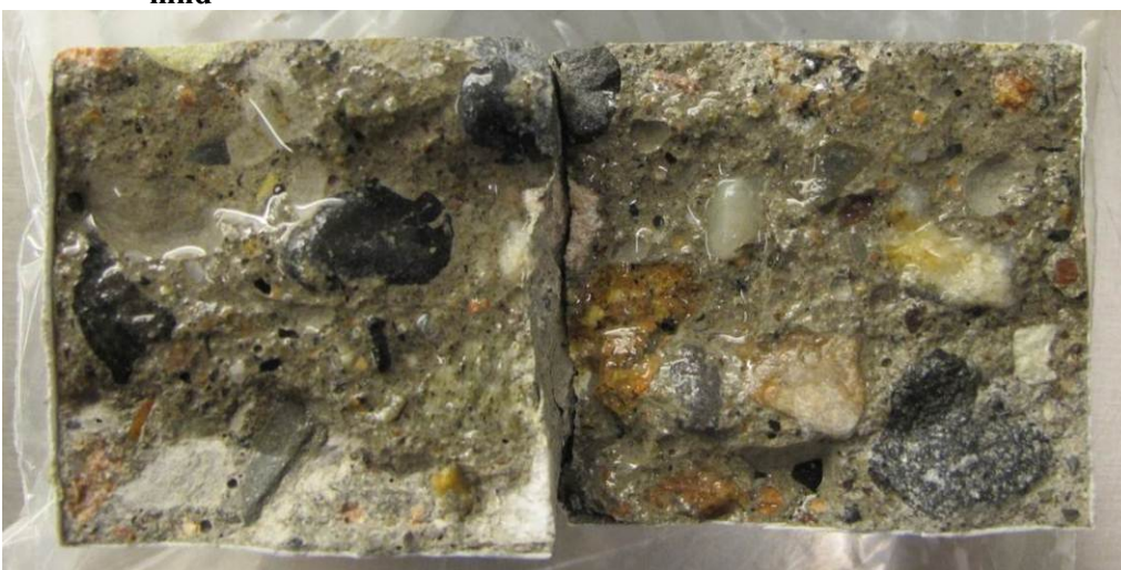
Figur 32 Bruddflater påført vann umiddelbart etter splitting, prøvestykke 17B - oppbevart periodisk neddykket i 16,5 % NaCl-løsning i 56 døgn, deretter i luft/plastpose i 4 mnd
