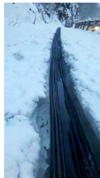
Figur 18. Rombaksvegen, GHW 2. Tining av grøft. Foto Karl Olav Dahlberg, Mesta
