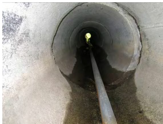
Figur 3. Dårlig skjõt mellom de øverste rørene, ellers god standard. Foto Øystein Larsen, Vegdirektoratet
