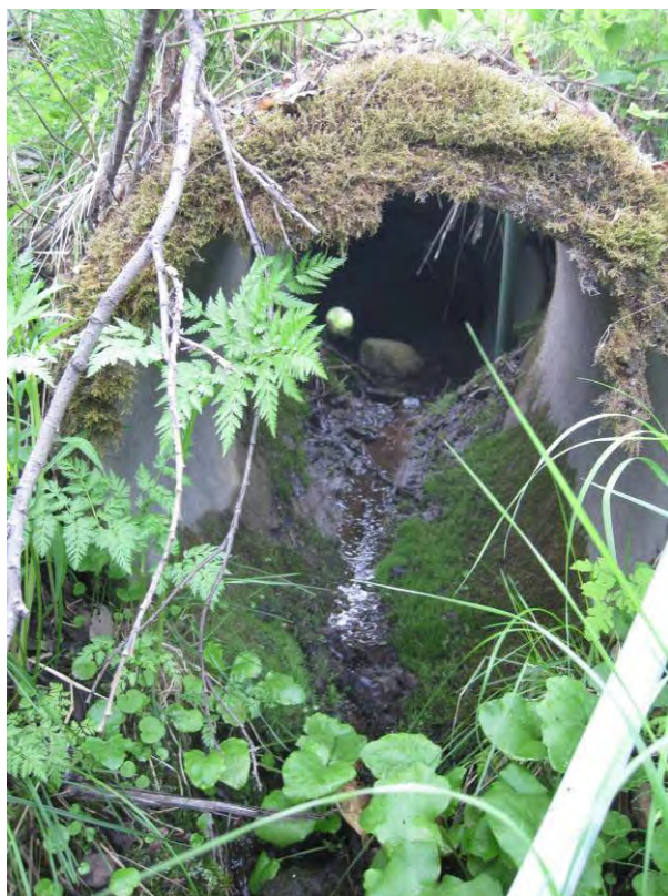
Figur 2. Utløp. Foto KM Reitan
