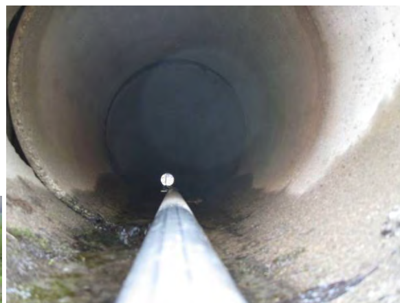
Figur 3. Ytterste rør har glidd ut, elles god standard på stikkrenna. Foto KM Reitan
