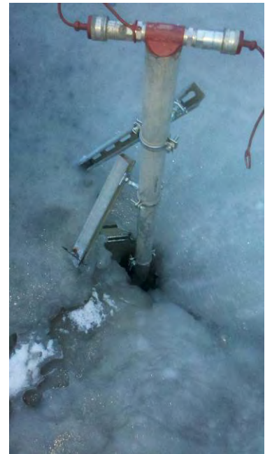
Figur 16. Åpning rundt innløpet utvidet med eget "tinerør". Foto Karl Olav Dahlberg, Mesta
