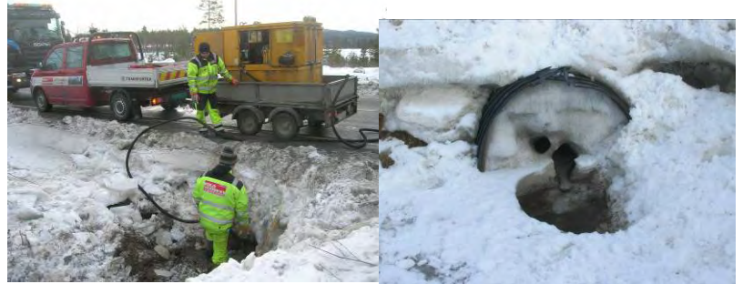
Figur 1. Tining av stikkrenne med steam. Åpning etter utført steaming. Foto KM Reitan
