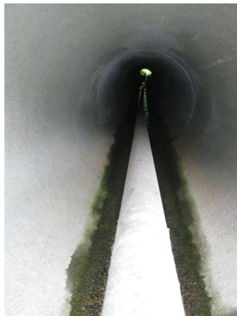
Figur 4. IGS-rør i bunnen av stikkrenna. Foto KM Reitan
