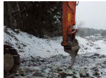
Figur 4. Gravemaskin med rippertann. Foto Knut Magne Reitan, Siv.ing. Reitan AS
