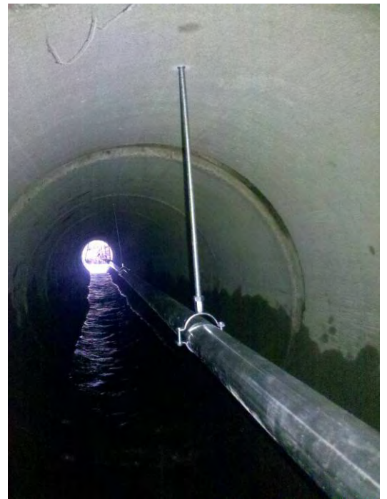
Figur 11 Opphenging av IGS i stikkrenne .
