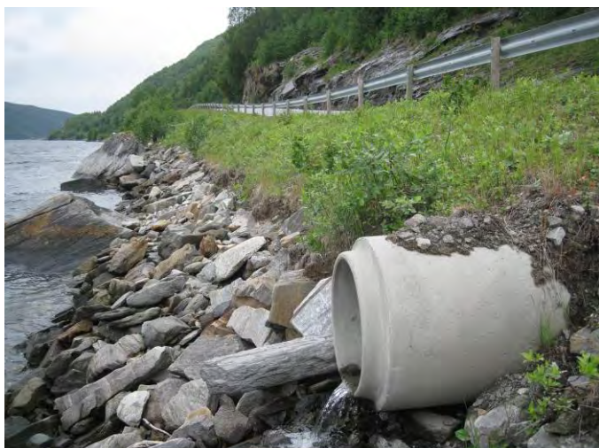
Figur 2. Utløp. Foto KM Reitan
