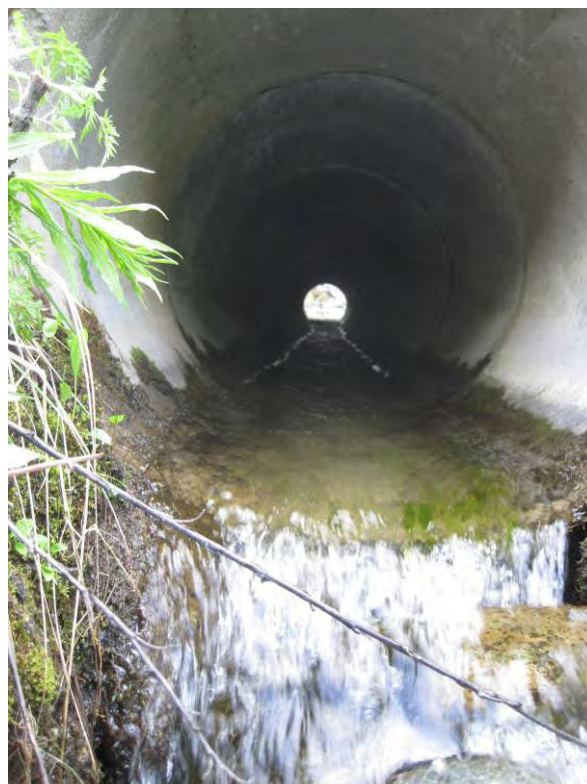
Figur 3. Innvendig stikkrenne, god standard. Foto KM Reitan
