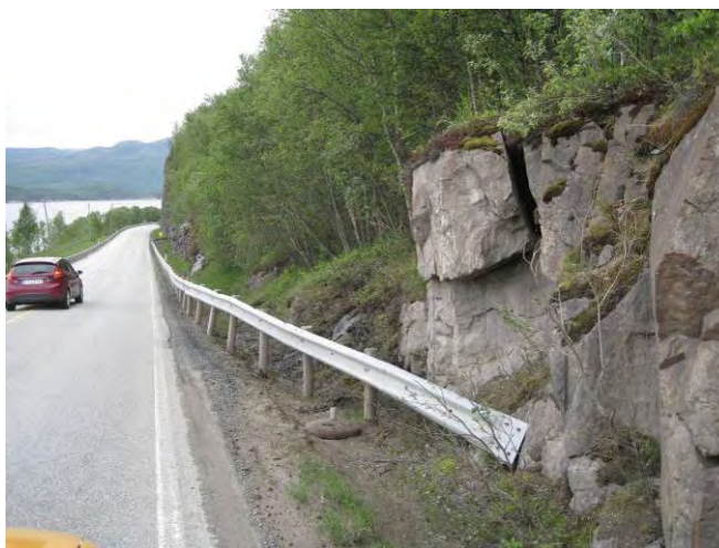
Figur 2. Rekkverk på hele strekningen. Foto KM Reitan
