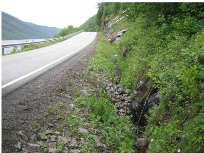
Figur 4 Innløp av stikkrenne. Foto KM Reitan
