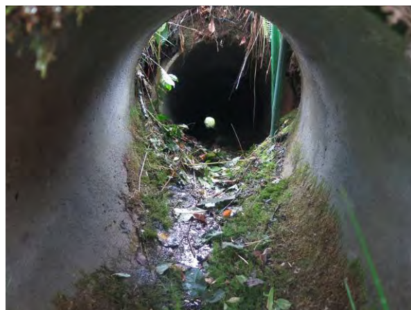
Figur 3. Nederste rør har glidd ut, ellers bra standard på renna.
