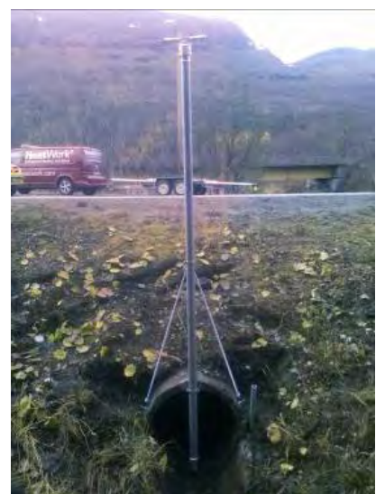
Figur 12 Feste av oppstikk med adapter. Foto: Dan Eirik Knudsen, HeatWork
