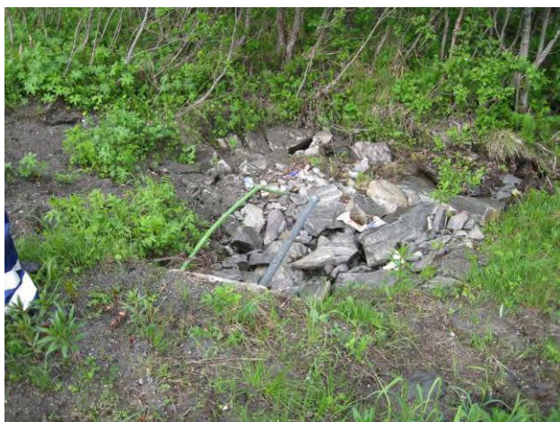
Figur 2. Utløp. Foto KM Reitan
