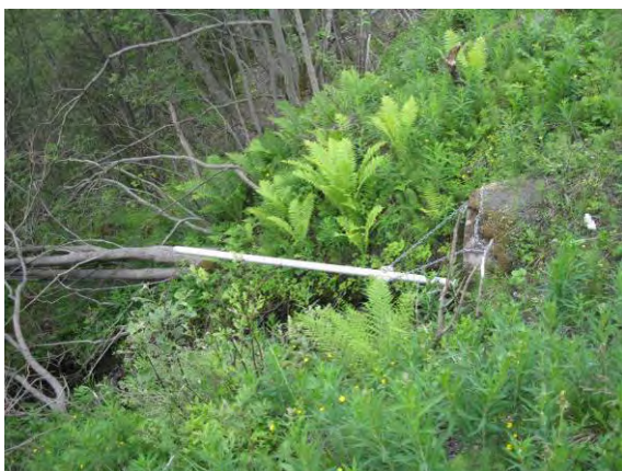
Figur 2. Utløp. Foto KM Reitan
