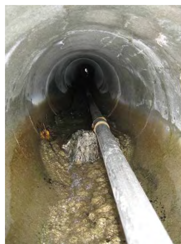
Figur 3. IGS-røret er løftet opp ved utløpet. Foto: KM Reitan
