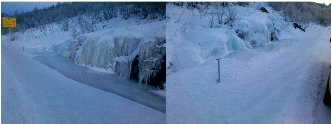
Figur 13 HW 4 Is i skjæring og grøft. Foto: Håkon Svendsen, Mesta
