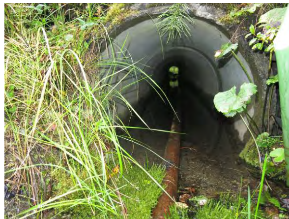
Figur 3. God standard på stikkrenne. Foto Øystein Larsen, Vegdirektoratet
