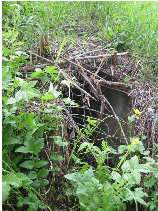
Figur 1. Innløp. Foto KM Reitan
