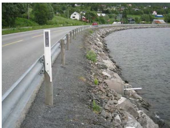
Figur 3. Stikkrenne under fylkesveg og g/s-veg som skimtes helt til venstre. Foto KM Reitan
