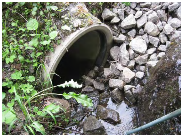
Figur 1. Innløp av stikkrenne. Foto KM Reitan
