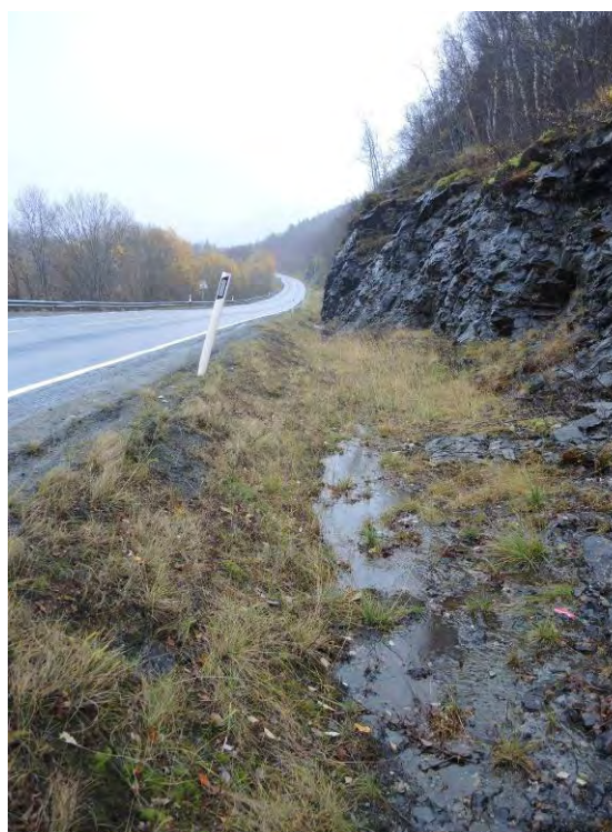
Figur 2. Grøftprofil motnord. Foto KM Reitan
