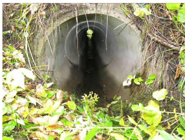
Figur 3. God standard på renna. Foto Øystein Larsen, Vegdirektoratet
