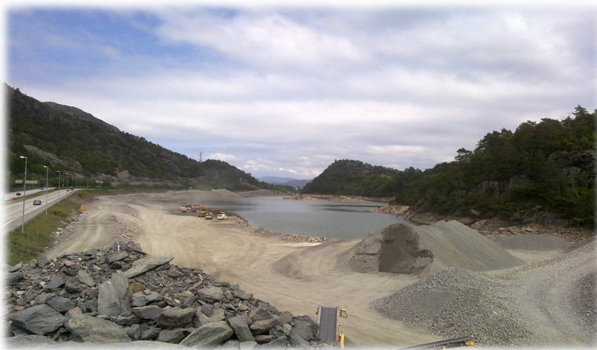
Figur 4: Utlegging av sprengsteinmasser i vann samt midlertidig deponering på land
