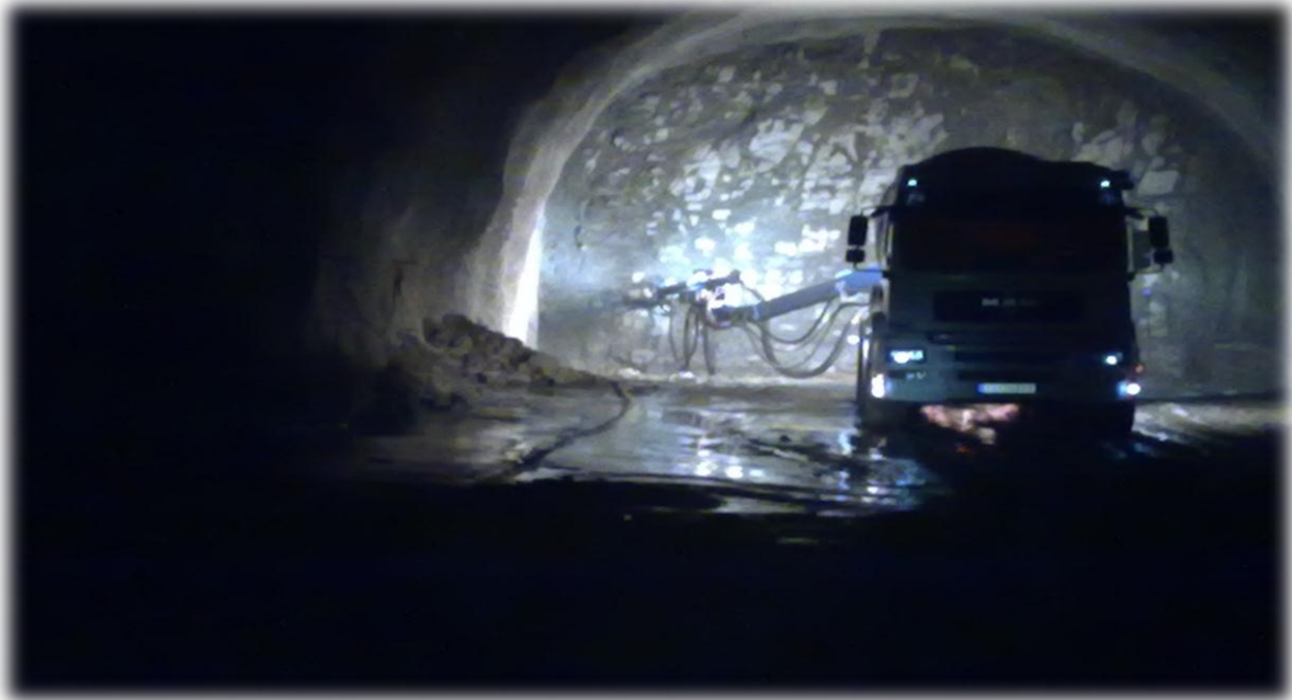
Figur 1: Sprøyting av betong i tunnel
