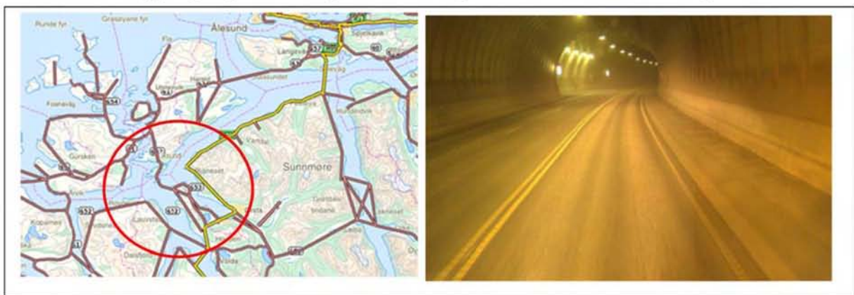
Figur 10: Eiksundtunnelen, Fv653, Møre og Romsdal. Kart og bilde
