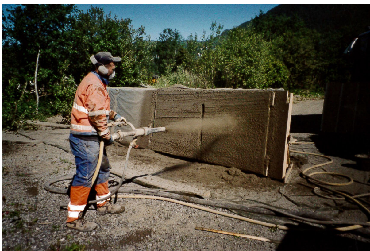
Foto 4 Sprøyting av overflate på paneler med 3 kg/m 3 fiber, etter avtrekking til jevn tykkelse.
