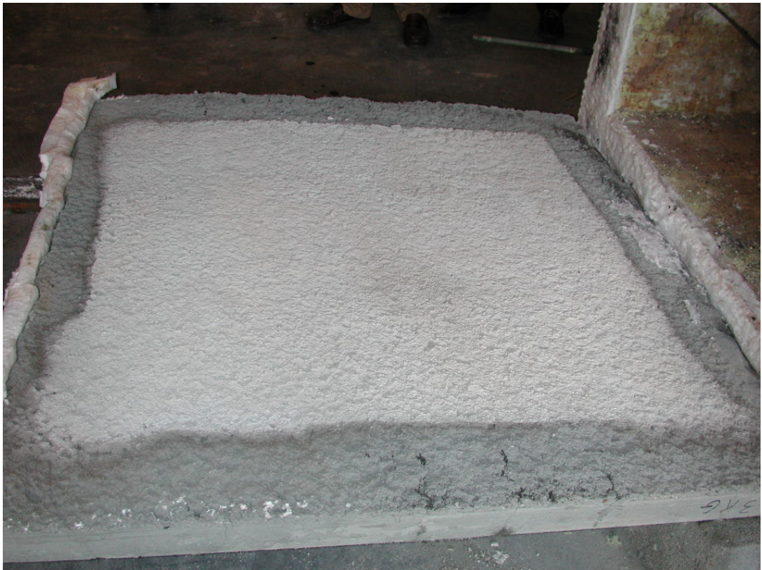
Foto 1: Eksponert side av prøvestykke A etter branntesten. Ingen avskalling.
