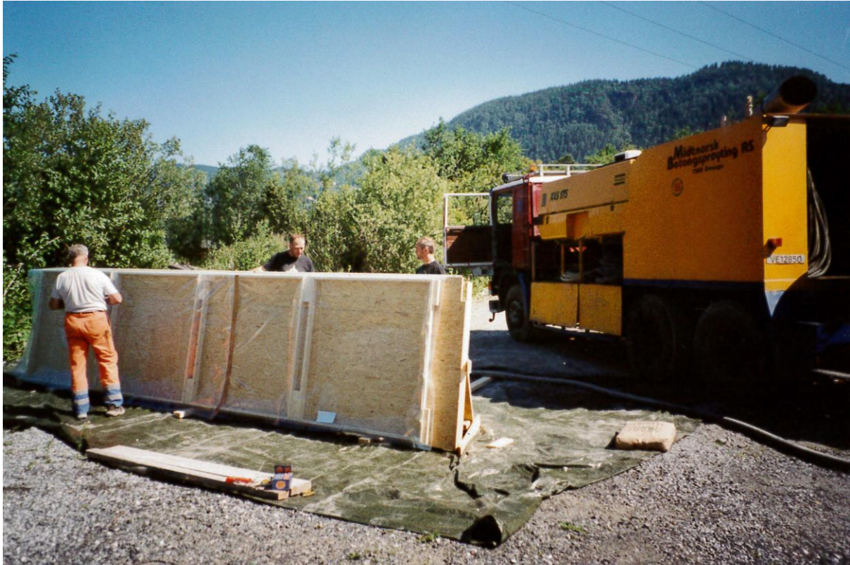
Foto 1 Oppstilling av forskaling
