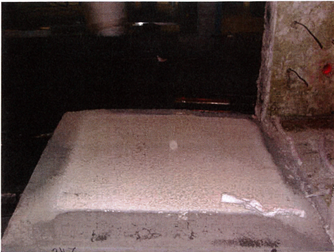
Foto 9: Eksponert side av prøvestykke I etter branntesten. Ingen avskalling.
