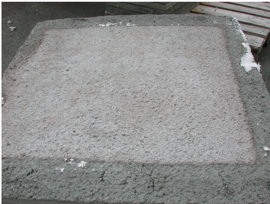
Foto 5: Eksponert side av prøvestykke E etter brann testen. Ingen avskalling.
