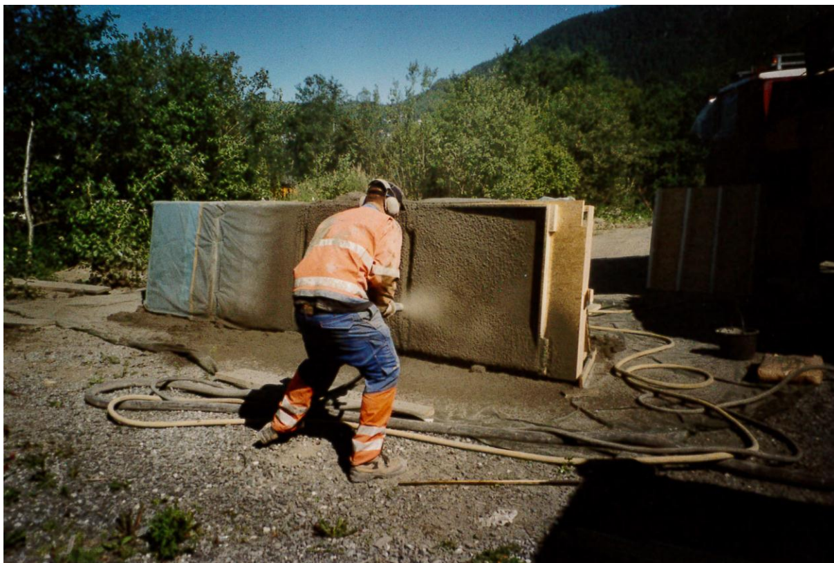
Foto 3 Paneler med 3 kg/m 3 fiber sprøytes, paneler med 2 kg/m 3 fiber tildekket med plast.
