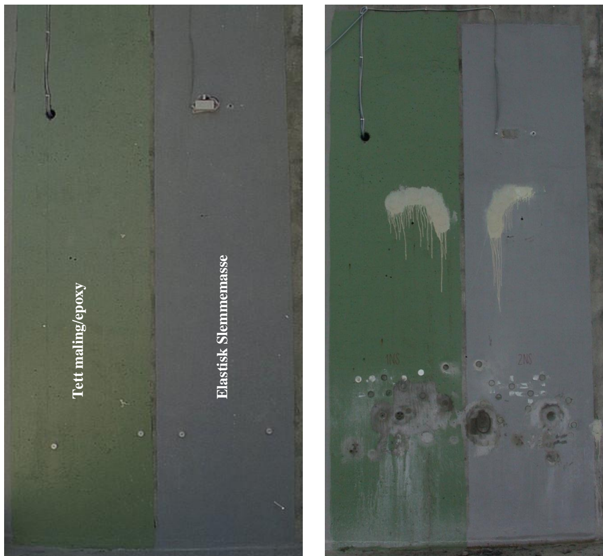
Figur 6 Produkt 1 og 2 på nordre side av søndre tårn i 1994 til venstre og 2005 til høyre. Bildet viser også omfanget av prøver som er tatt ut gjennom prosjektet. 1NS (grønn) til venstre, 2NS (grå) til høyre.
