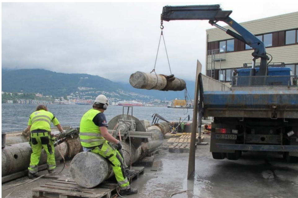
FIGUR 16: KUTTING AV MIDTDELEN AV SØYLE 6 (TIL HØYRE PÅ BILDET)
