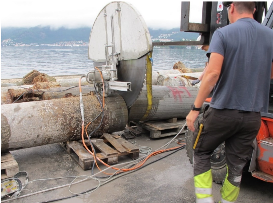
FIGUR 15: KUTTING AV MIDTDELEN AV SØYLE 4
