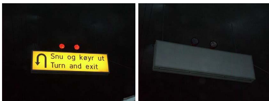
Figur 5.1 Eksempel på skilt og signal for snunisje i tunnel. To-posisjonsskilt vist i aktiv og passiv stilling. Ref. håndbok V321 Variable skilt .
