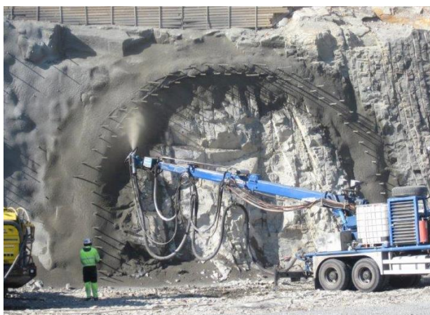
Figur 6.4 To raster med forbolter med 6 meter \varnothing 32 mm, bundet sammen med \varnothing 16 mm kamstål, innerste rast helt ned mot sålen. Illustrert i skisse til høyre: innerste rast 60-70 cm fra teoretisk sprengningsprofil med innbyrdes bolteavstand c/c 60-70 cm, og en ytre rast 60-70 cm utenfor denne igjen, satt slik at boltene i ytre rast plasseres midt mellom to bolter i indre rast (såkalt W-mønster). Ringveg Vest Bergen, 2. byggetrinn (Foto T.Kirkeby).
