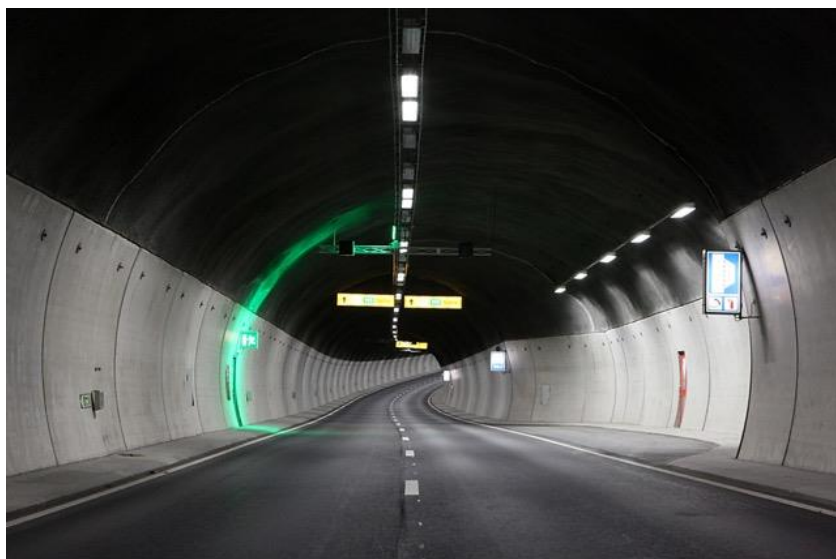
Figur 9.1 Belyst havarinisje, sett i forhold til belyst rømningsvei og veg (nisje tar ikke vekk oppmerksomhet fra trafikkbildet, og gir liten blanding). (Foto: A.P. Søvik)
