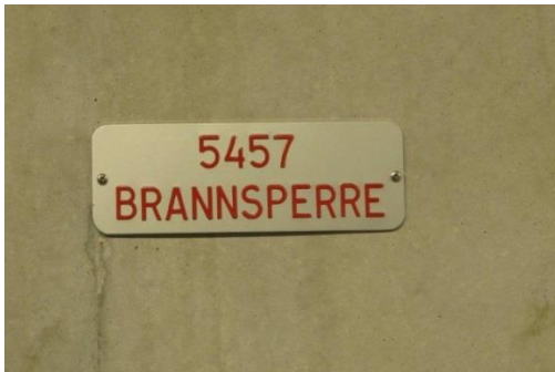
Figur 4.4 Lite, veggmontert skilt som markerer brannseksjonert felt. Nestunnelen 2014.
