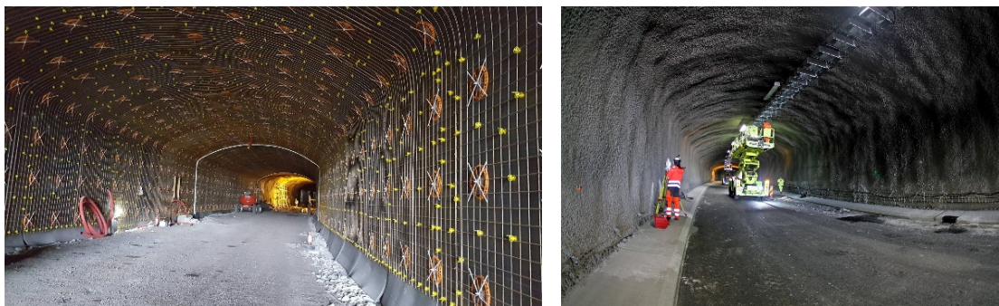
Figur 99: Rehabiliteringsarbeid i Brynstunnelen. Kilde: Statens vegvesen
