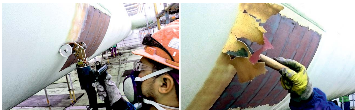
Figur 15. Fjerning av malingsbelegg med induksjonsoppvarming. Foto: Abadi Oil and Gas Services
