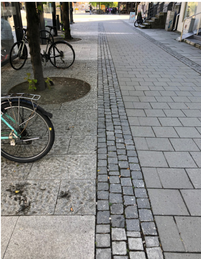
Bilde 4.3: Dette er et godt eksempel på bevisst materialbruk i ulike soner. Ferdselssonen har jevn asfalt og står i kontrast til møbleringssonen av gatestein. I kjørebanelen er det lagt store heller for syklistene. Da det er mer behagelig å gå på heller enn gatestein, velger mange å gå på hellene noe som kan skape konflikt mellom syklende og gående. Nedre Bakklandet, Trondheim. Foto: Frøydis Hollakleiv.
