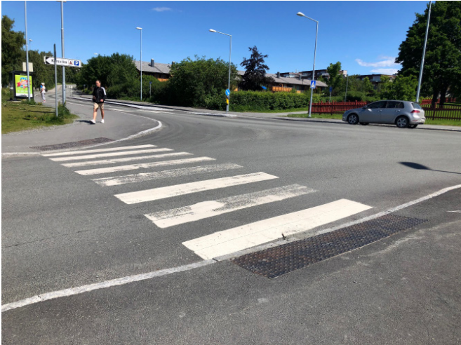
Bilde 4.5: Før gangfeltet er det etablert et varselfelt, men det mangler retningsindikatorer tvers over fortauet slik at blinde blir oppmerksomme på overgangen. Lade, Trondheim. Foto: Frøydis Hollakleiv.
