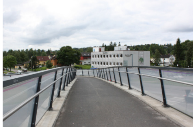
Bilde 3.2: Både rekkverk og håndlist heller innover mot ferdselssonen, og gjør det lettere for rullestolbrukere å få et godt grep. Foto: Statens vegvesen.
