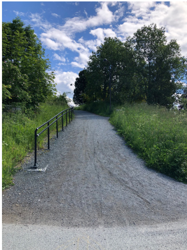
Bilde 2.22: Bred snarveg med grusdekke, håndlist og benk. Festningen, Trondheim. Foto: Frøydis Hollakleiv.
