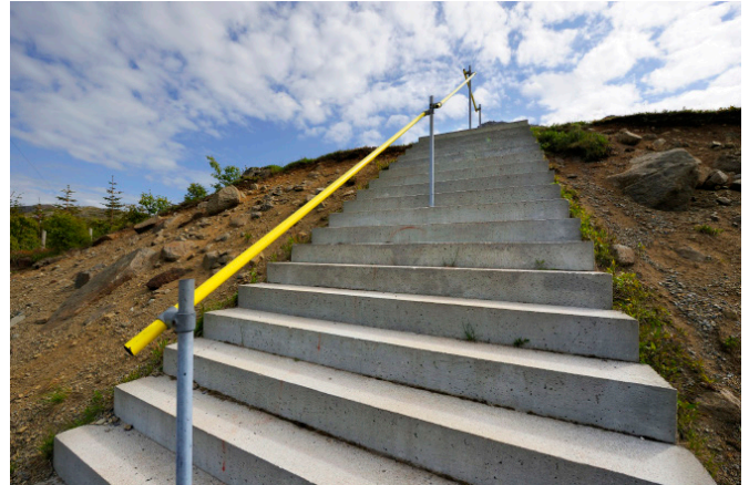
Bilde 2.24: Eksempel på fargebruk på håndlist som gjør den enkel å legge merke til. Flakstad. Foto: Jarle Wæhler.
