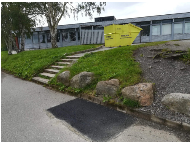
Bilde 2.25: Trappen kunne med fordel hatt rekkverk med håndlist, og vært bedre markert. Eldre med rullator vil muligens velge den dårlig utformede stien ved siden av for å enklere komme seg fram med hjul. Madla, Stavanger. Foto: Jahn Ivar Kjølseth.
