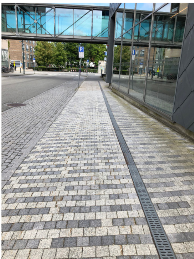
Bilde: 2.3: Vannrennen fungerer som ledende element. St. Olavs hospital, Trondheim. Foto: Frøydis Hollakleiv.
