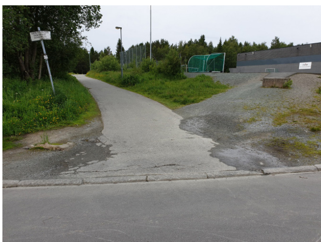
Bilde 2.18: Her er det høy kantstein gjennom krysset mellom to gang- og sykkelveger. På sykkel er det utfordrende og svinge og forsere en høy kant samtidig. Kantsteinen bør fjernes eller senkes. Tiller, Trondheim. Foto: Liv Øvstedal, Statens Vegvesen
