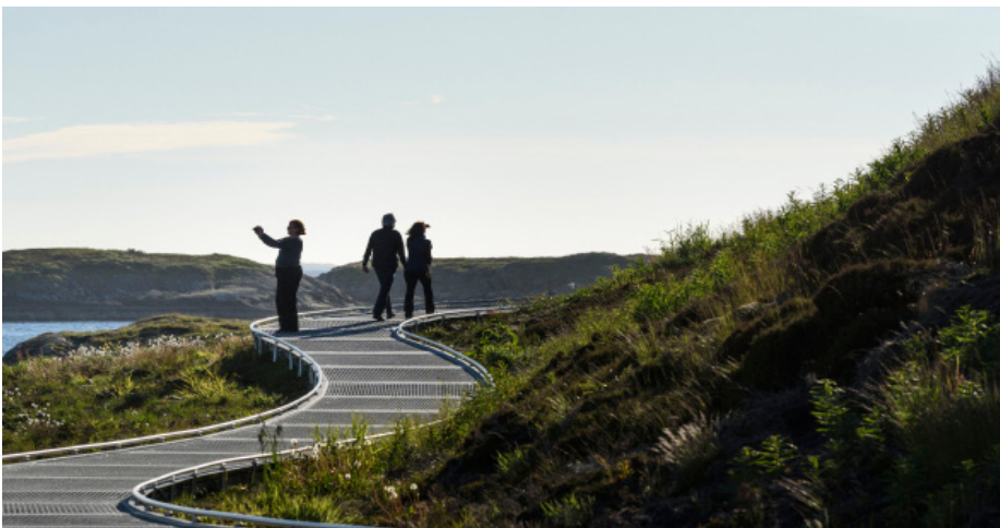
Bilde 3.3: Langs denne opparbeidede gangvegen sørger føringskanten langs sidene for at blinde ikke trækker utenfor. Foto: Roger Ellingsen.
