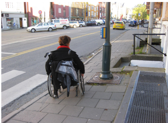
Bilde 2.1: Her er veggsonen bred og ferdselssonen blir for smal. I tillegg står lysstolpen midt i vegen og trappen stikker ut i ferdselssonen. Veggsonen kan gjøres smalere, trappen synligere og ferdselssonen bredere forbi lysstolpen. Kan fortauet gjøres bredere i dette partiet for å gi bedre passering av lysstolpen? Trondheim. Foto: Statens vegvesen.
