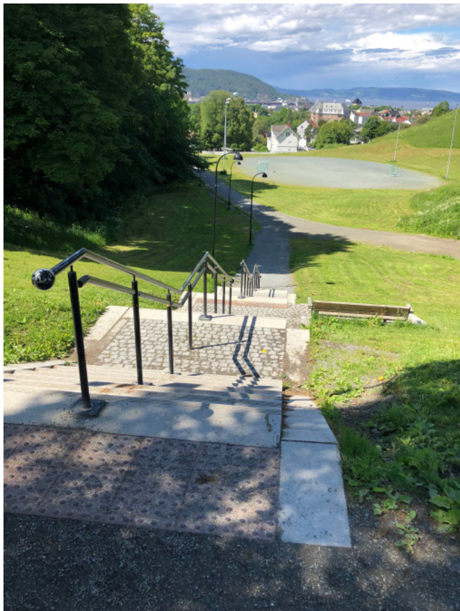
Bilde 2.21: Trapp etablert der det før gikk en sti, med håndlist og benk. Duedalen, Trondheim. Foto: Frøydis Hollakleiv.
