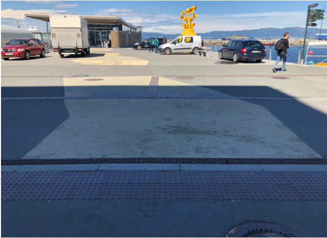
Bilde 4.8: Her er det brukt et lyst dekke for å markere kryssingen over sykkelvegen og gangvegen. Det lyse underlaget fortsetter hele vegen til hurtigbåtkaia. Her ser man også hvor mye kontrastene blir påvirket av sol- og skyggeforhold. Brattørkaia, Trondheim. Foto: Frøydís Hollakleiv.
