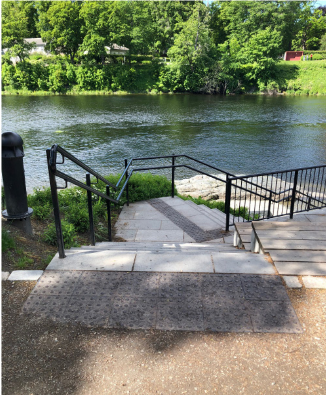
Bilde 2.23: Trappen har håndlist i to høyder, taktill markering, og en kontrasterende farge til omgivelsene. Mangler håndlister på begge sider. Gåsaparken, Trondheim. Foto: Frøydis Hollakleiv.
