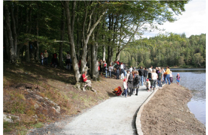
Bilde 2.11: Gang- og sykkelvegen/turvegen har kantsteinslinje på siden ut mot vannet, sannsynligvis for å sikre at folk ikke havner ut i vannet. På den andre siden vil det ikke være nødvendig da det er god lyshetskontrast og få farer. Foto: Statens vegvesen.
