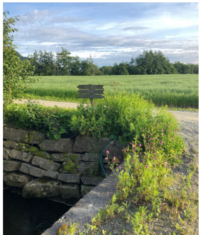
Bilde 3.10: Her er en turveg skiltet, men skiltene har dårlig lyshetskontrast mot omgivelsene og skriften er vanskelig å tyde. I tillegg er skiltet plassert på kanten av en kanal som gjør det er umulig å komme helt inn til. Det kan oppstå farlige situasjoner som at folk faller ut i kanalen. Skiltet burde plasseres lengre til høyre i krysset og det burde vært rekkverk over broen. Melhus. Foto: Frøydis Hollakleiv.
