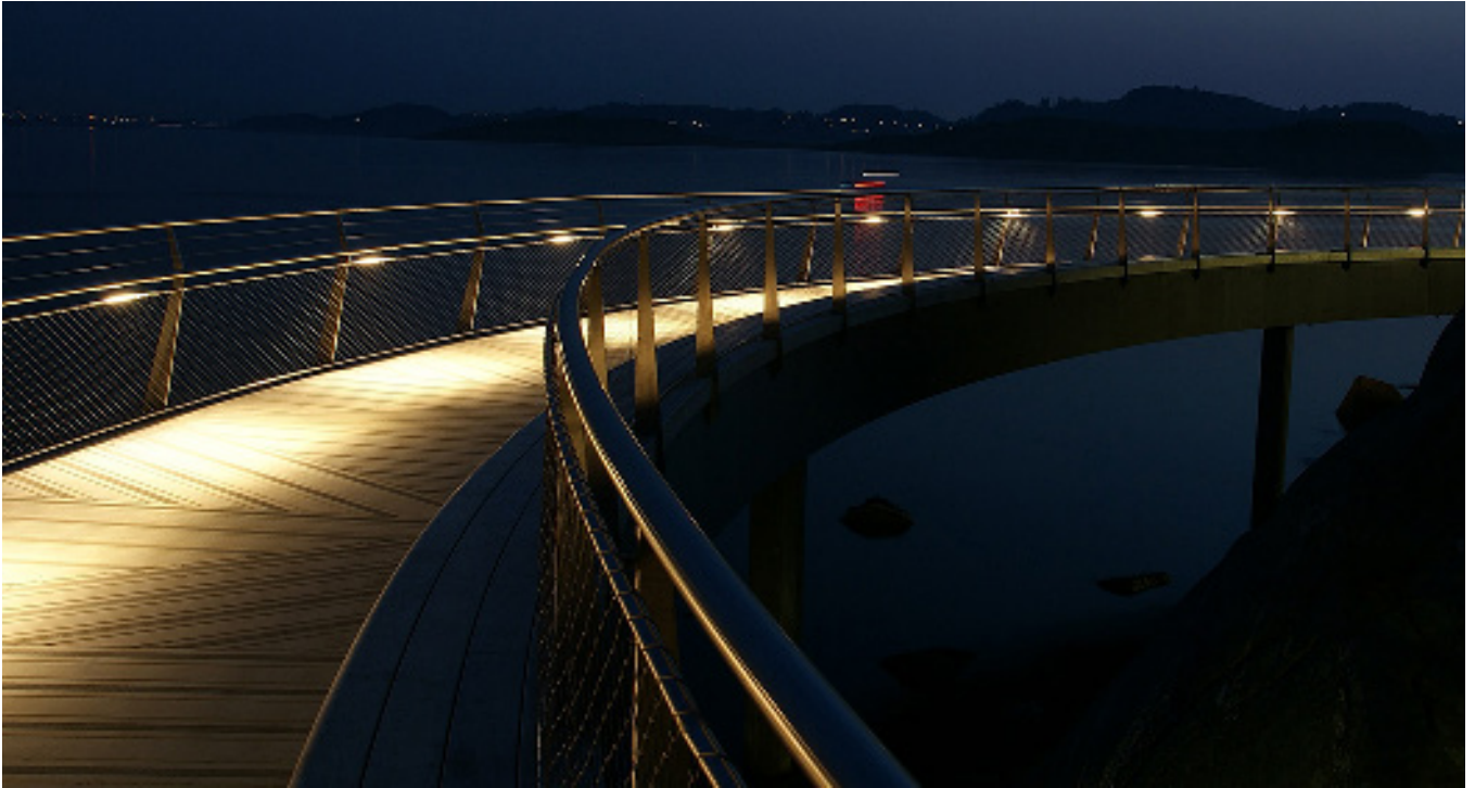
Bilde 3.6: Belysning langs rekkverk som gir jevn og god belysning. Hohammeren bro, Stavanger. Foto: Gaute Fornes, Multiconsult.
