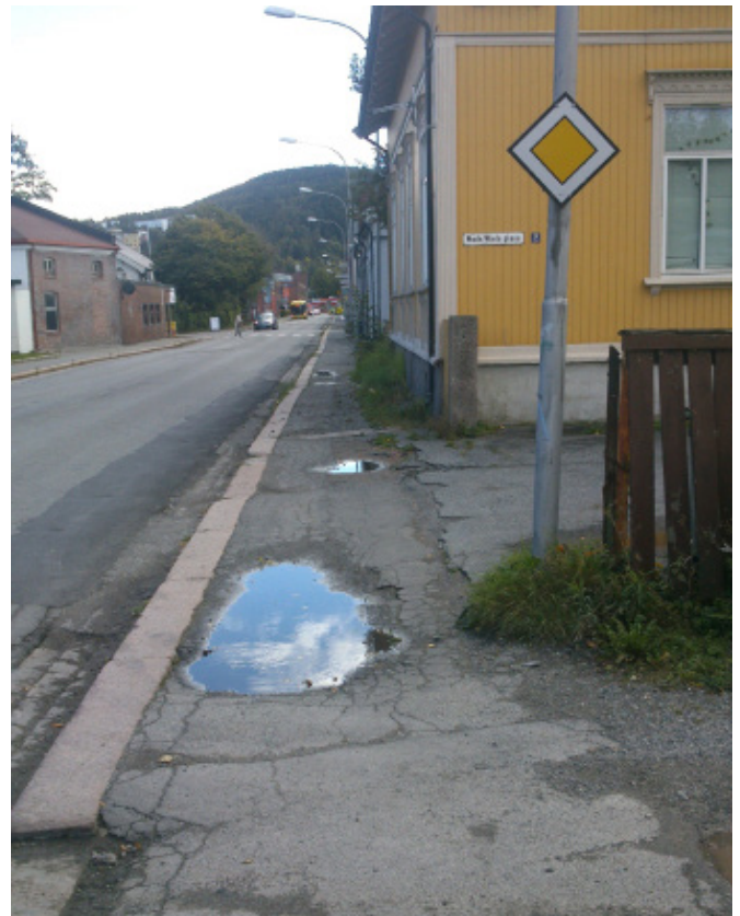
Bilde 4.2: Fortauet har et ujevnt dekke som danner store sølepytter. Det er vanskelig for personer med nedsatt bevegelse å passere uten å bli våt. Her bør det reasfalteres. Drammen. Foto: Liv Øvstedal, Statens Vegvesen.
