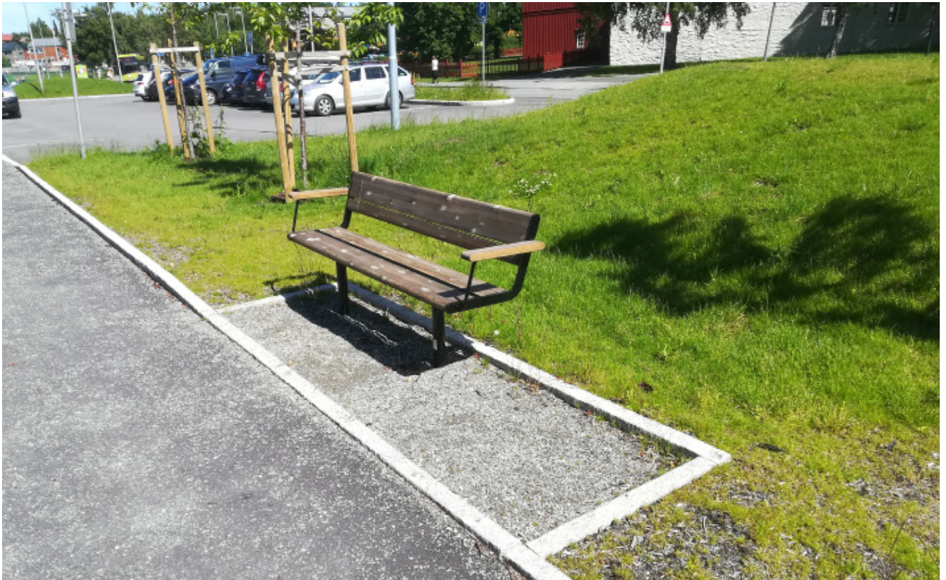
Bilde 3.4: Benken har rygglene og armlener, det er plass til rullestol ved siden av og benken har god avstand til ferdselssonen. Både benken og underlaget har god lyshekskontrast til omgivelssene. Lade, Trondheim. Foto: Jahn Ivar Kjølseih.
