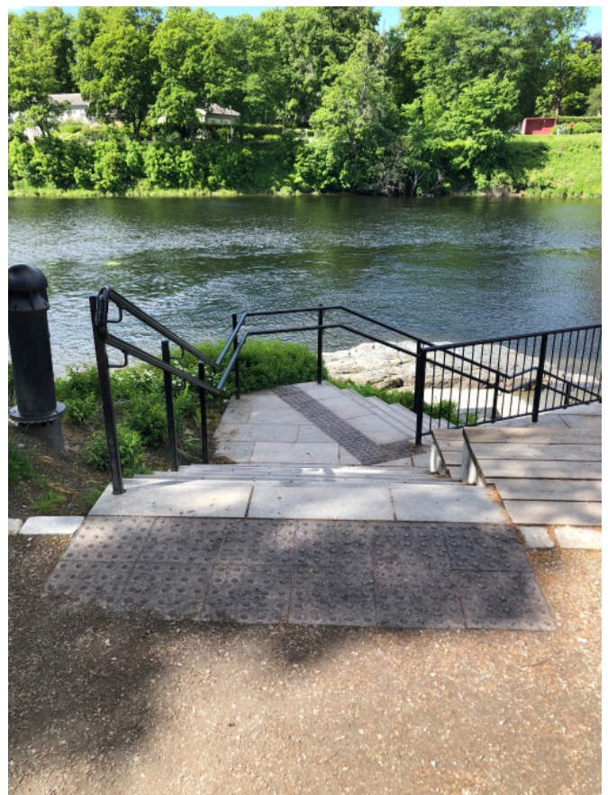
Bilde 4.7: Varsselfelt inn mot trapp. Gåsaparken, Trondheim. Foto: Frøydis Hollakleiv.
