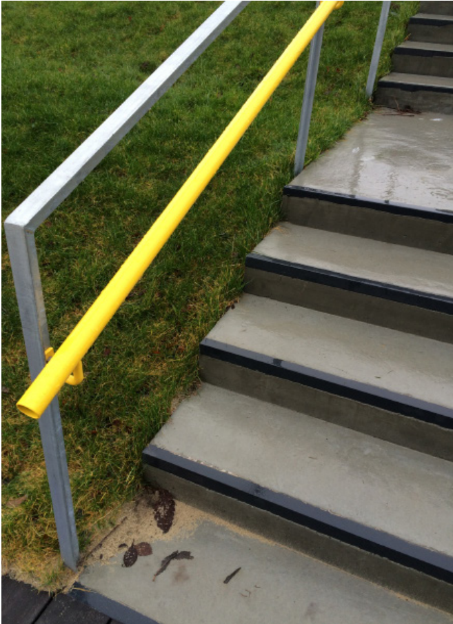
Bilde 3.1: Gul håndlist gir god synlighet og kontrast. Den runde formen er lett og behagelig å holde i. Håndlisten mangler avbøying på enden. Bryne. Foto: Siw Øie Norheim.
