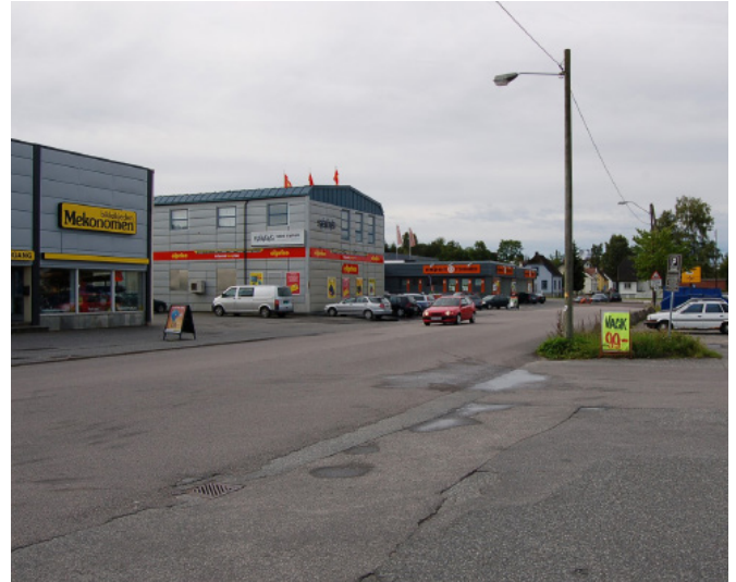
Bilde 2.6: Dette er et stort og åpent areal bestående stort sett av asfalt, og det er få kontraster og ledende element som skiller fortau fra vegbane og parkeringsplass. Her burde ferdselssonen fått en tydelig avgrensning mot annet dekke som ga bedre visuell og taktil inndeling. Foto: Statens vegvesen.
