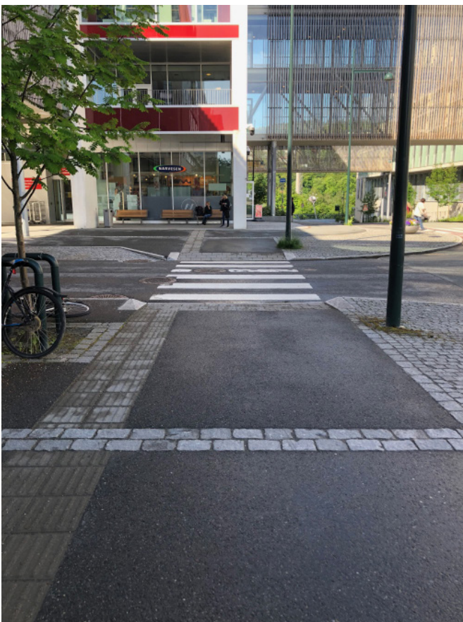
Bilde 4.6: Retningsindikatorer og varselfelt før gangfelt. St. Olavs hospital. Foto: Frøydis Hollakleiv.
