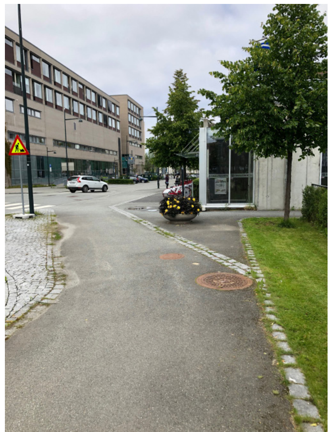
Bilde 2.8: For å sikre at personer med nedsatt syn oppdager at ferdselssonen endrer retning, er ferdselssonen avgrenset med to rader gatestein. Blomsterpottens skål-form kan skape kollisjonsfare for personer med nedsatt syn. St. Olavs hospital. Foto: Frøydis Hollakleiv.
