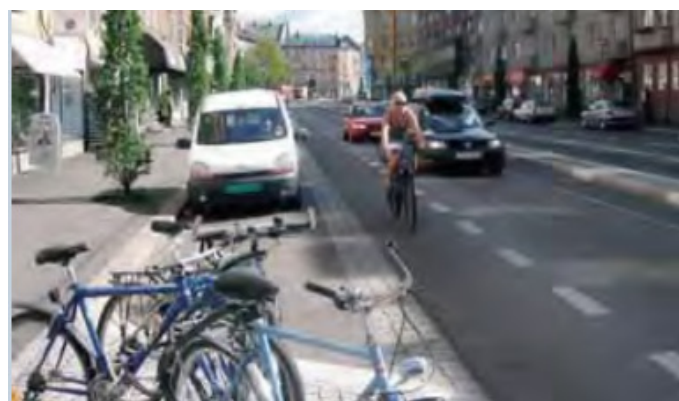
Figur 3.41: Sykkelfelt og vareleveringslomme i en gate i Oslo. Foto: V126 Varelevering i byen.
