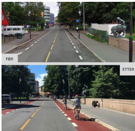
Figur 3.17: Rødt dekke: Sykkelfeltene oppleves som tydeligere og tryggere, og dermed mer attraktive. (Sykkelprosjektet/Oslo kommune, u.d).
