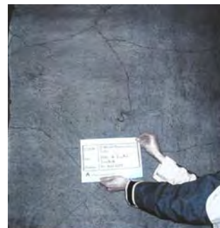
Seltener-Drassentunnel, Spritzbeton (s. Kapitel 3.1.4.)
