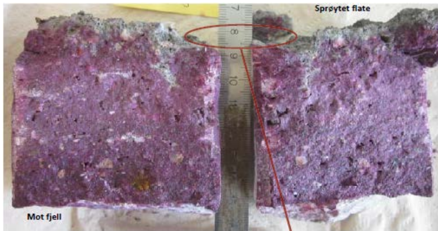
VI.10. Pelnummer 405 høgre. Kjerne 405-8. Overflatekarbonatisering inn til 5 mm samt lokalt på riss inn frå overflata. Ikkje karbonatisering frå heftsona mot bergmassen. Betongalder 14 år. Foto: Mannvit.
