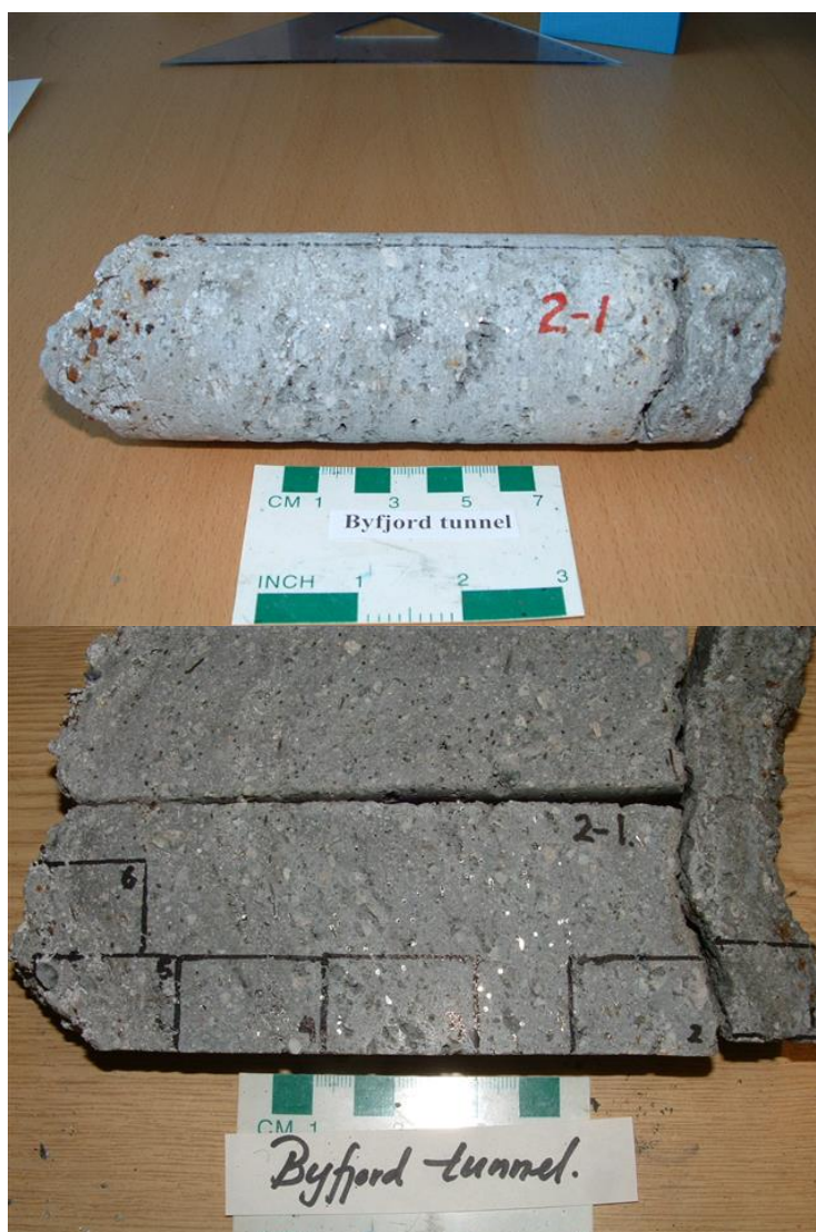
V4.38. Kjerne Core 2-1 (pel 2868) med tynnslipområder. Stålfiberkorrosjon 20-30 mm inn frå bergsida (venstre ende) og ytre avskaling (høgre). Betongalder 13 år. Foto: Per Hagelia.
