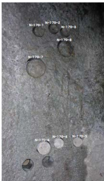
VI.15. Prøvestader ved pel 170. Bora ut i 2014. Betongalder 13 år. Foto: Arnhild Fjose.
