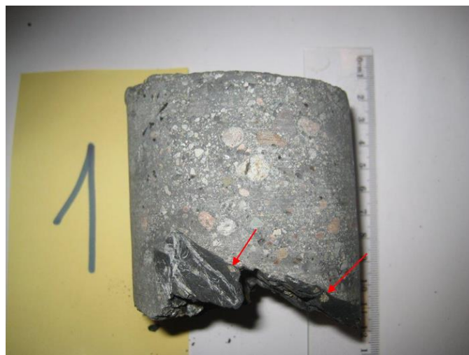
Figur 4.38: Eksempel på intakt sprøytebetong på grunn av svært god heft mot alunskifer i Svartdaltunnelen (betongalder: 16 år). Ikkje-reagerte svovelskorn < 1 mm frå heftsona (pilar). Resultat & foto, Jon Gulland (2015).
