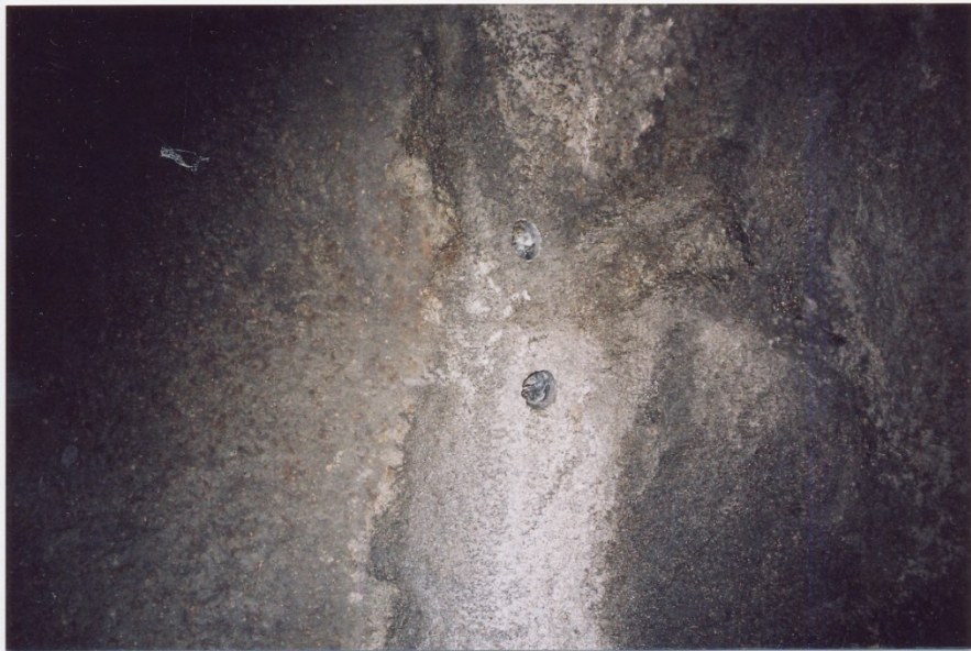
Km 5,245 h.s. før og etter boring.
