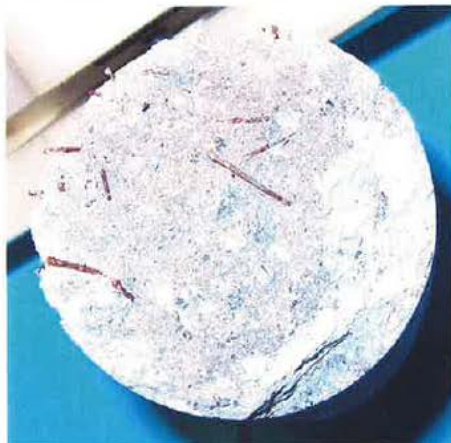
Foto nr 4-6."fk17", henholdsvis hel kjerne (med overflaten mot venstre), overflate (mot tunnel) og endeplate (fjellkontakt). Det kan observeres stålfiber i betongen, også på endeplaten.
