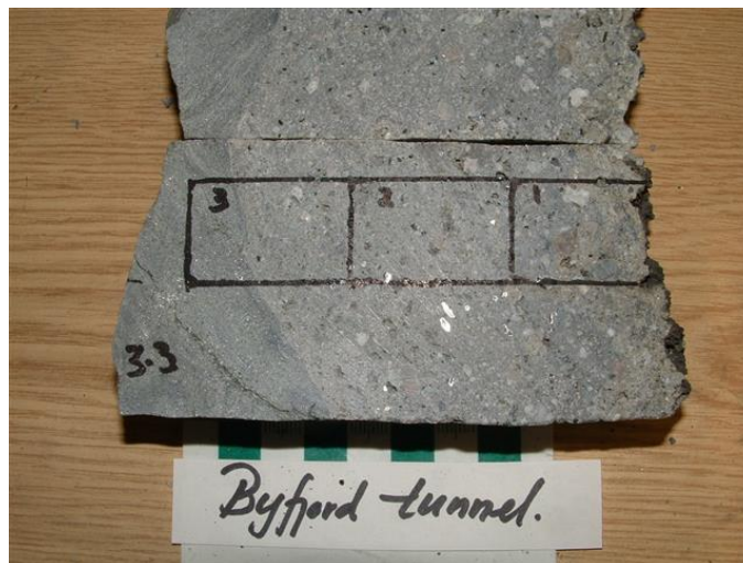
VI.28. Kjerne 3-3 frå pelnummer 4410 med tynnslipområder. Bora ut i 2004. Svært god heft utan omvandling og utfellingar. Karbonatiseringsdjup i kontakt med tunnelluft er på 20 mm med litt marginal fiberkorrosjon. Betongalder 13 år. Foto: Per Hagelia..
