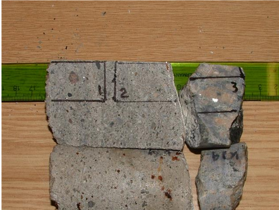
V4.99. Kjerneprøve Kj 9 ved pelnummer 15930 utan biofilm. Innteikna tynnslipområder. Middels heft med utfelling av kvit Mg(OH)_2 (brucitt) og kalsiumkarbonat (magnesium kalsitt, kalsitt og aragonitt). Betongalder 5 år. Foto: Per Hagelia.
