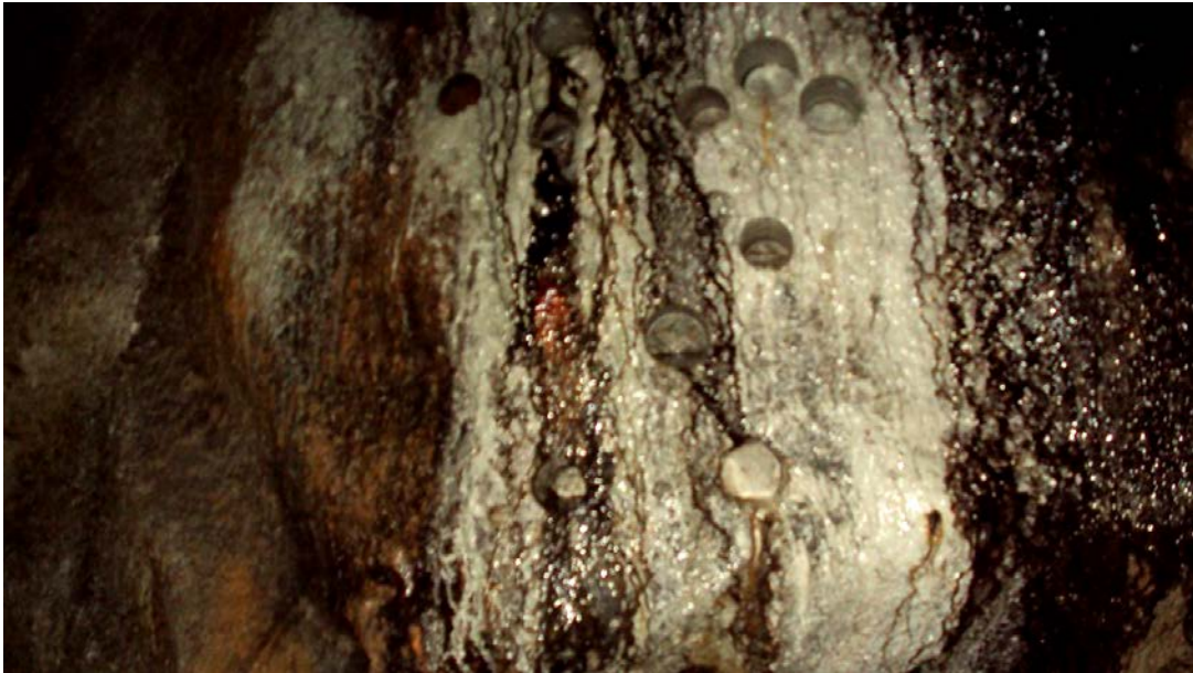
V4.88. Pelnummer 15925 etter utboring av fire nye kjerner i samband med Varige konstruksjonar ved betongalder 16 år i 2015 (større diameter enn kjernene frå 2004). Foto frå mars 2016 ved betongalder 17 år. Område har vore svært fuktig sidan 1999. Merk utfelling omfattande utluting av kalsium og utfelling av kalsiumkarbonat (har litt Mg) som har auka på med tida (sjå V4.81). Kalsiumkarbonatet er utfelt over eldre mørk biofilm, med nye striper av mørk biofilm utanpå. Foto: Per Hagelia.
