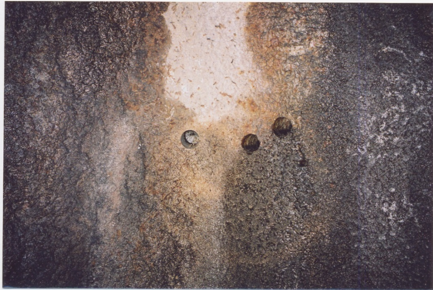
Km 6,150 h.s. ved tidlegare boring.
