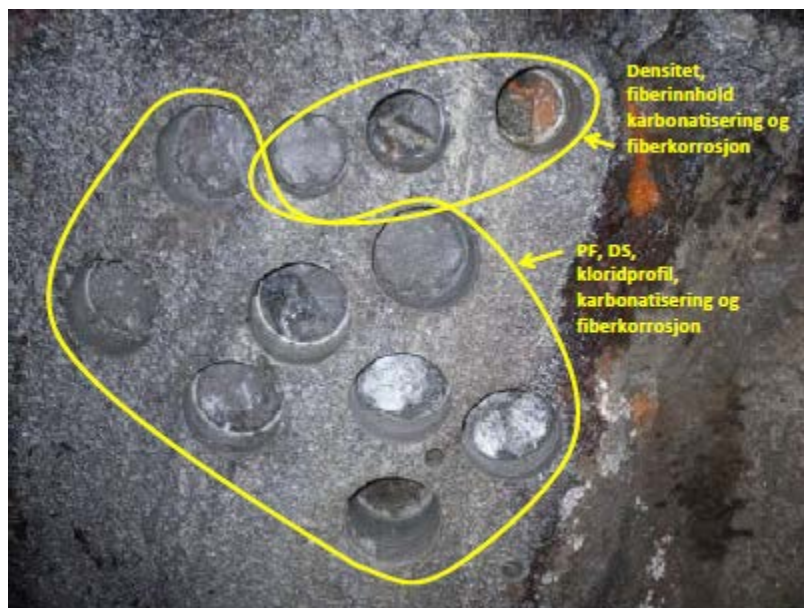
V4.6. Flekkerøytunnelen, pelnummer 1380H. Bergoverflata var våt, delvis med biofilm. Kjernene blei bora ut 4 meter over vegbana. Betongalder 26 år: Foto: Mannvit.
