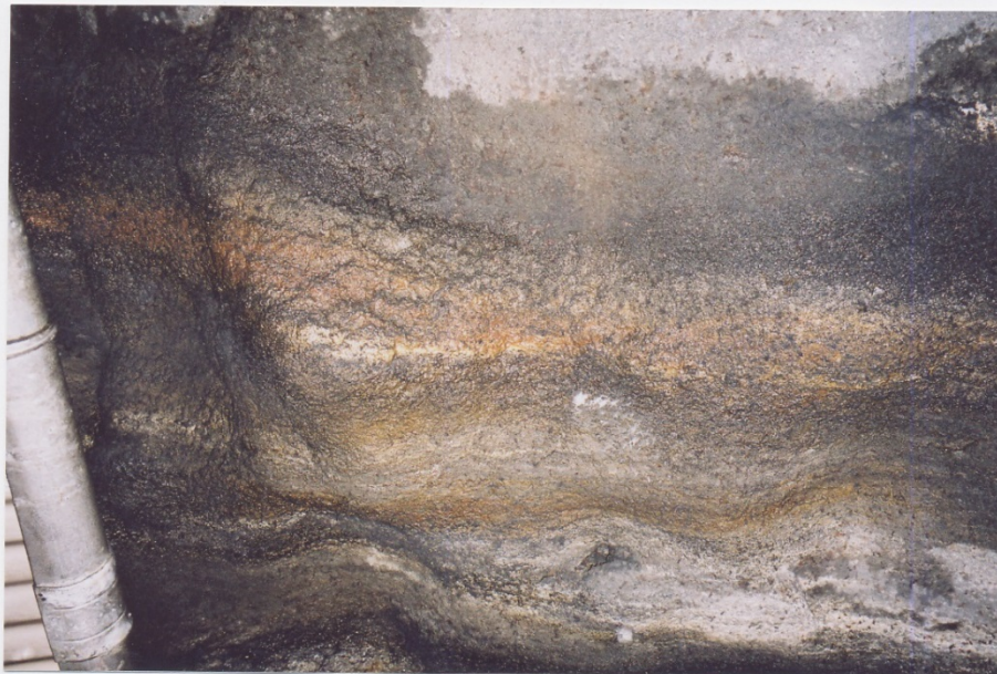
Km 5,700 h.s. før og etter boring.
