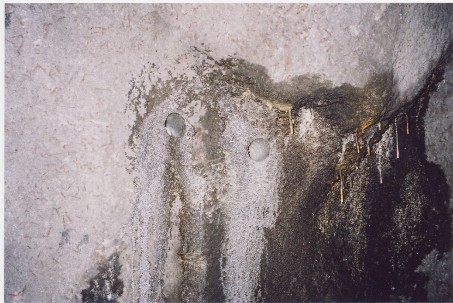
Km 4,032 h.s. før og etter boring.
