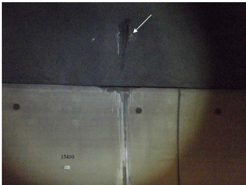
VI.29. Utboring av sprøytebetongkjerner frå bergsikringa i 2009 (pil). Betongalder 10 år. Foto: Jan Viggo Holm, Norconsult.
