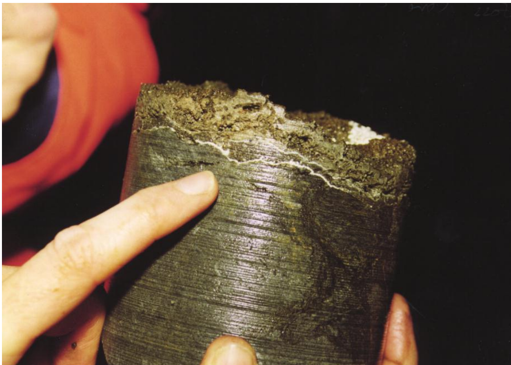
V2.1. Kjerne P00/1570/1, bora ut i 2000. Betongalder 16 år. Fullskala thaumasitt sulfatangrep (TSA) var avgrensa til svært tynn betong. Foto: Ted Sibbick, BRE.
