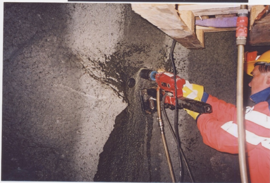
Km 3,910 h.s. Tidlegare boring under takrenna.
