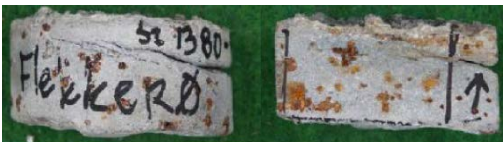
V4.21. Kjerne 1380-9 med tynnslipområde. Avskaling og fiberkorrosjon. Muleg er noko av betongen tæra bort. Betongalder 26 år. Foto: Mannvit.
