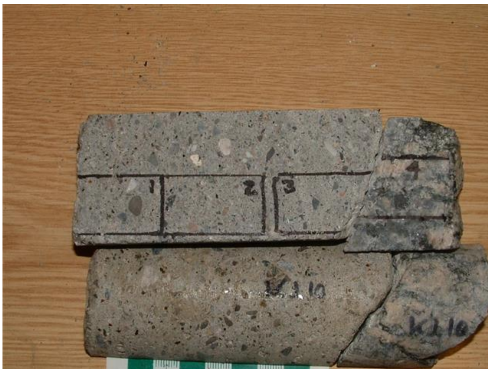
V4.100. Kjerneprøve Kj 10 ved pelnummer 15930 utan biofilm. Innteikna tynnslipområder. Middels heft med utfelling av Mg(OH)_2 (brucitt) og kalsiumkarbonat (kalsitt). Betongalder 5 år. Foto: Per Hagelia.
