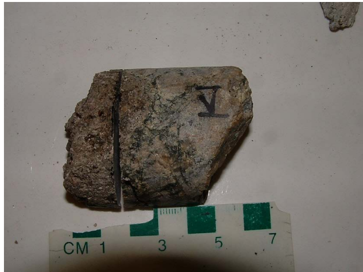
V4.95. Kjerne KJ V under tykk syregivande biofilm hadde mista svært mykje av overflata. Merk den svake overflata (venstre): mykje av kjerna i denne delen fragmenteret og gjekk tapt under utboring (estimert tap ca. 20 mm). Resten av betongen hadde stort omfang av thaumasitt sulfatangrep, magnesiumangrep og utfelling av Popcornkalsitt. Betongalder 5 år. Foto: Per Hagelia.
