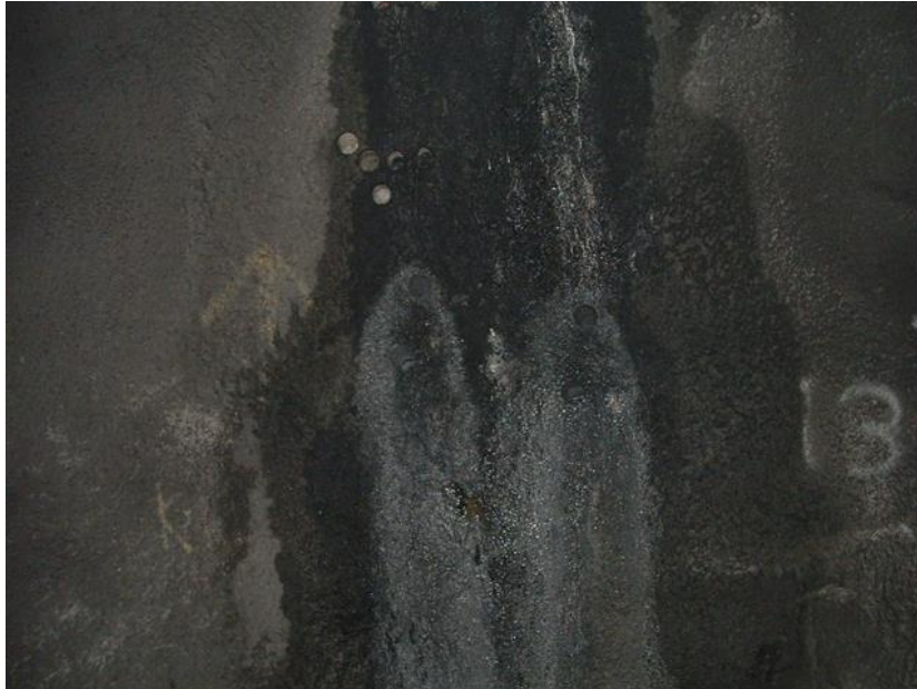
V4.31. Lokalisering av kjernene (Core-) 1-1, 1-2, 1-3 og 1-4 på pelnummer 2862 i relativt tørt område (midt på bildet: nedre del vått etter utboring i 2004). Tidlegare kjerneboring av Røhrsveen og Lygre (1996); 5 kjerner lengre opp, blei bora ut medan det fortsatt var vått (mørkt område). Betongalder 13 år. Foto: Per Hagelia.
