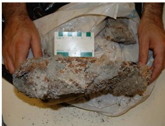
Figur 4.104: Sterkt forvittra og svært svakt betongflak Oslofjordtunnelen frå område med høgt vasstrykk. Betongen kunne brytast opp med handmakt.
