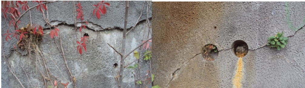
V3.1. Oversikt over prøvepunktene frå 2000 sett i 2014. Kjerneprøver ( d = 100 \text{ mm} ): Core 1 og 2 (venstre bilde) og Core 3 og 4 (høgre). Foto: Per Hagelia.
