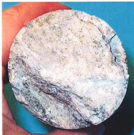
Foto nr 1-3. "fk3", henholdsvis hel kjerne (med overflaten mot venstre og fjell i indre del), overflate (mot tunnel) og endeflate (fjell). Det kan observeres stålfiber i betongen.
