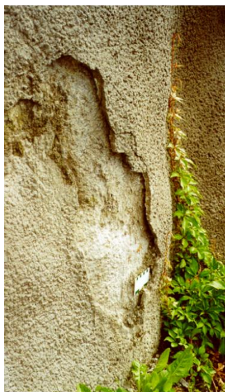
Figur 4.42: Åkebergveien Oslo, år 2000. Avskaling av stålfiberarmert sprøytebetong langs ei ca. 20 mm sone av fullstendig pulverisert betong av thaumasitt, kalsitt og kvarts. Stålfiberen var totalt omvandla til rust.
