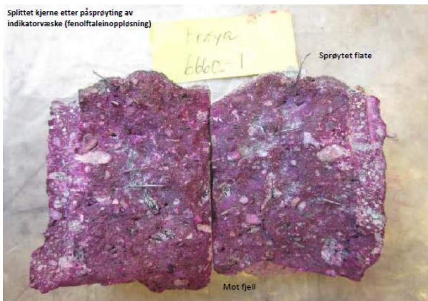
V4.77. Kjerne 1 frå pel 6660 viste i gjennomsnitt 1 mm karbonatisering frå tunnelsida utan karbonatisering mot berg.
