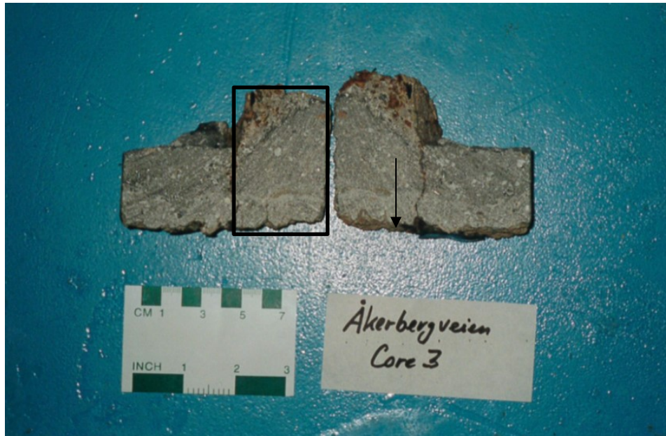
V3.7. Kjerne Core 3 med tynnslip område for BRE nr. P00/1570/29. Sprøytebetong med omfattende stålfiberkorrosjon knytta til syreangrep mot alunskifer (Sone A). Betongalder 13 år. Litt alunskifer bevart i venstre kjernehalvdel. Foto: Per Hagelia.
