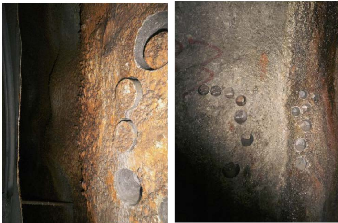
V4.73. Pelnummer 4795V, borkjerner frå område med fuktig jernrik biofilm og 6660H (høgre) frå område med både tynn biofilm (høgre del av bildet) og fuktig betong utan biofilm (venstre del). Betongalder 15 år. Foto: Mannvit.
