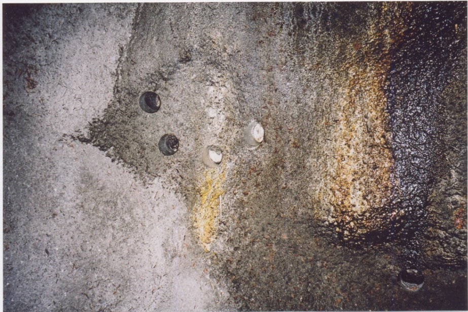
Km 4,890 i nisje h.s. før og etter boring. Tidlegare boring i nedre høgre hjørne.
