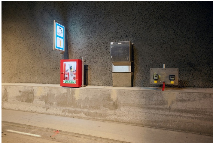
Figur 1 Eksempel på integrerte løsninger for nødstasjoner, skap m.m. Foto: Carsten Koføed SVV
