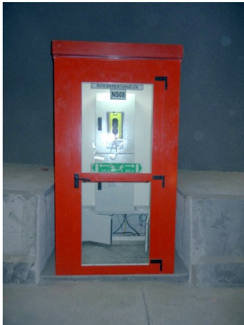
Figur 1 Eksempel på integrerte løsninger for nødstasjoner, skap m.m. Foto: Carsten Koføed SVV
