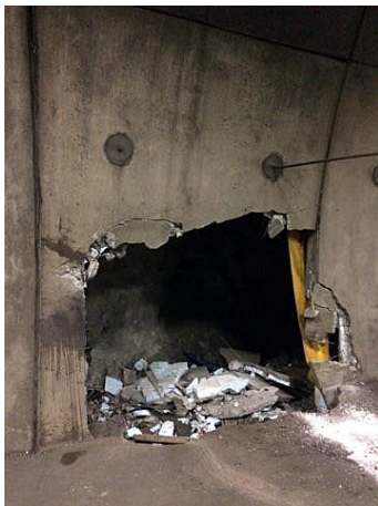
Figur 2 Eksempler påkjørselskader
