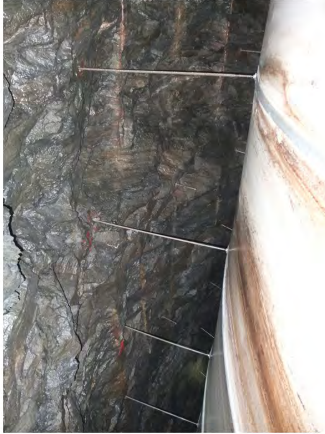
11 Baksiden av hvelv - seksjon mo øst
