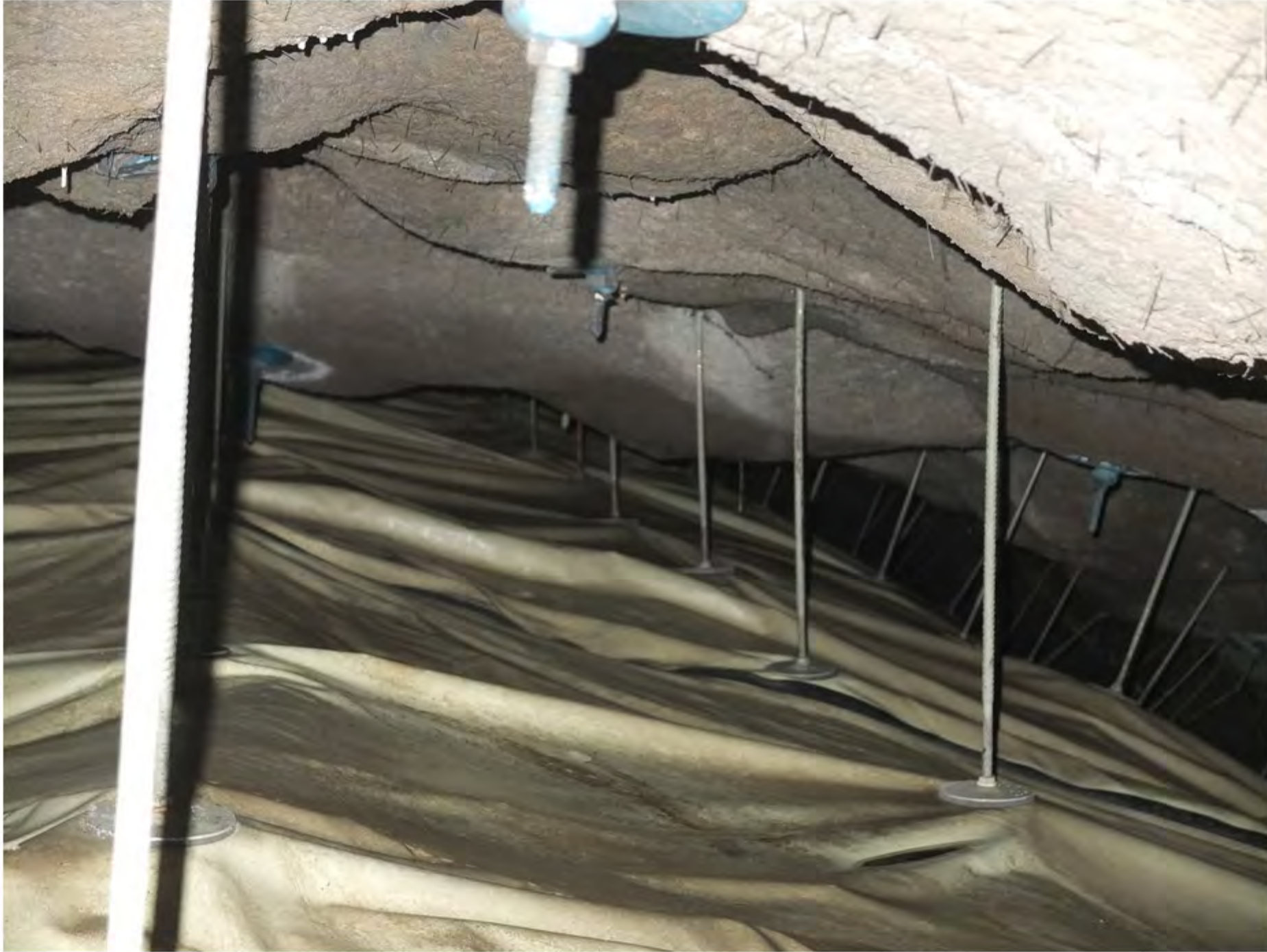
11 Oversiden av takhvelv
