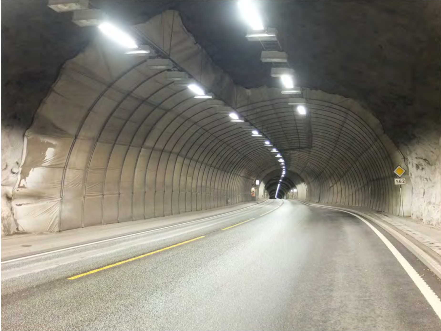
5 Tunnelkledning innenfor søndre portal
