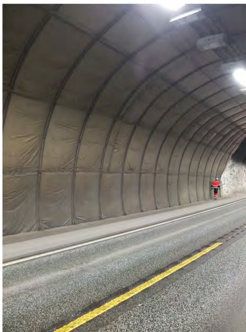
2 Tunnelkledning innefor nordre portal
