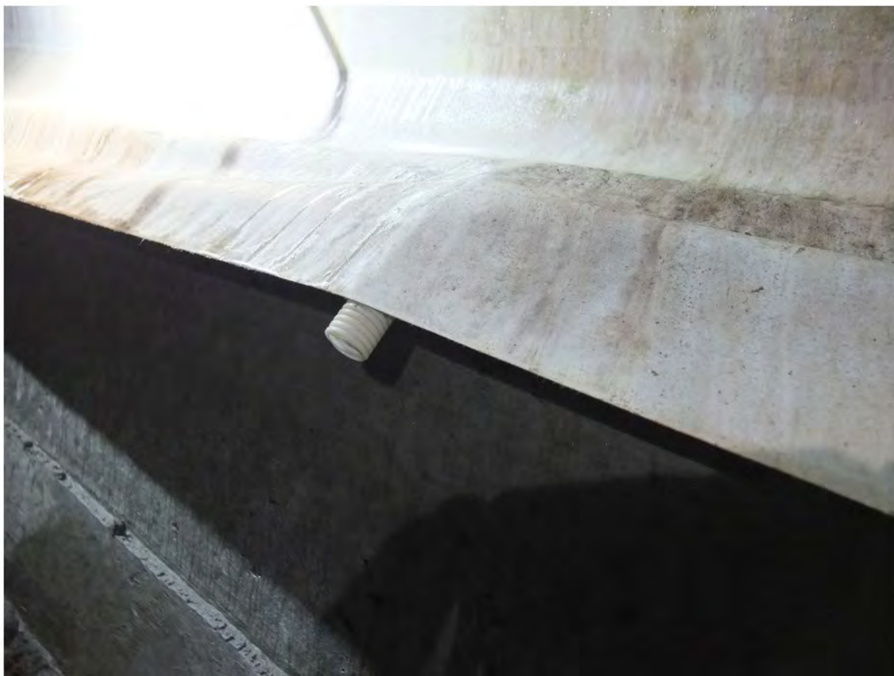
16 Dreneringsdetalj over betongbankett på baksiden av hvelv
