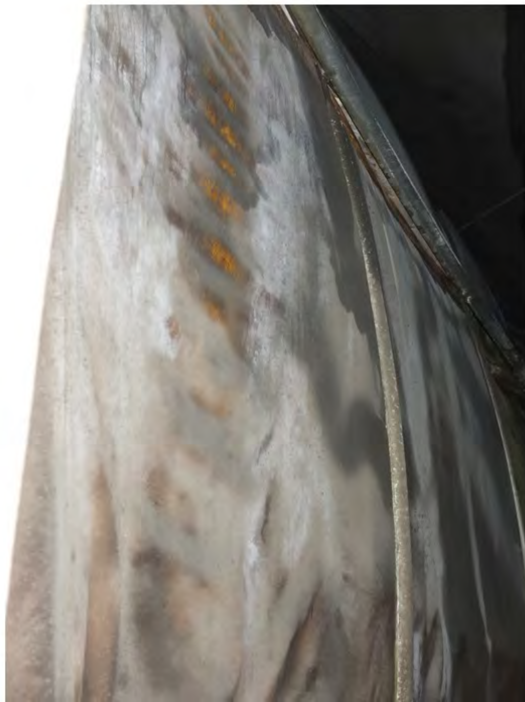
22 Baksiden av isolert hvelv
