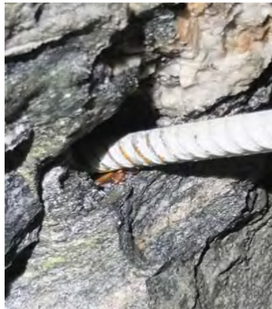
Foto 2.10.13. Lokal skade på korrosjonsbeskyttelse på kammer
