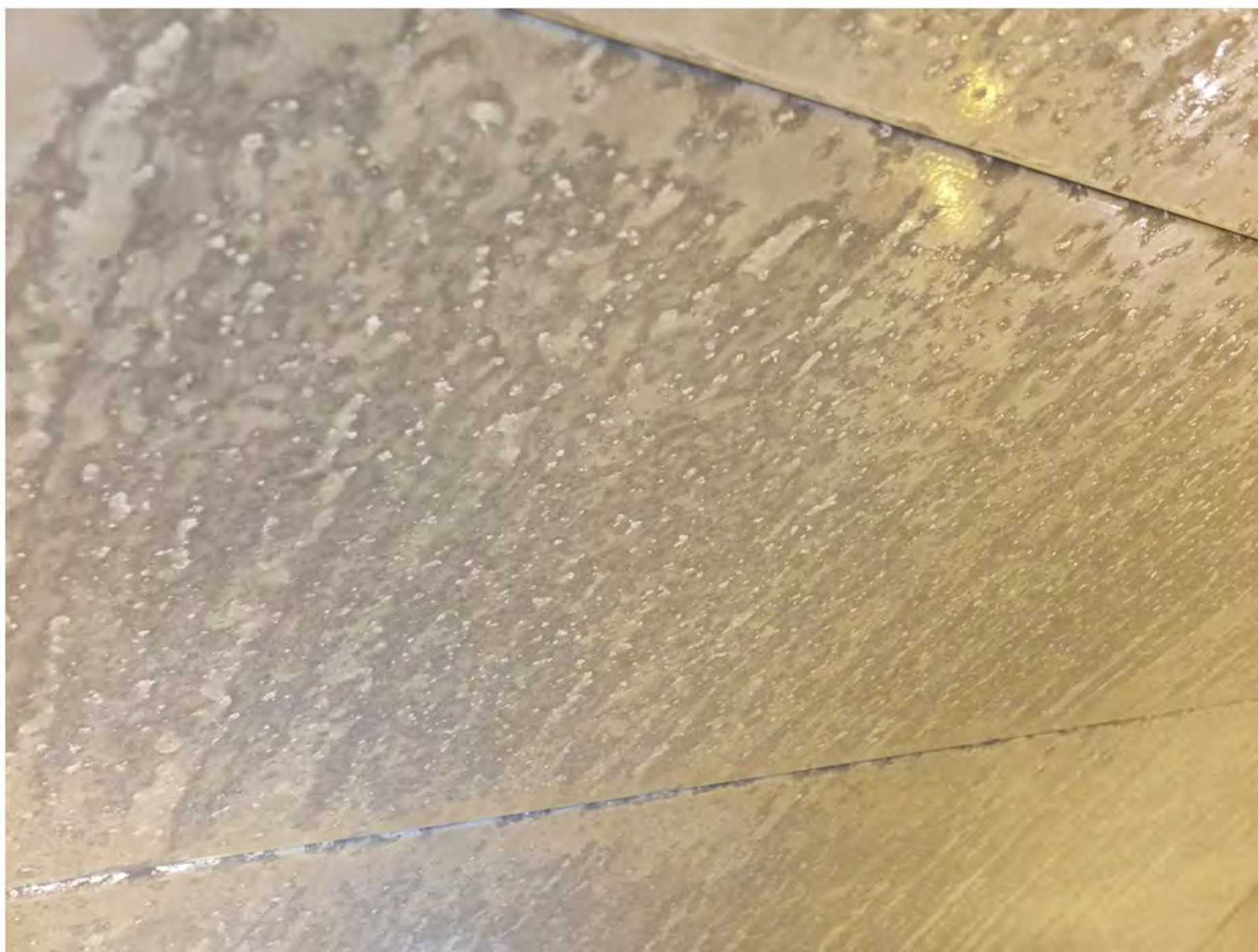
12 Platefelt før rengjøring og inspeksjon
