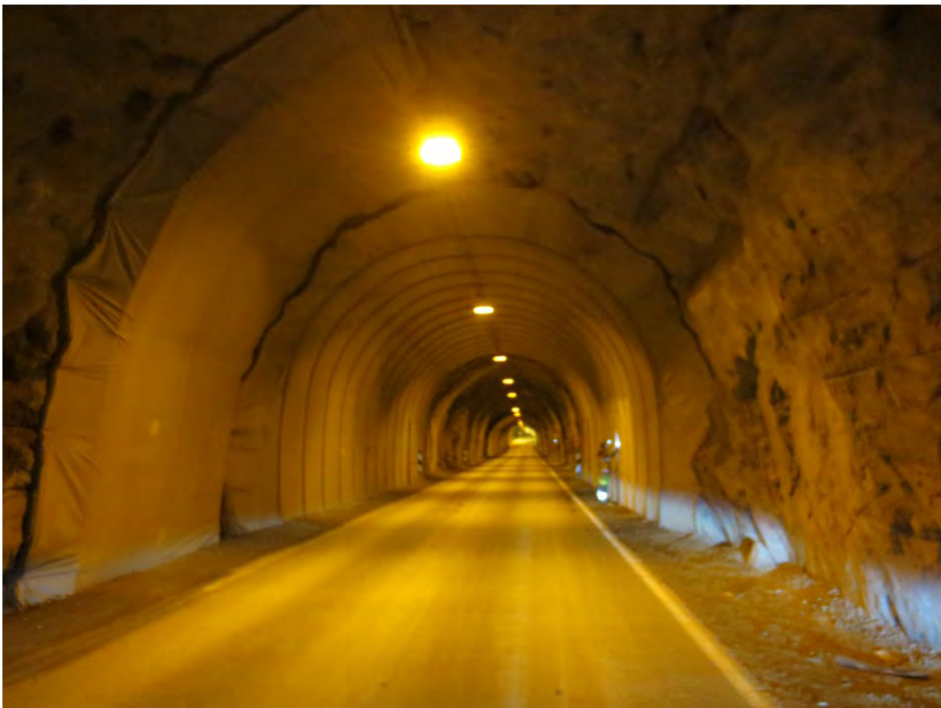
12 Profil 250 før søndre portal - Oversikt
