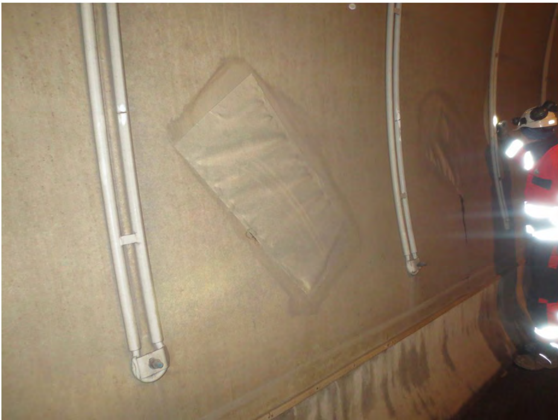
8 Mange reparasjonspunkter pga hærverk
