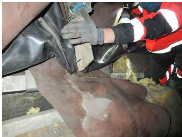
Foto 2.12.20. Detalj avslutning av T-profil og ekstra membranstripe i forlengelse av profilet
