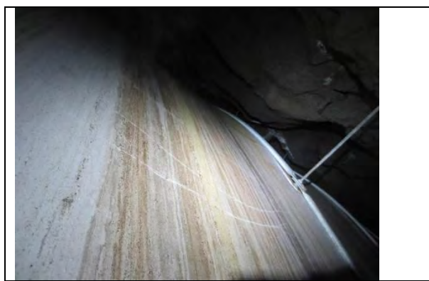
Foto 2.8.13. Oversikt tunnelduk type 554 på bergsiden
