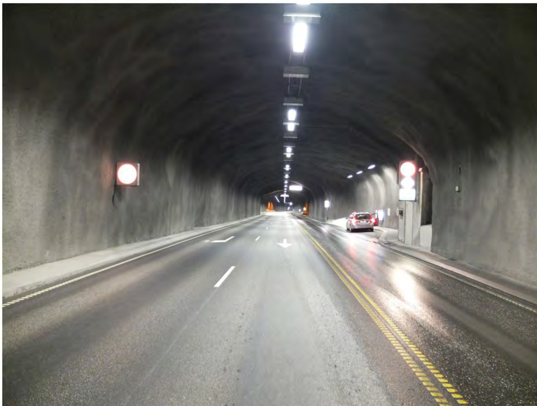
1 Oversikt - Innkjøring fra Ålesundsiden
