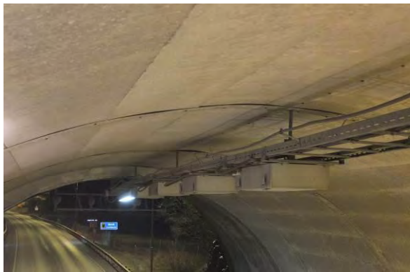
Foto 2.12.11. Festebolter for kabelbru ved hver kassettskjøt
