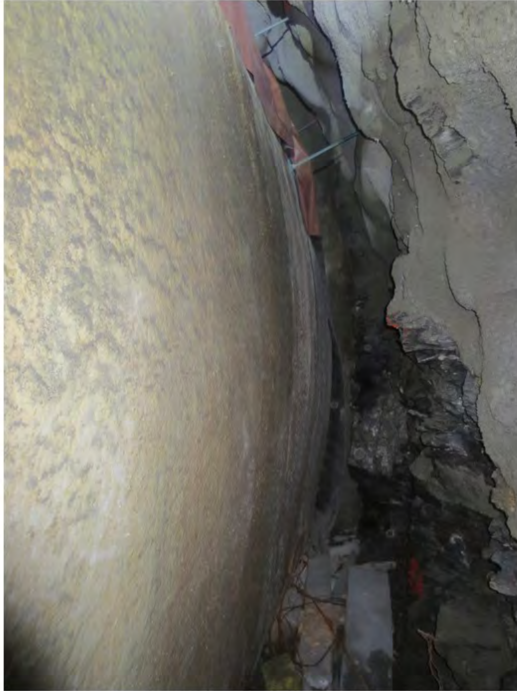
39 Baksiden av veggelement
