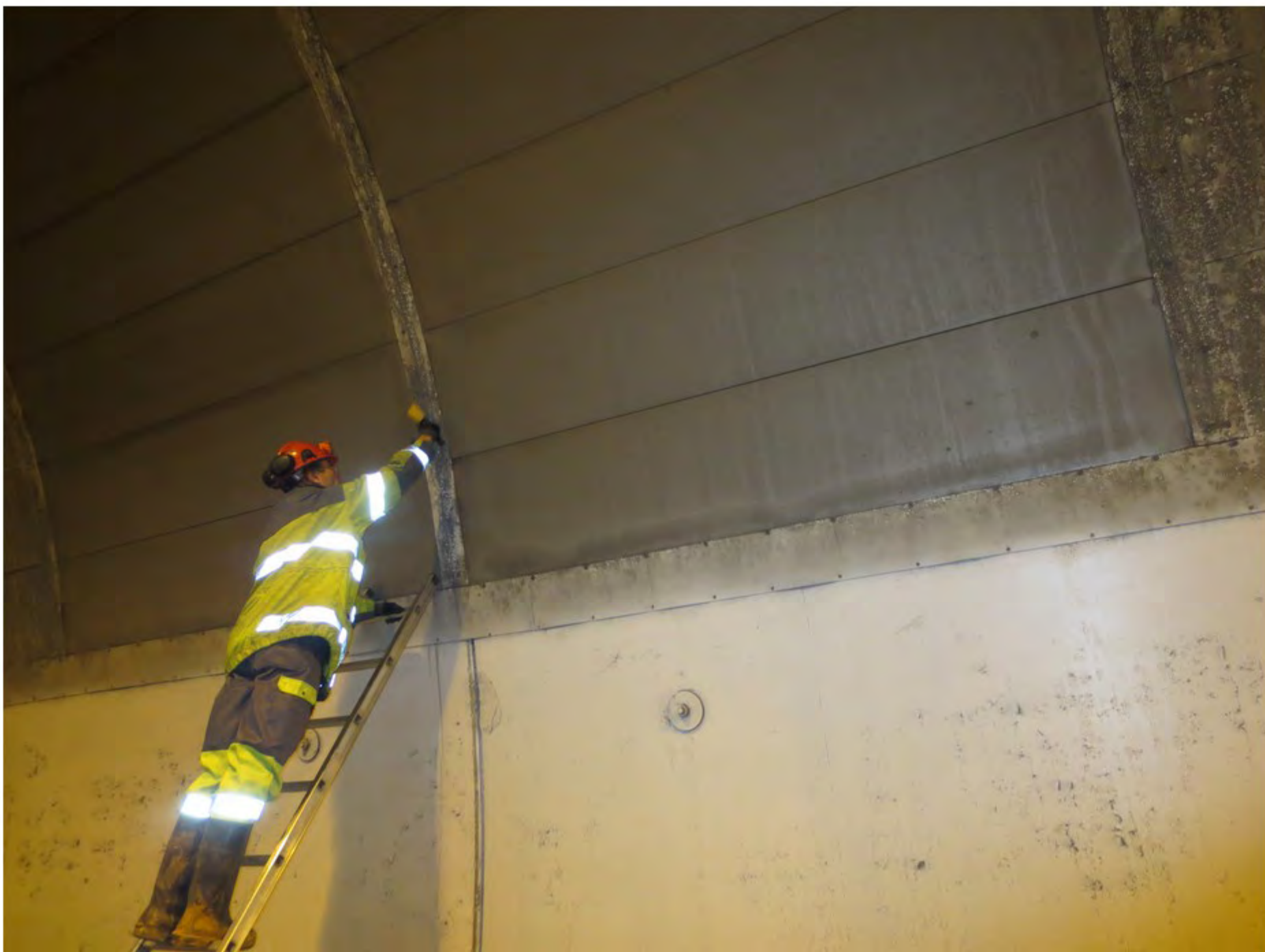
20 Felt med syrefaste platekassetter
