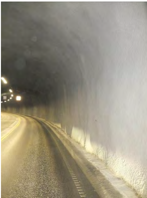
Foto 2.10.5. Oversiktsbilde sprøytebetongflate
