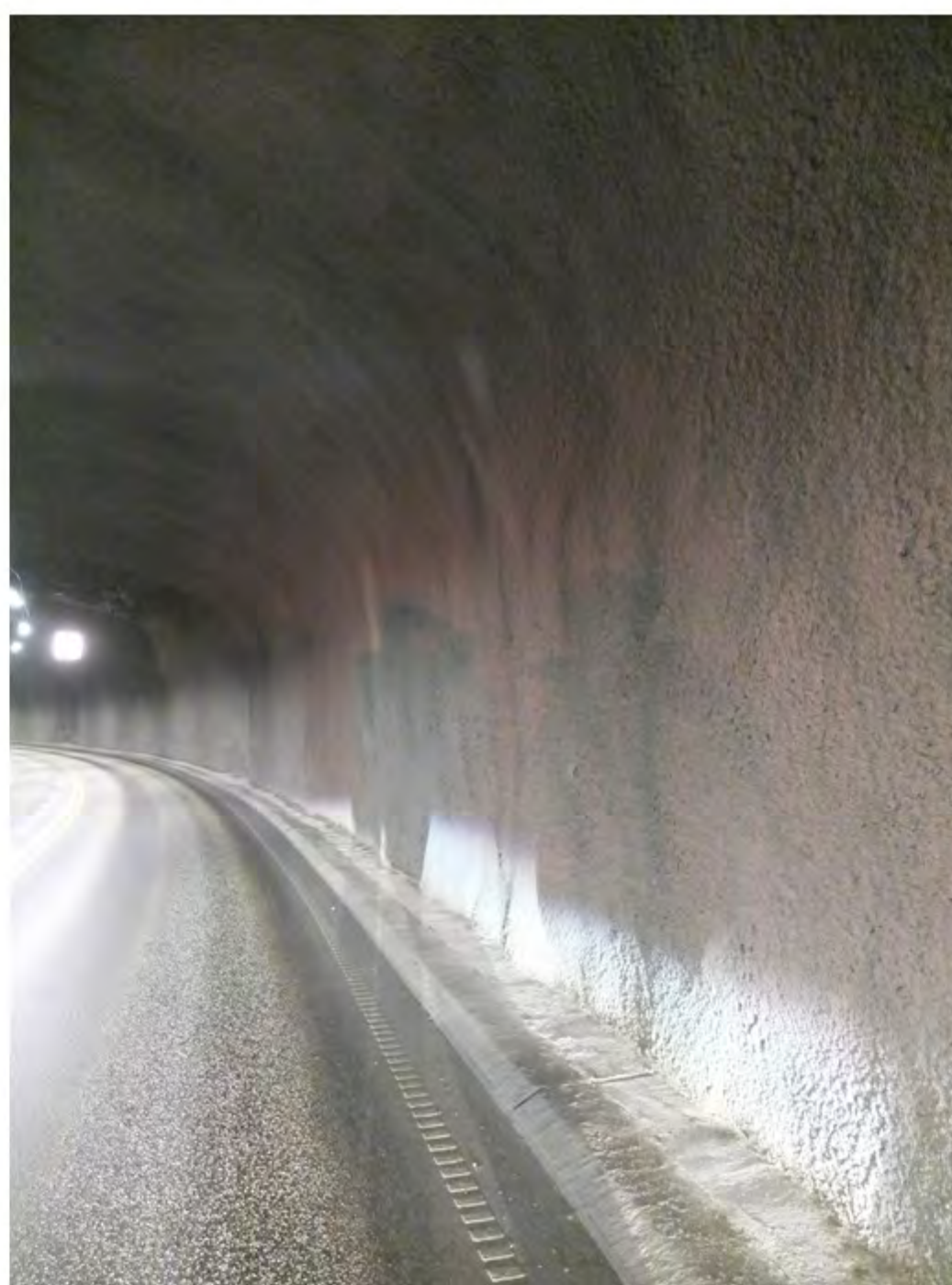
2 Sprøytebetong høyre side
