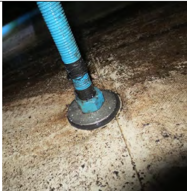
Foto 2.5.18. Festebolt for kabelstige, pakning, bakskive og mutter
