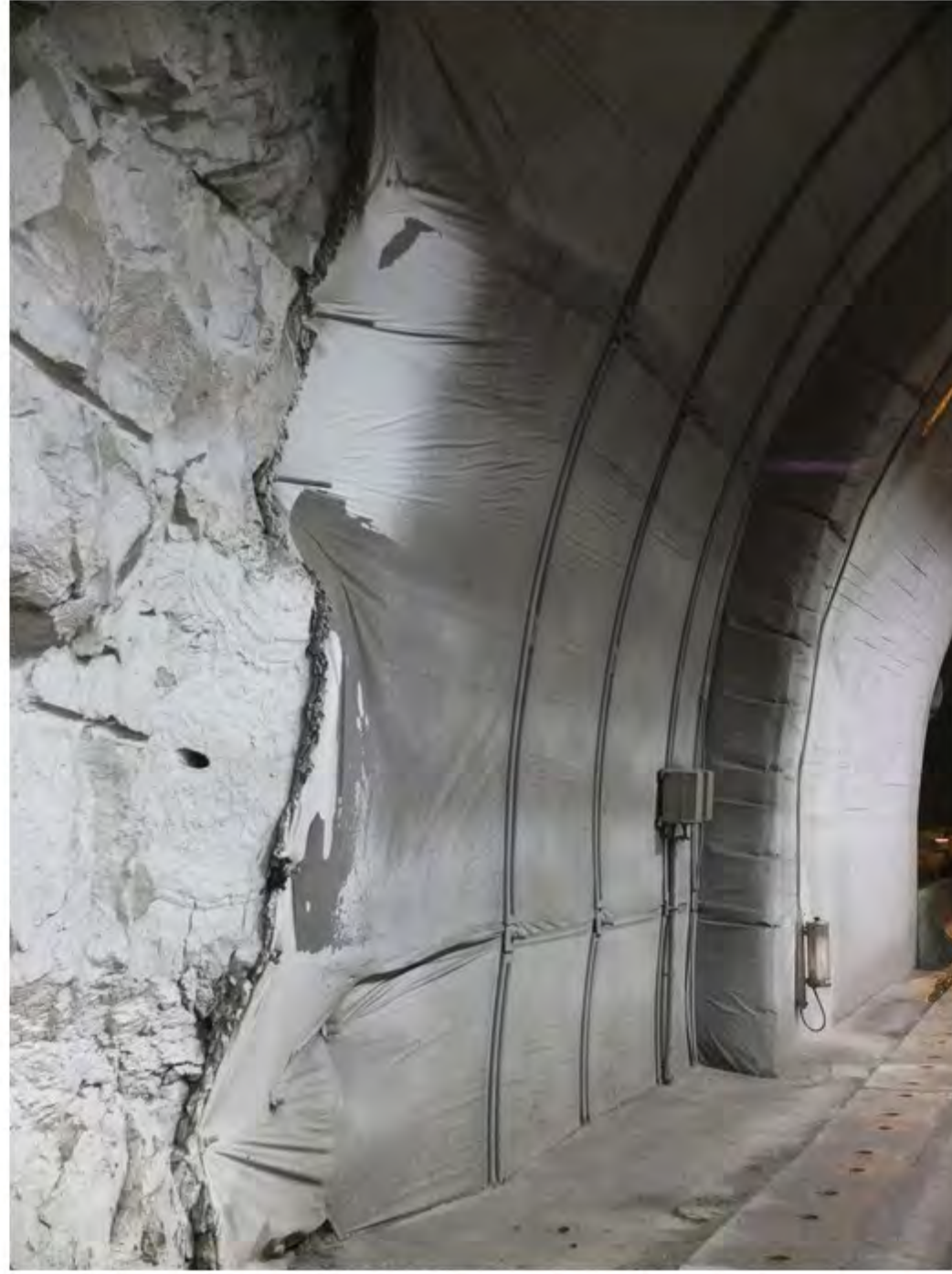
3 Tunnelkledning innenfor nordre portal
