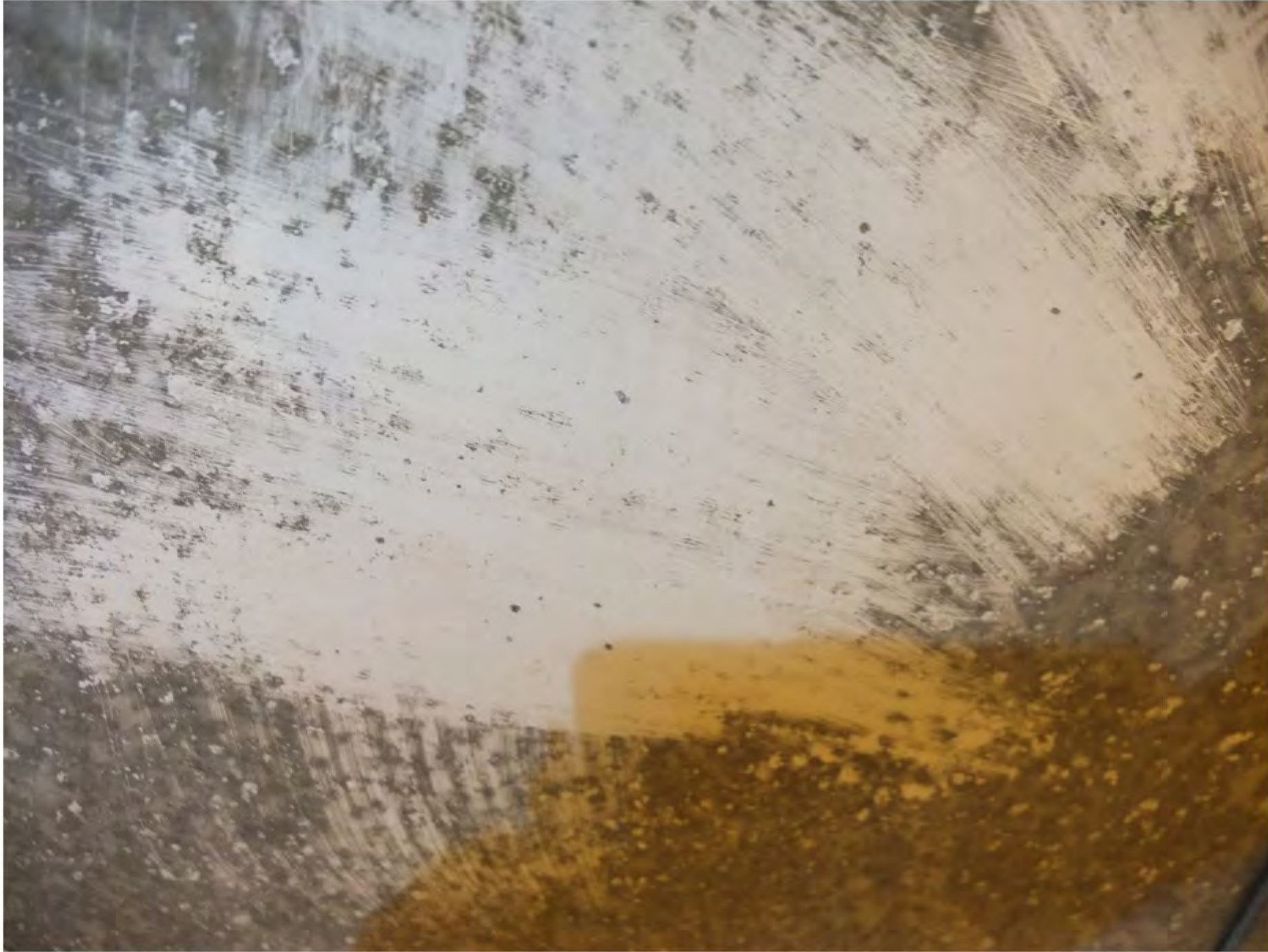
13 Rengjort prøvelfelt viser blæring og avflassing av lakk
