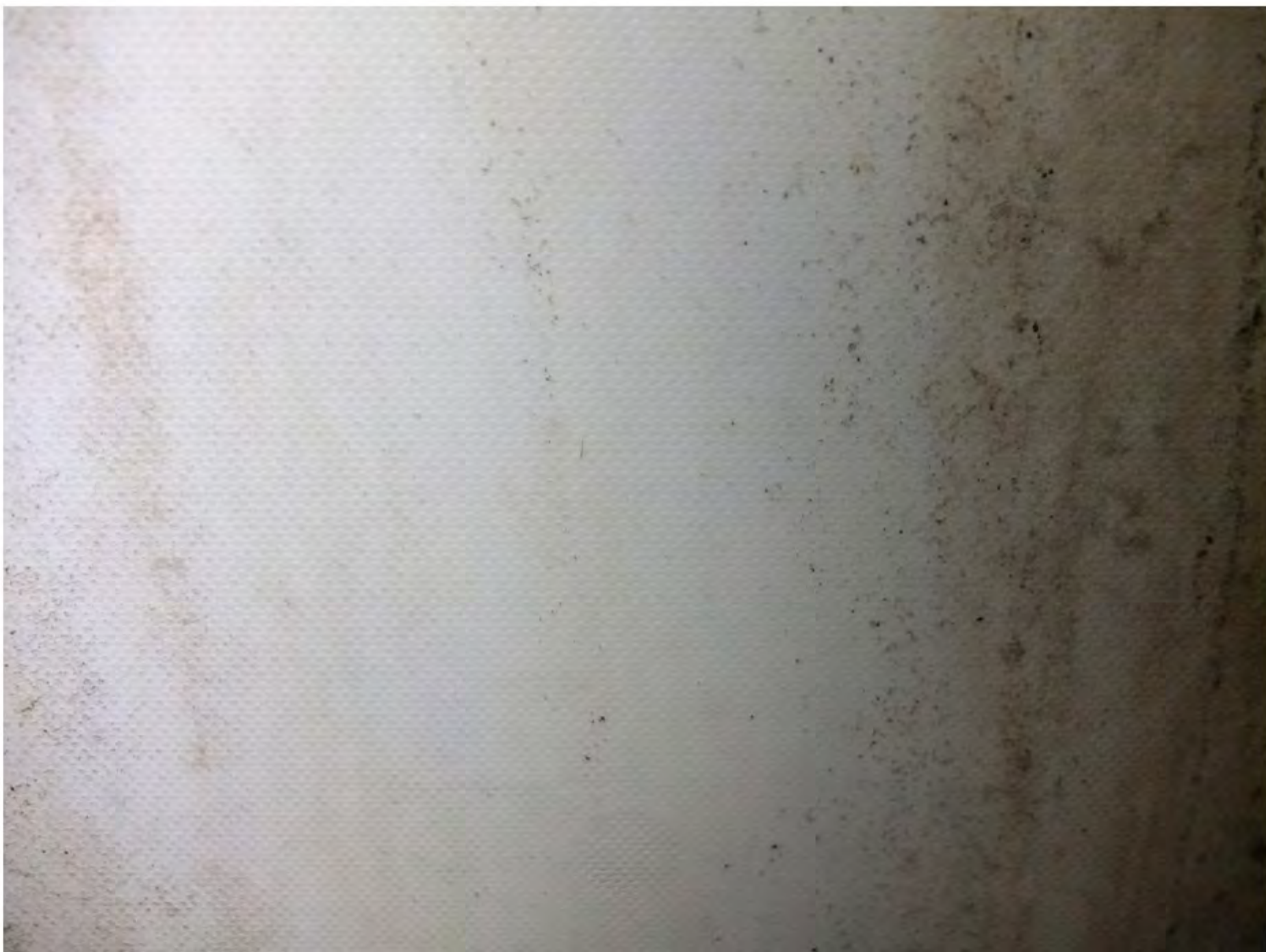
38 Tunnelduk 556 på Bergsiden
