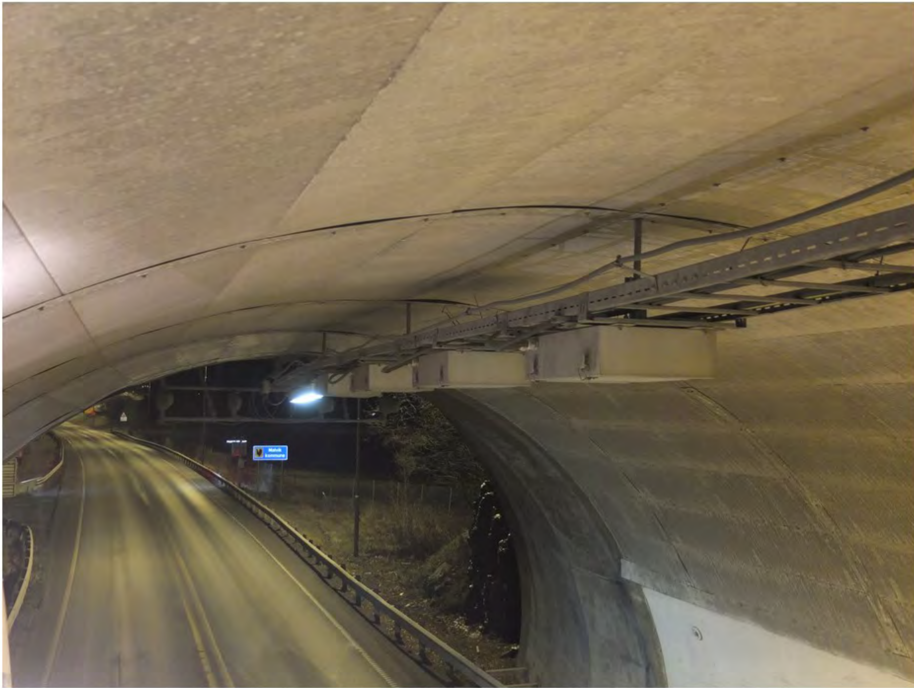
41 Festebolter for kabelbru ved hver kassettskjøt
