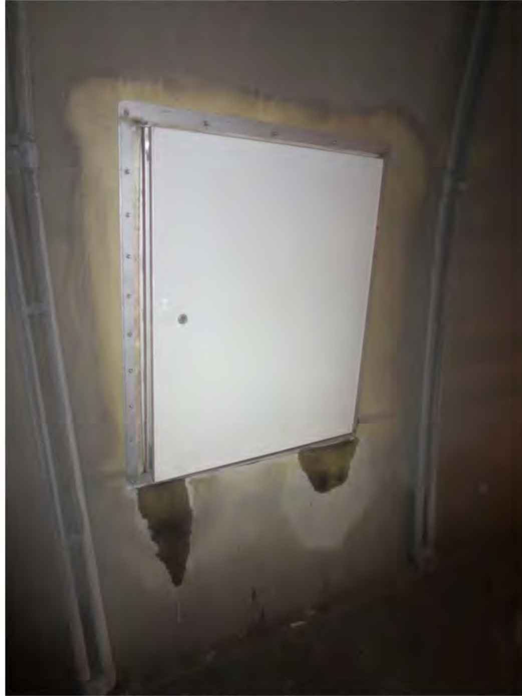
45 Inspeksjonsluke i seksjon mot vest
