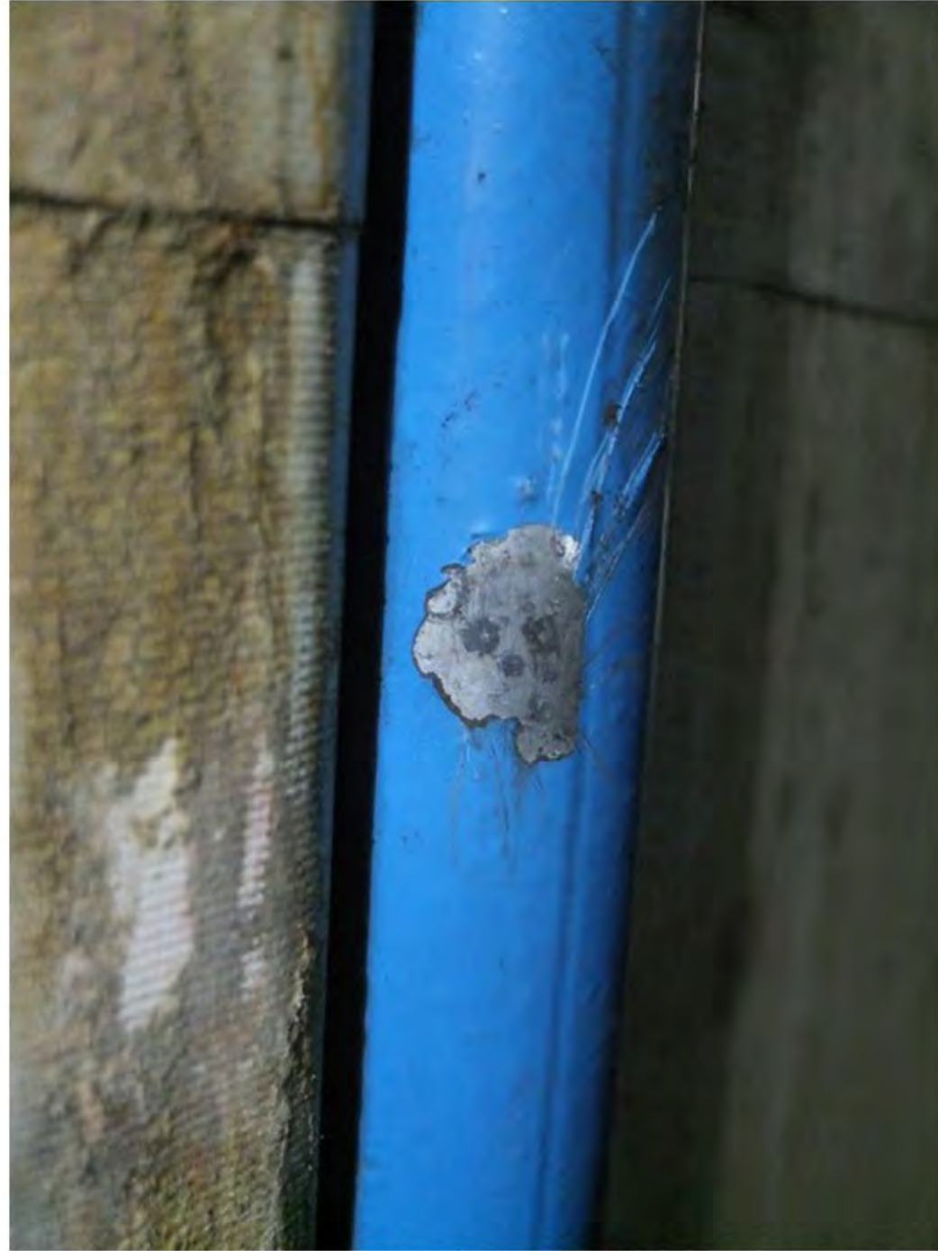
37 Blæring i Combicoat fjernet - Lett tæring i sink
