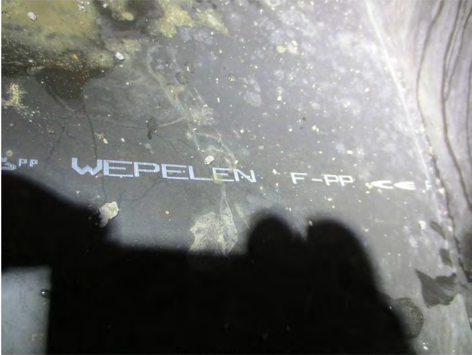
7 PP-duk bak betongelement
