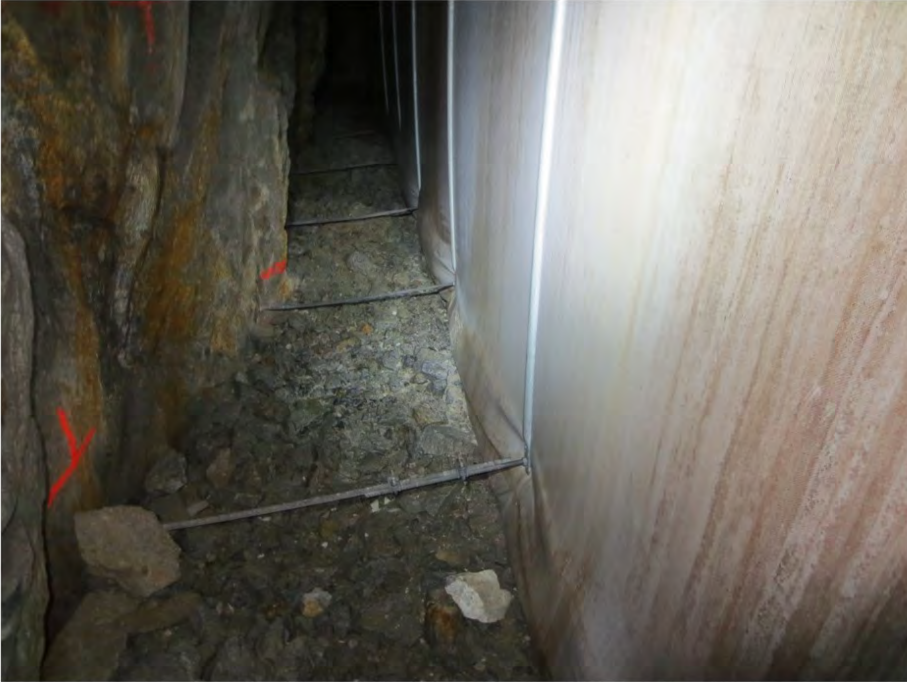
23 Profil 100 - Stram duk på bergside pga oppfylling av skulder
