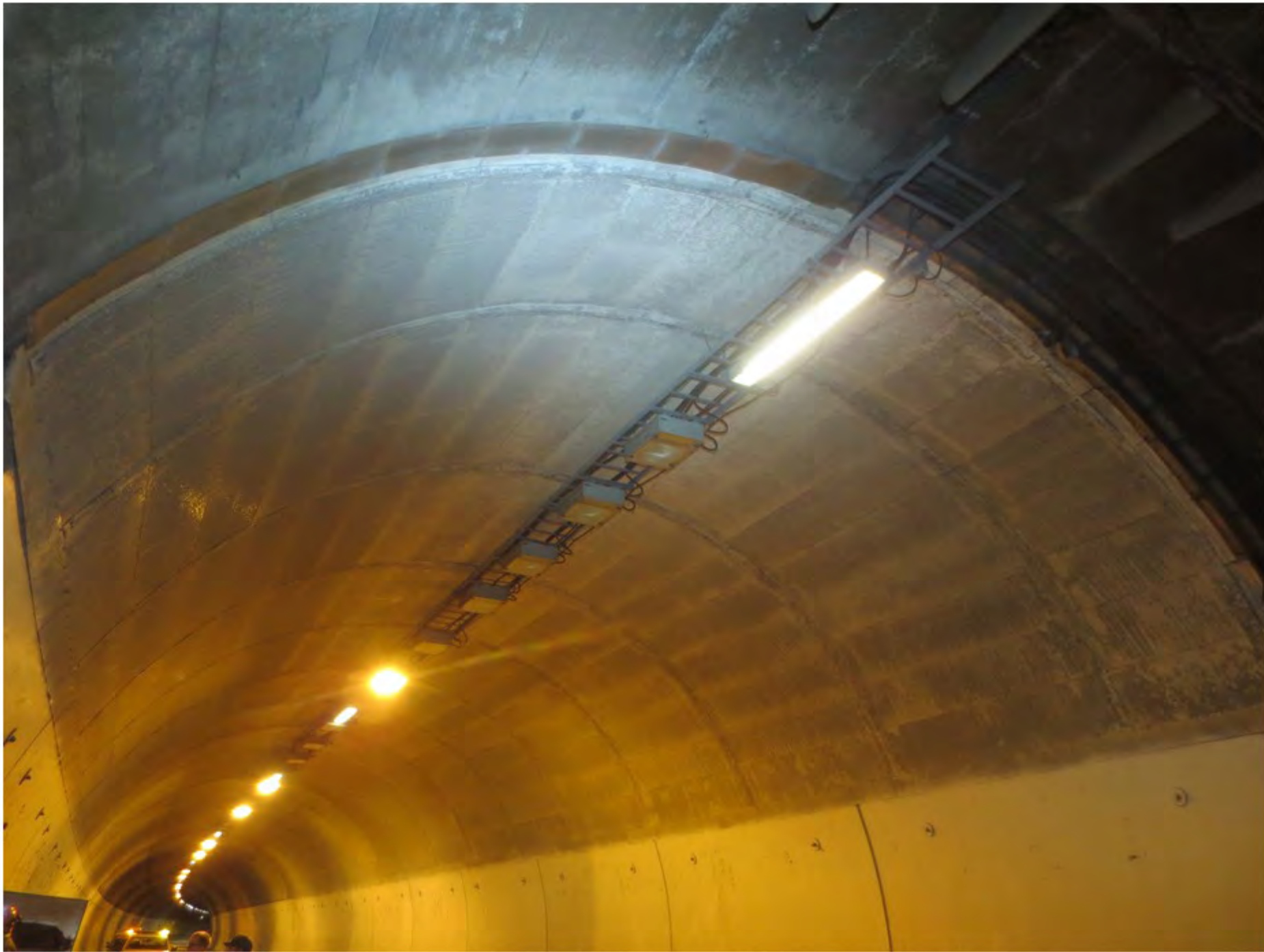
3 Oversikt felt med platekassetter
