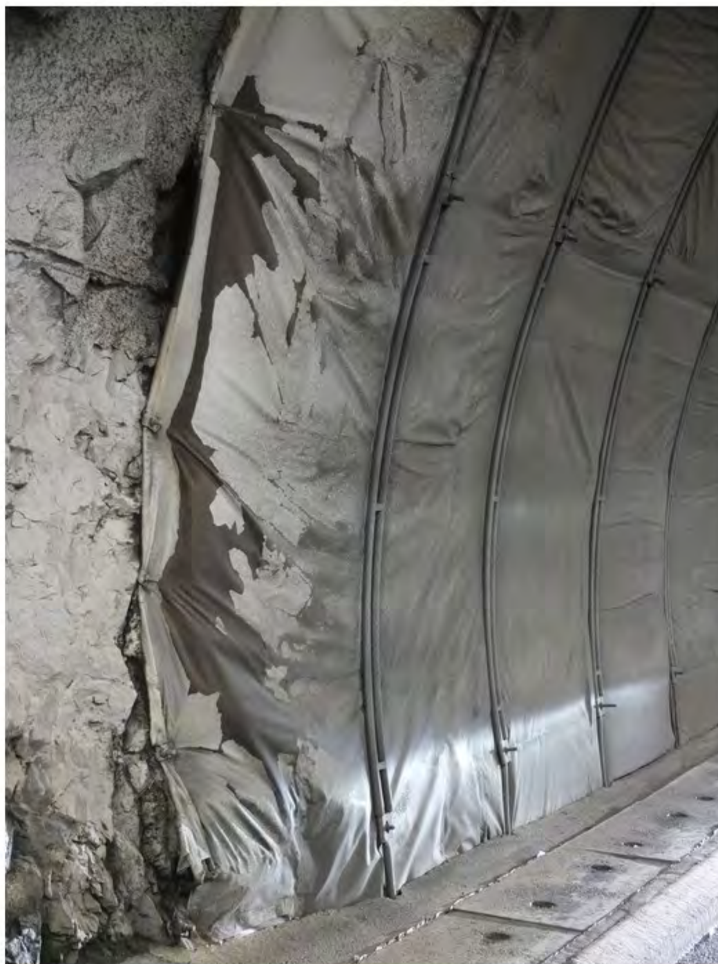
8 Overgang mot berg - Duk er påsprøytet kalkbelegg
