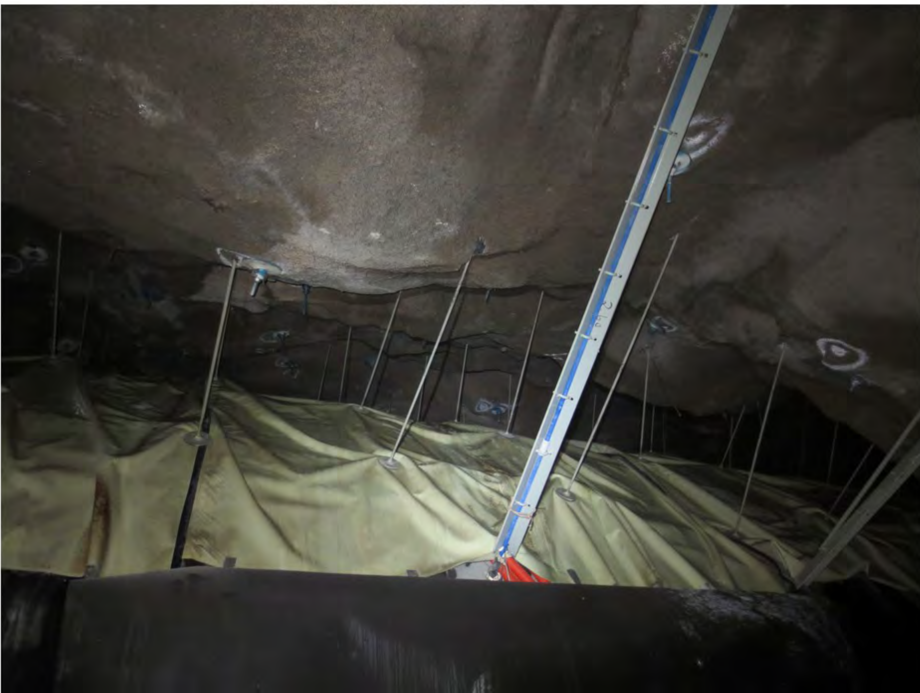
6 Overgang betongelementer og sprøytebetonghvelv
