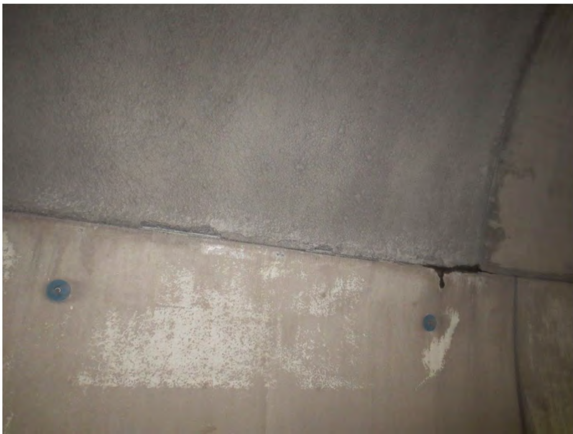
2 Overgang sprøytebetong - betongelement
