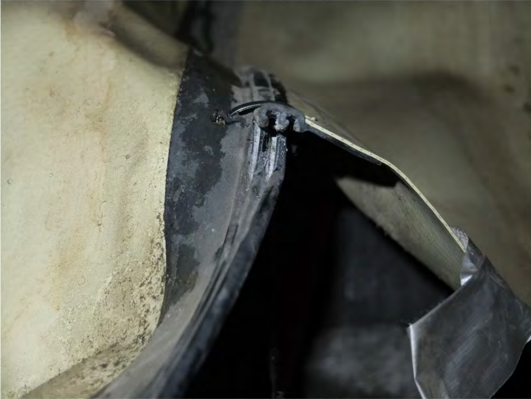
15 Wapromembran med Zip-Lock skjøt
