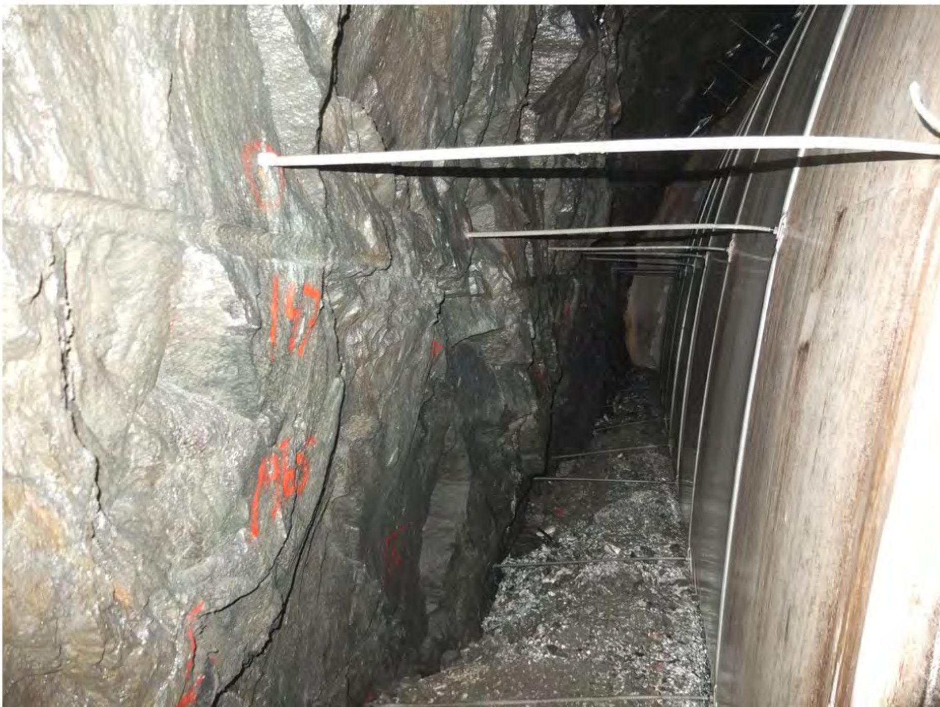
10 Bak hvelv - Seksjon med 554 mot øst
