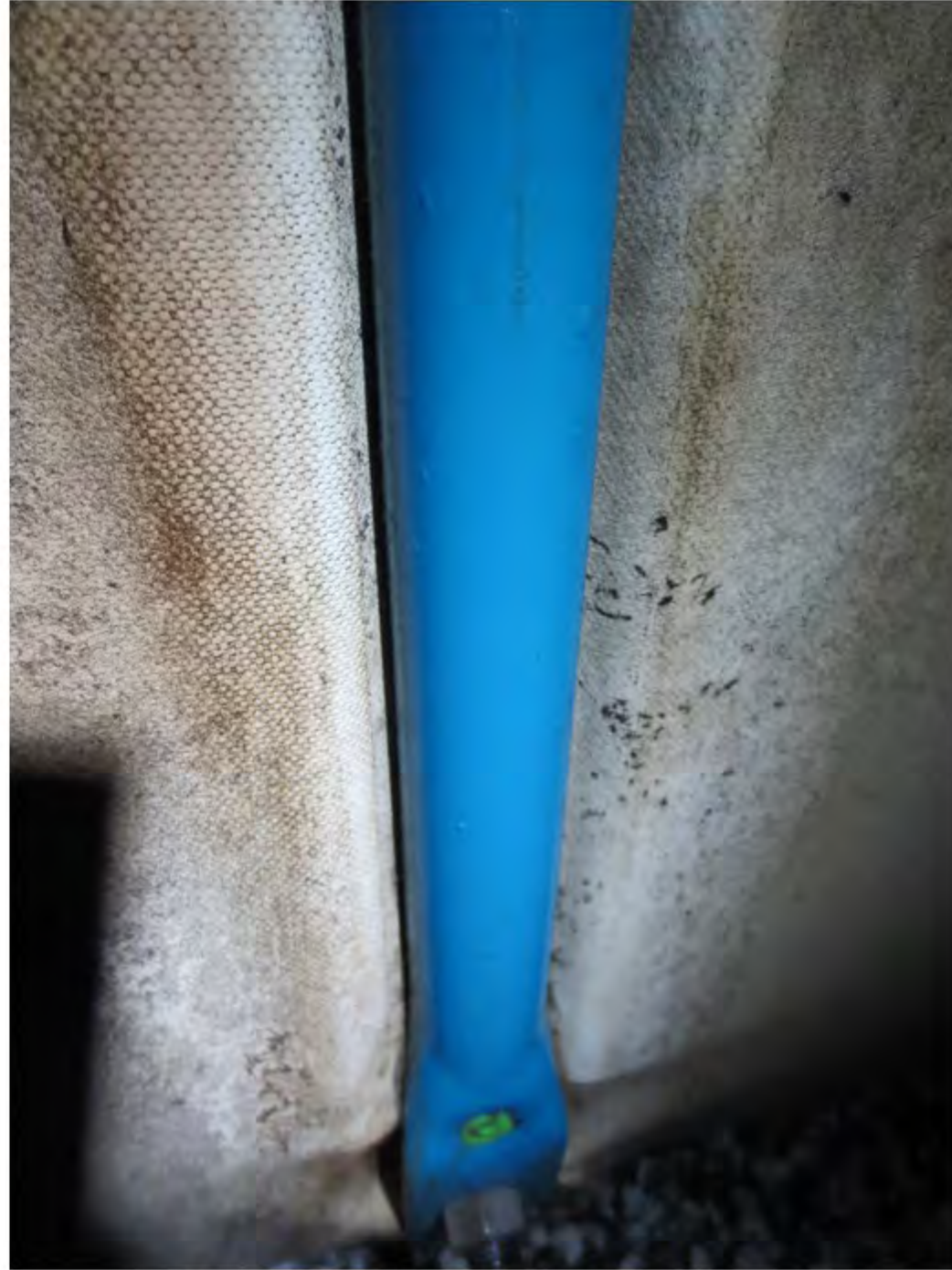
43 Enkelte små blærer i Combicoat på bakrør
