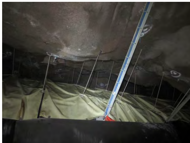
Foto 2.11.4. Overlappende membran med veggelementer. (Blå veggbolt)
