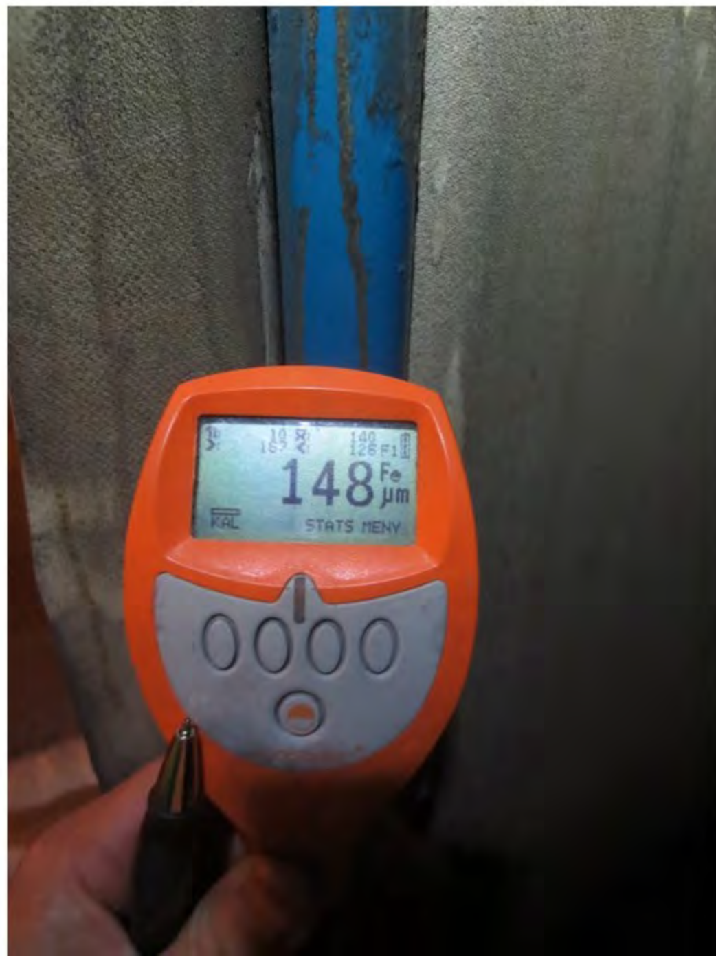
38 Tykkelsesmåling Combicoat på bakrør- 1,5 km fra portal Frøyasiden
