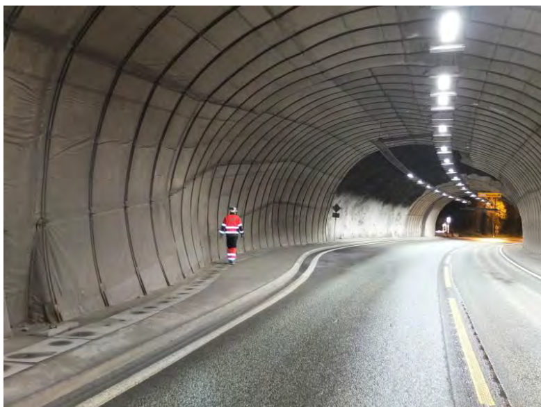
Foto 2.7.1. Oversikt tunnelkledning nær sydøstre portal
