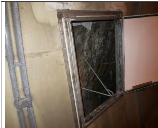
Foto 2.3.5. Ettermontert syrefast luke. Velfungerende i forhold til glidelåstype
