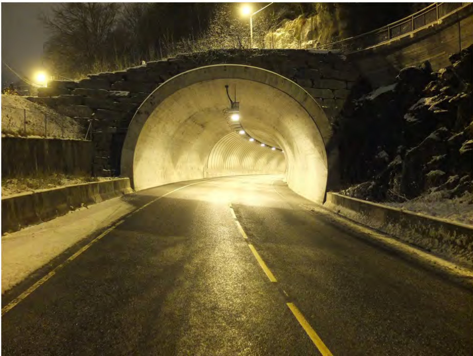
2 Portal mot syd
