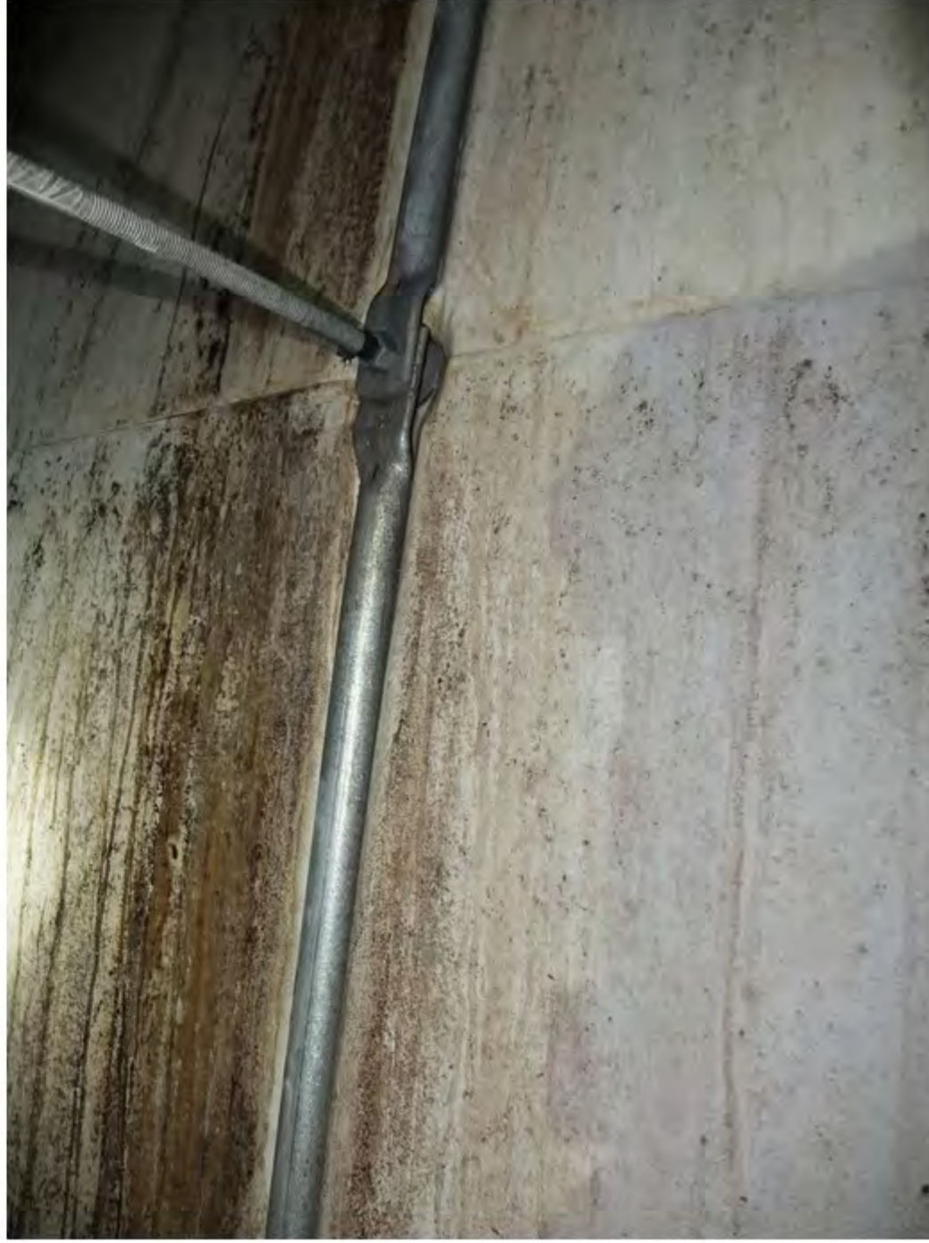
13 Bakrør og festebolt på seksjon mot øst
