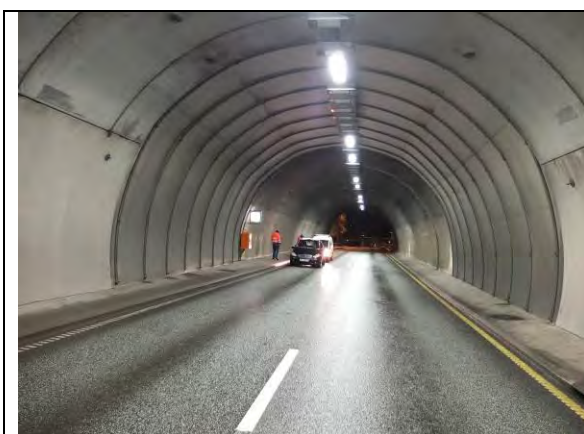
Foto 2.5.1. Prøvefelt med WG tunnelhvelv T100 i sydgående løp
