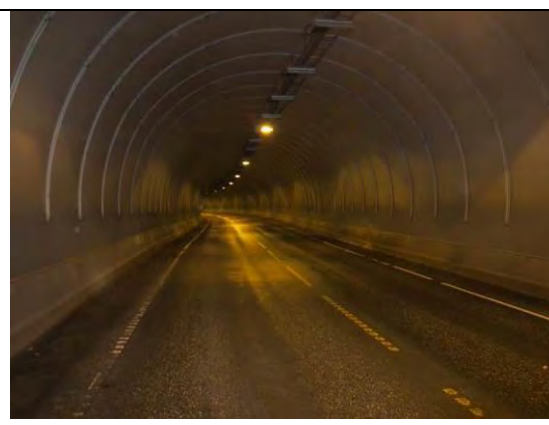
Foto 2.6.2 Oversikt Sædalstunnelen. Duk type 556.
