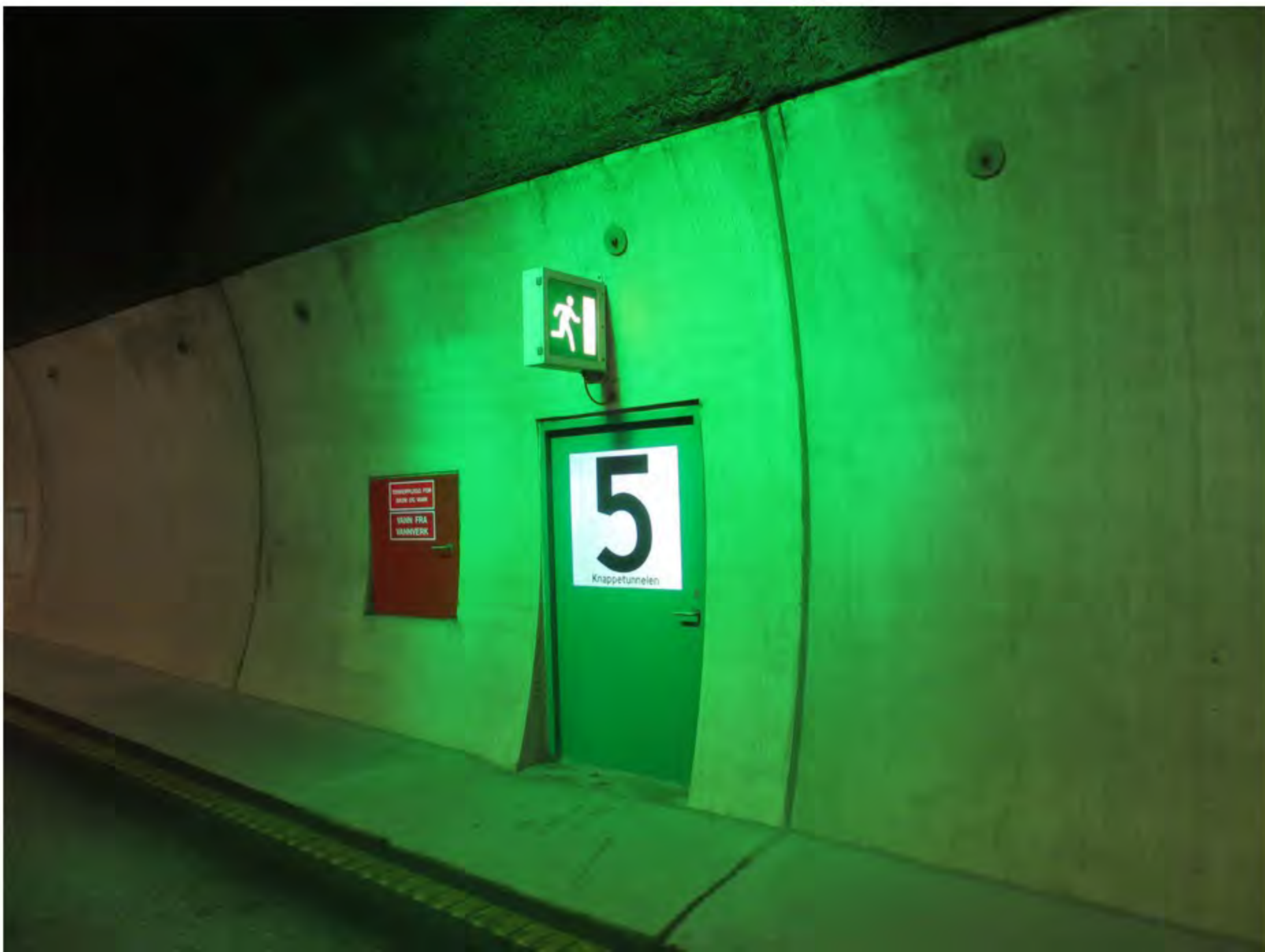
24 Rømningsvei 5 nordgående løp
