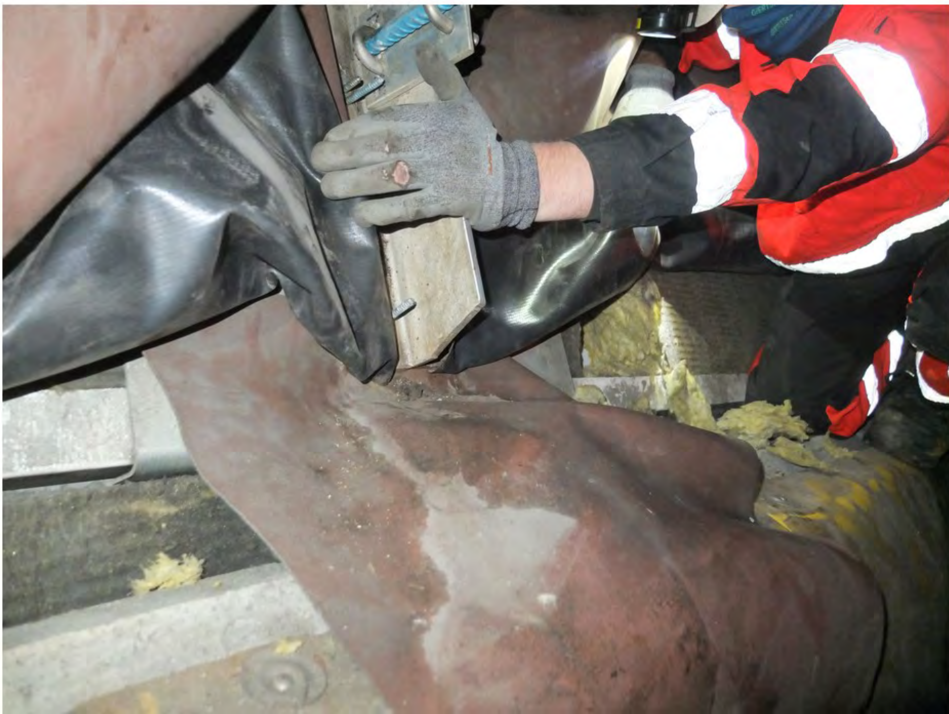
34 Detalj avslutning T-profil og ekstra membranstripe i forlengelsen av profilet
