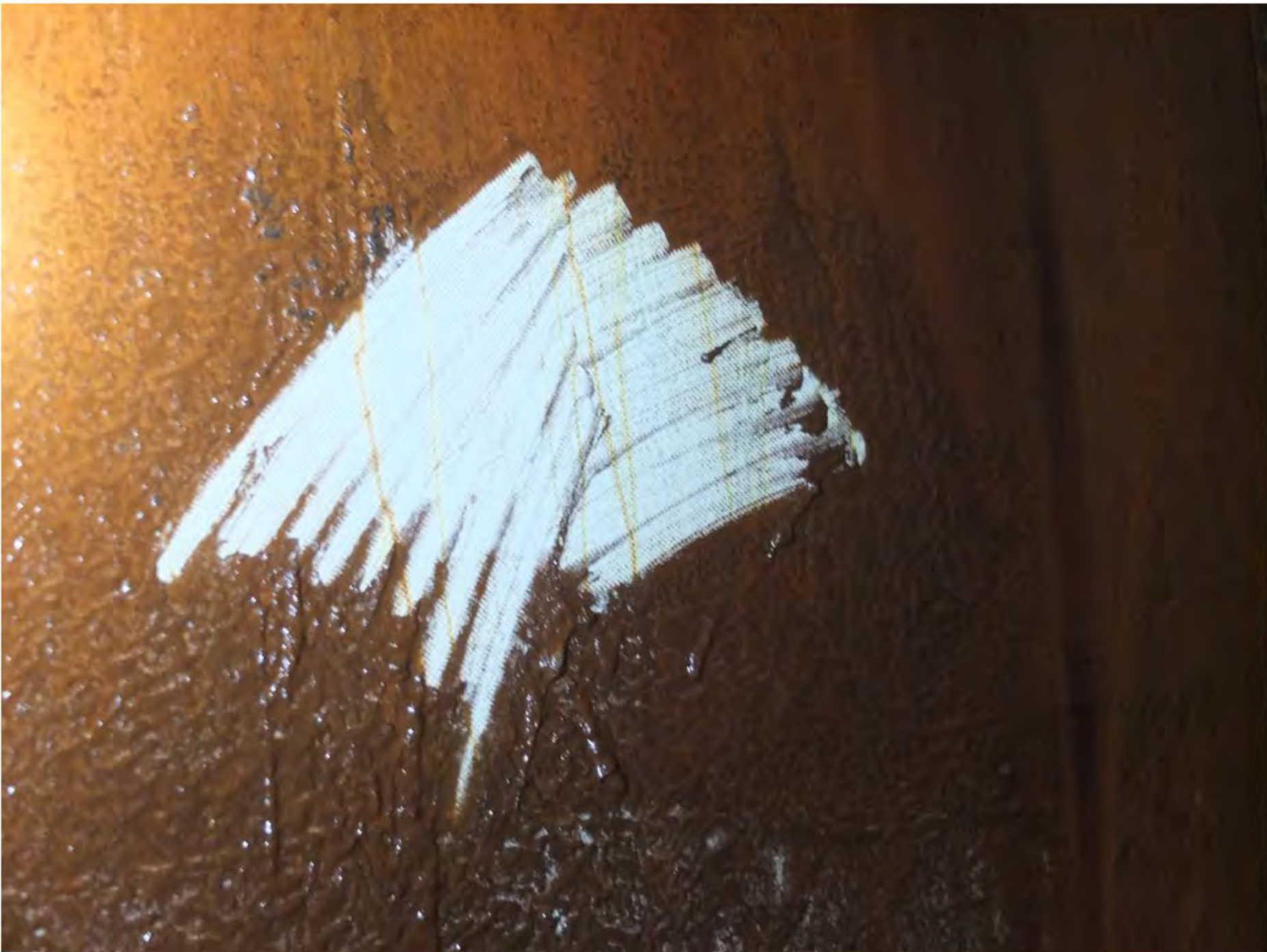
18 Ingen skader i duk etter at avleiringer er fjernet
