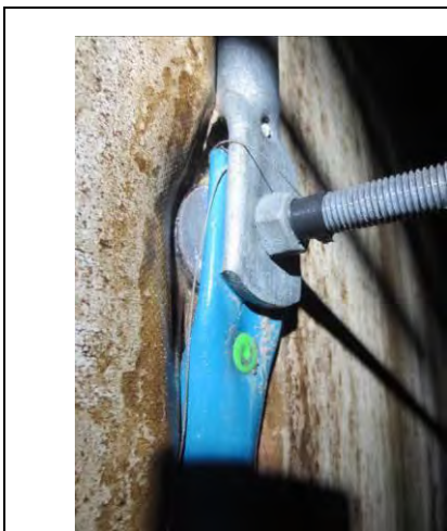
Foto 2.4.14. Kombinasjon av rørtyper
