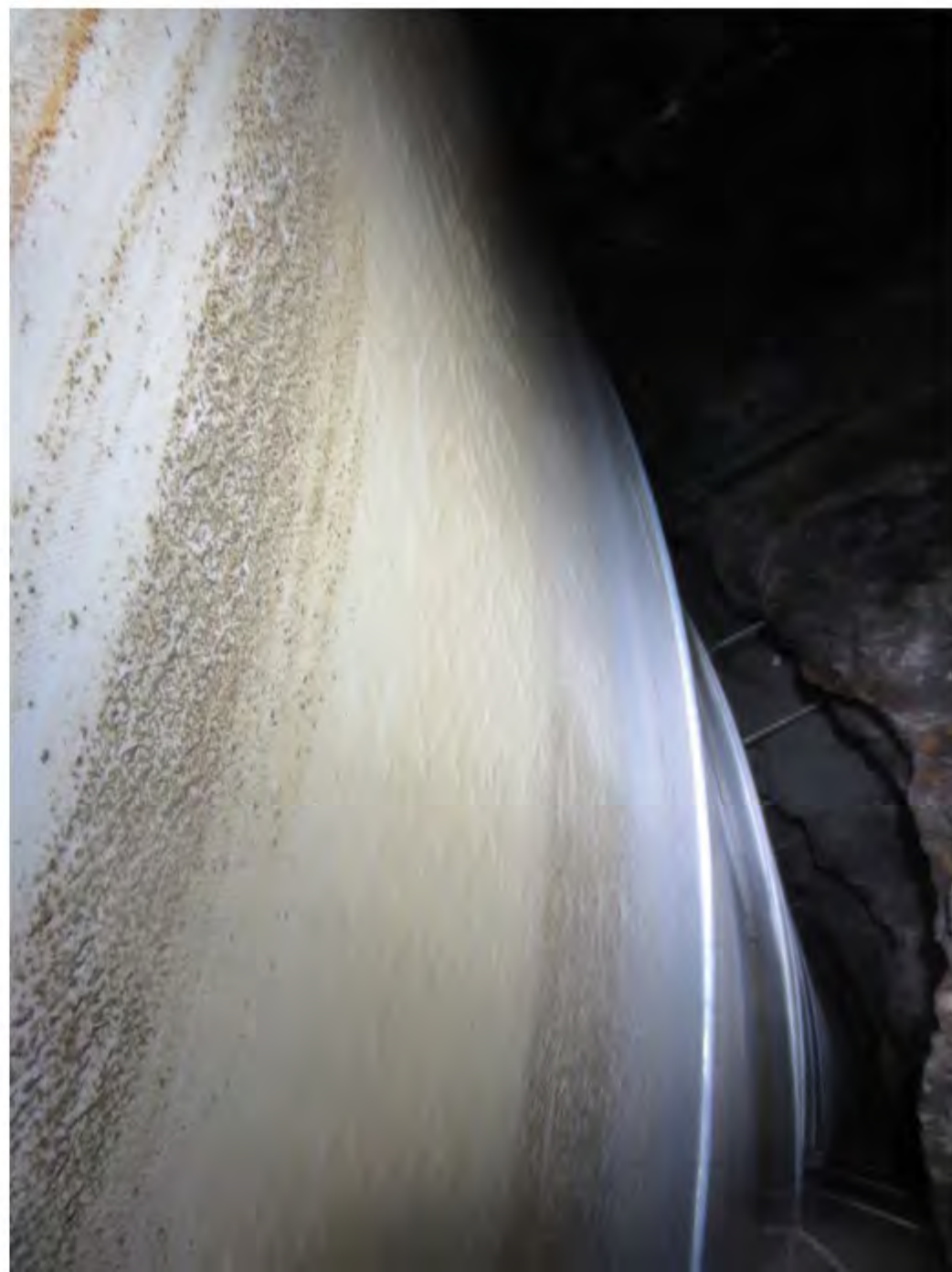
22 Profil 1100 - Avrenning av store vannmengder på baksiden av duk
