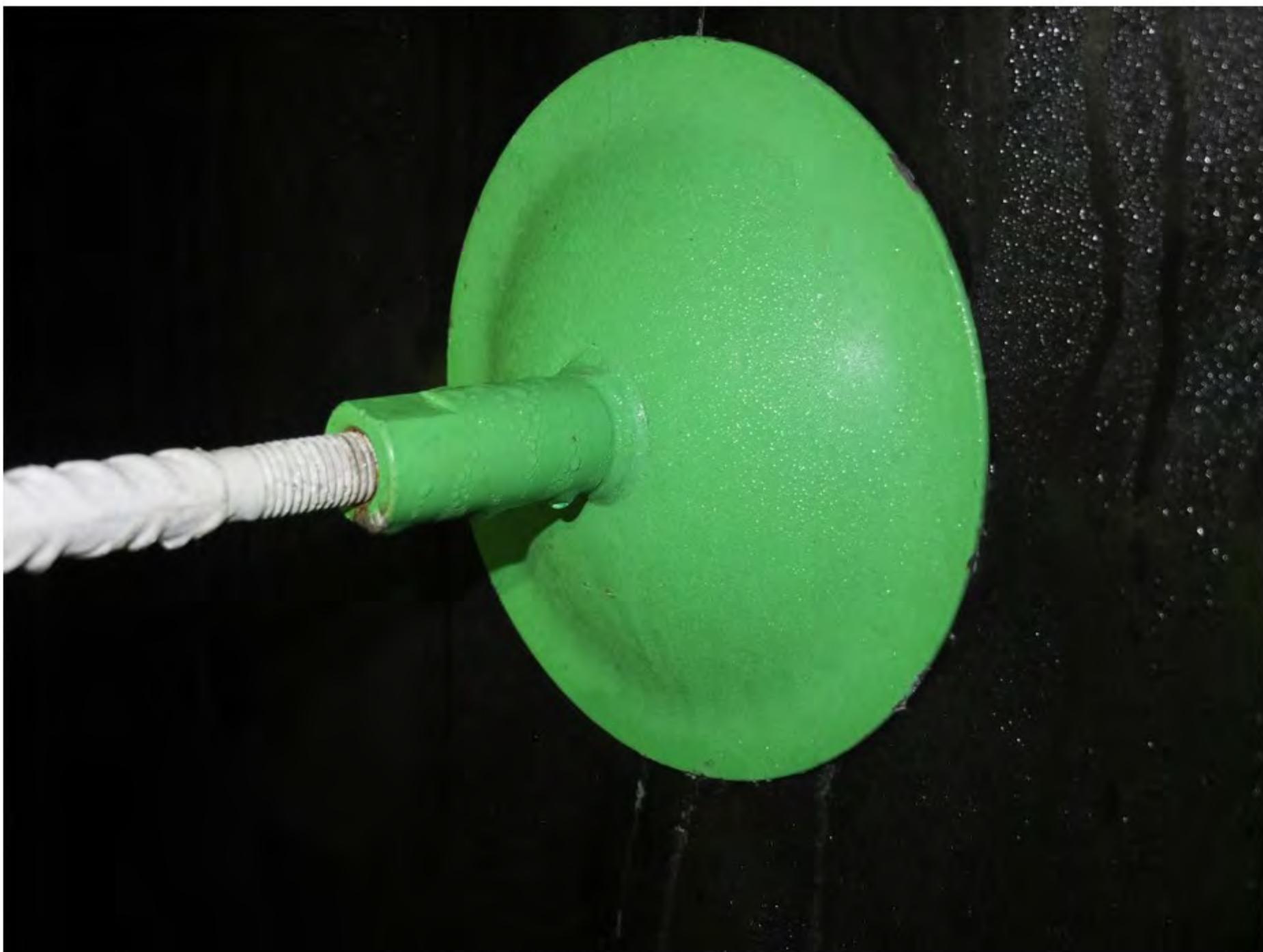
26 Bakskive - Kondensvann - Kantskader på lakk
