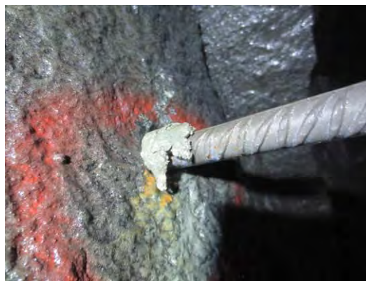
Foto 2.4.19. Innfesting av bolt til berg
