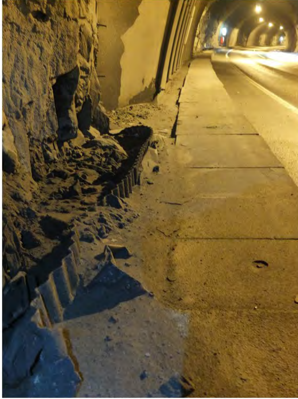
47 Rester etter fjernet lettledning av korrugert aluminium
