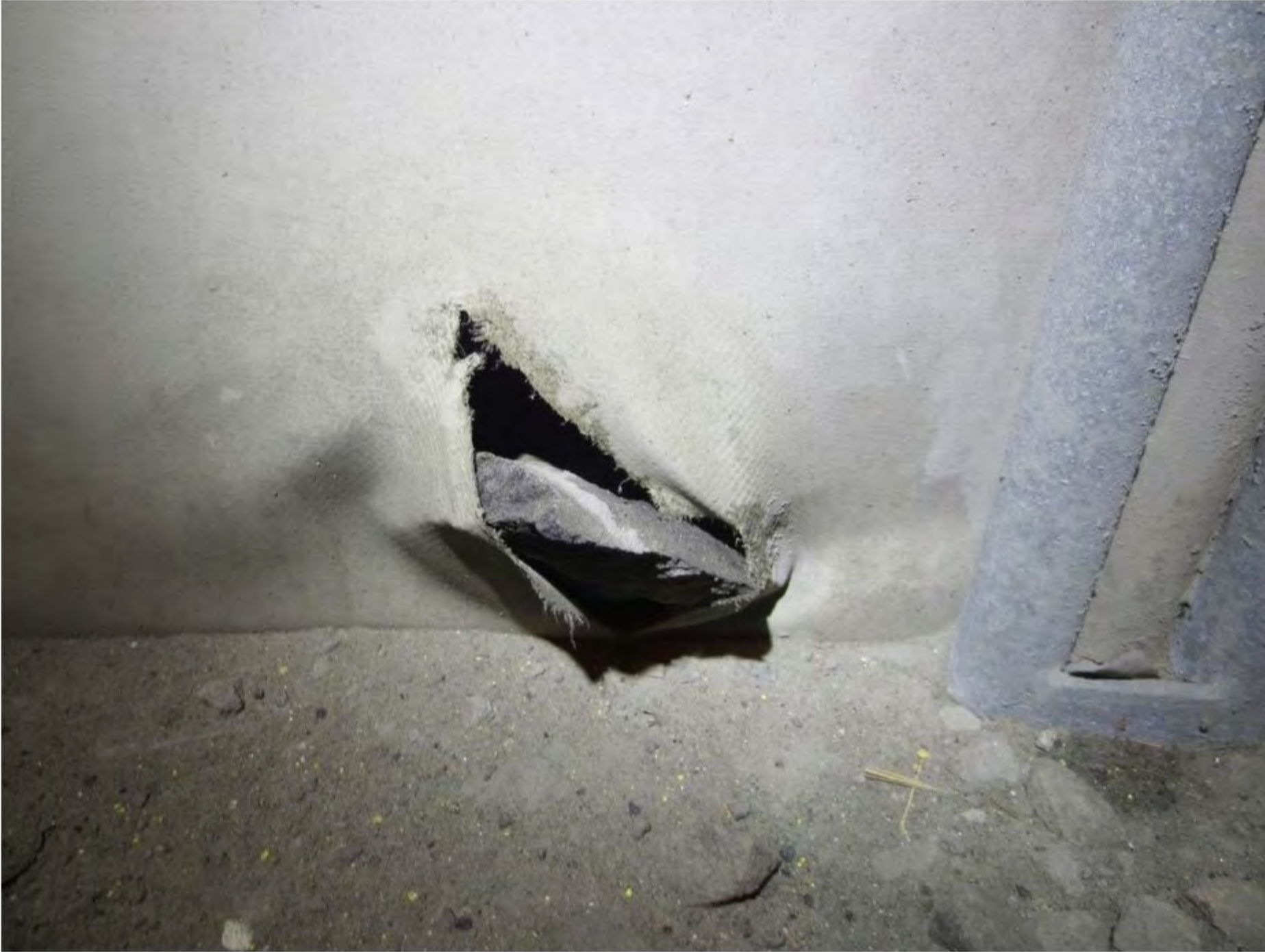
7 Profil 50 - Hull i duk pga bakenforliggende stein
