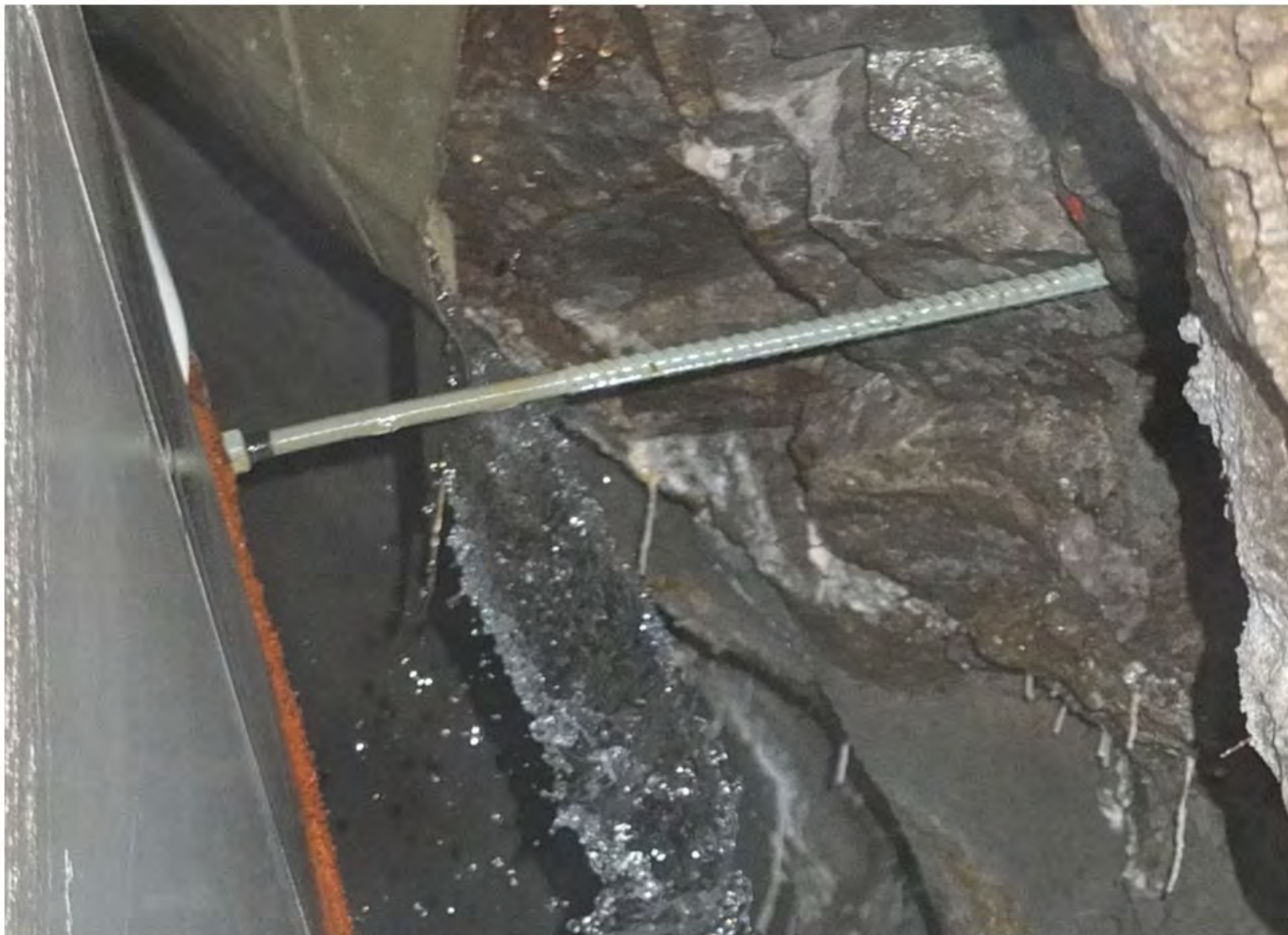
33 Combicoated festebolt i meget aggressivt miljø - Tilstand OK
