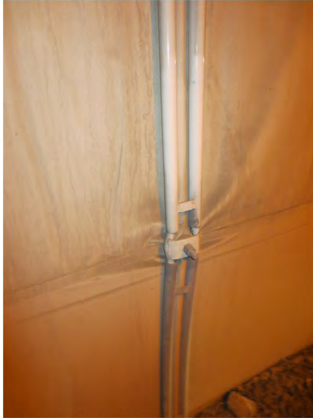
19 Framrør behandlet med Combicoat i reparasjonsfelt
