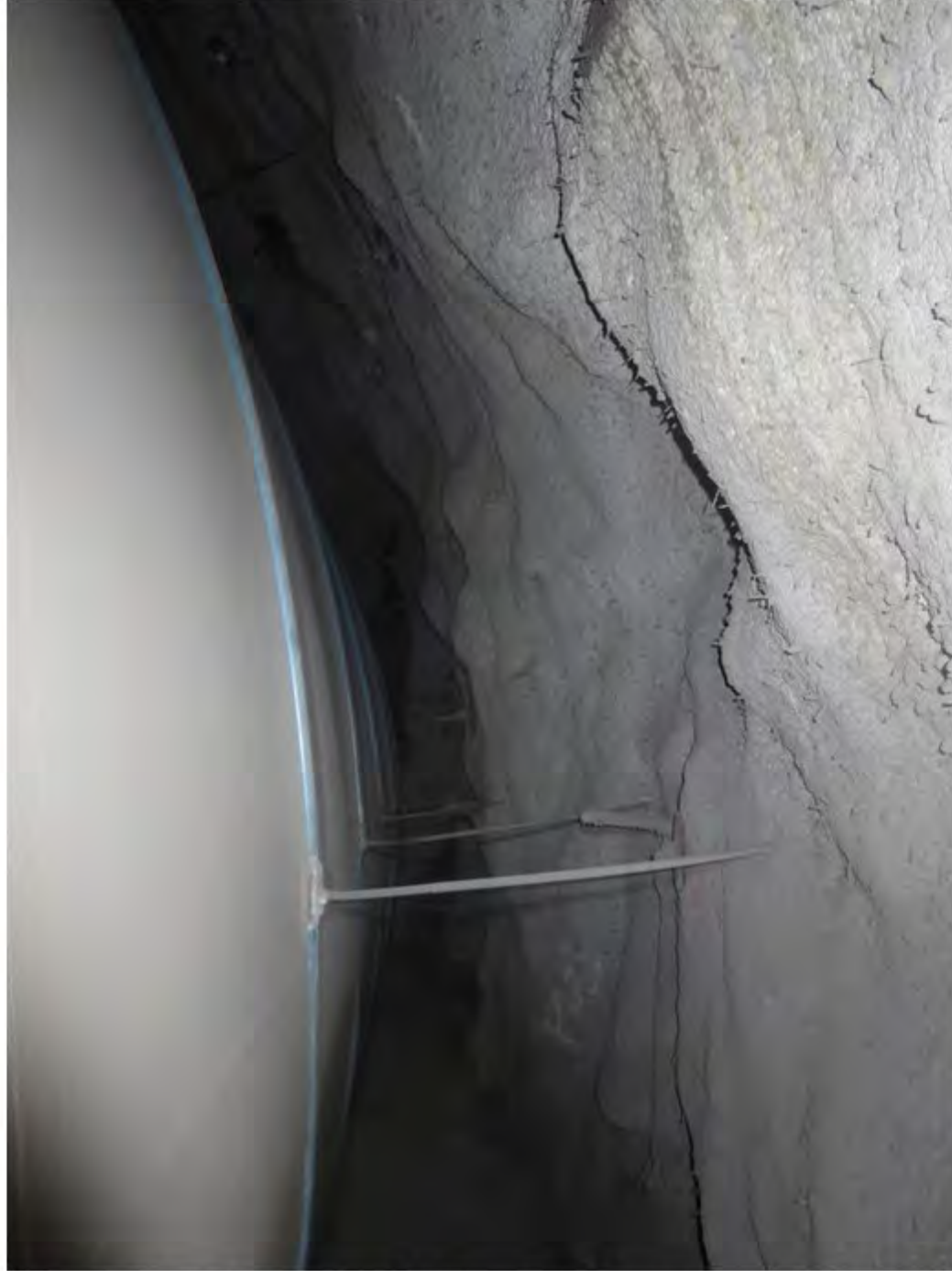
25 Baksiden av hvelv 1,5 km fra portal Frøyasiden - tørt på inspeksjonstidspunktet
