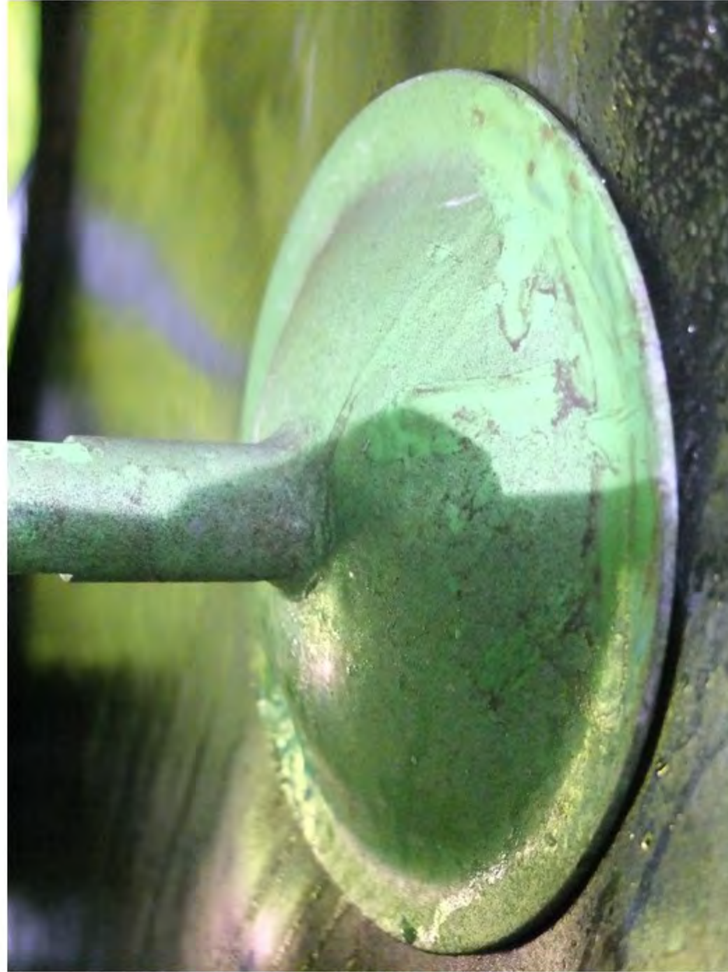
13 Bakskive - Noe blæring og lakkavskalling mot kant
