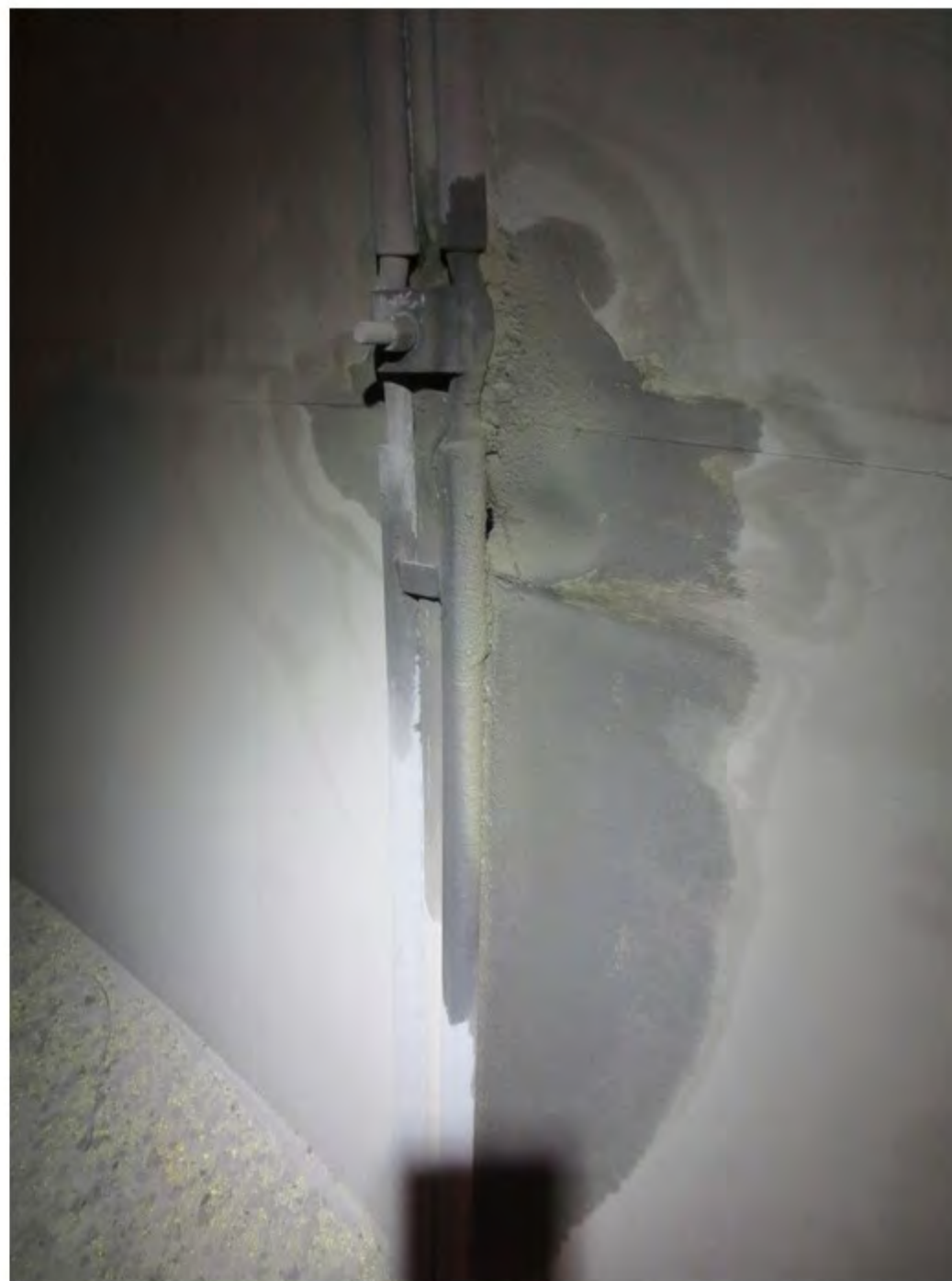
12 Profil 1050 - Hull i duk med tilhørende oppfukning
