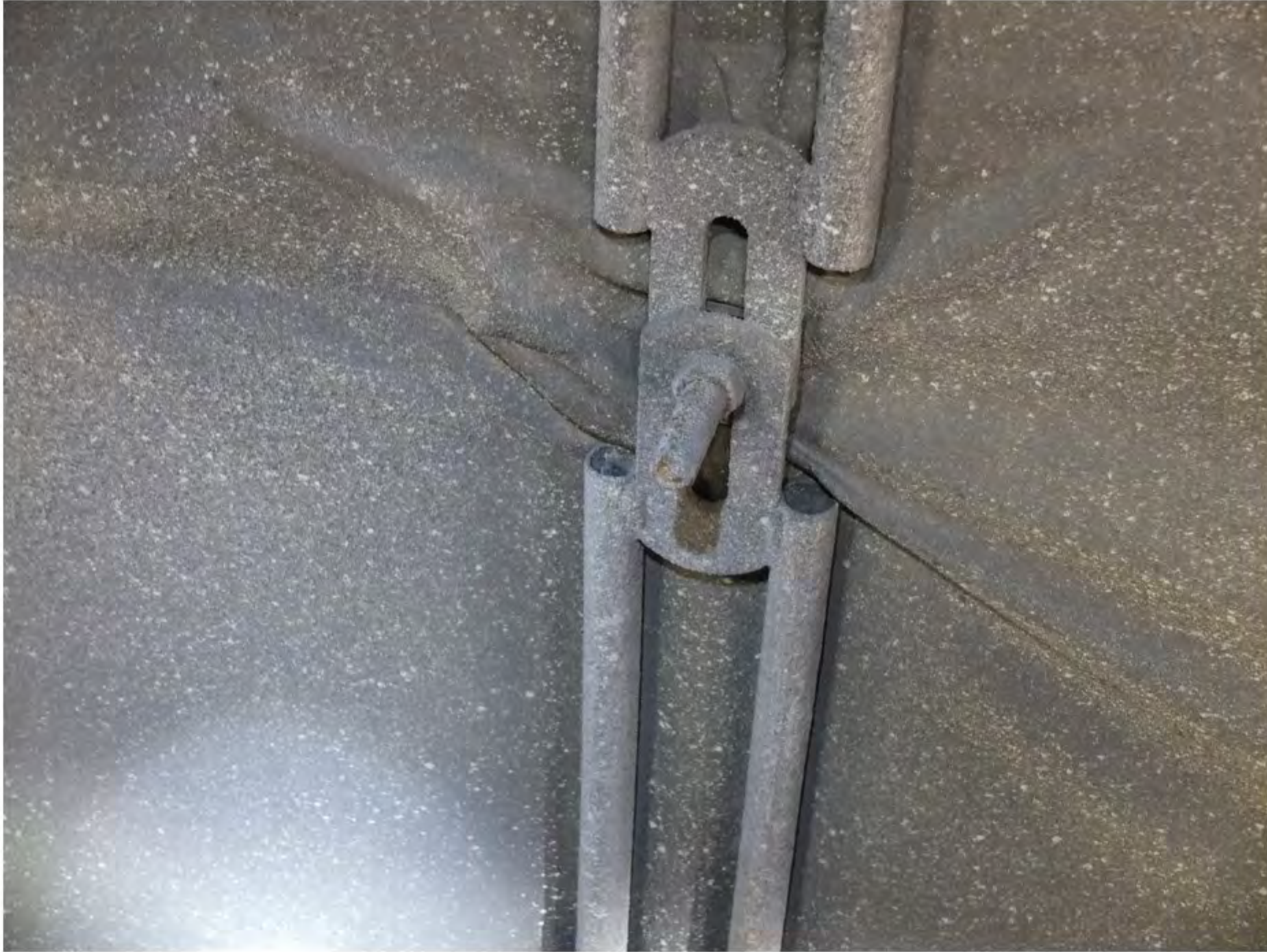
19 Detalj av skjøt av fremrør
