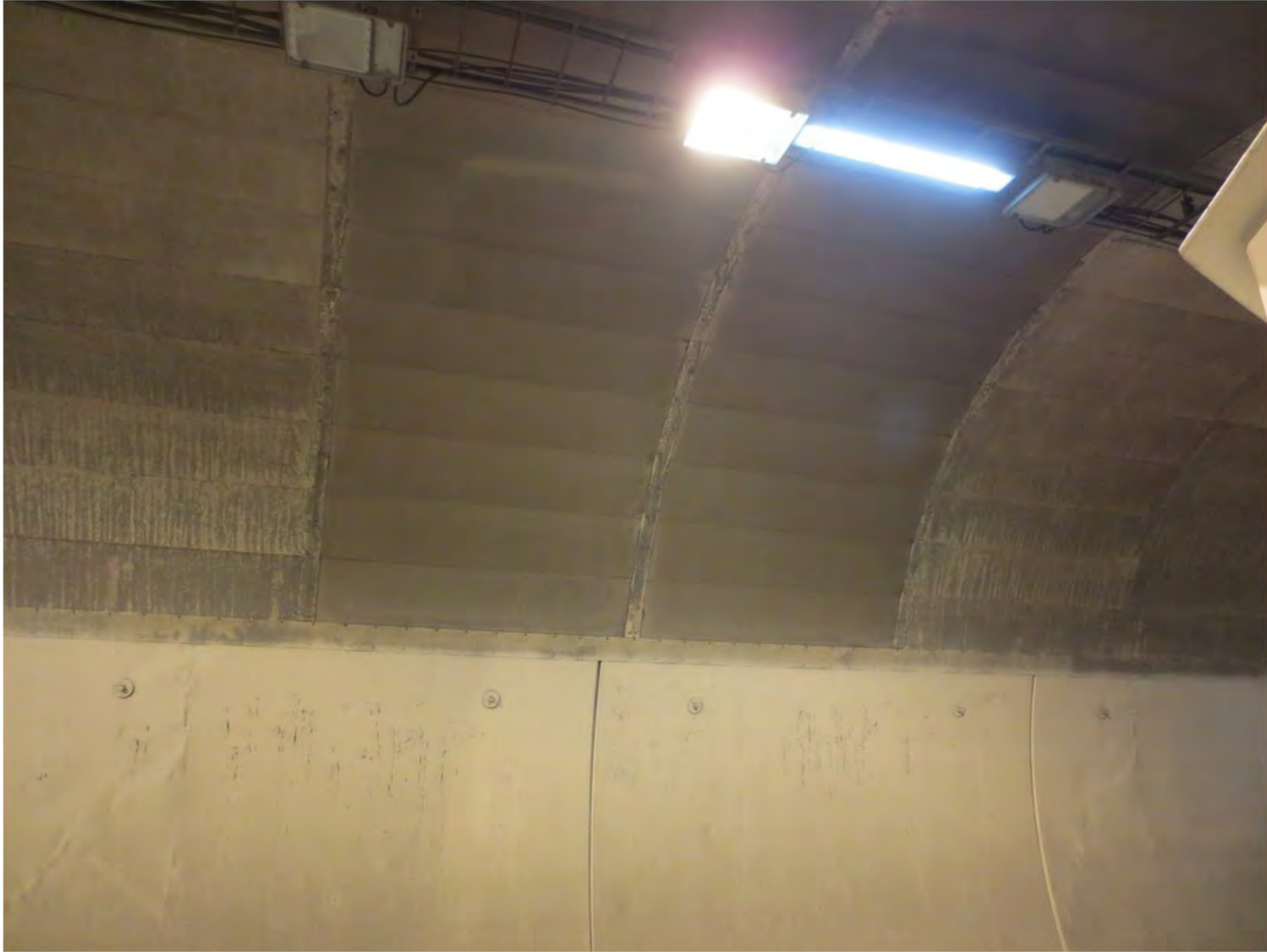
19 Felt med syrefaste platekassetter
