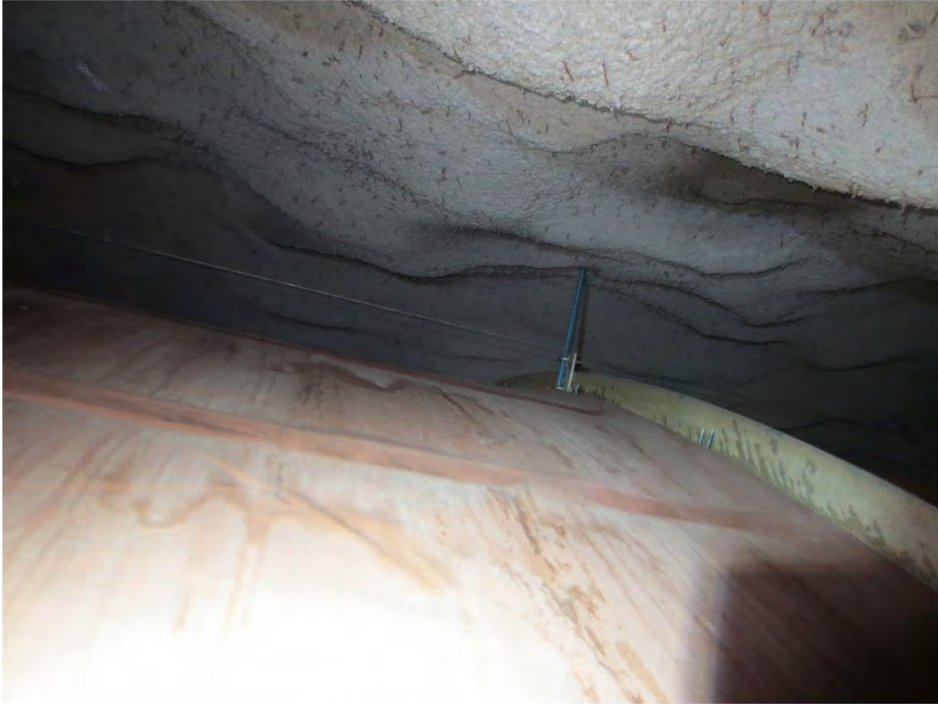
27 Oversikt PVC-membran i hengen
