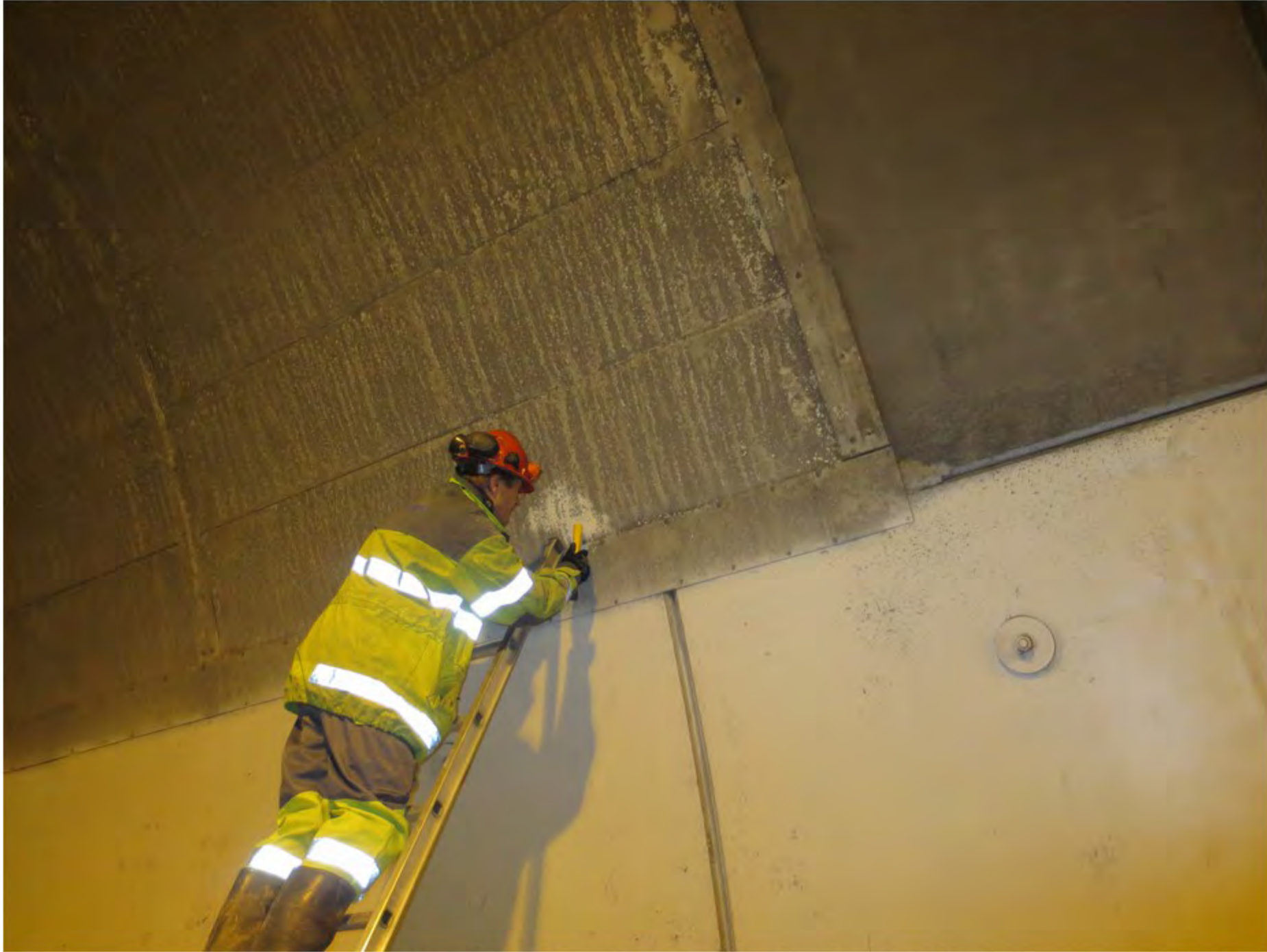
5 Prøvefelt plassert ned mot veggelement - Rengjøring av overflater
