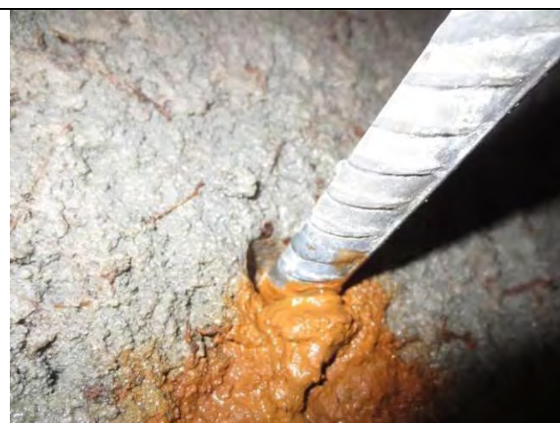
Foto 2.8.21. Detalj bilde bolteinnfesting
