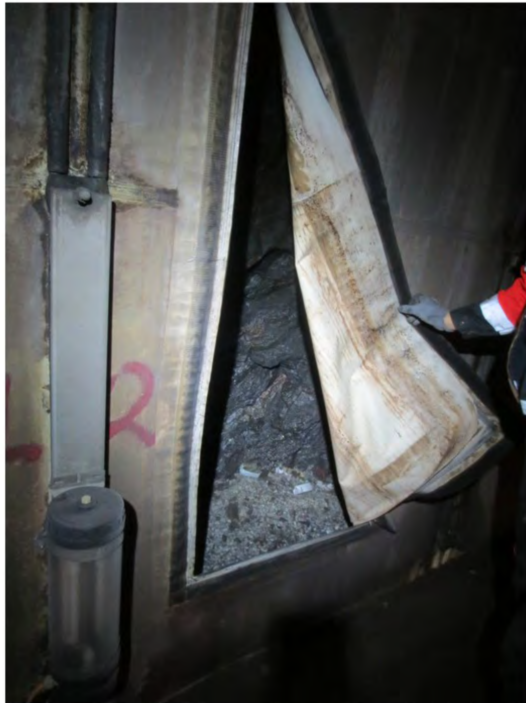
8 Glidelåssluke i seksjon mot øst
