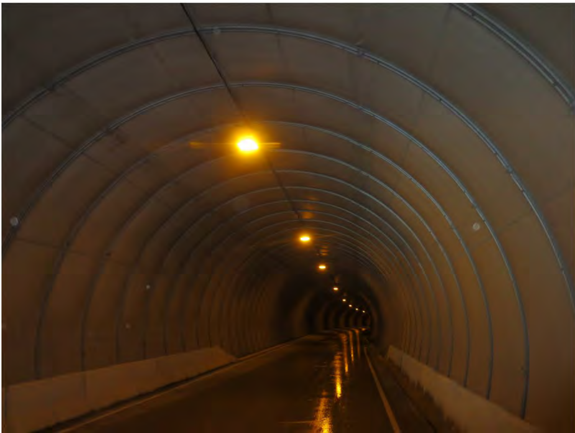
2 Ved vestre portal - Oversikt tunnelkledning innkjøringszone med føringskant
