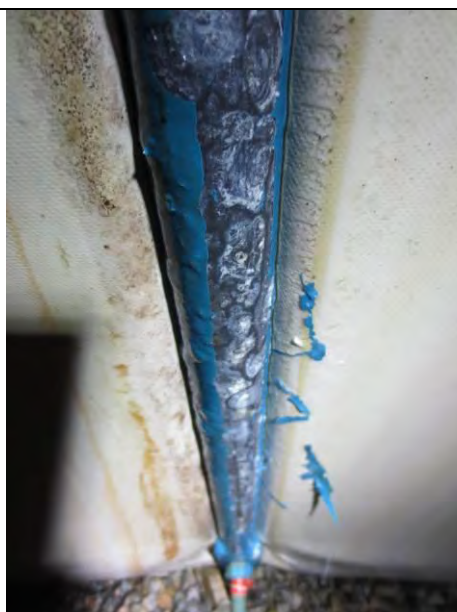
Foto 2.3.9. Løs pulverlakk er fjernet
