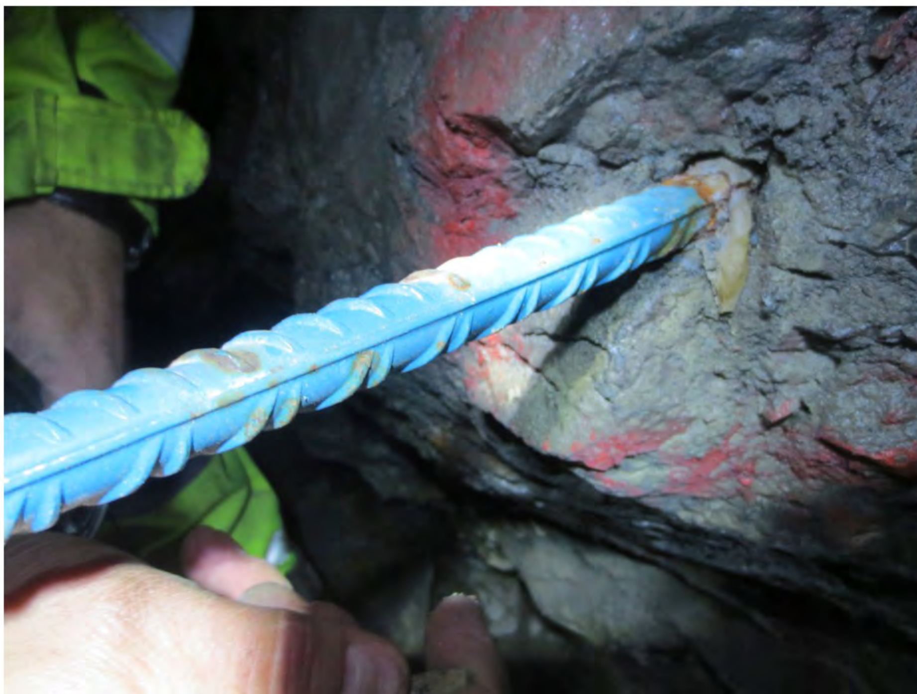
18 Bolt og innfesting til berg
