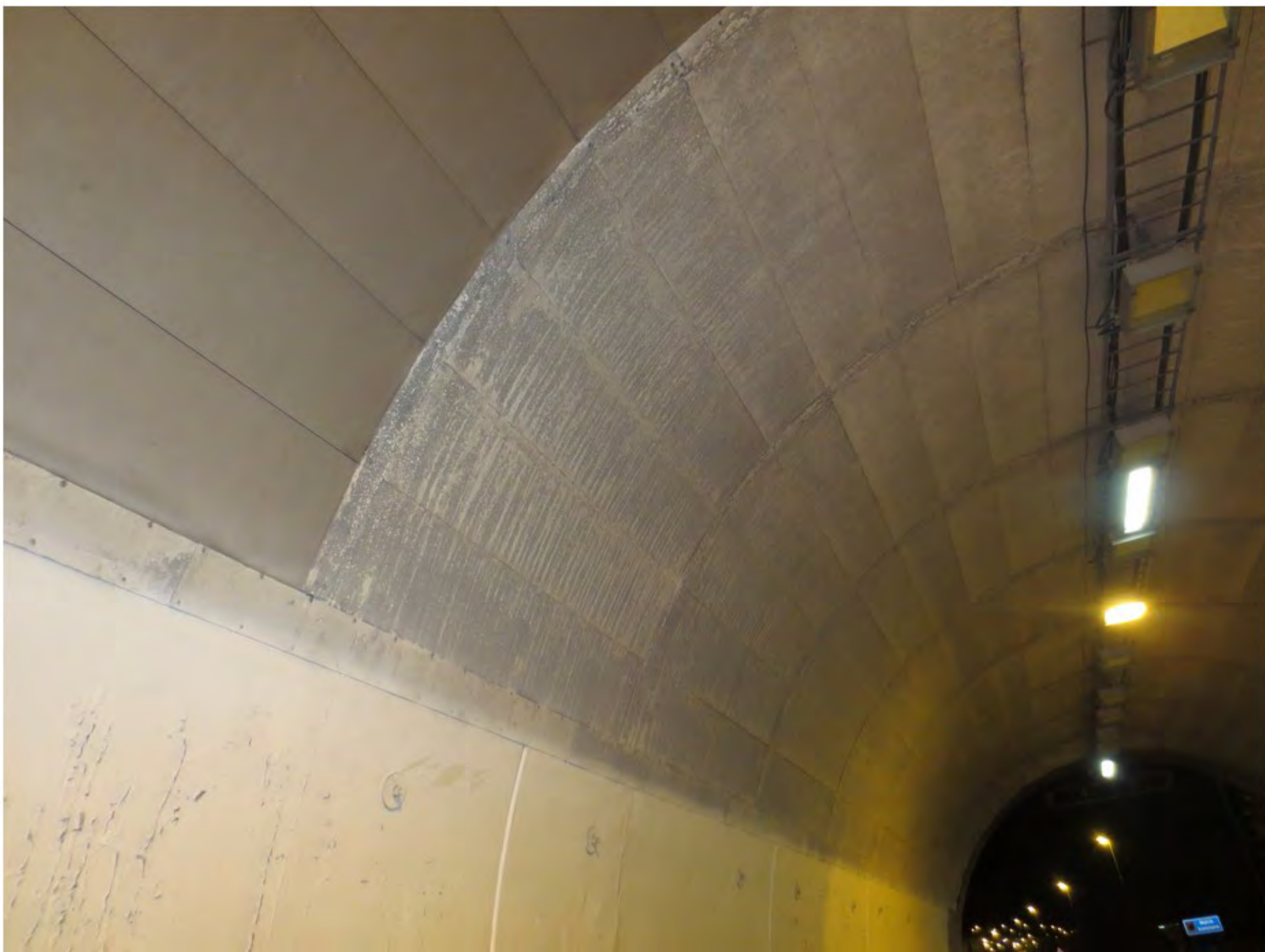
22 Overgang mellom syrefaste og overflatebehandlede platekassetter
