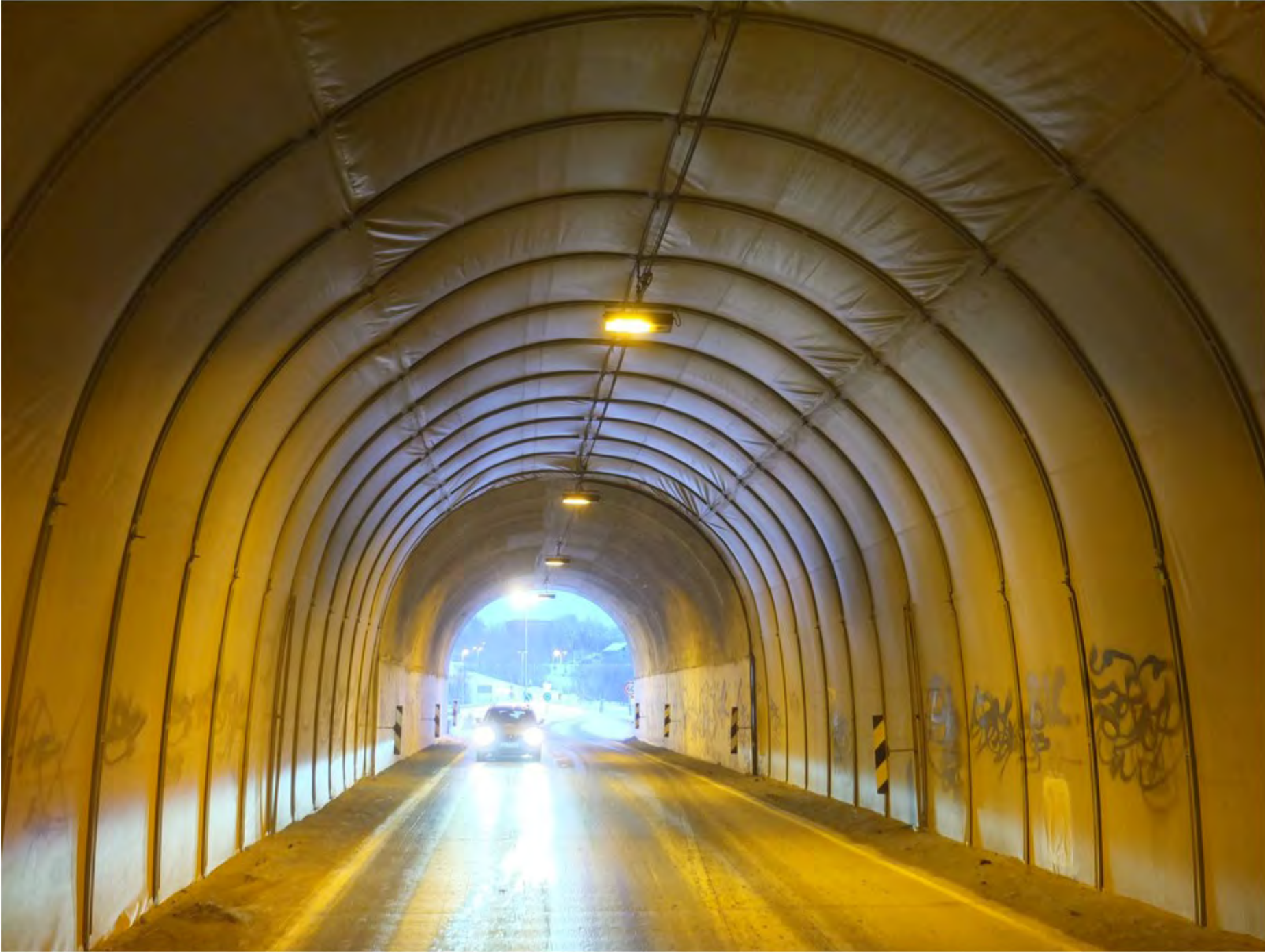
3 Oversikt tunnelkledning innenfor nordre portal
