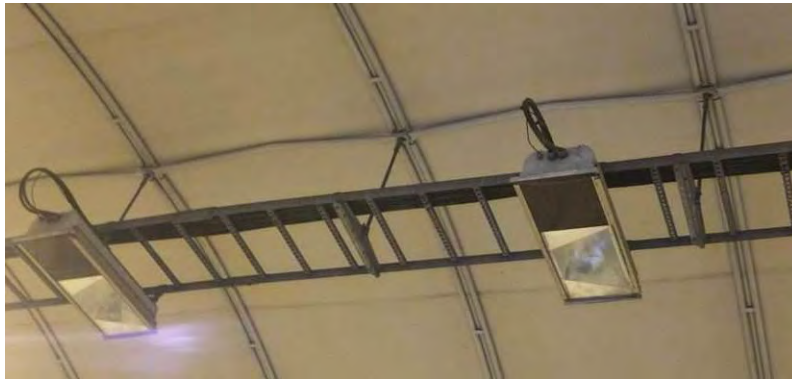
Langsgående topprør i senter tak.
