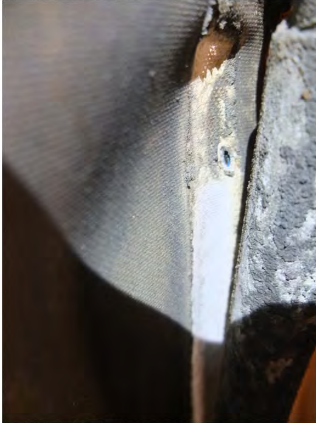
11 Hull i duk i klemsone mellom rørene
