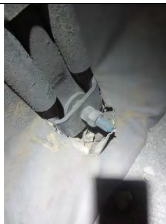
Foto 2.2.3. Revnet duk ned mot bankett
