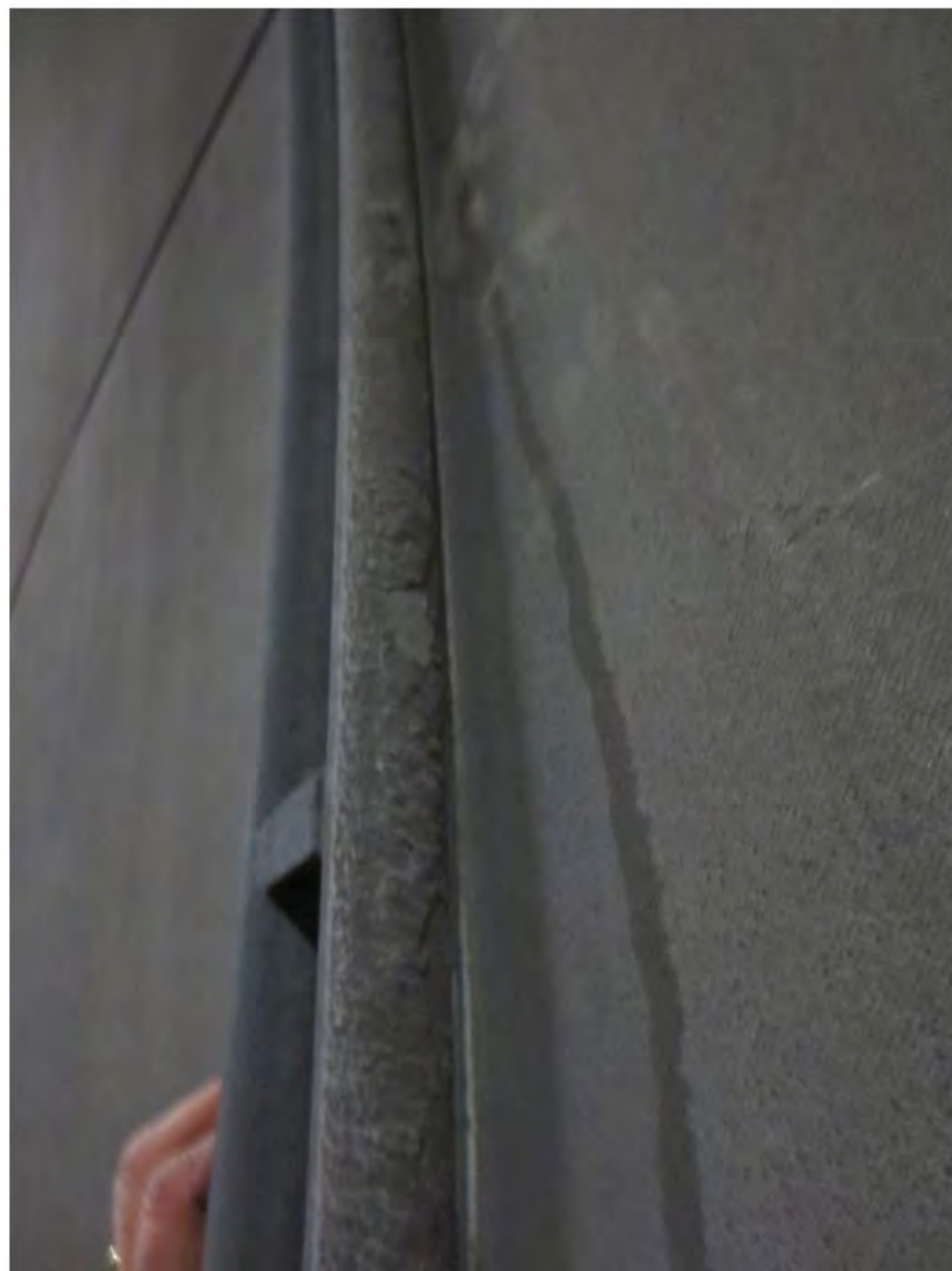
14 Fremrør løsnet
