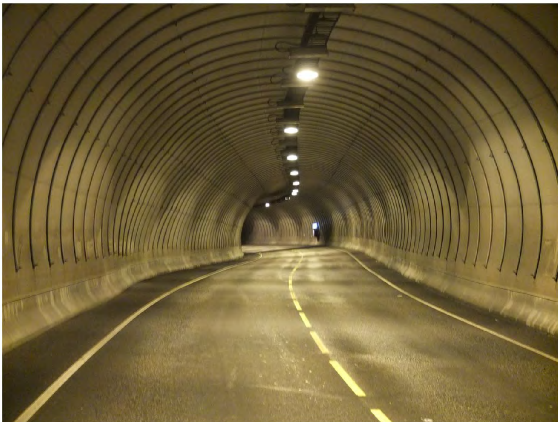
3 Oversikt tunnelkledning med bankett av betong
