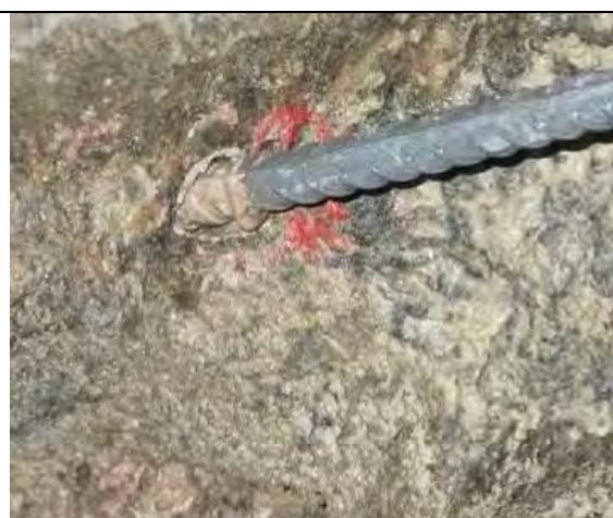
Foto 2.8.19. Ingen skader på bolt i berginnfestingen
