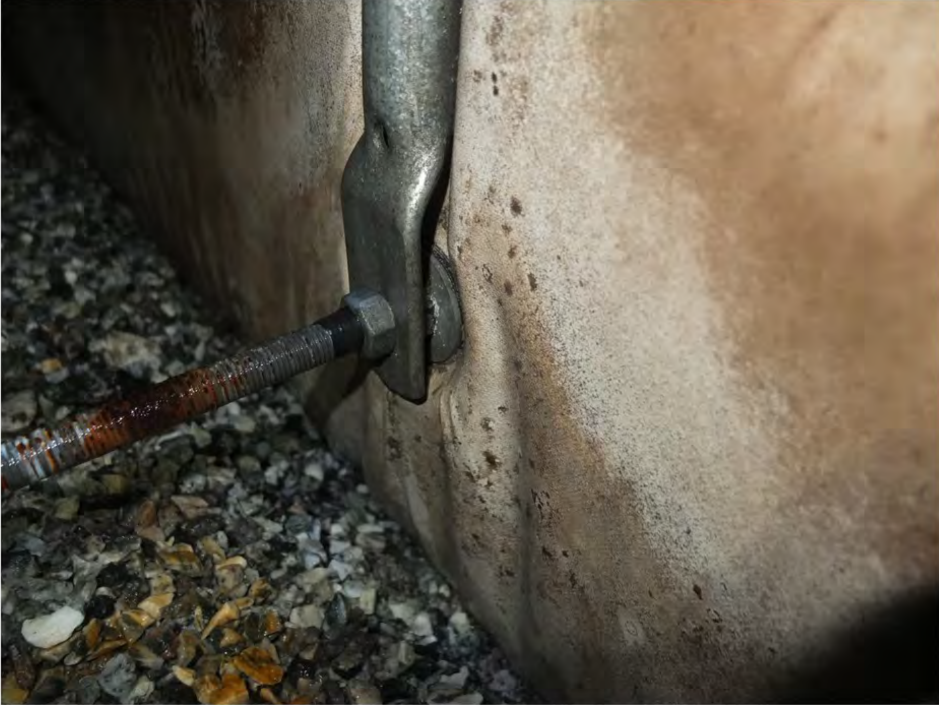
17 Nedre boltegjennomføring - Seksjon mot øst med 554 duk
