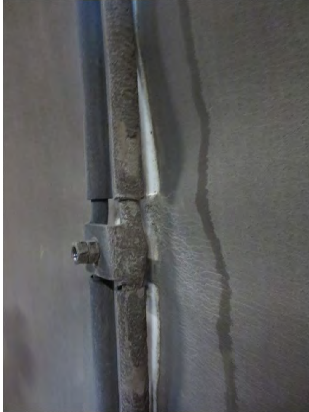
13 Fremrør løsnet
