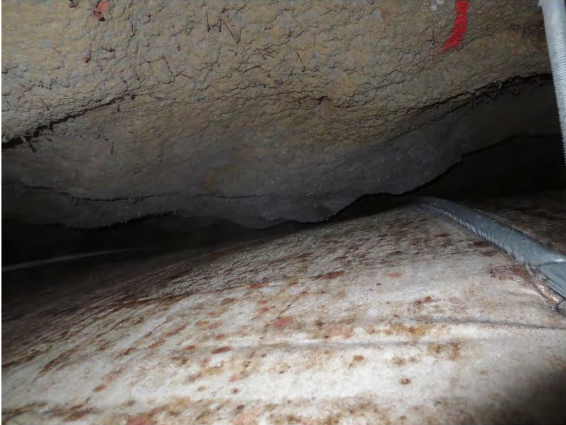
27 Hull pga punktkontakt med fjell
