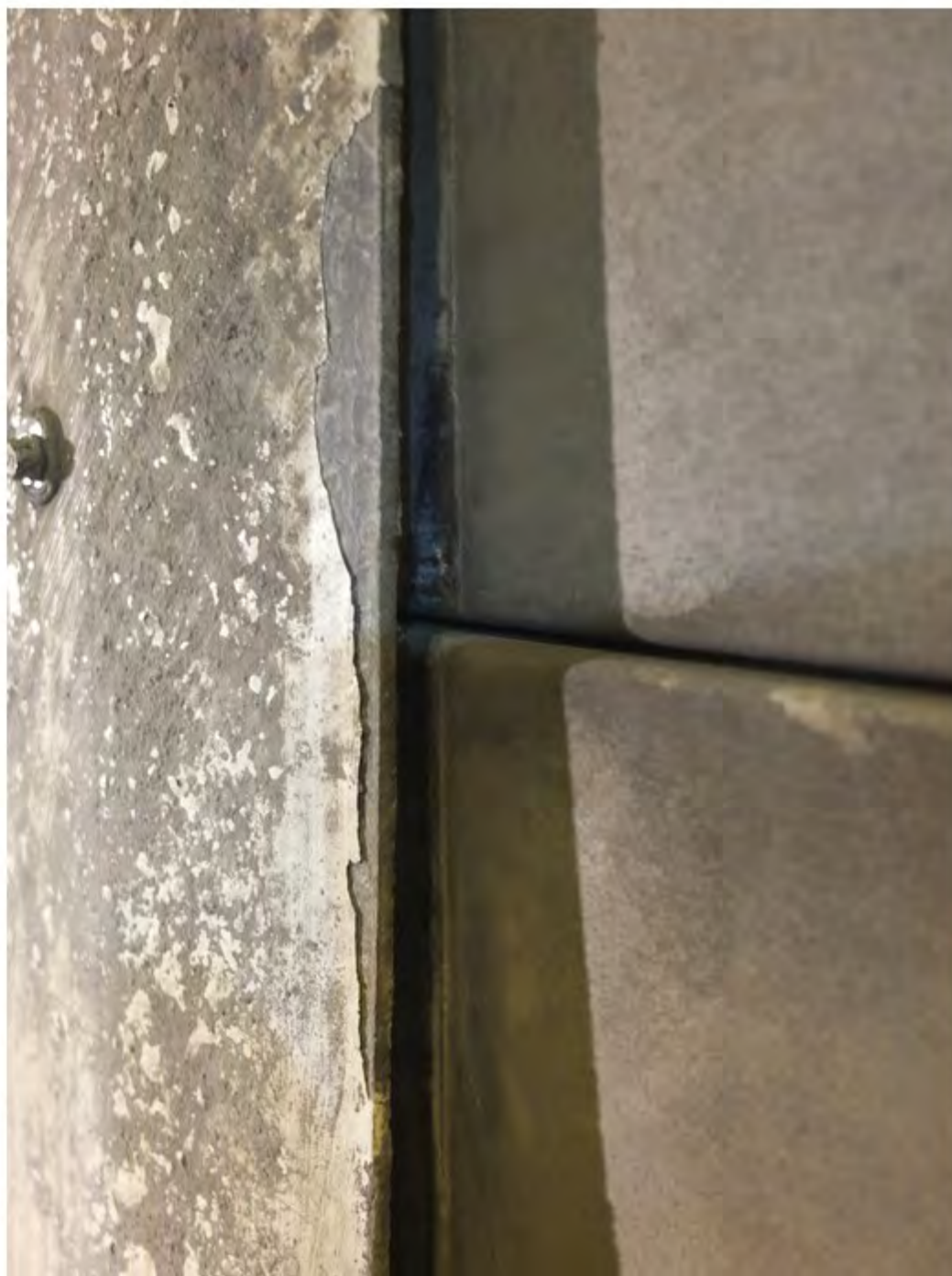
16 Flassing av lakk på tverrgående dekkbeslag
