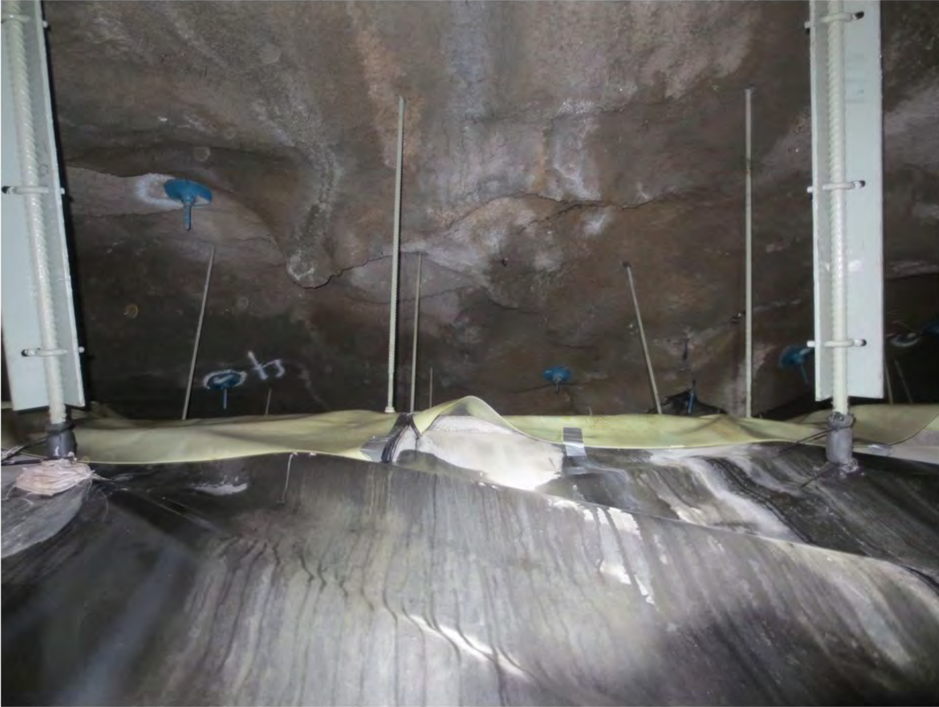
5 Overgang betongelementer og sprøytebetonghvelv
