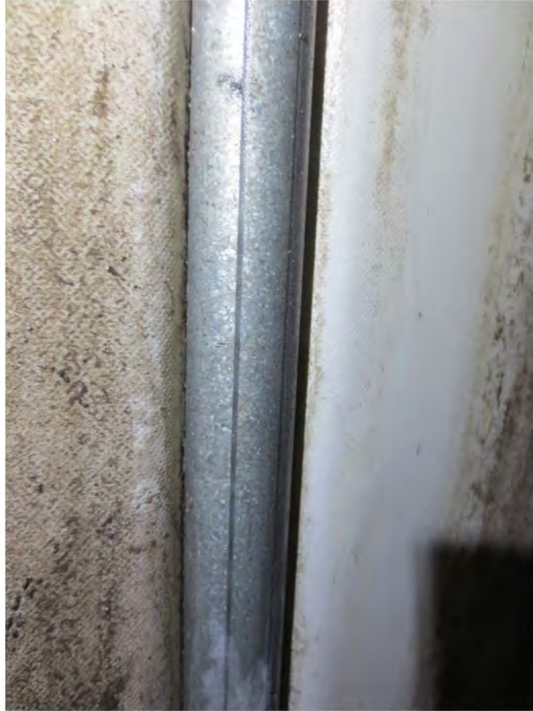
15 Bakrør seksjon mot øst - God tilstand på sinkbelegg
