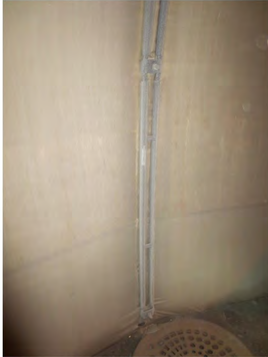
25 Tunnelduk 556 på seksjon mot vest
