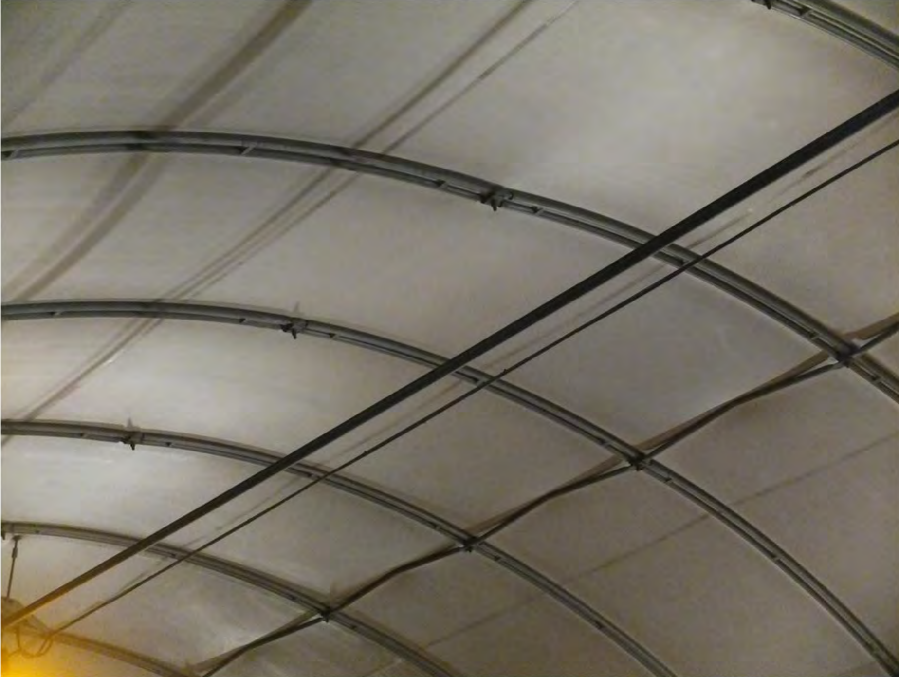
3 Oversikt tunnelduk i tak
