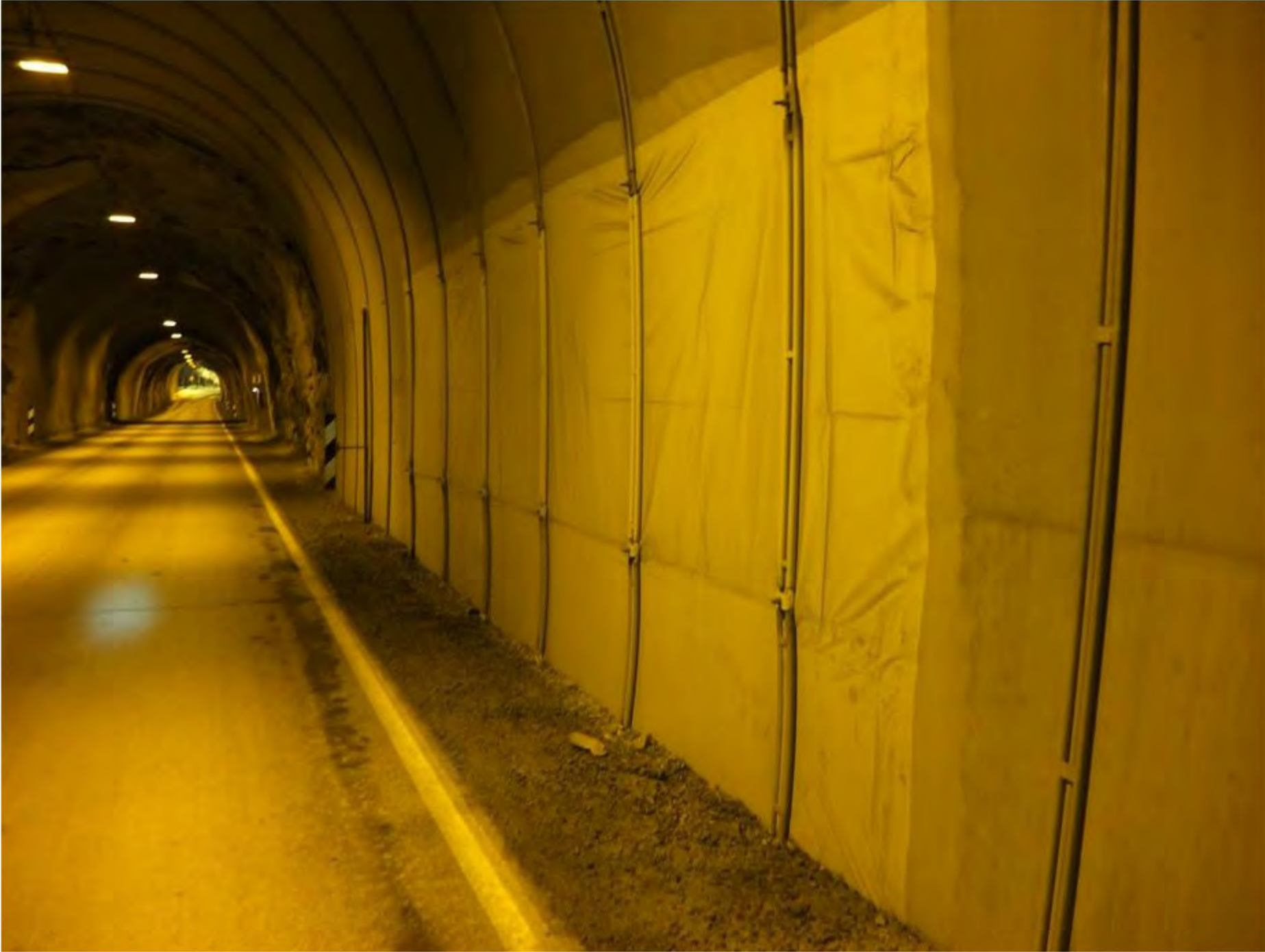
13 Profil 200 før søndre portal - Reparasjonsfelt med WG tunnelduk type 556 ca 3 x 8 m
