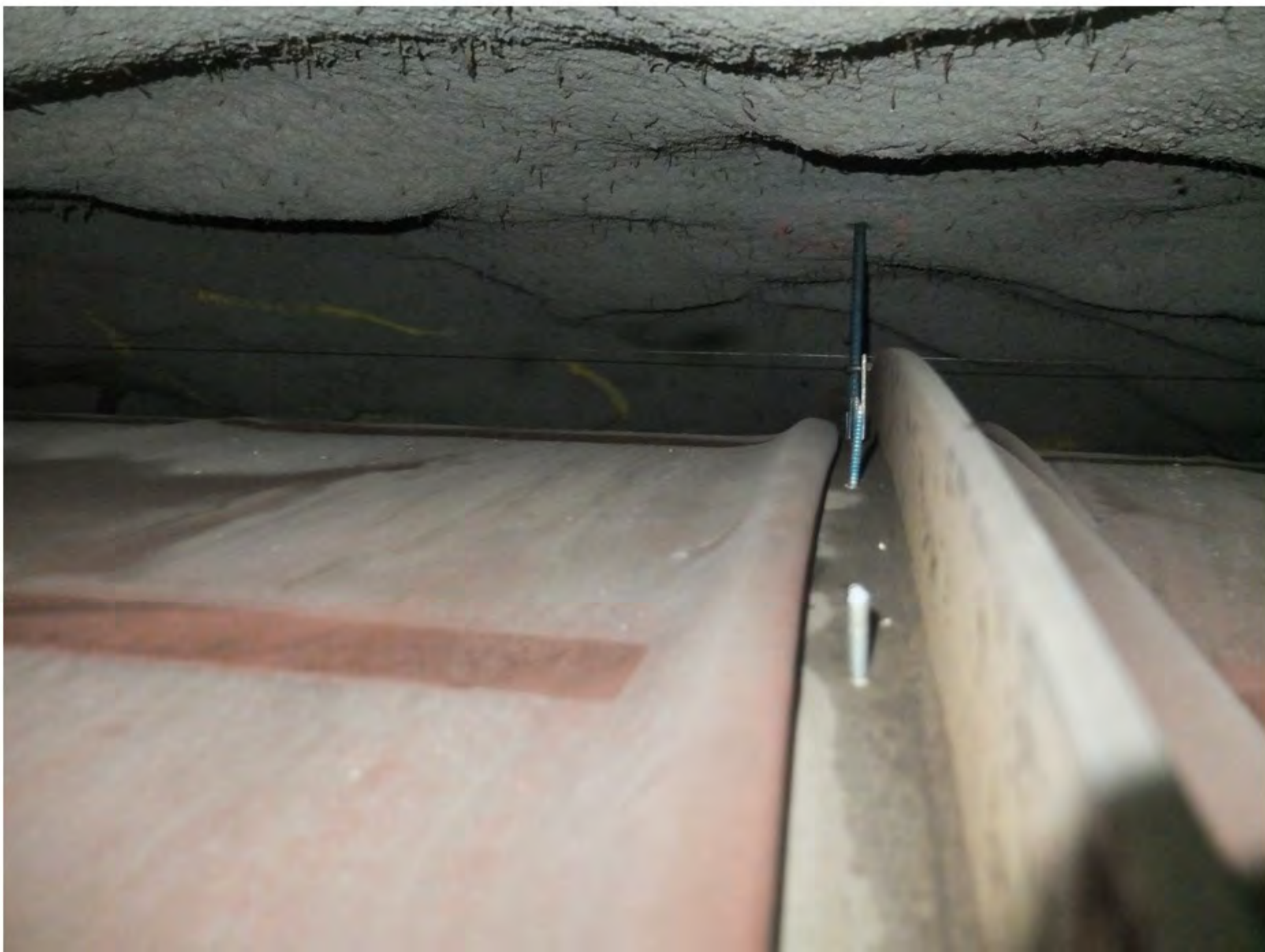
28 Tilslutning og innfesting av membran til T-profilet
