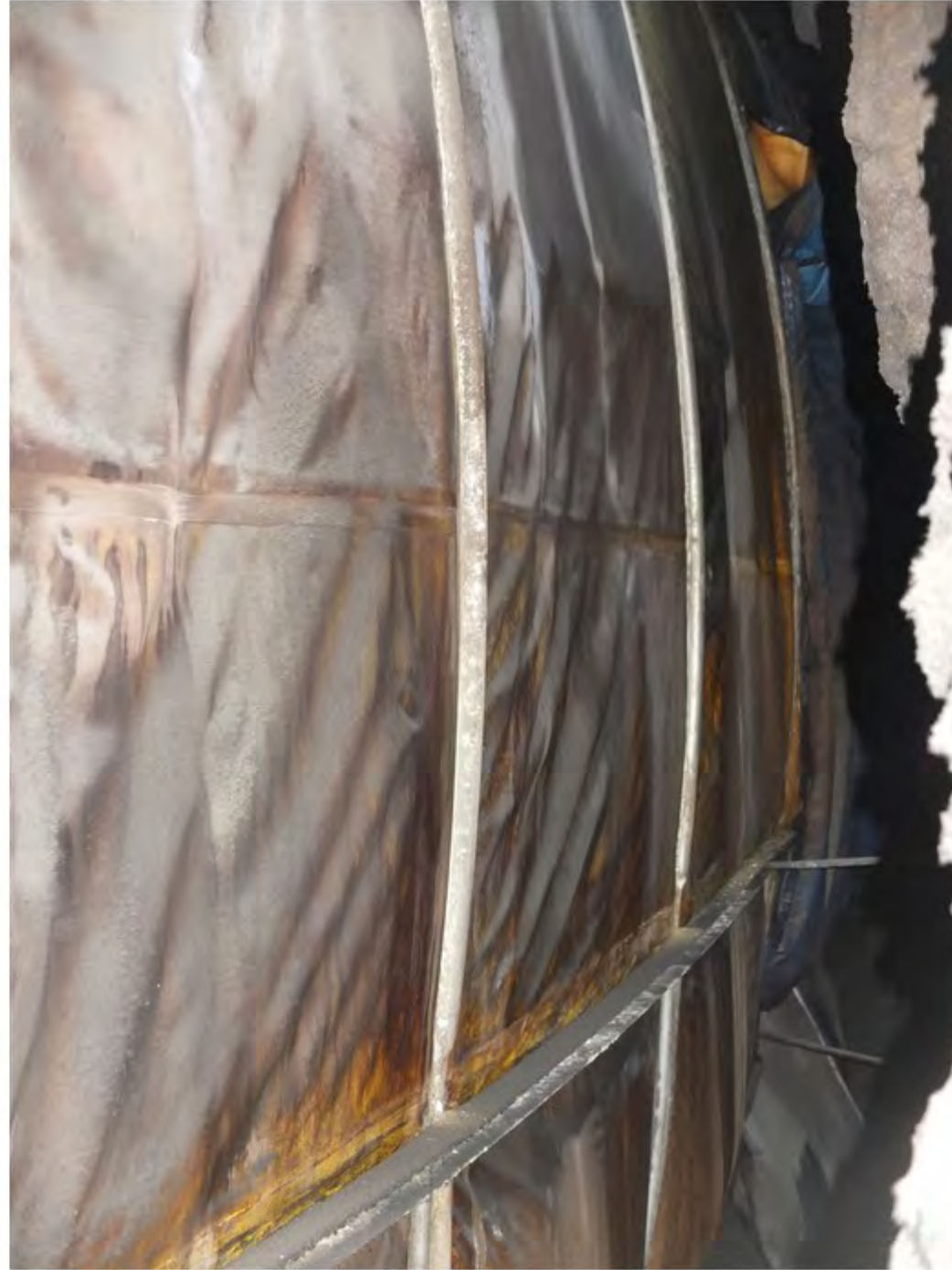
21 Baksiden av isolert hvelv
