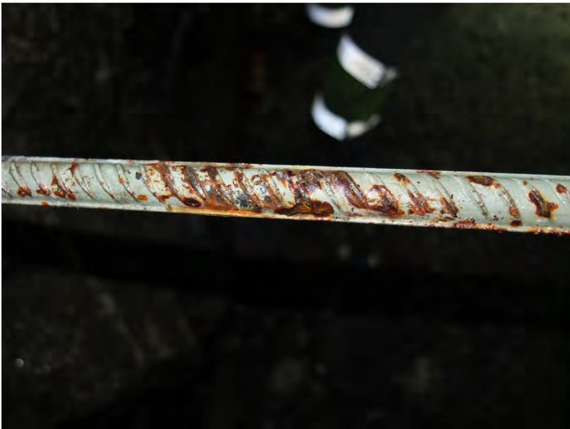
36 Festebolt - Korrosjon ved punktskader i overflatebehandlingen samt avleiringer fra lekkasjevann
