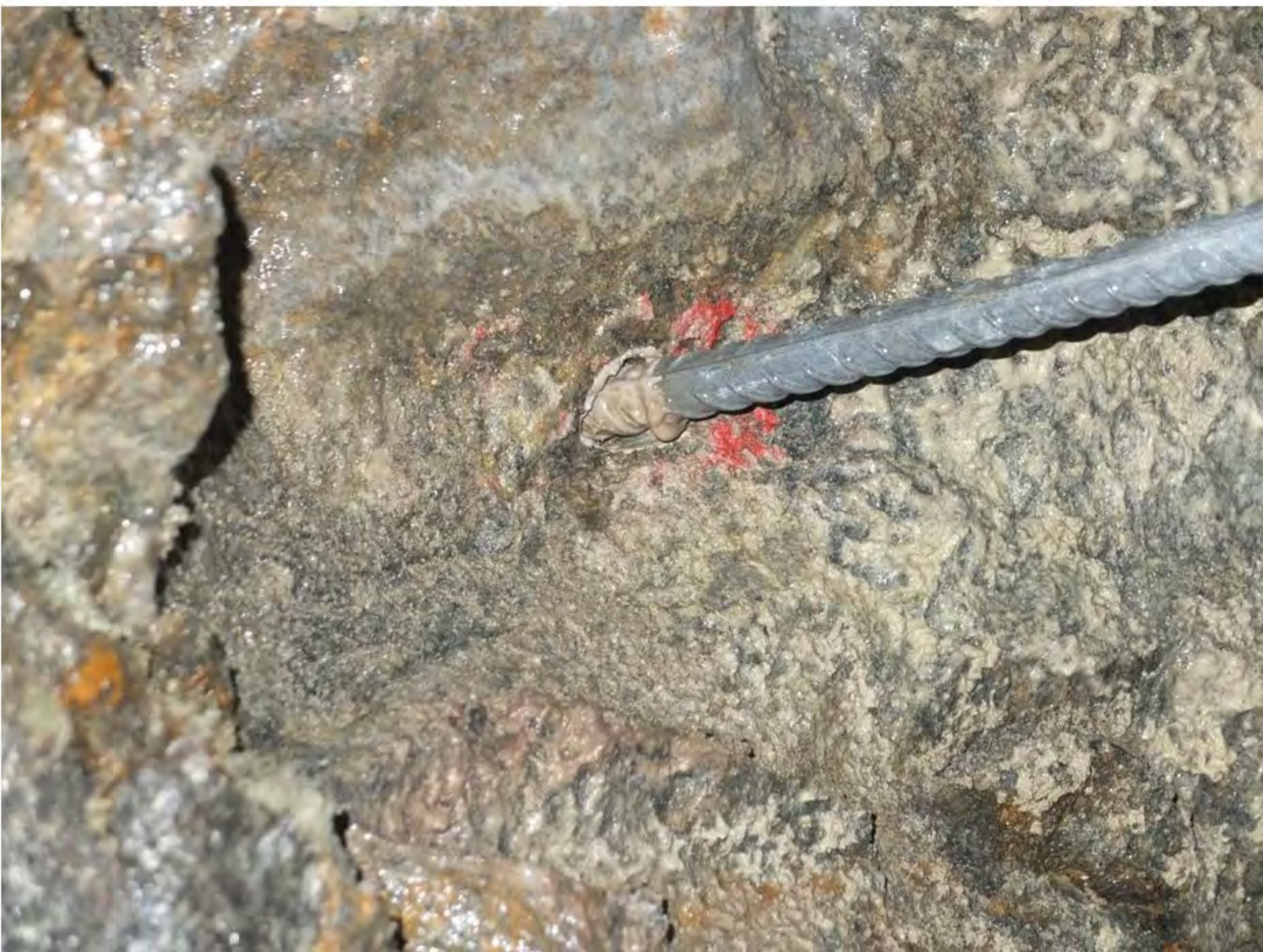
38 Ingen skader på bolt i berginnfesting
