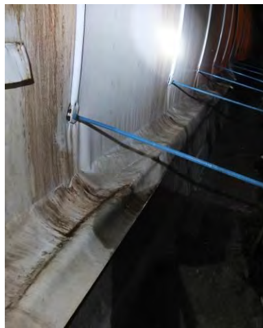
Foto 2.6.4. Tilslutning duk mot føringskant, bergsiden
