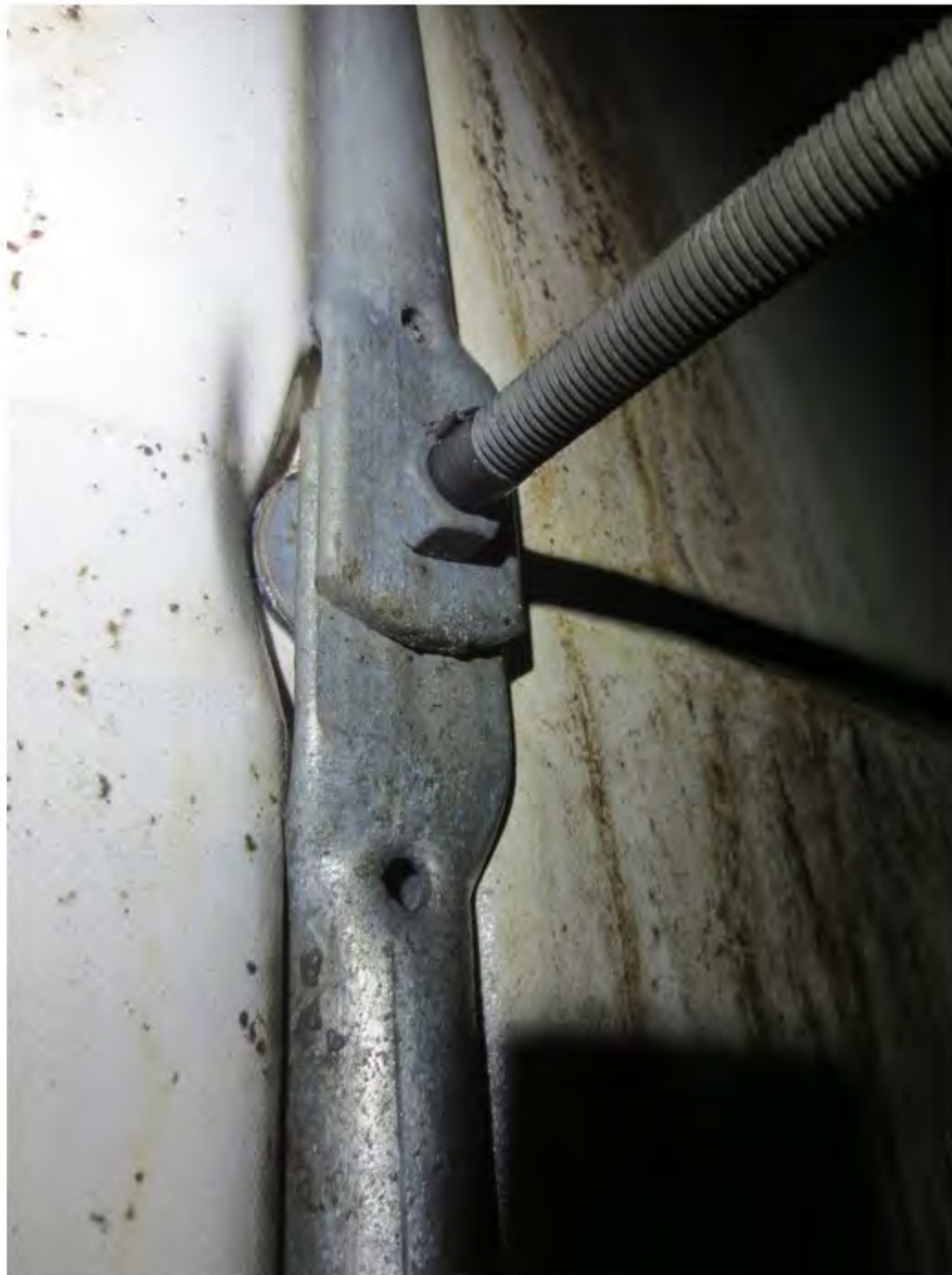
14 Bakrør og festebolt på seksjon mot øst
