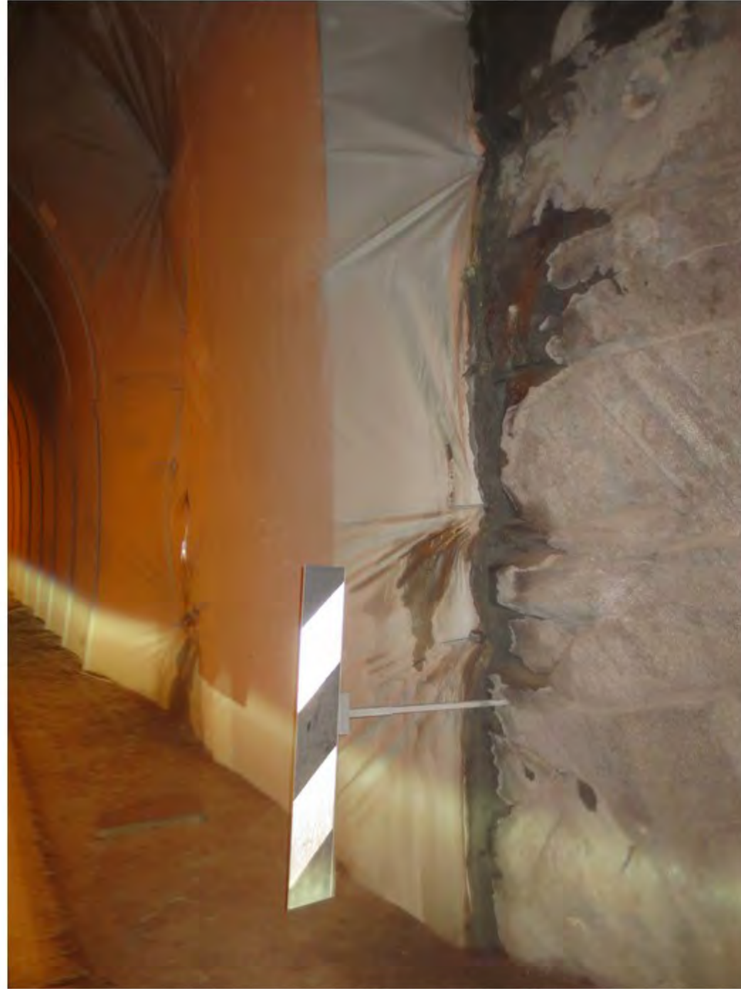
21 Detalj av endeavslutning av duk
