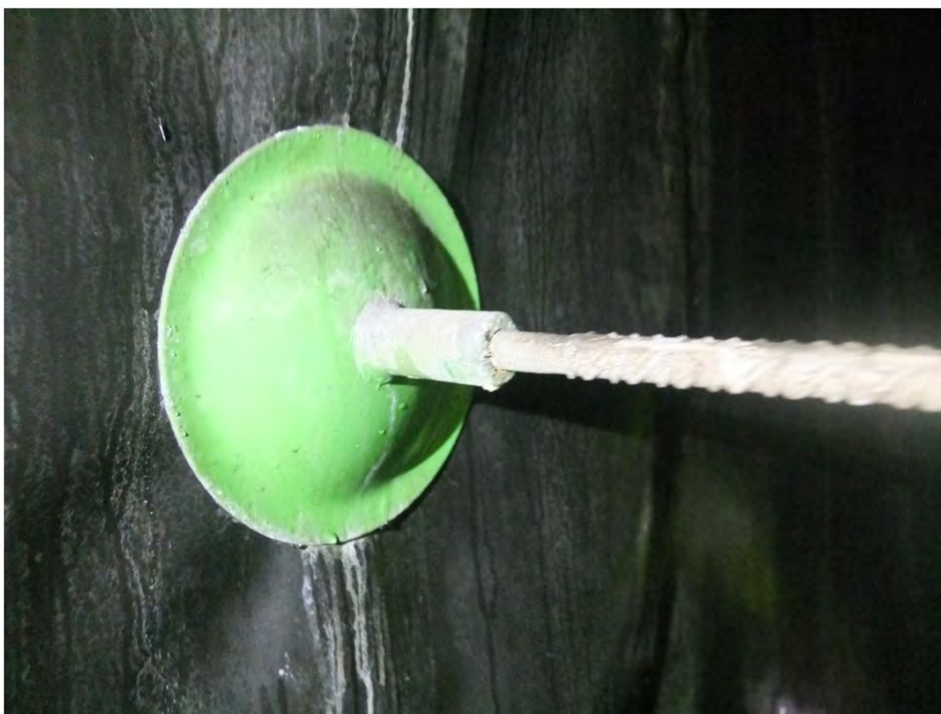
22 Noe blæring - Lakkskader på kant
