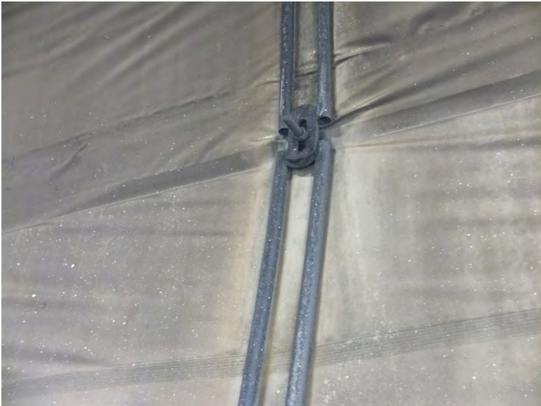
18 Detalj av skjøt av fremrør
