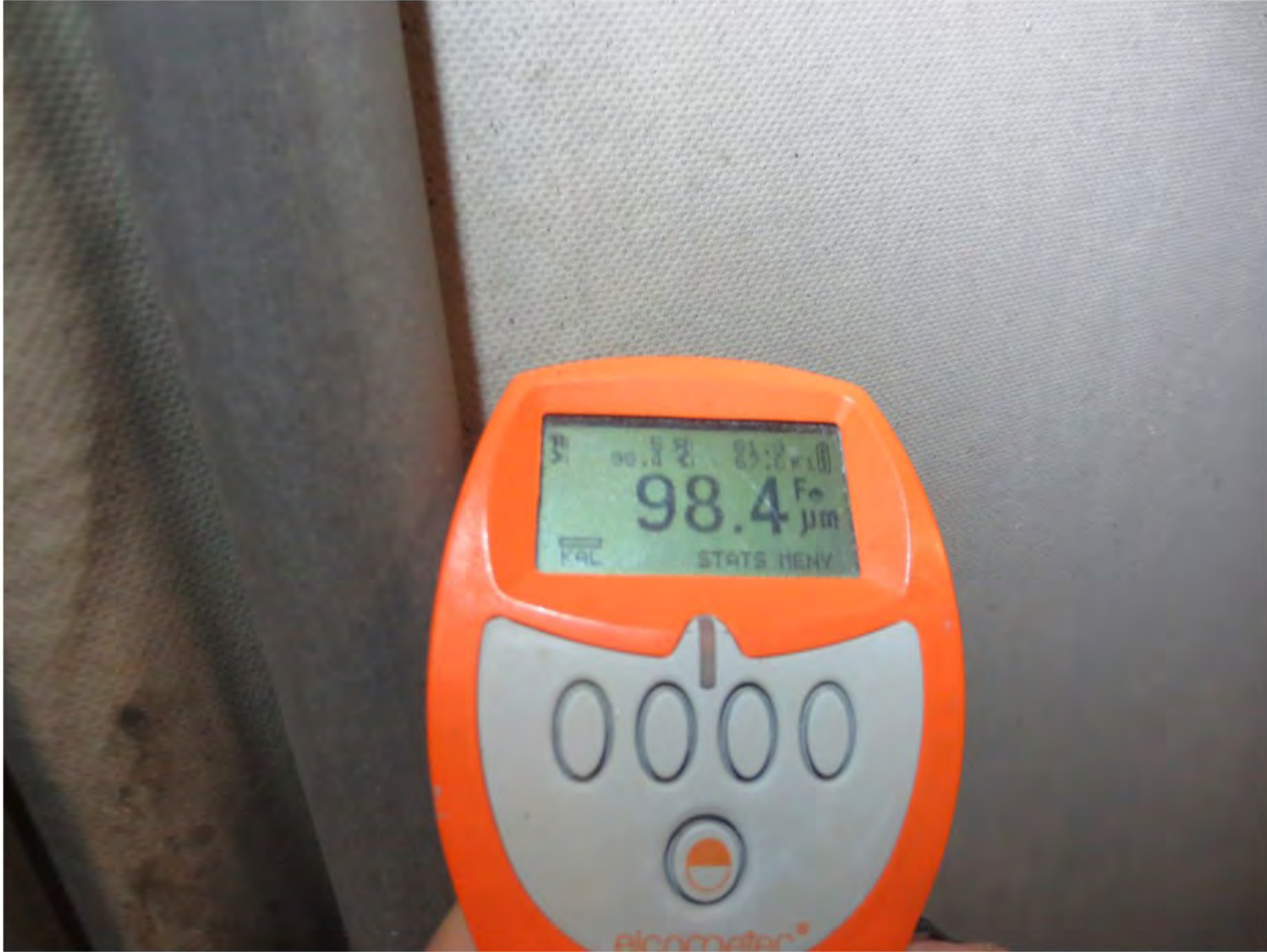
17 Tykkelsesmåling på fremrør
