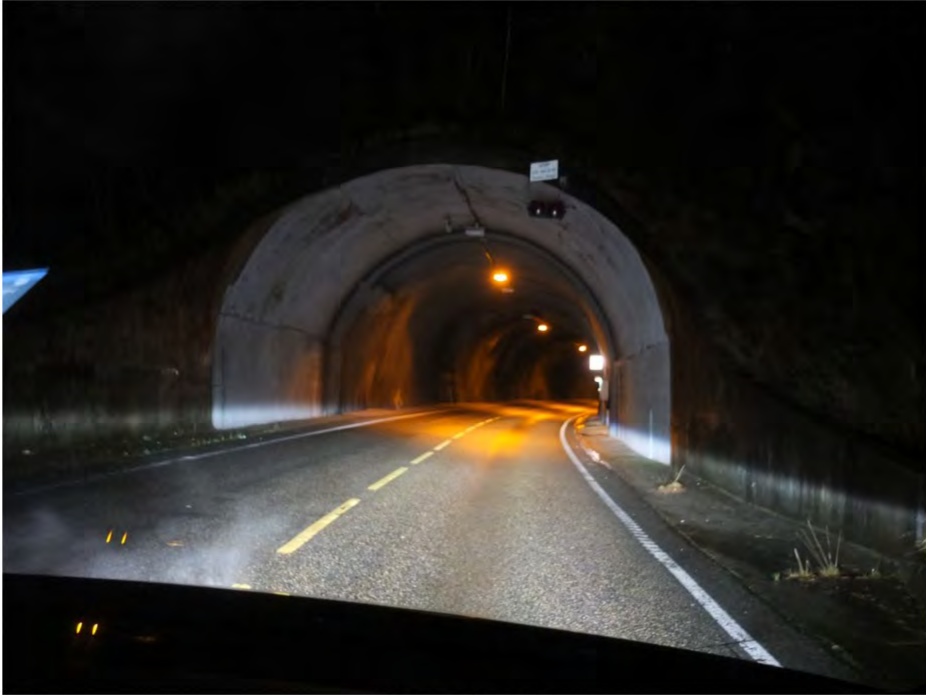
1 Portal på Bjorøysiden
