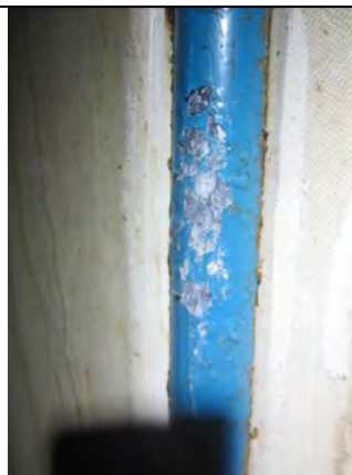
Foto 2.2.5 Løs pulverlakk er fjernet
