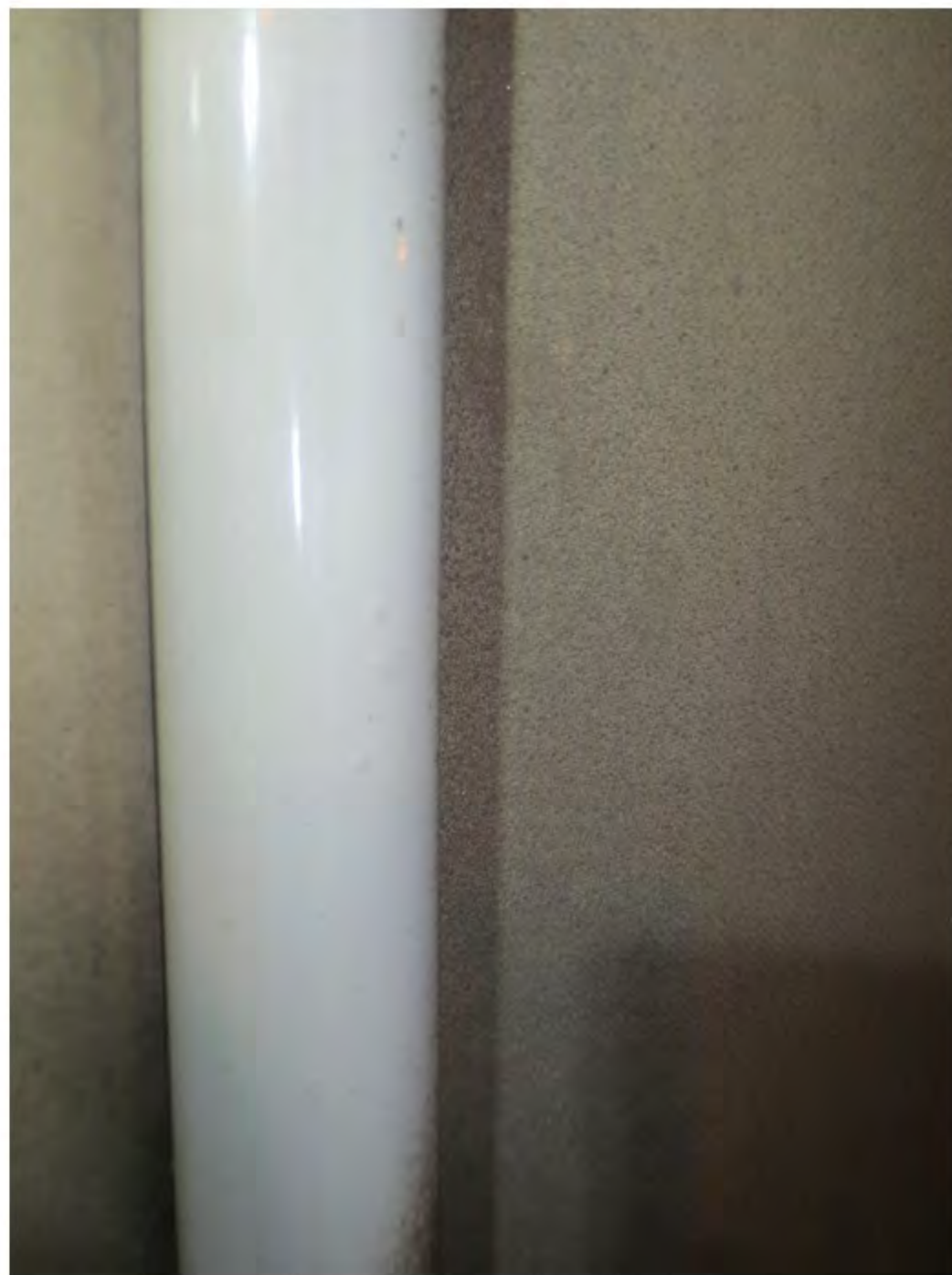
16 Blæring i Combicoat på fremrør
