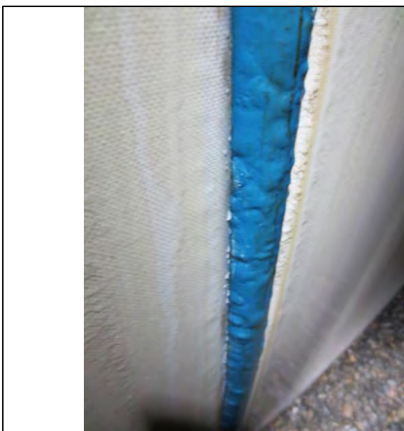
Foto 2.3.8. Blæring i pulverlakk (saltvannssonen)
