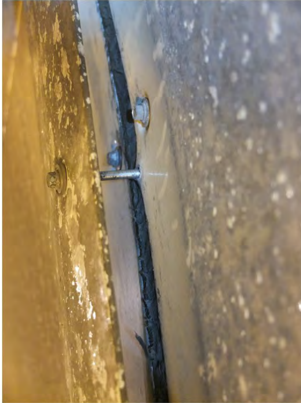
17 Festebolter for kassetene under dekkbeslaget
