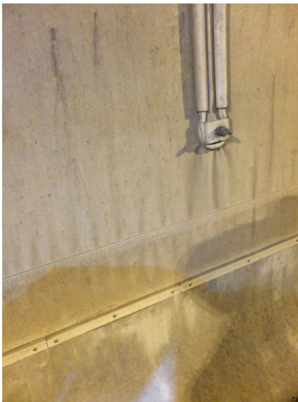
10 Innfesting av tunnelduk til betongbankett på trafikksiden
