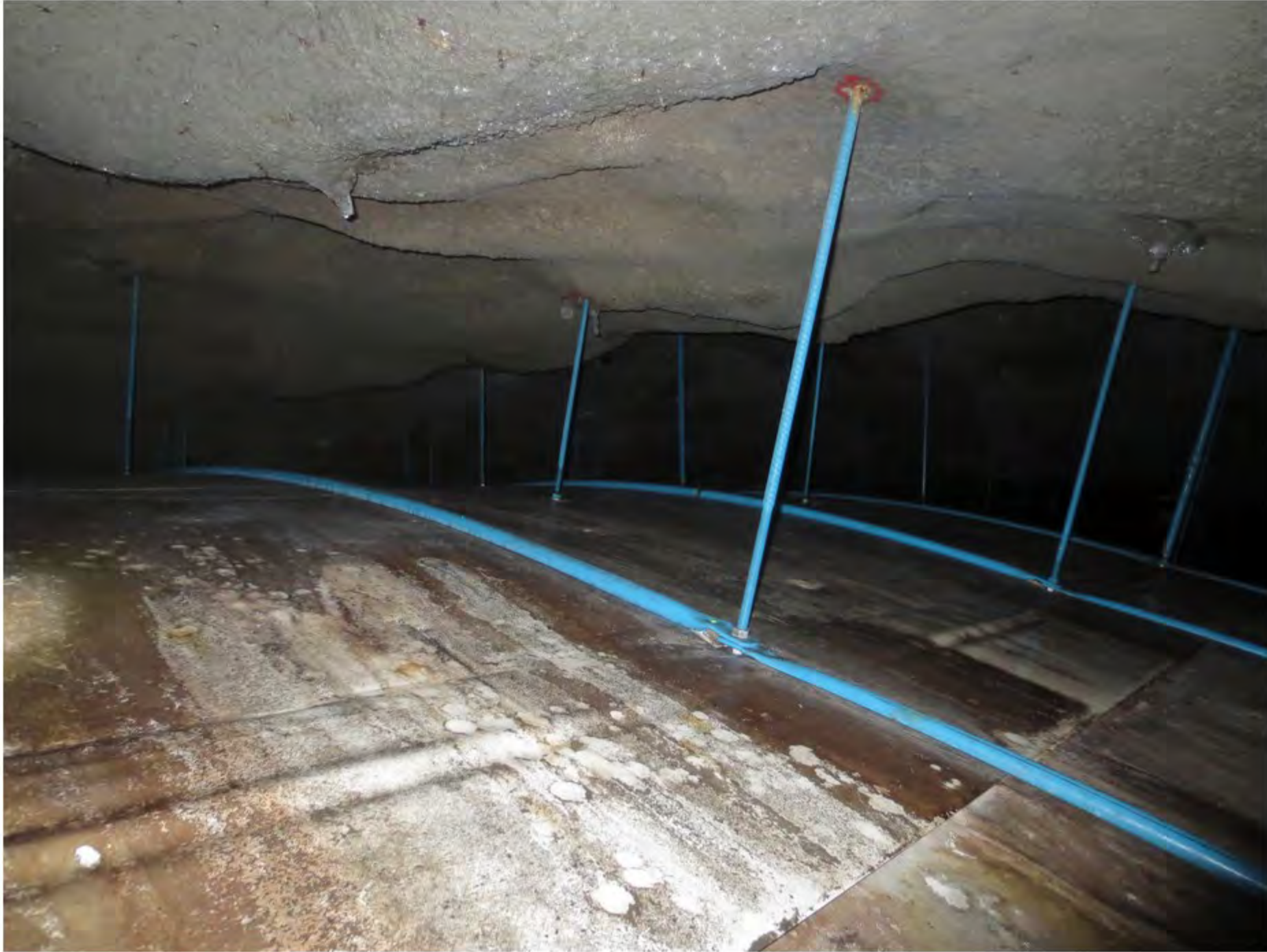
11 Oversiden av hvelv
