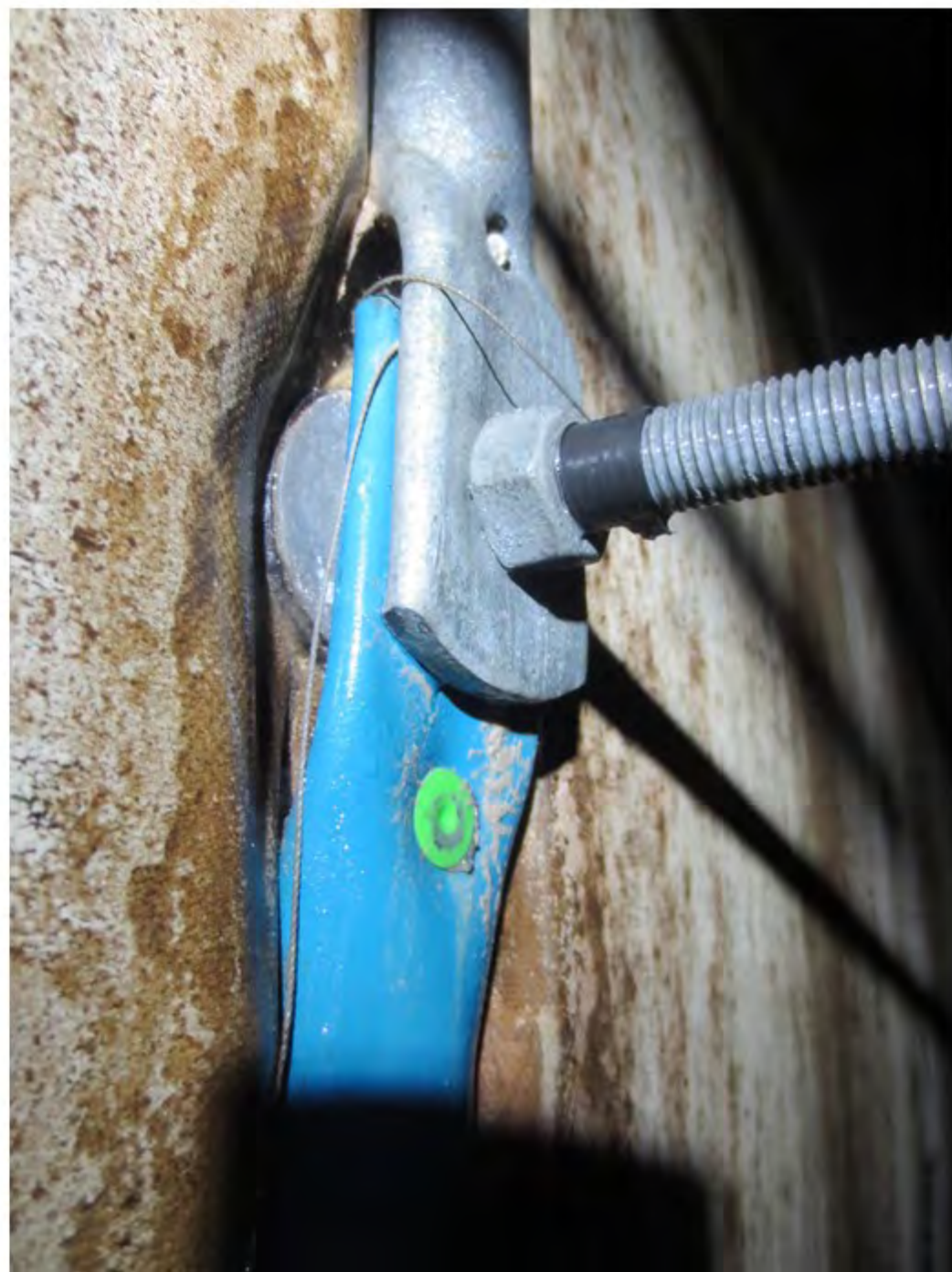
40 Kombinasjon av sinkbelegg og Combicoat på bakrør - Seksjon mot vest
