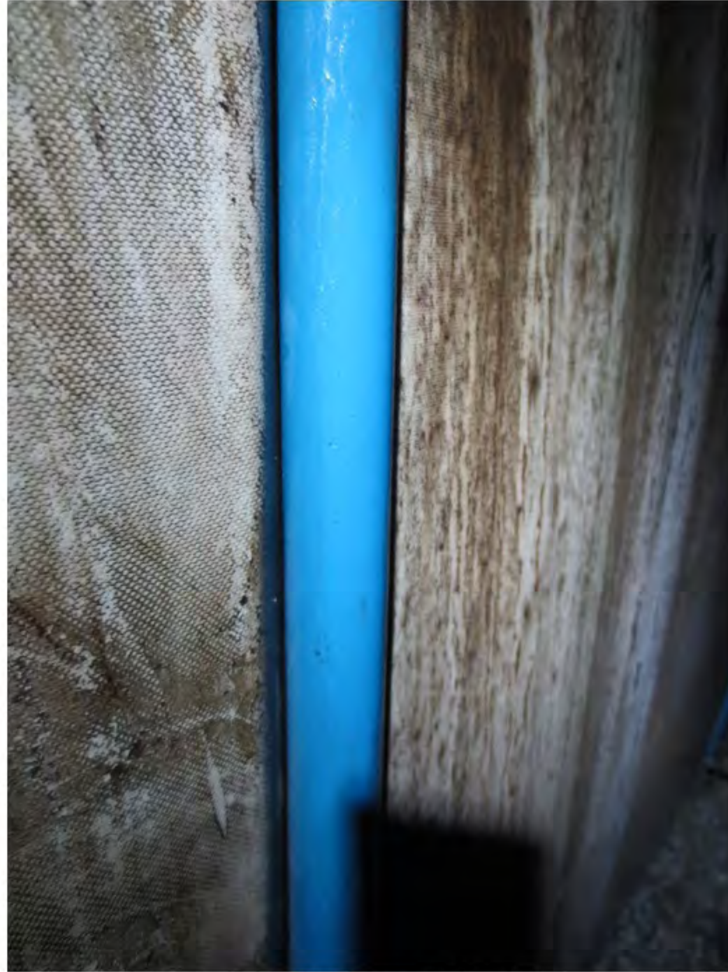
41 Bakrør med Combicoat med god tilstand
