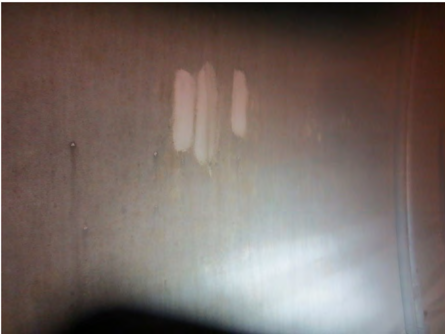
8 Profil 1800 - Tilsmussing fjernet - Duken er inntakt
