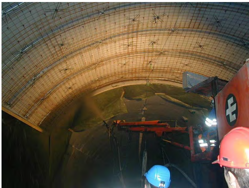
Fig 1.4 T200 klar for påføring av sprøytebetong (Troldhaugtunnelen)
