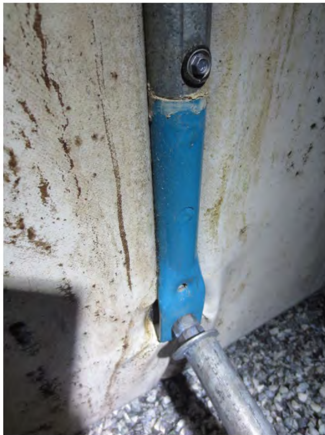
18 Seksjon mot øst - Deler av bakrør har Combicoat belegg
