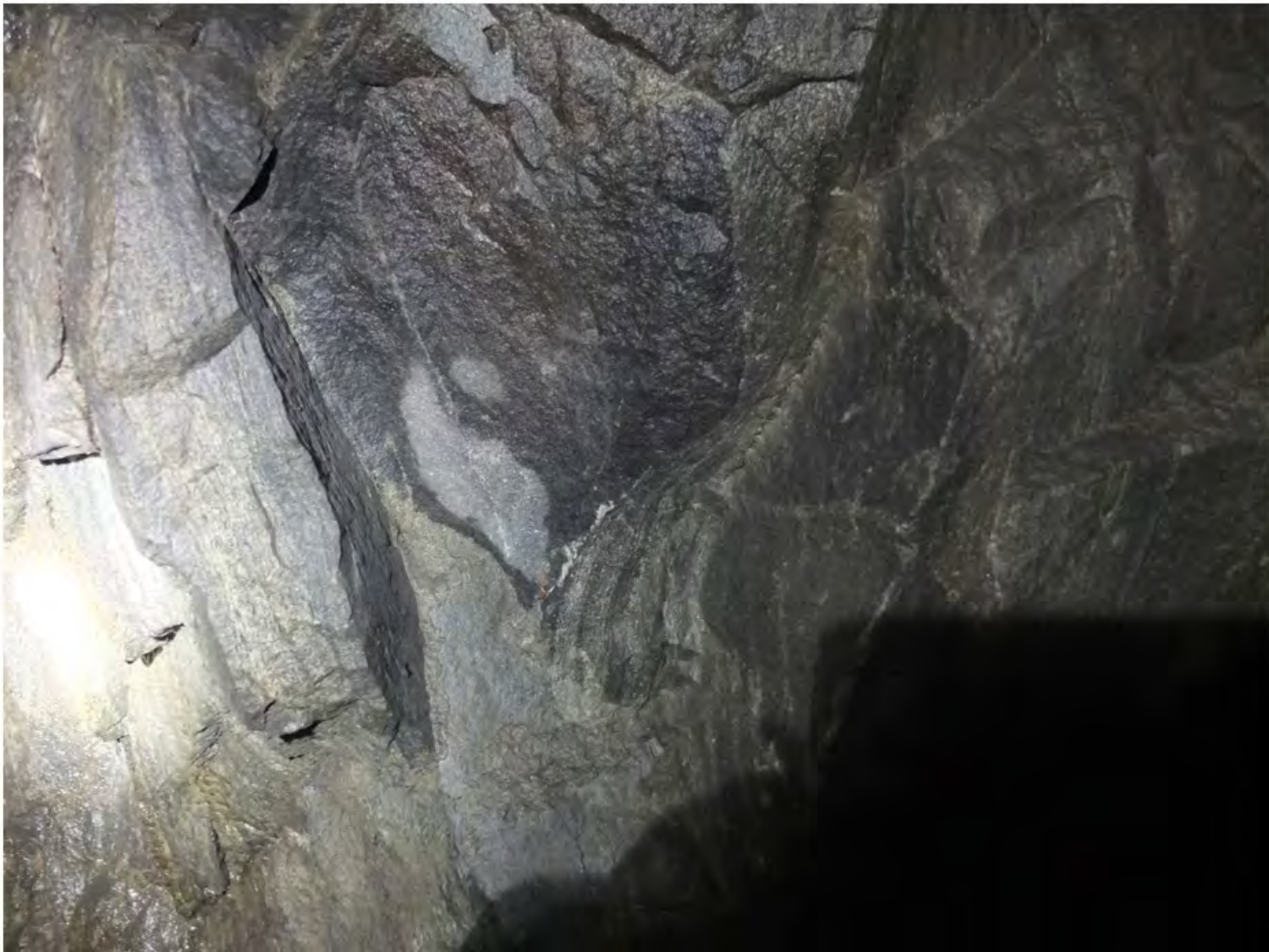
46 Bergtype på vestre del av tunnelen
