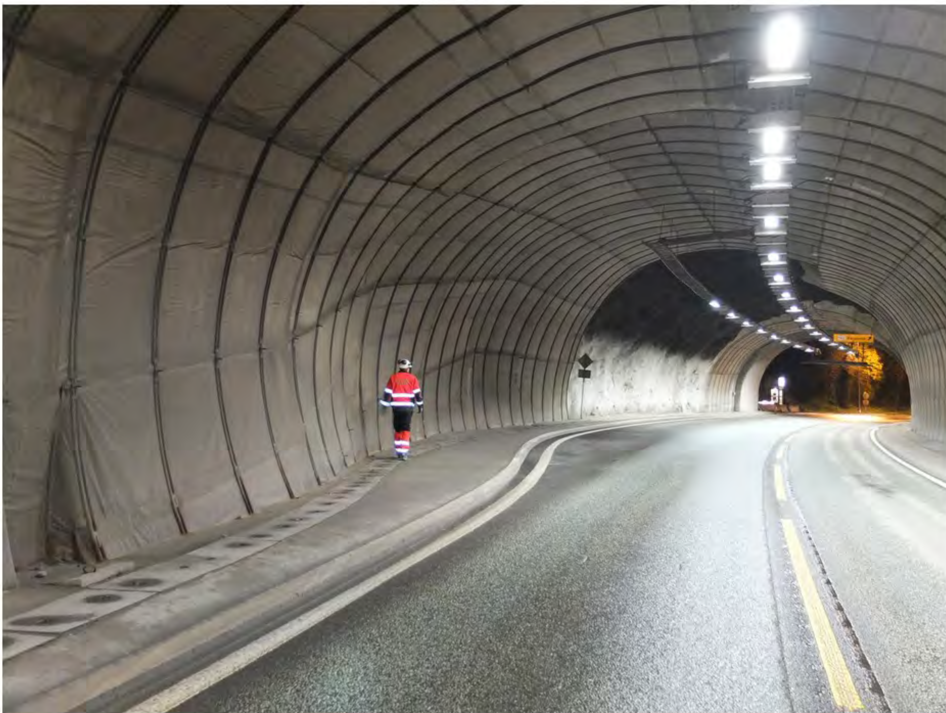
4 Tunnelkledning innenfor søndre portal
