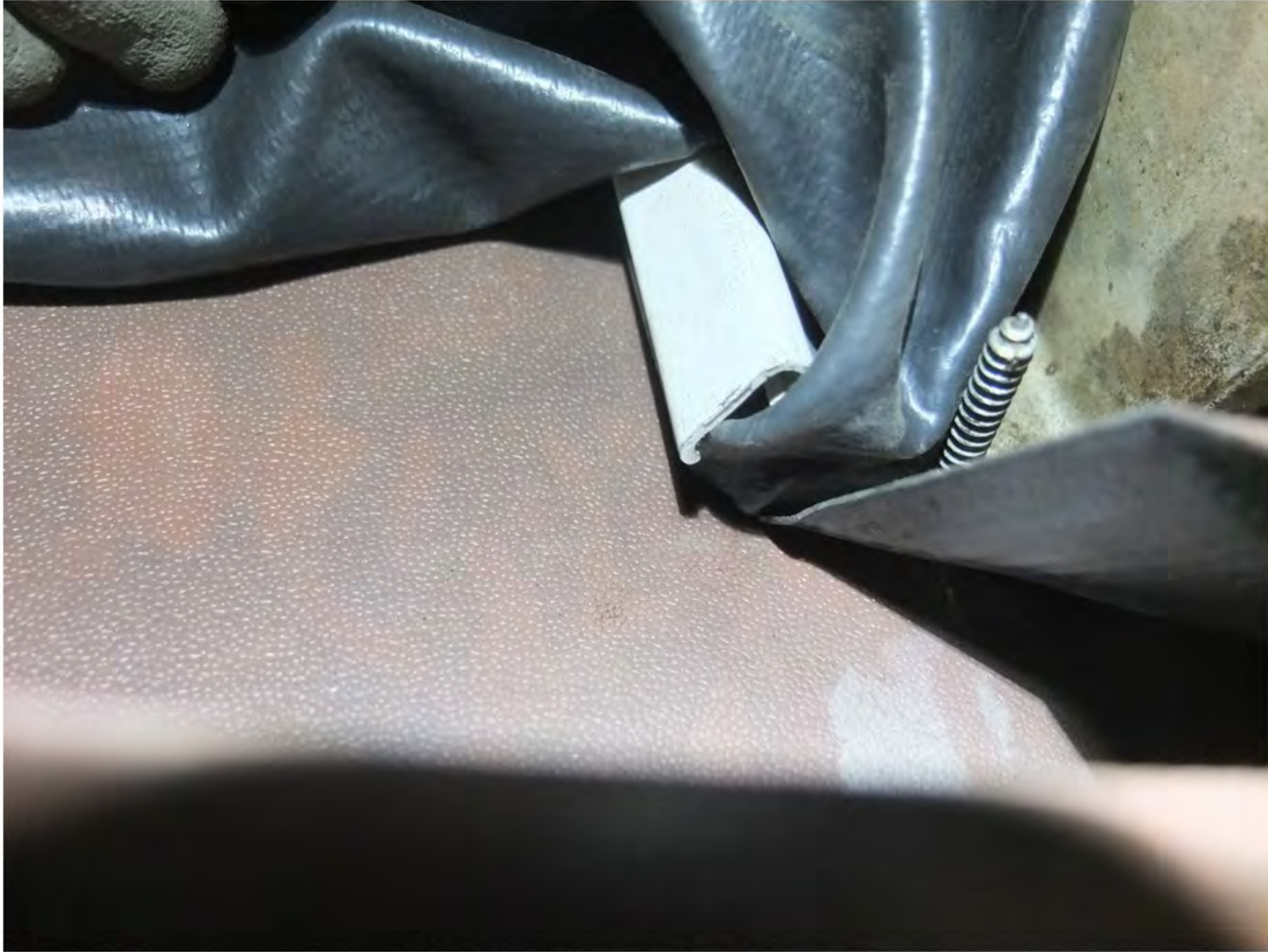
35 Klips for feste av membran til T-profilen
