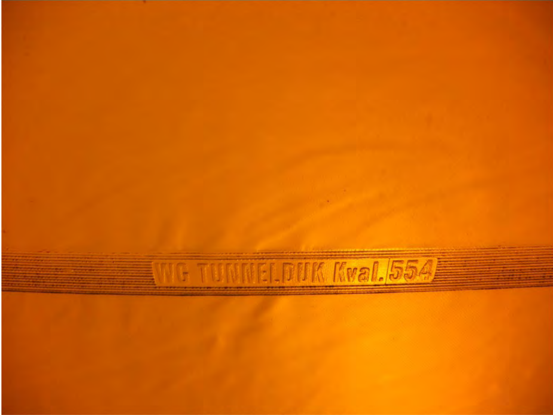
7 Tunnelduk type 554 østre seksjon
