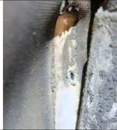
Foto 2.3.3. Hull i tunnelduk bak framrør
