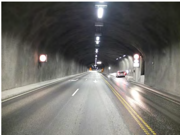
Foto 2.10.1. Oversiktsbilde Ellingsøytunnelen mot portal syd.
