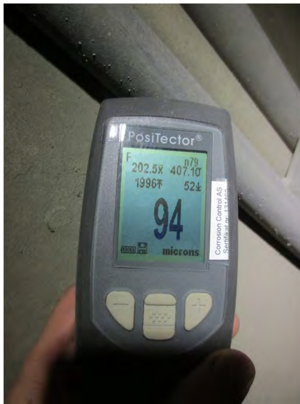
16 Vestre portal - Tykkelse varmforsinking på framrør
