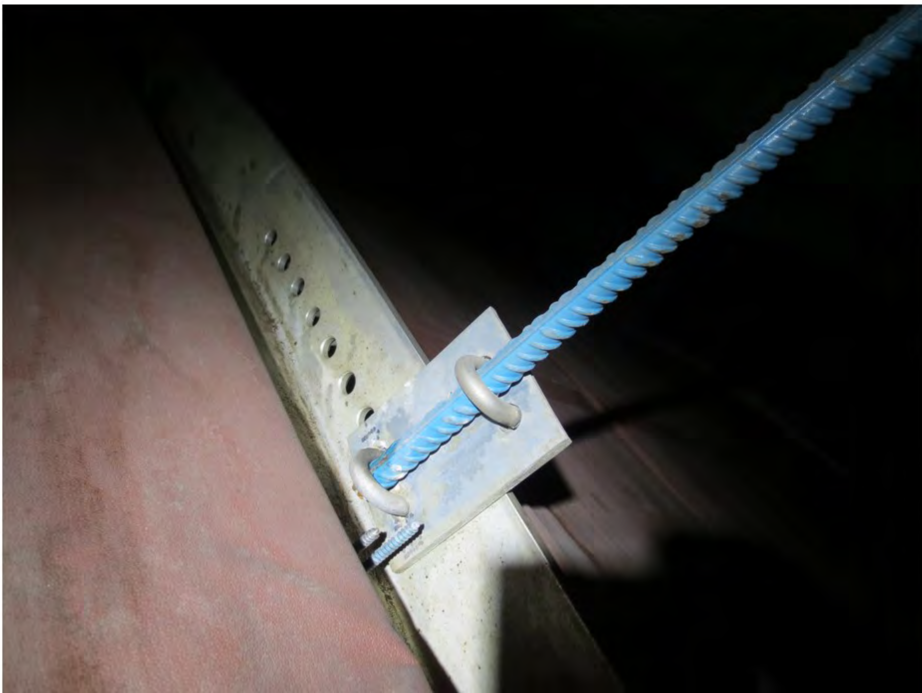
30 Detalj festebolt med innfestingsplate og U-klammer
