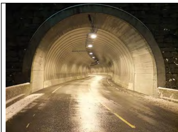
Foto 2.6.1 Oversikt Nattlandtunnelen. Duk type 554.
