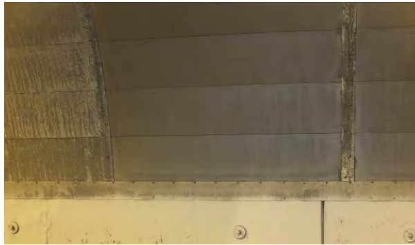
Foto 2.12.9. Felt med syrefaste platekassetter
