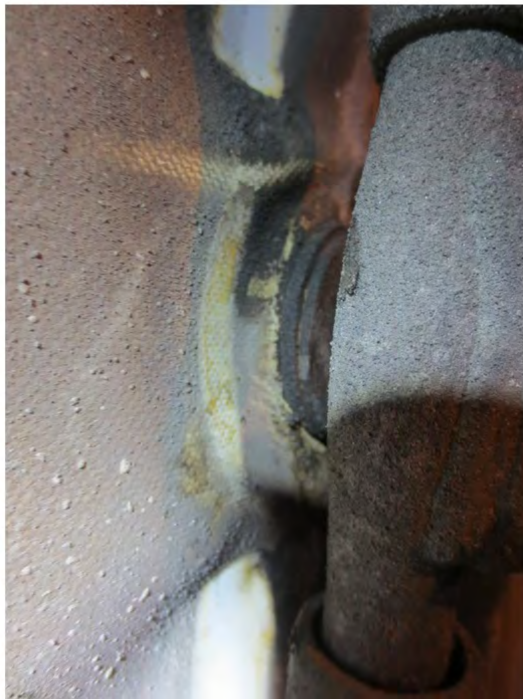
32 Svetting gjennom pakning
