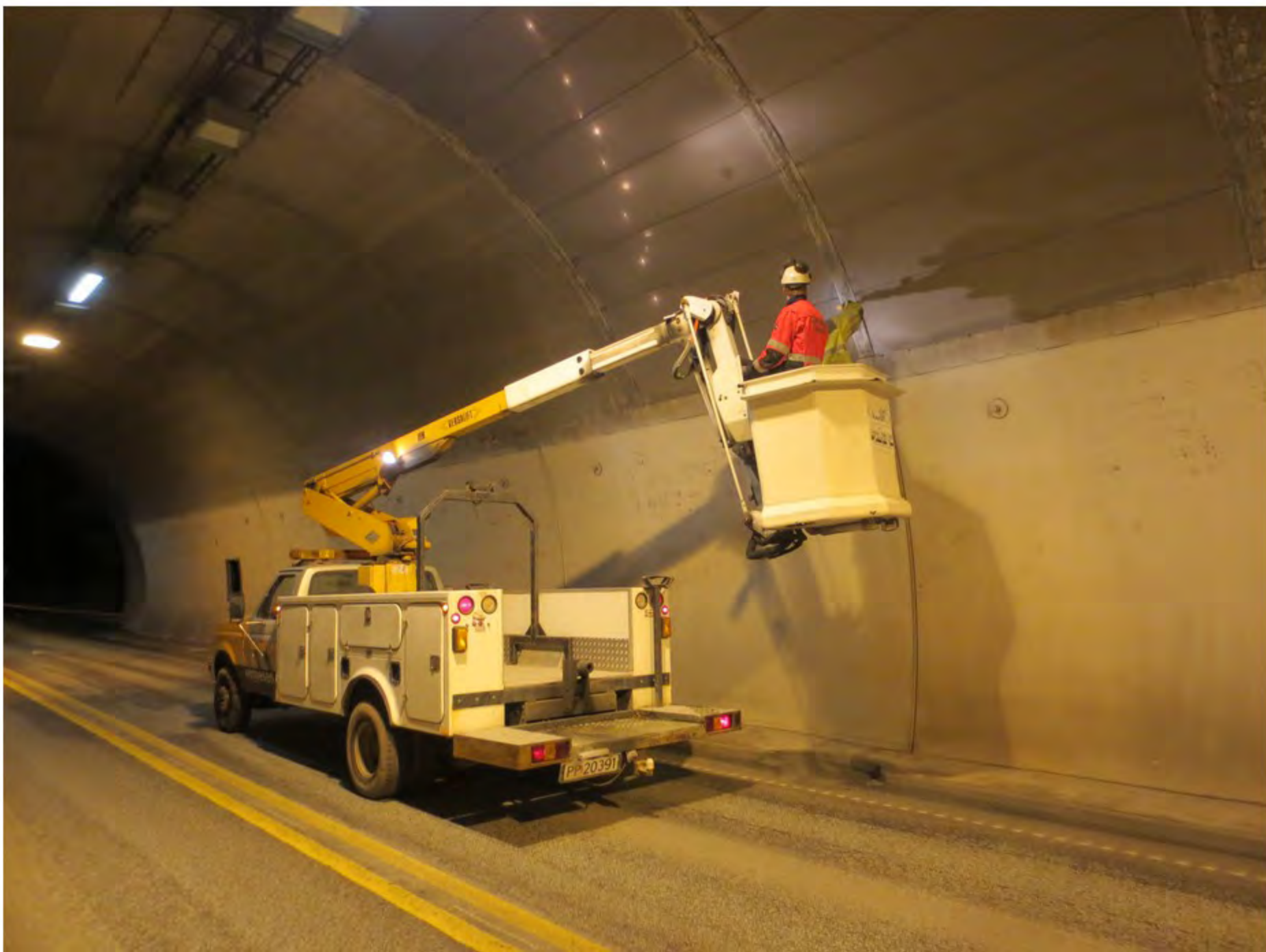
14 Inspeksjon av platefelt med lift
