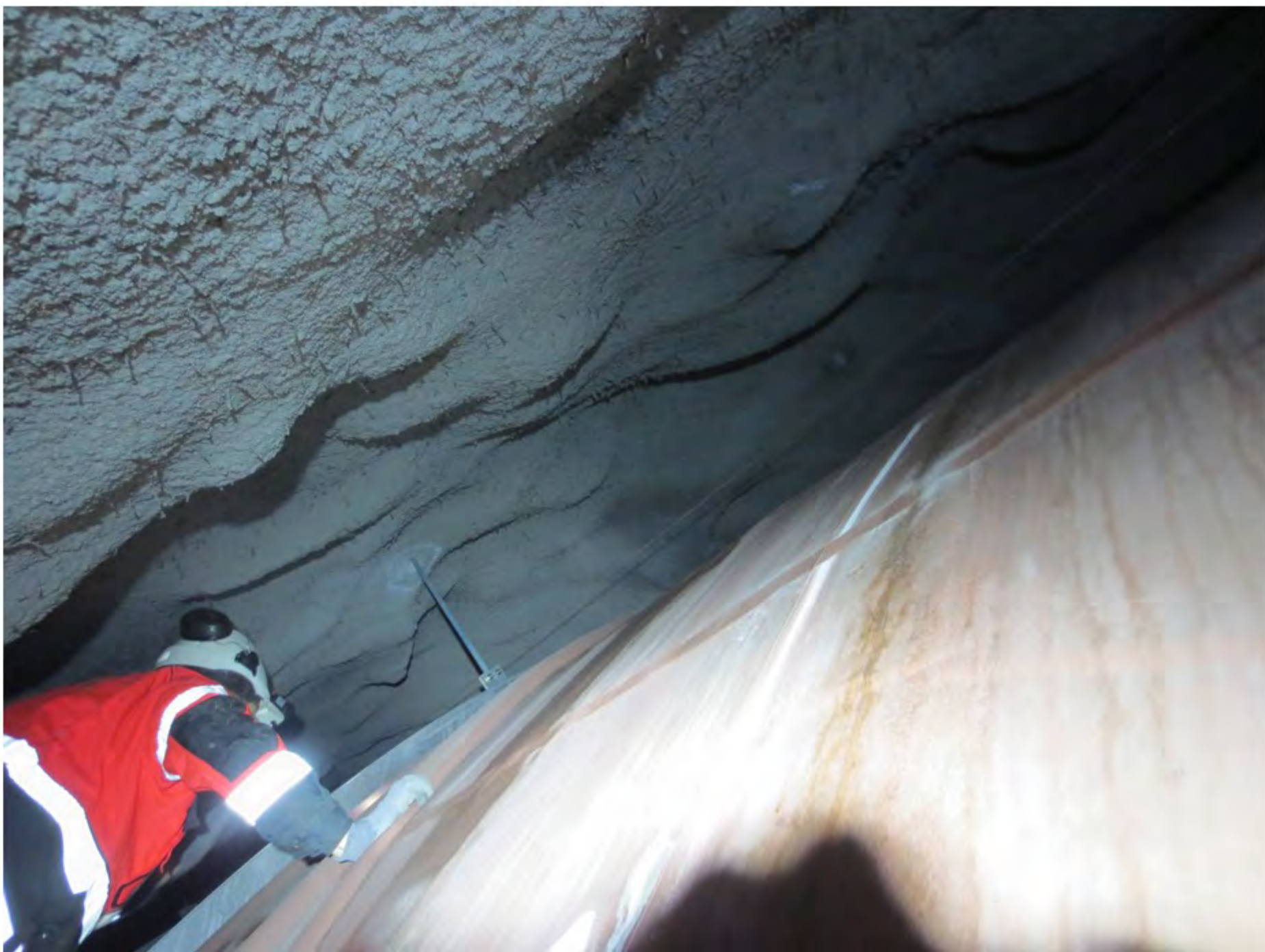
32 Generelt tørt miljø - Lite lekkasje gjennom bergsikring av sprøytebetong
