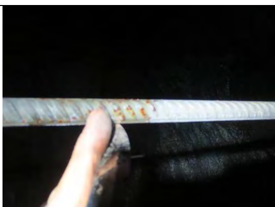
Foto 2.4.17. Punktkorrosjon på kammer på festebolt
