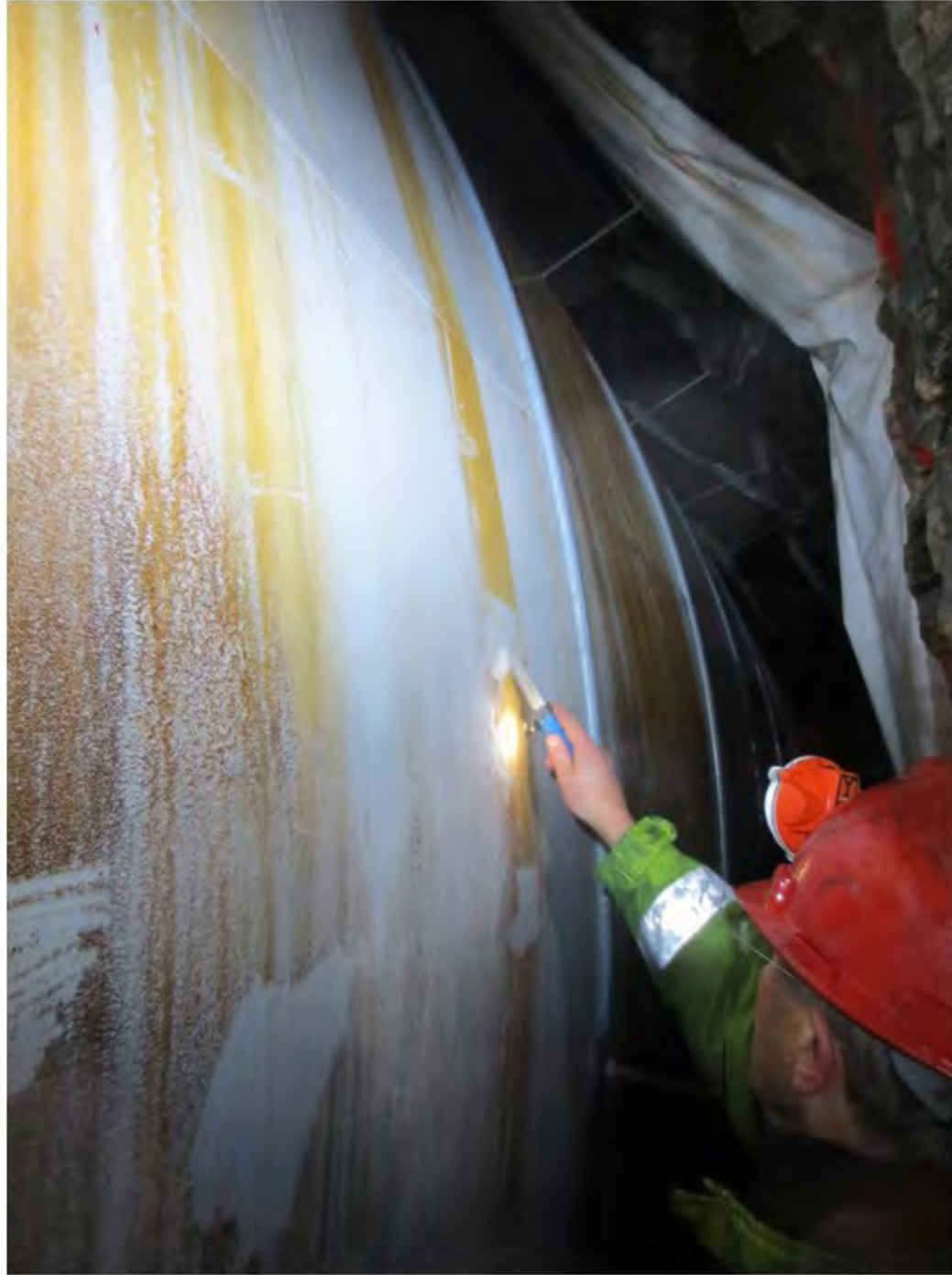
23 Profil 1300 - Fjerning av avleiringer og belegg på duk
