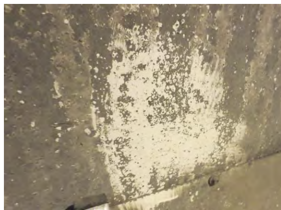
Foto 2.12.2. Skitt fjernet ved børsting og bruk av fille
