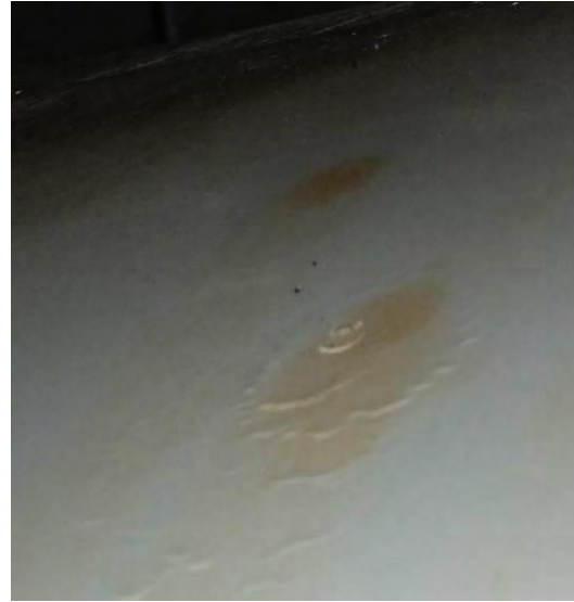
Foto 2.6.10. Samme sted på bergsiden av duken.
