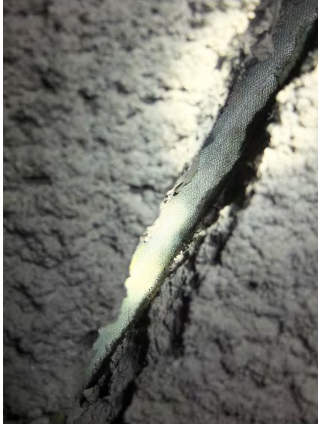
9 Synlig brandduk i dilatasjonsfuge
