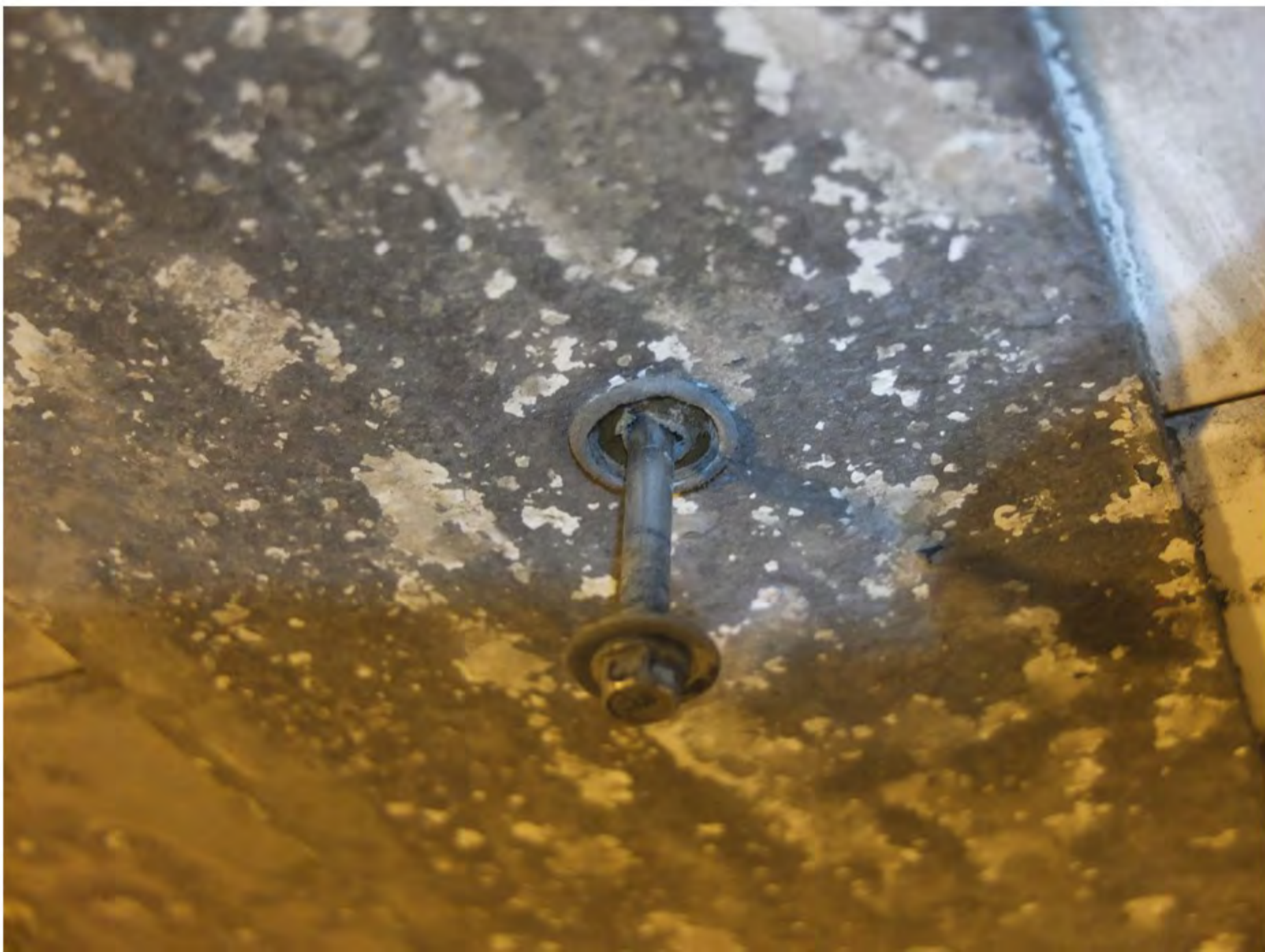
18 Syrefast skrue for innfesting av dekkbeslag OK
