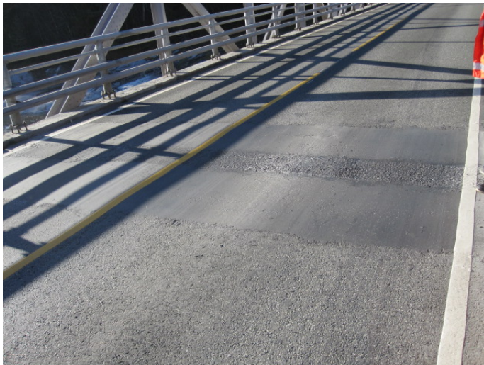
Figur 10 Vinnefuga fra Nederland på plass i Telemark (foto: Gaute Nordbotten)
