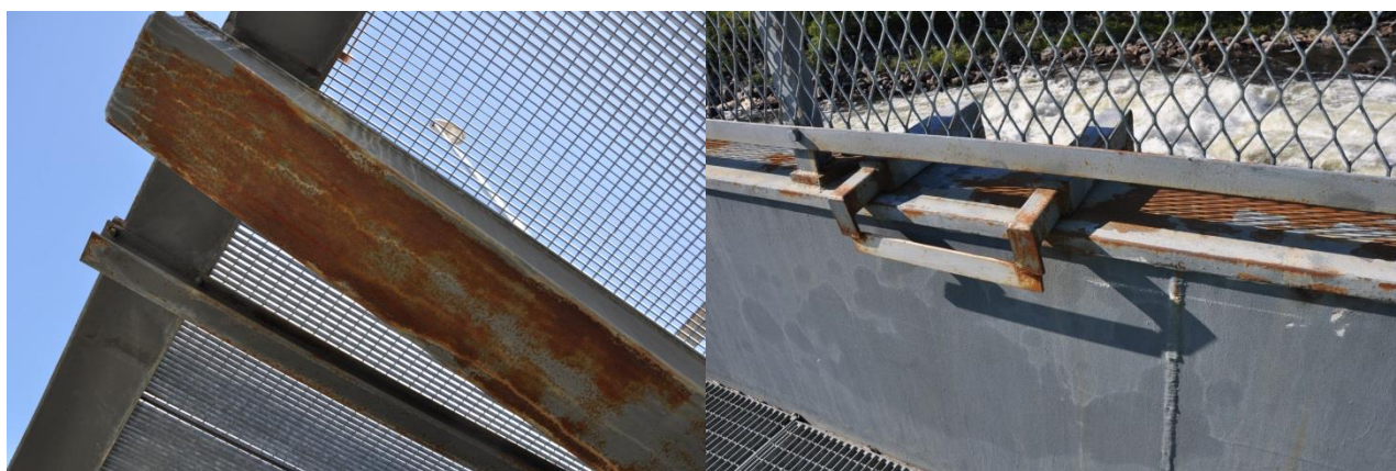
Figur 11. Nedbrytning av belegget på gang og sykkelbane på Neiden bru.
