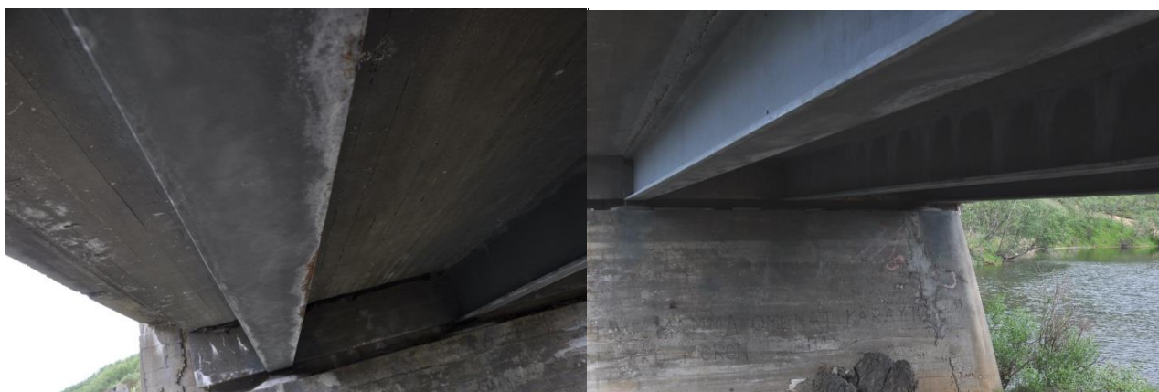
Figur 13. Beleggtilstand på Adamsfossen bru i 2013
