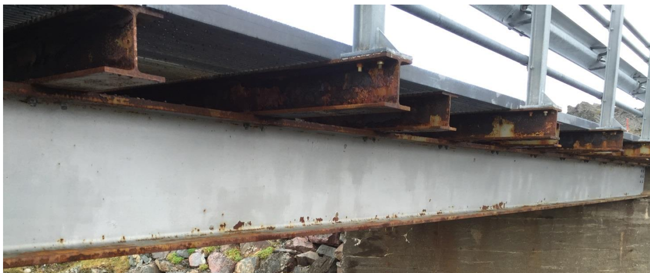
Figur 20. Beleggtilstand på Næringselv bru i 2015
