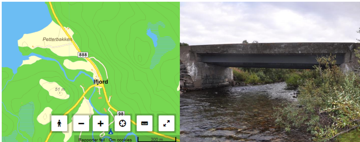
Figur 16. Plassering av Ifjord bru og oversiktsbilde
