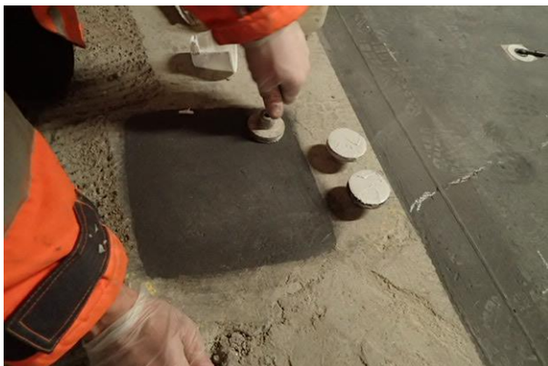
Figur 46 Feste av \varnothing 60 mm heftkopper til anoden ved bruk av to-komponent epoksy.
