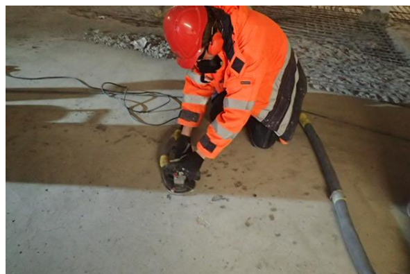
Figur 14 Diamantsliping av bitumenrester med vinkelsliper.
