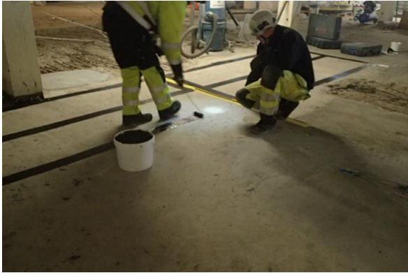
Figur 21 Påføring av anodemaling i striper der PDR-bånd senere skal limes.
