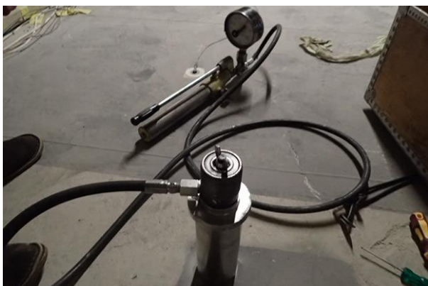
Figur 47 Montering av avtrekksutstyr for testing av heftfastheten til anoden.
