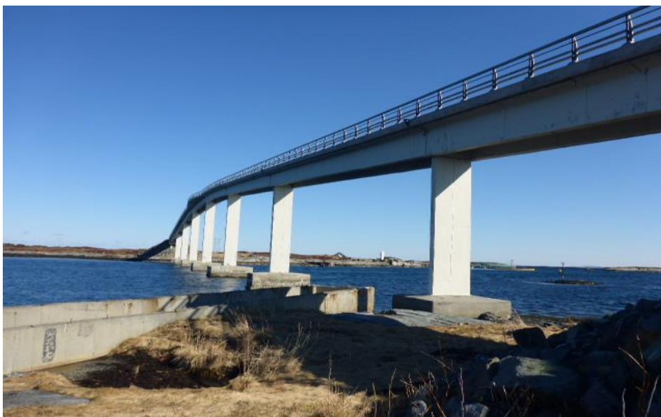
Figur 9 Verjeskiftbrua sett fra Hopen-siden mot Veiholmen
