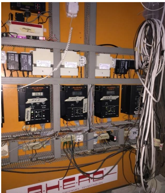
Figur 72 Skapet på Nerlandsøy-siden (akse 21). Strømforsyning til sone 1-4 + prøvefelt.
