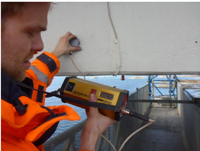
Figur 41 Måling av armeringsoverdekning og -plassering ved bruk av "Profometer 3"
