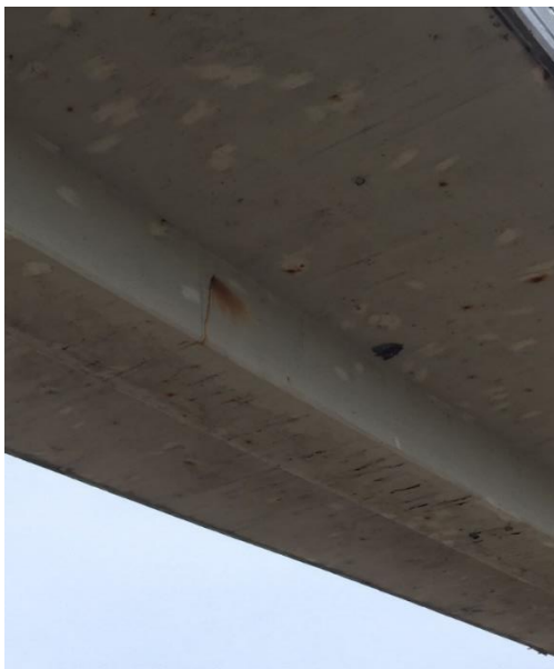
Figur 76. Brudrager og brudekke sett fra Remøy-siden. Riss på brukasse, avflassing og liten avskalling. Blokkeringer av jernbindertråd med noen nye rustutslag.
