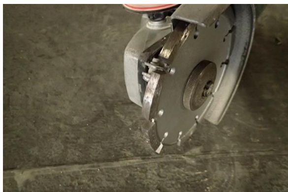
Figur 38 Måling av lokal strømgjennomgang. Isolering av anode ved slissing med vinkelsliper med tykt blad
