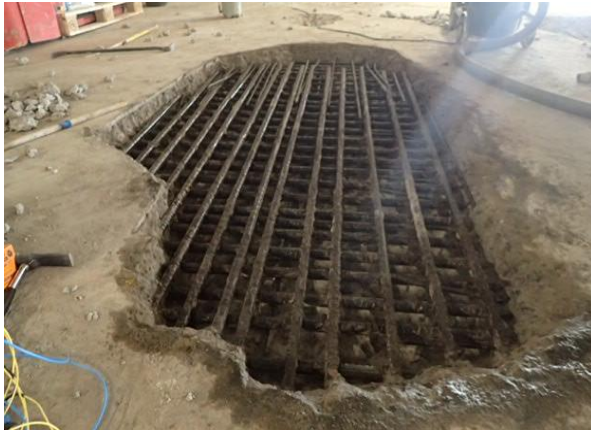
Figur 19 Meislet og forvannet reparasjon i felt 1
