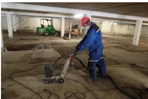
Figur 13 Forbehandling. Sliping av betongoverflaten
