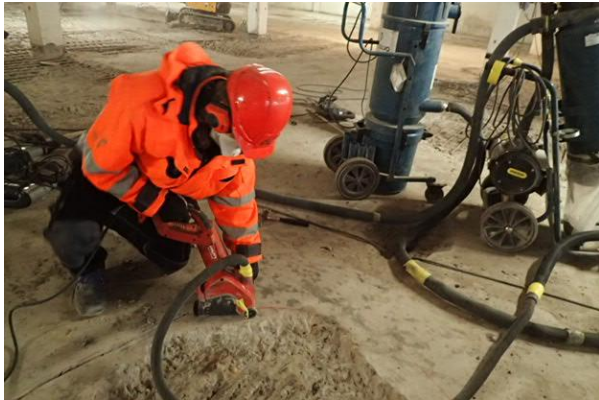
Figur 15 Avgrensning av skader ved å slisse før meisling
