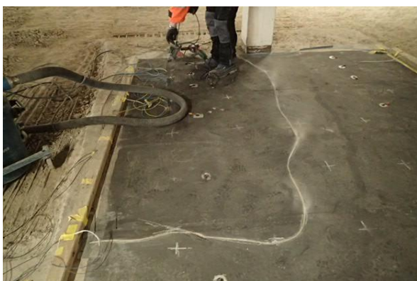
Figur 39 Isolering av reparasjon A i felt 1 for måling av strømgjennomgang.
