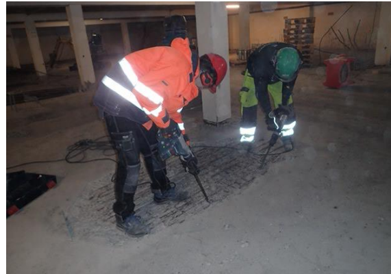
Figur 16 Håndmeisling av større skade i felt 1
