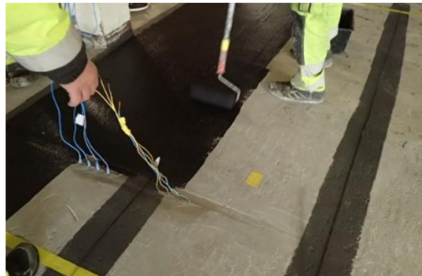
Figur 23 Enhetlig påføring av anode etter montering av PDR-bånd
