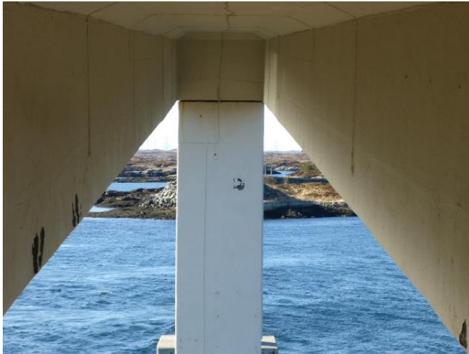
Figur 83 Fra styreskap i akse 9 mot pilar akse 8.
