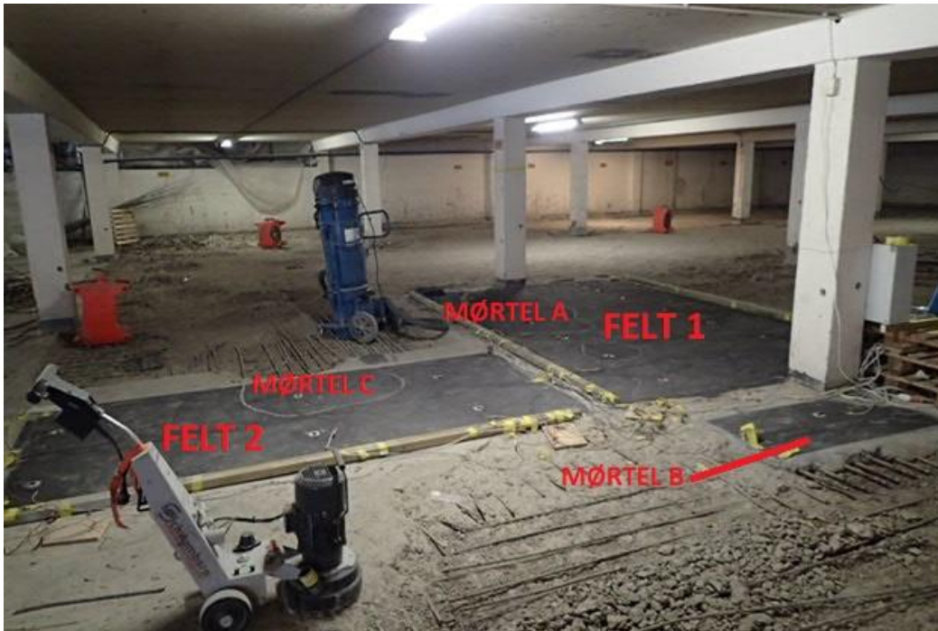
Figur 31 Foto av prøvefelt og reparasjonsmørtlene
