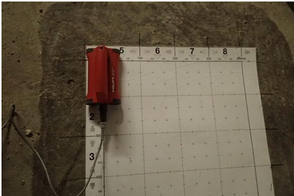
Figur 40 «HILTI FS 10» plassert på rutenett for skanning av overflaten (armeringsoverdekning og plassering).
