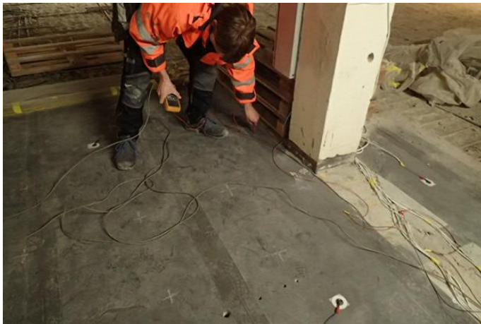
Figur 45 Spenningsfall i anode ut fra PDR-bånd målt med multimeter i etablert rutenett.
