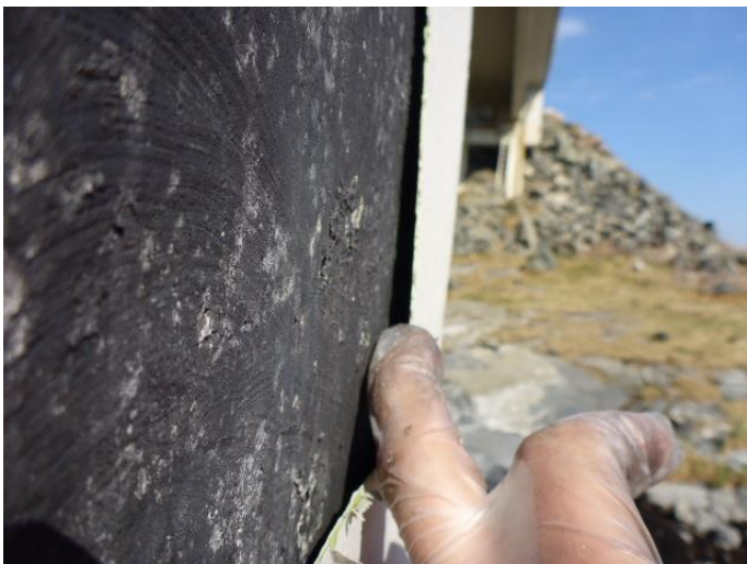
Figur 91 Rent heftbrudd mellom epoksy og primer (AHEAD Multiprimer). Pilar akse 8, cirka 1,8 m OK fundament.
