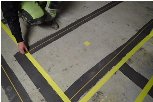
Figur 22 Montering av dobbeltsidig tape for feste av PDR-bånd til påført anodestripe
