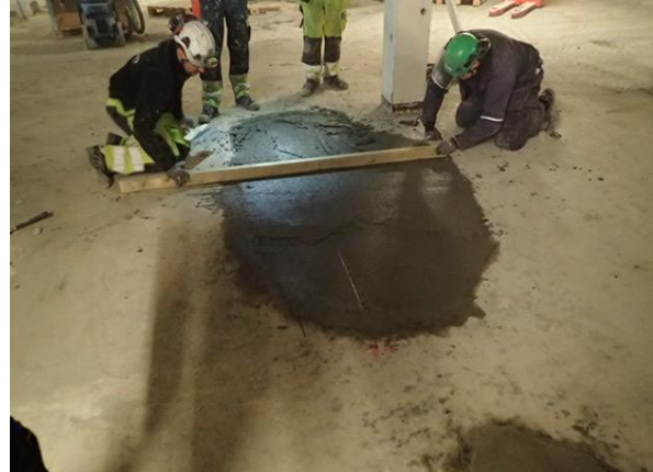
Figur 20 Mørtlet og filset reparasjon i felt 1.
