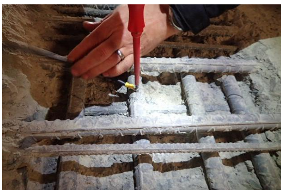
Figur 27 Etablering av armeringskontakt
