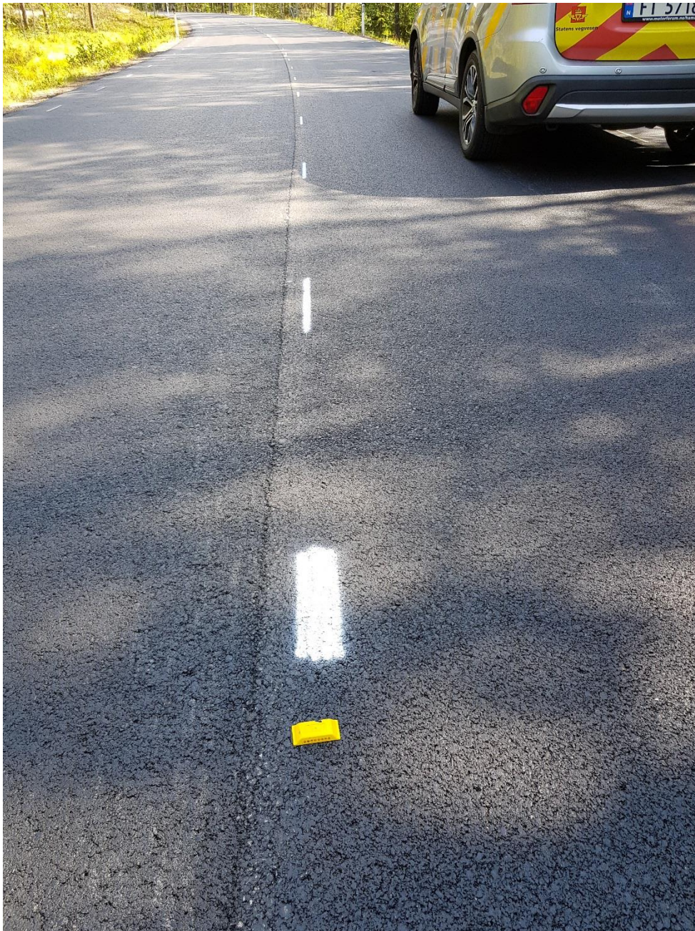
Figur 8.2: Eksempel på bruk av midlertidige reflektorer
