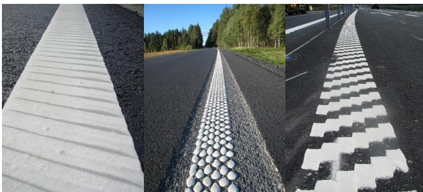
Figur 6.7: Eksempler på profilerte linjetyper som har forbedret lysreflekterende egenskap i våt tilstand
