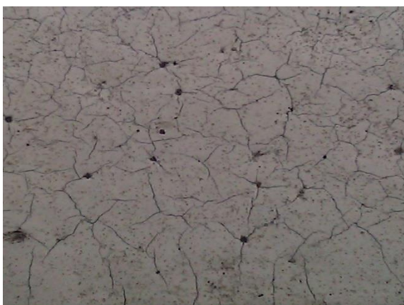
Figur 6.27: Når drop-on-glass blir liggende for lavt i linjeoverflaten vil overflaten ha større tendens til å krakelere
