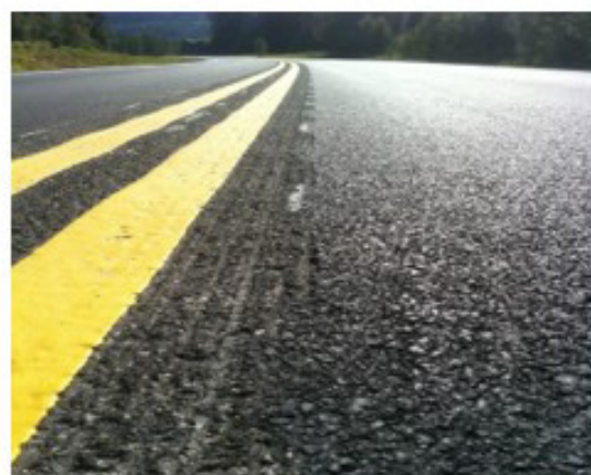
Forsterket midtopmerking med plan linje i nedfrest sinusrille
