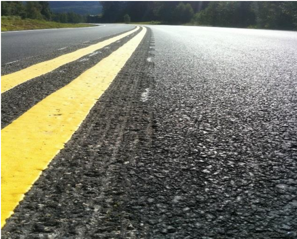
Figur 1.4: Langsgående vegoppmerking lagt ned i et fresespor
