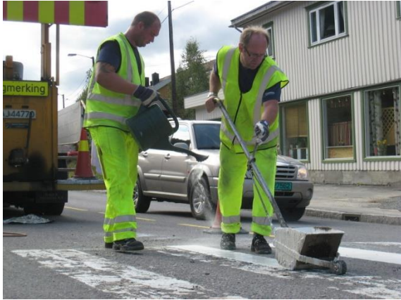
Figur 7.22: Glasspåføring på tverrgående oppmerking ved hjelp av hagesprøyte
