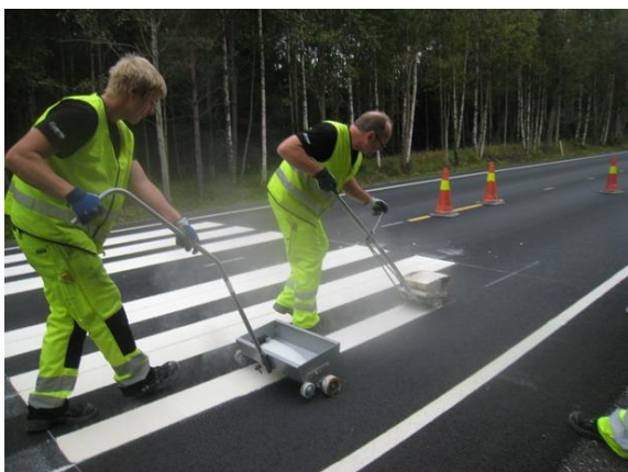
Figur 7.4: Håndlegging med skope med etterfølgende glasspåføring
