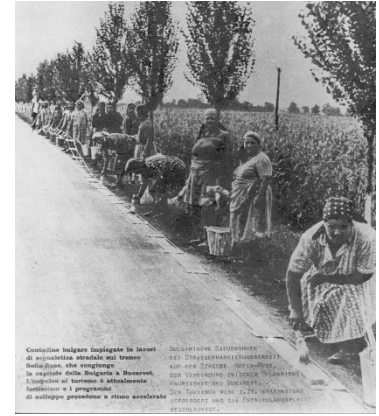
Figur 7.1: Eksempler på manuelt utført vegoppmerking, Dead Man's Curve i Michigan USA i 1917, håndlegging med slepesko i Sverige på 1950-tallet og maling av stiplet kantlinje i Bulgaria, også på 50-tallet
