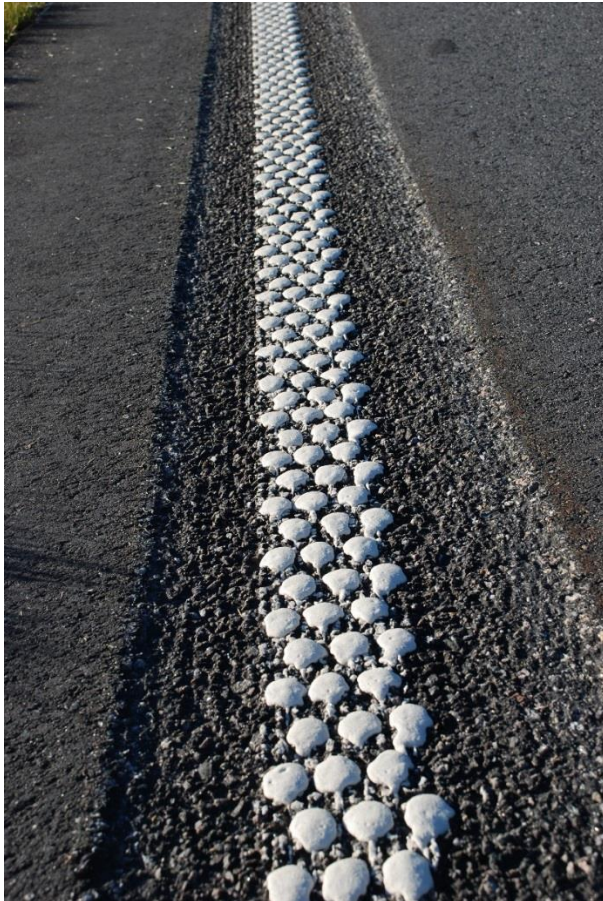
Figur 3.8: Profilert kantlinje type II lagt i plant nedfrest spor – dråpeflex (alternativ 3)
