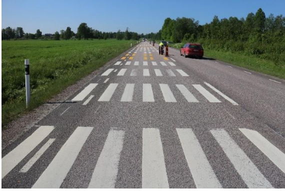
Figur 6.21: Nordisk prøvefelt i Sunne i Sverige etter første vinter. Enkelte av materialene har fått kraftig slitasje i hjulsporene.
