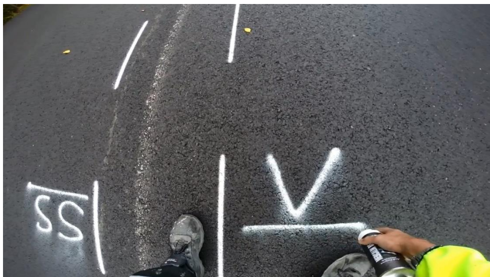
Figur 8.7 Eksempel på koding av midtlinje
