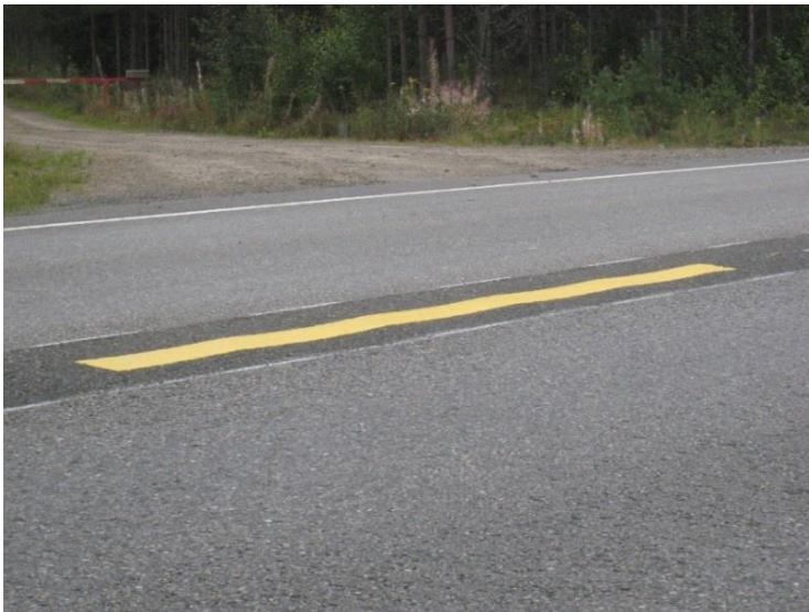
Figur 3.5: Forsterket midtoppmerking med plan linje i sinusrille (alternativ 2)
