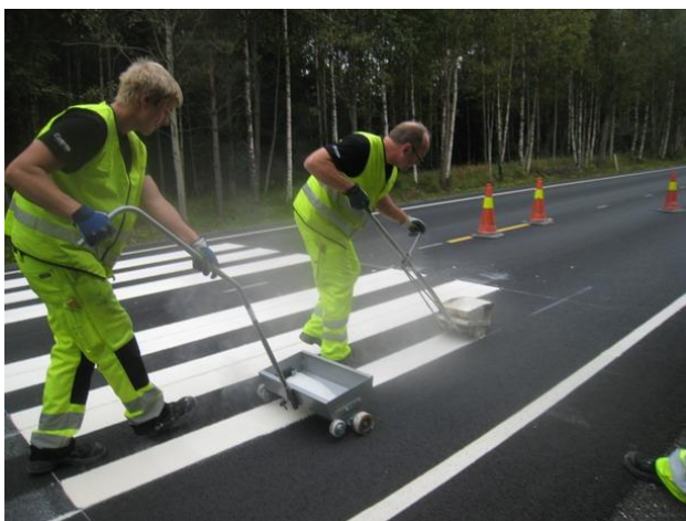
Figur 10.1: Manuell oppmerking av gangfelt
