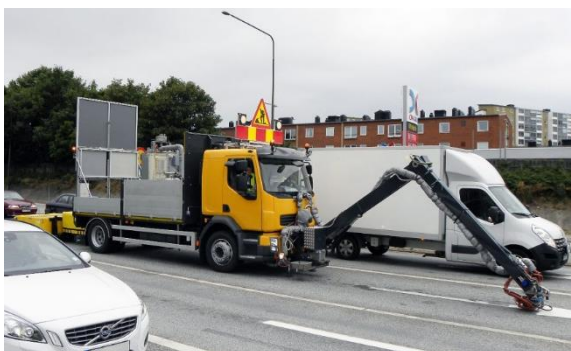
Figur 7.5: Maskinell applisering av tverrgående oppmerking
