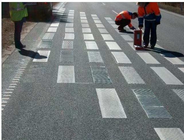
Figur 6.8: Profilerte linjer kan oppfattes mørkere i motlys fordi man observerer skyggesiden av linjeprofilen
