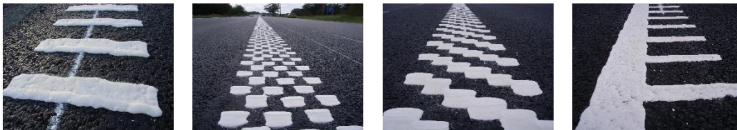
Figur 7.18: Utvalg av linjetyper som kan produseres med ekstruderingssko og tilhørende styringsboks (longflex, sjakkmønster, trappflex, kamflex)
