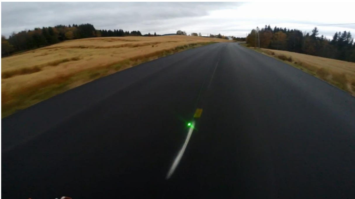
Figur 8.10: Eksempel på bruk av lasersikte ved formerking
