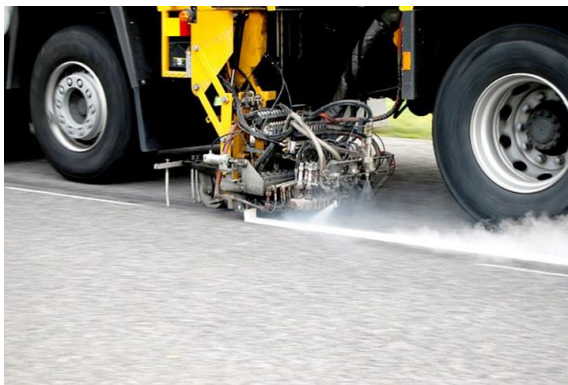
Figur 7.14: Ekstruderingssko på utleggerenhet
