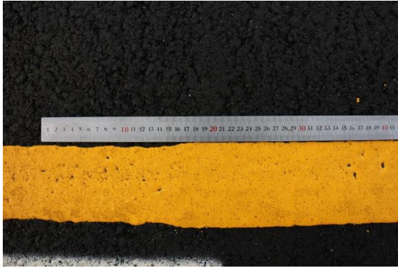
Figur 7.19 Redusert linjebredde fra 10 cm til 9 cm ved åpning av ekstra klaffesett når det appliseres kombinasjonslinjer
