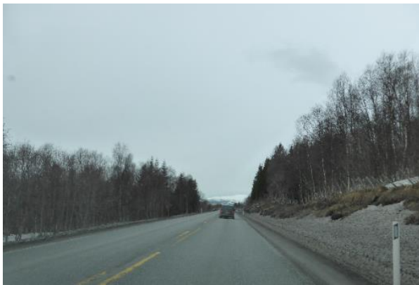
Stor slitasje på langsgående kant – og midtlinjer
