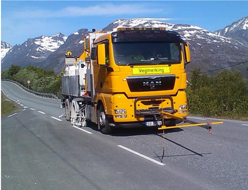
Figur 2.2: Utlegging av vannbasert maling
