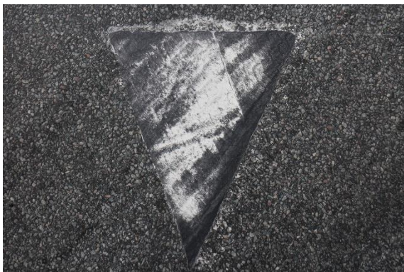
Figur 6.31: Eksempel på sverting på nylagt oppmerking
