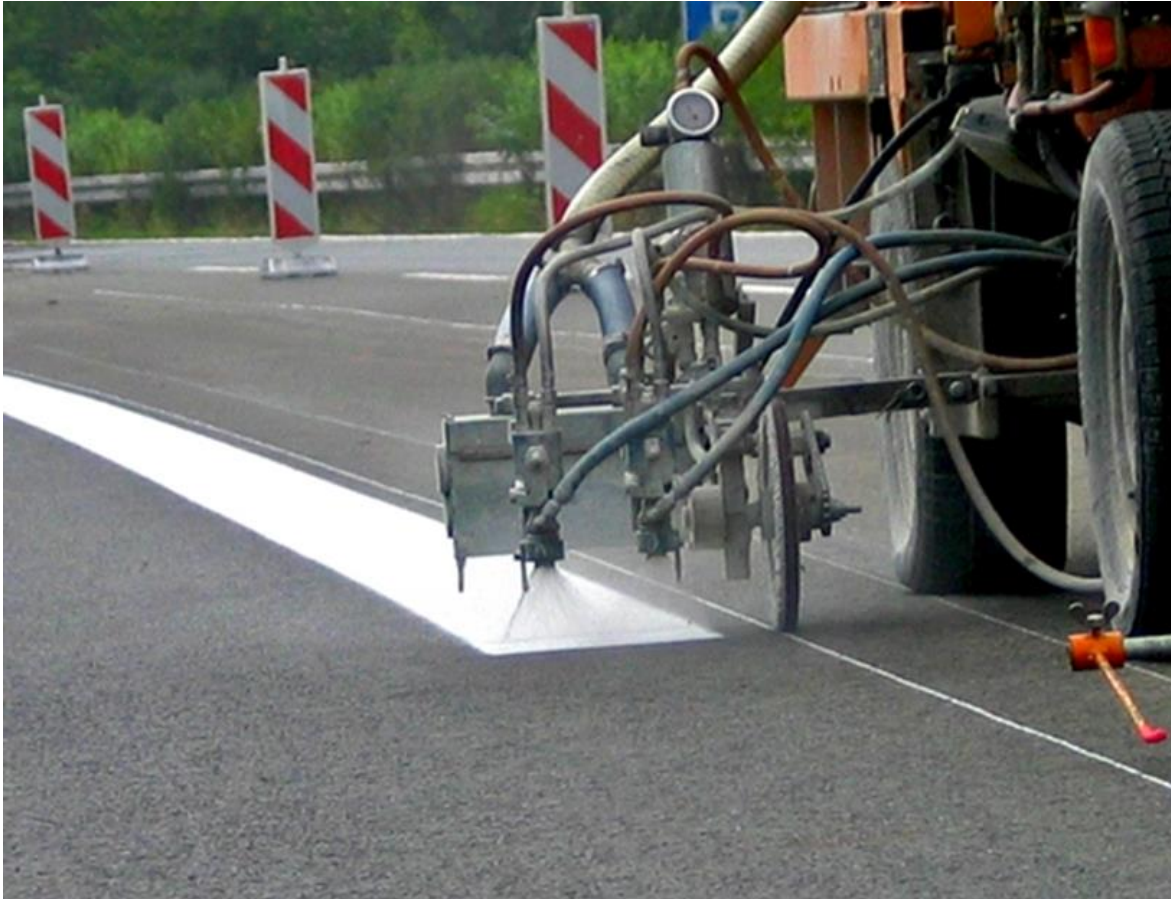
Figur 2.3: Utlegging av sprayet termoplast
