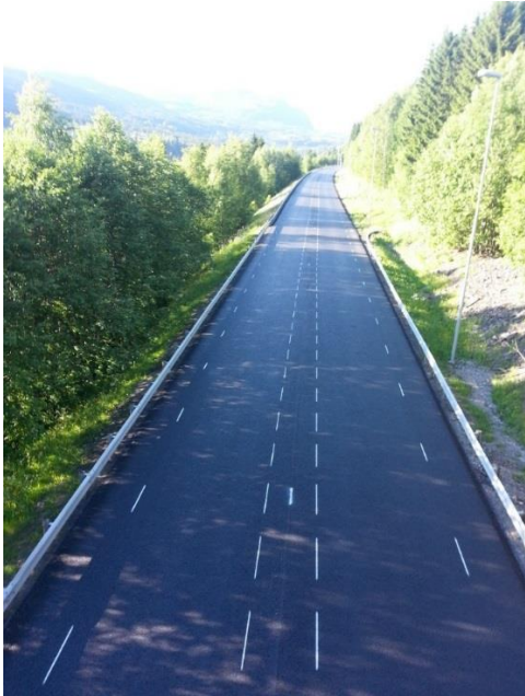
Figur 8.4: Formerking før utførelse av fresing av sinusriller med bredde 1 m for forsterket midtoppmerking og tradisjonell kantoppmerking
