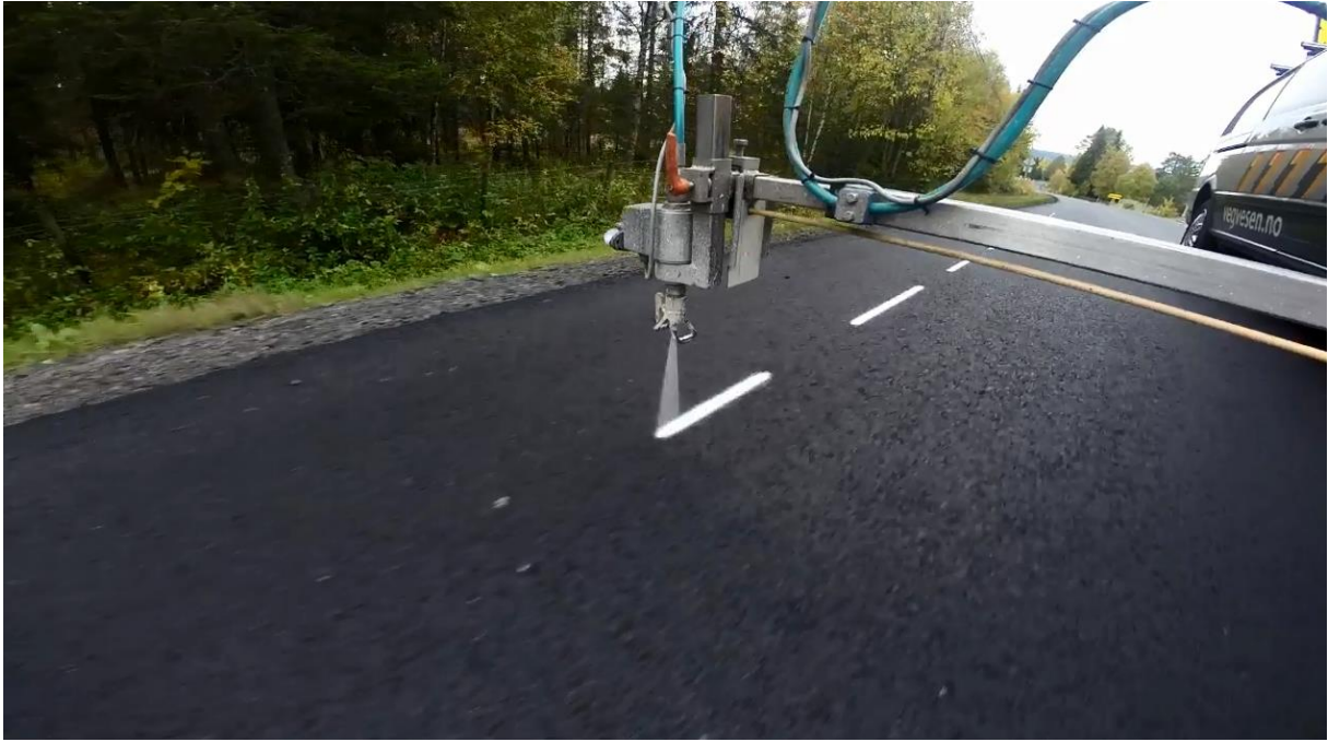
Figur 8.6: Eksempel på formerking før fresing av spor for nedfrest kantlinje
