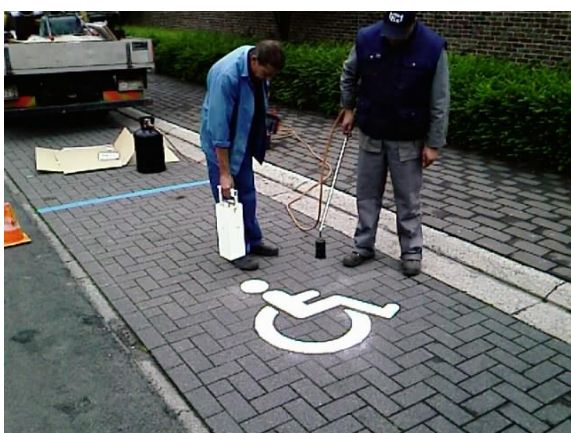
Figur 7.6: Applisering av prefabrikkert HC-symbol ved hjelp av gassbrenner. Drop-on-glass påføres manuelt med egen glassdispenser.
