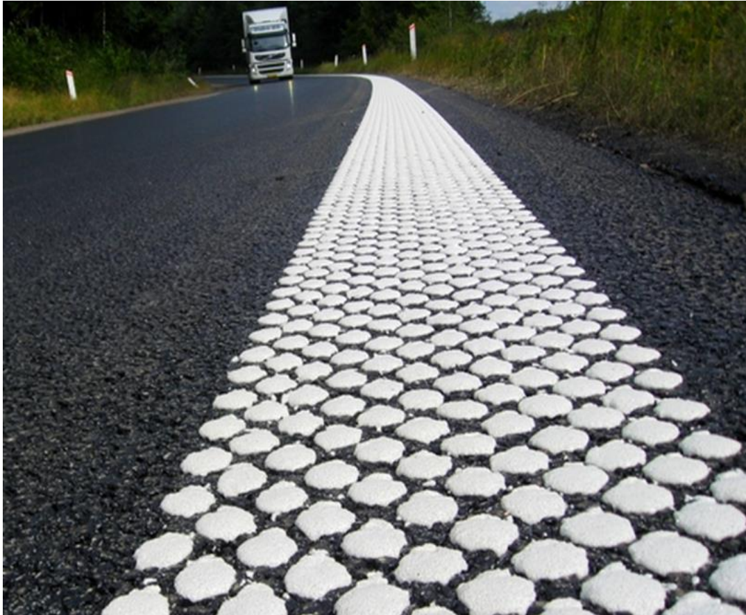
Figur 2.5: Eksempel på profilert kantlinje. Her i typen Dråpeflex. Fra øyehøyde i en personbil ser linjen sammenhengende ut fremover.
