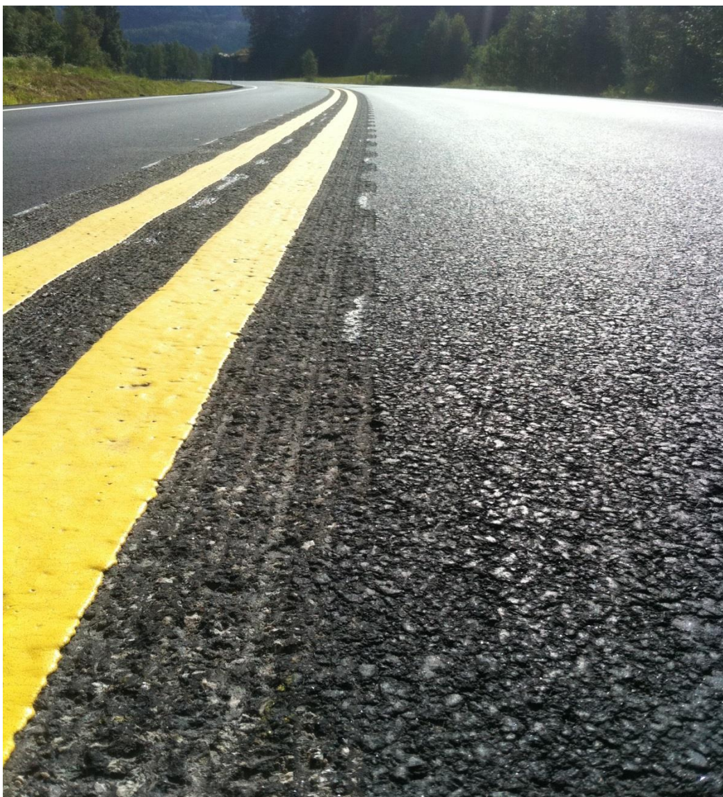
Figur 2.6: Forsterket midtoppmerking. Dobbel plan sperrelinje lagt i nedfrest sinusrille.
