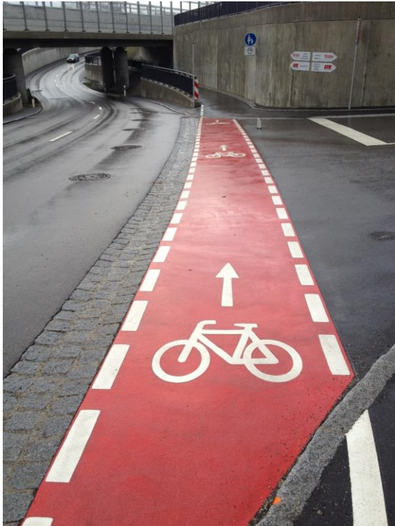
Figur 6.19: Eksempler på bruk av 2-komponent materiale til sykkelfelt (eksempel fra Sverige)
