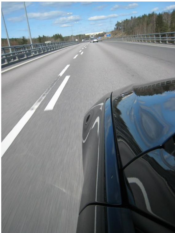
Figur 7.20: Typisk slitasjemønster på kombinasjonslinjer ved feil på ekstruderutstyret
