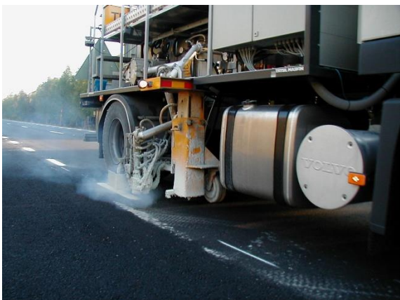
Figur 7.10: Spraypistol på utleggerenhet; noe røyk kan forekomme
