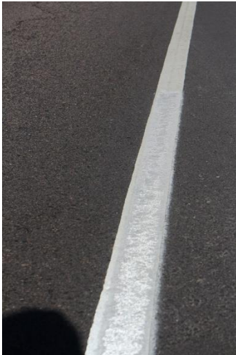
Figur 6.32: Uensartet spraybilde, linjen er tynn i kanten og tykkere på midten. Drop-on-glasset har allerede løsnet fra kanten av linjen.
