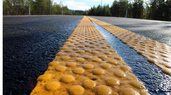
Figur 7.17: Dråpekombi produsert med Multiapplicator fra Trysil Maskin AS
