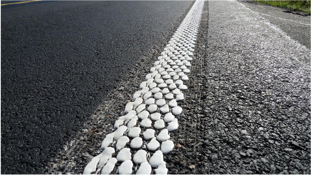
Figur 1.6: Vegoppmerking dråpeflex i plant fresespor
