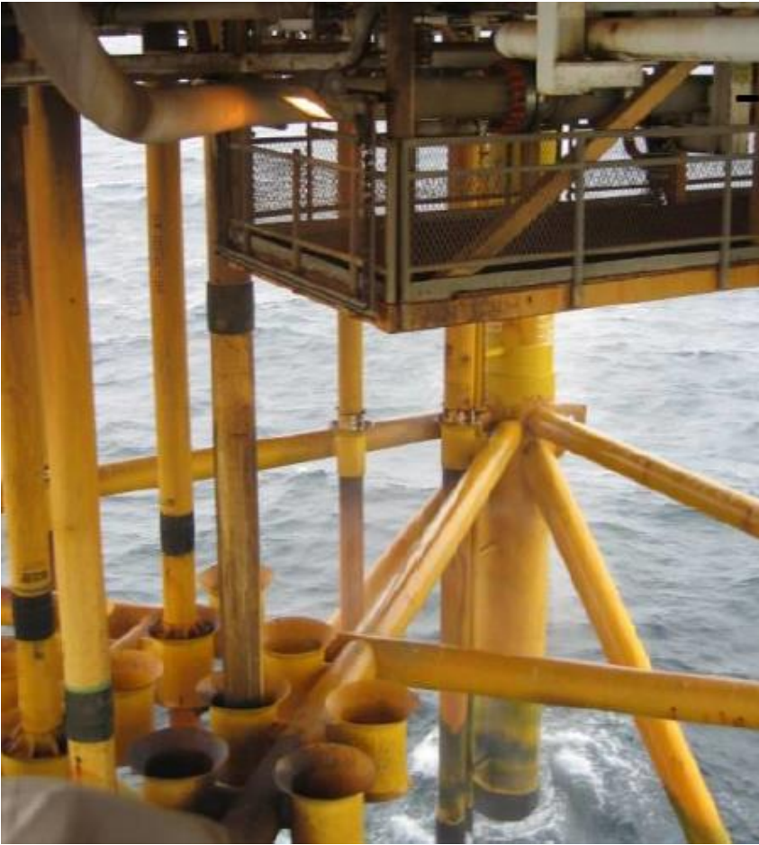
Figur 11. Glassflak polyester i plaskesona på offshore plattform med over 20 års levetid.
