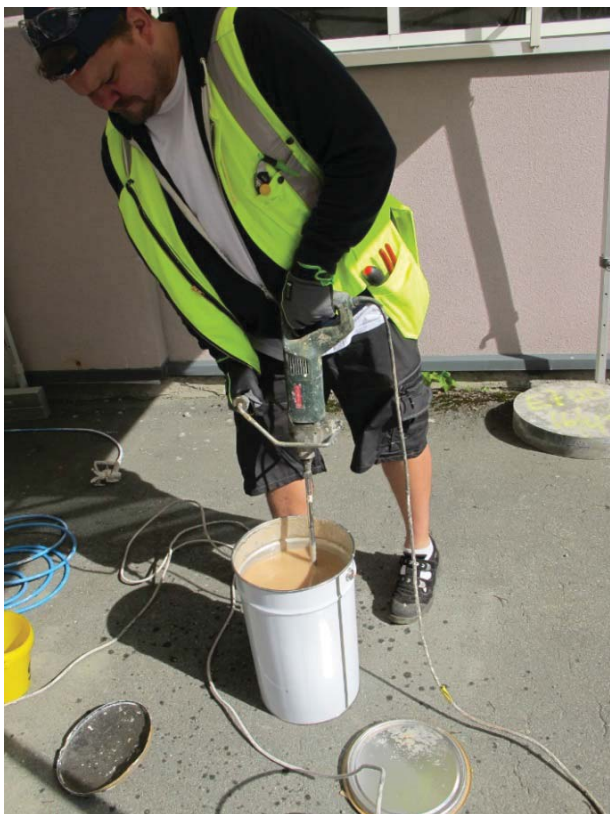
Omrøring av StoCryl HG 200 i spannet
