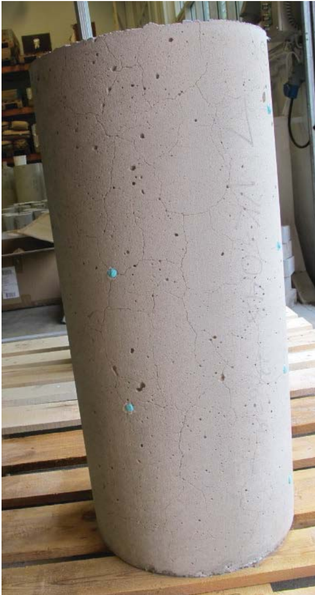
Forbehandlet overflate – porer og riss åpnet. Riss typisk målt fra 0,1-0,4 mm
