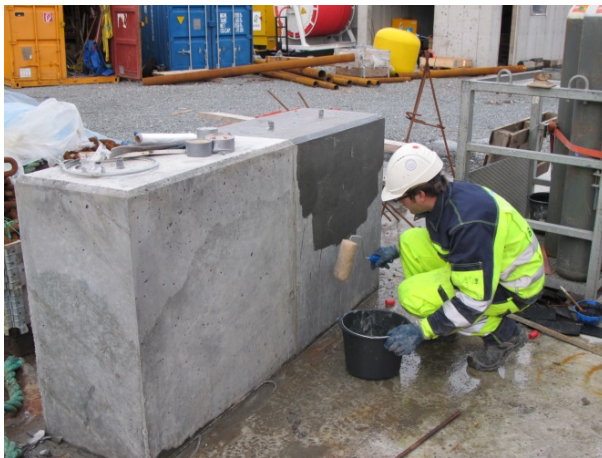
Figur 25 Påføring StoCryl HG 200, Philpp Schlenk, Bilfinger. Dette ble gjort uten tildekning av tilstøtende referansehalvdel.
