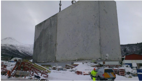
Figur 43 Stort element hentes på Skorgeneset 9/12-13. Flate B: Ubehandlet del til venstre, StoCryl HG 200 til høyre (foto: Martin Gedra)
