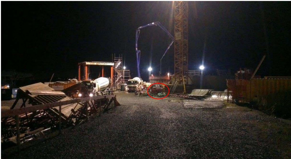
Figur 15 Anleggsstedet Skorgeneset, støping av stort element (rød ring) (foto: Martin Gedra)
