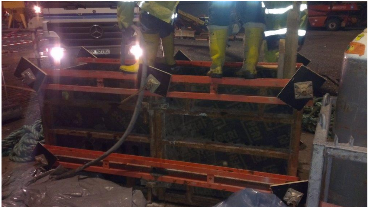
Figur 18 Utstøping og vibrering av betongen i det store elementet (foto: Martin Gedra).
