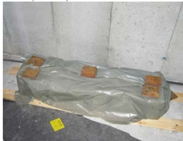
Figur 40 Uoppvarmet sveisebod – impregnerte elementer tildekket 4/12 (foto: Philipp Schlenk)
