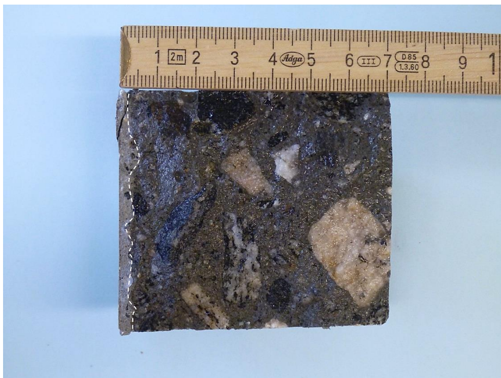
Kerne 4-S-4 – Til venstre ses den eksponerede overflade, mod højre ses den fræ- sede overflade. Den imprægnerede del (de yderste mm fra venstre) fremstår lysere end den øvrige del af kernen.
