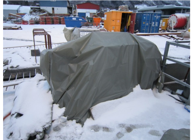
Figur 30 Hele elementet ble tildekket dagen etter påføring (3/12) (foto: Philipp Schlenk)
