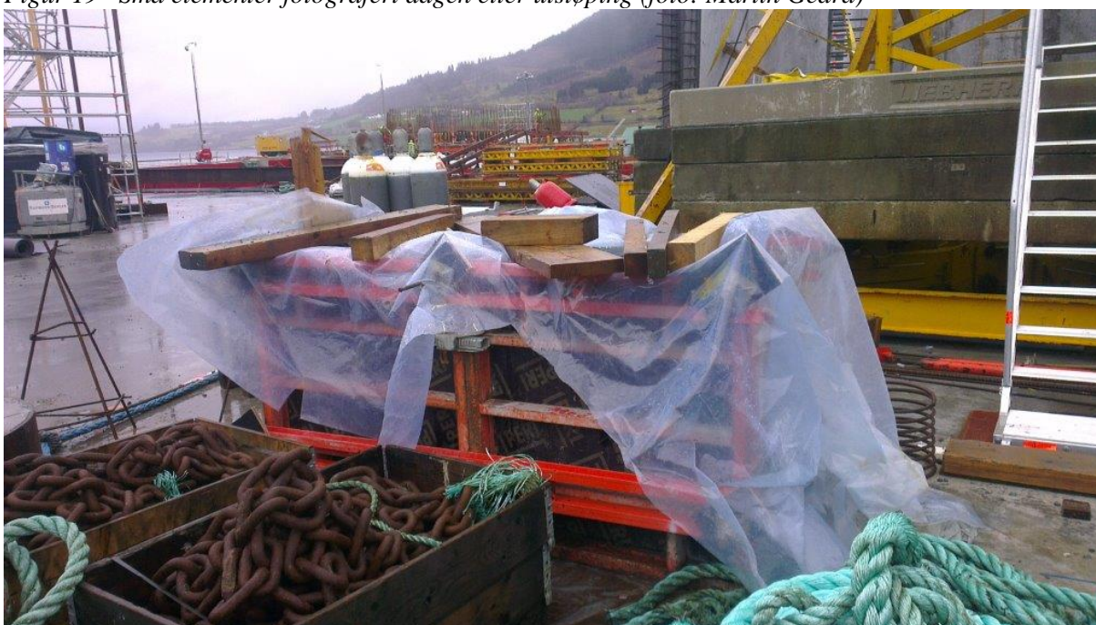
Figur 20 Stort element fotografert dagen etter utstøping (foto: Martin Gedra)
