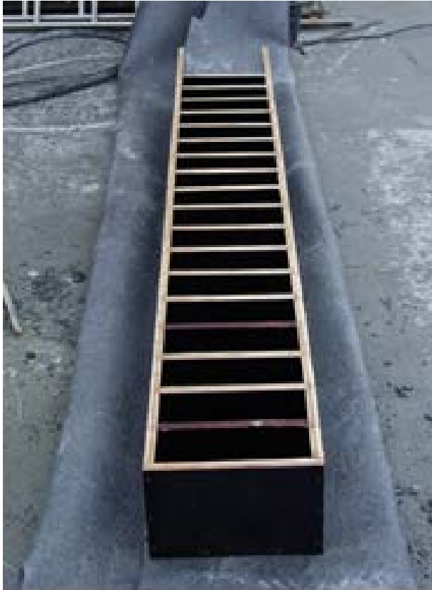
Figur 16 Forskaling små elementer, på isolerende underlag (foto: Lise Bathen)
