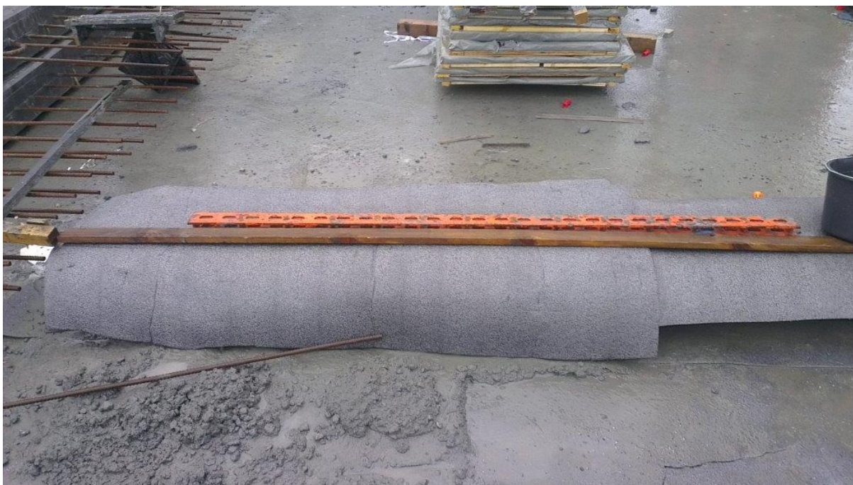
Figur 19 Små elementer fotografert dagen etter utstøping (foto: Martin Gedra)
