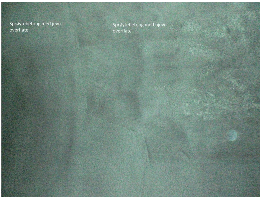
Bilde 3 Sprøytebetong påført direkte på berg ved profil 6
