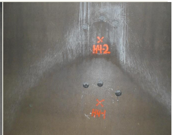
Profil 4. H4-4 er den mørke sprøytebetongen.
