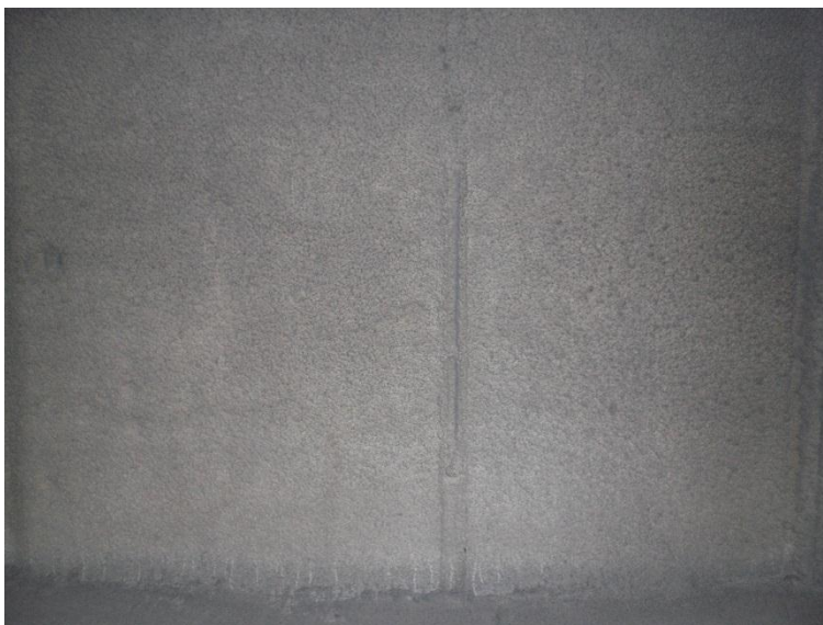
Bilde 2 Armering vises bak tynt lag med sprøytebetong ved profil 5
