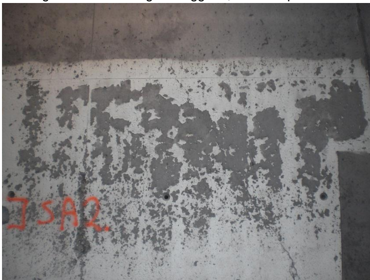
Bilde 10 Avflassing fra vegg i profil A
