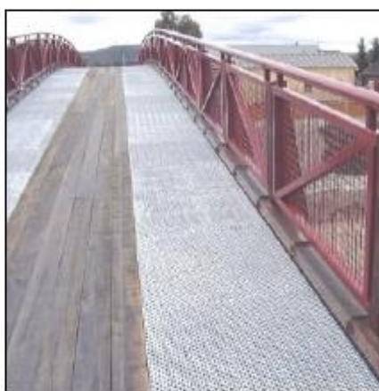
Figur 7-17: Brudekke med innlagte stålrister på Hanskemaker gs-bru
