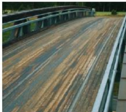
Figur 7-16: Skubbersenga bru med slitalag av kreosotimpregnert plank og med stål brøyteavvisere
