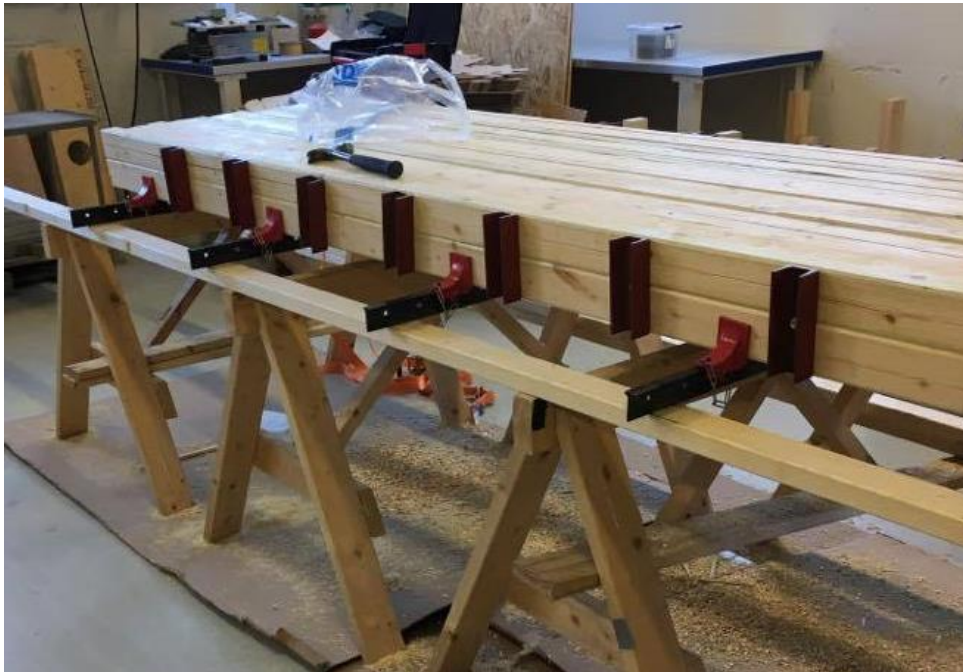
Figur 3.4: Dekket med gjengestenger, ankerplater og mutre
