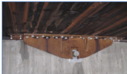
Figur 7-14: Sidestyring ved hjelp av åk og innstøpt bolt. Sundbyvegen bru
