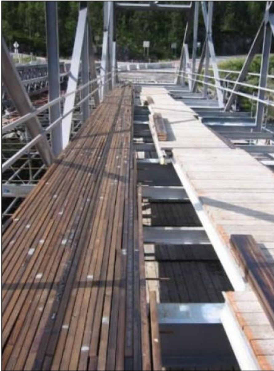
Figur 6-20: Tverrspent tredekke legges på Frøystul bru til erstatning for et gammelt betongdekke Figure 6-20: A stress laminated timber deck is replacing an old concrete deck on Frøystul Bridge
