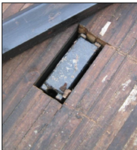
Figur 7-13: Innfelt sidestyling i dekket for utstøpning, Ner-Hole bru
