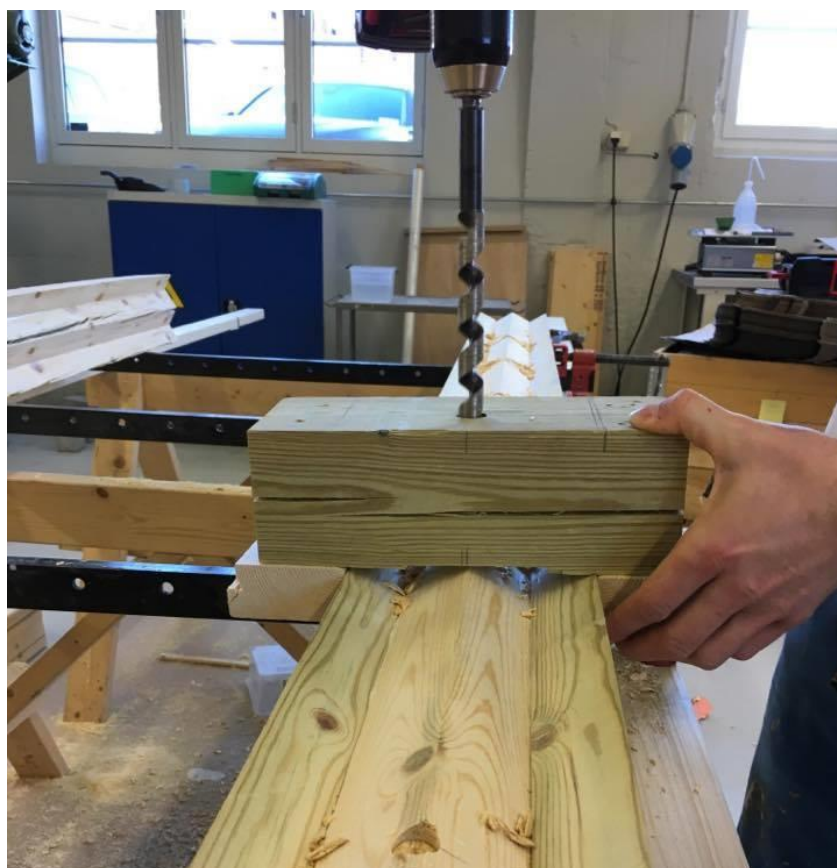
Figur 3.3: Boring av hull til gjengestenger
