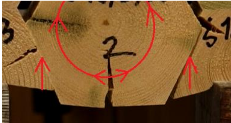
Figur 4.8: Oppsprekking i bunn av midtbjelke
