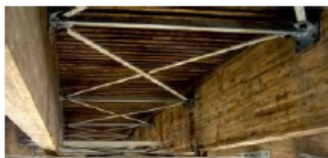
Figur 6-28: Underliggende vindavstivning mellom langbærere
