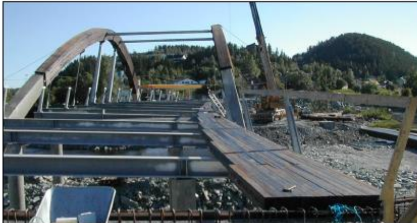
Figur 7-8: Tverrspent konstruksjonstreddekk med både horisontal- og vertikalkurvatur. Måørbrua Figure 7-8: Stress laminated deck of sawn timber with both horizontal and vertical curvature. Måør Bridge
