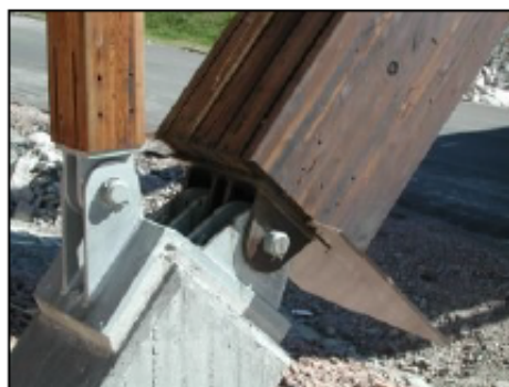
Figur 6-25: Eksempel på hemperledd med hemper-søyle
