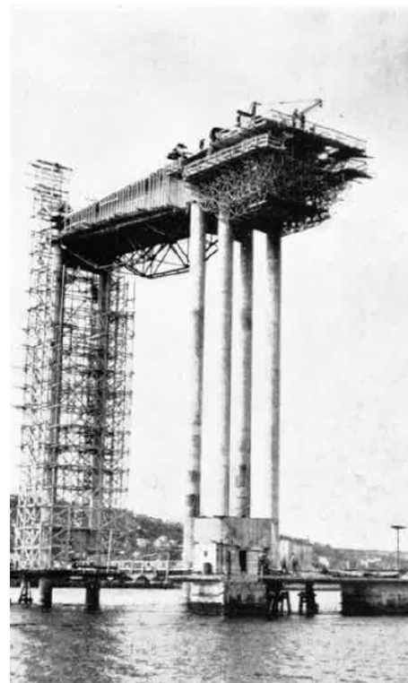
(d) Første trinn klart med forskalingsvogn [28]
