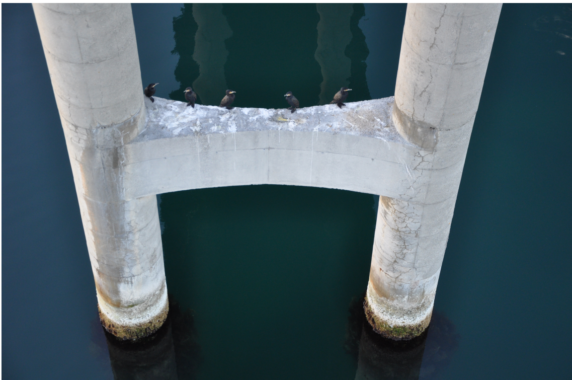
Figur 7.4: Tidevannssone og dreneringshull
