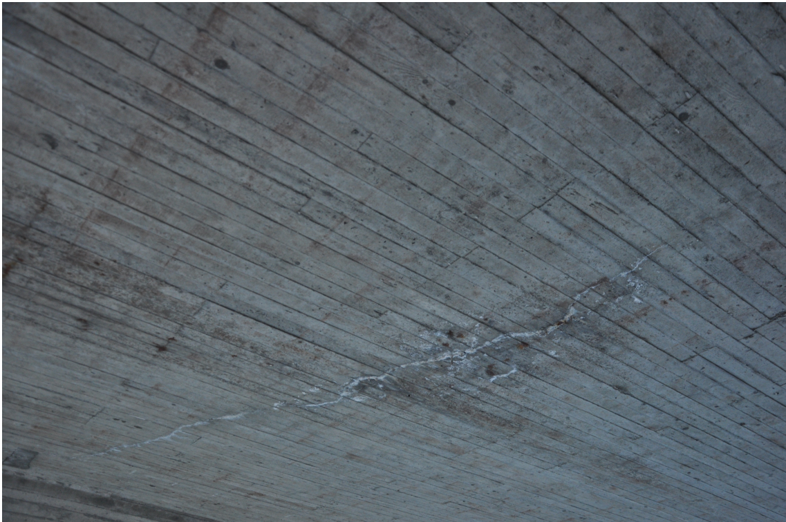
Figur 7.3: Svinnriss underside bruplate
