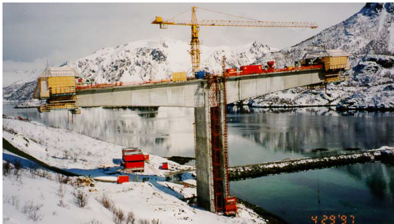
Figur 3.2: Balansert utbygging med forskalingsvogner [10]
