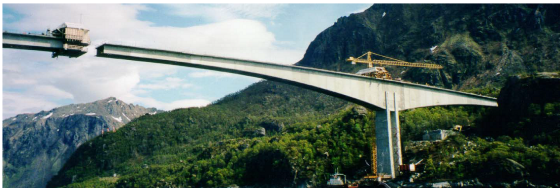
Figur 3.4: Like før sammenkobling for Raftsundet bru [10]
