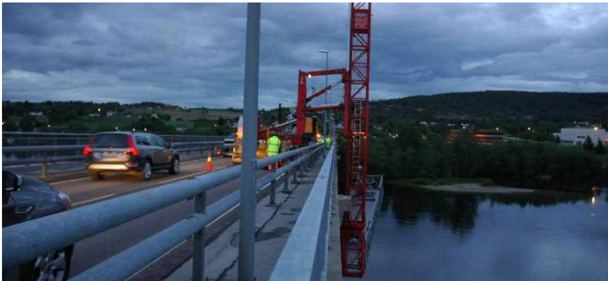
Foto 2. Inspeksjon med bruk av underbrulift i skumringen på kveldstid.
