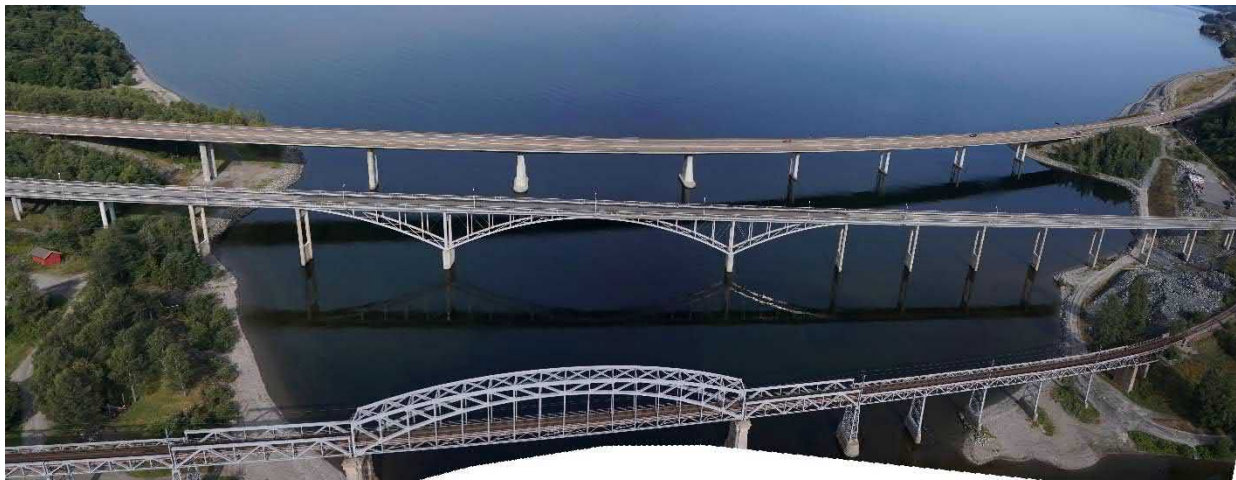
Foto 4. Et meget godt grunnlag for å planlegge videre inspeksjon av Langset og Minnesund bru.
