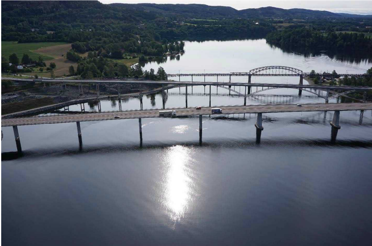
Foto 10. Minnesundbrua er godt egnet for droneinspeksjon. Lite hindringer.
