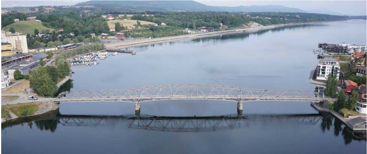
Foto 5. Hele fagverket på Eidsvoll Sundbru i et bilde. Nyttig å ha når man senere skal orientere seg i andre detaljfotoer.
