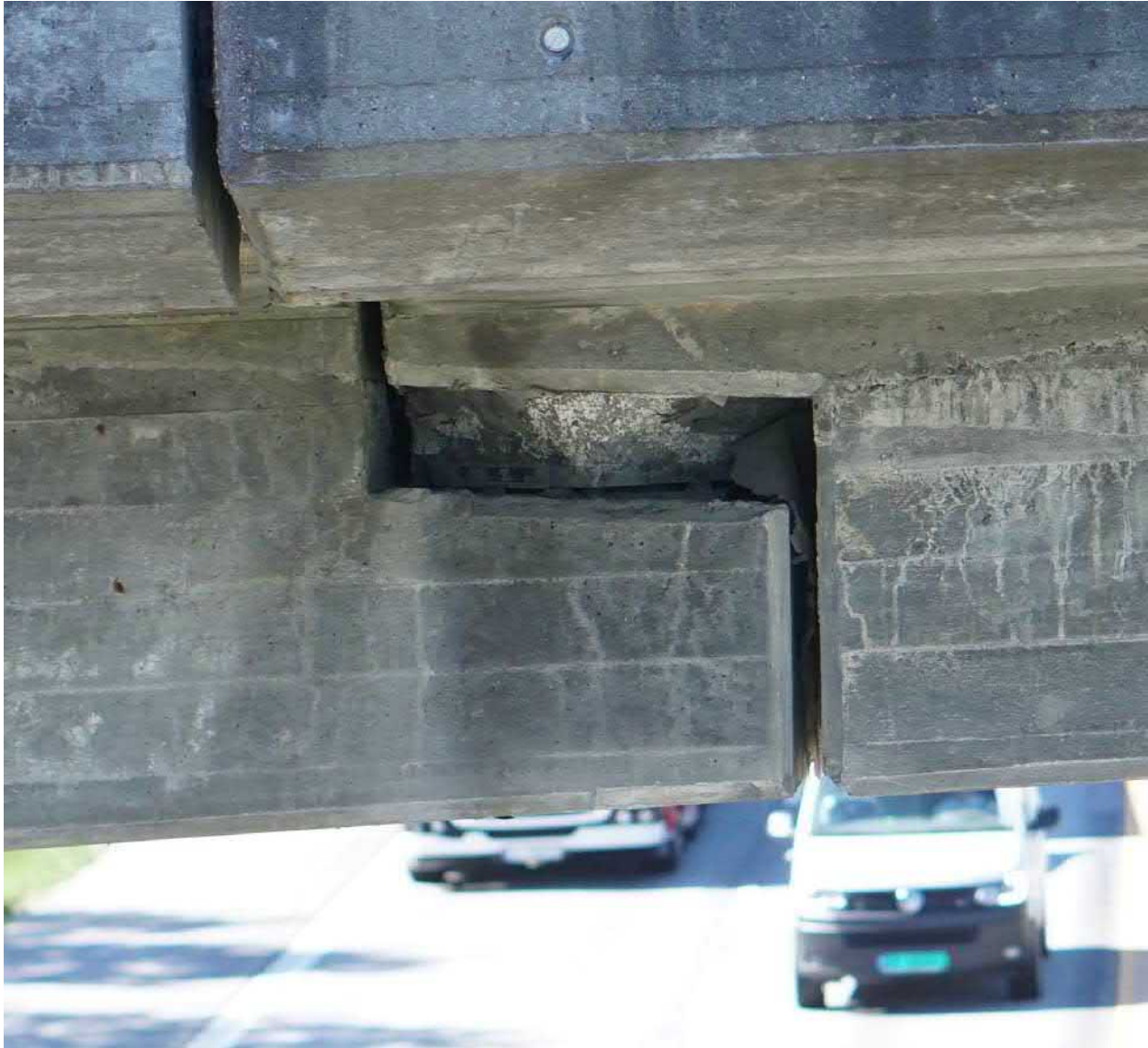
Foto 43. Foto av lageret ved innhengt spenn utført på dagtid med trafikk på E6. Detaljeringsgraden er vesentlig bedre enn vist i dette bildet.
