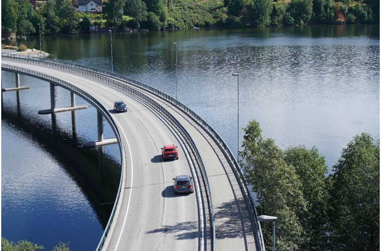
Foto 24. Eidsvollbrua ligger i kurvatur. På høyre side av brua kreves det mer forflytning av dronepiloten for å fly VLOS. Vegetasjonen hindrer dronens flymønster. Posisjoneringen til dronen er avgjørende for å få riktige bilder.
