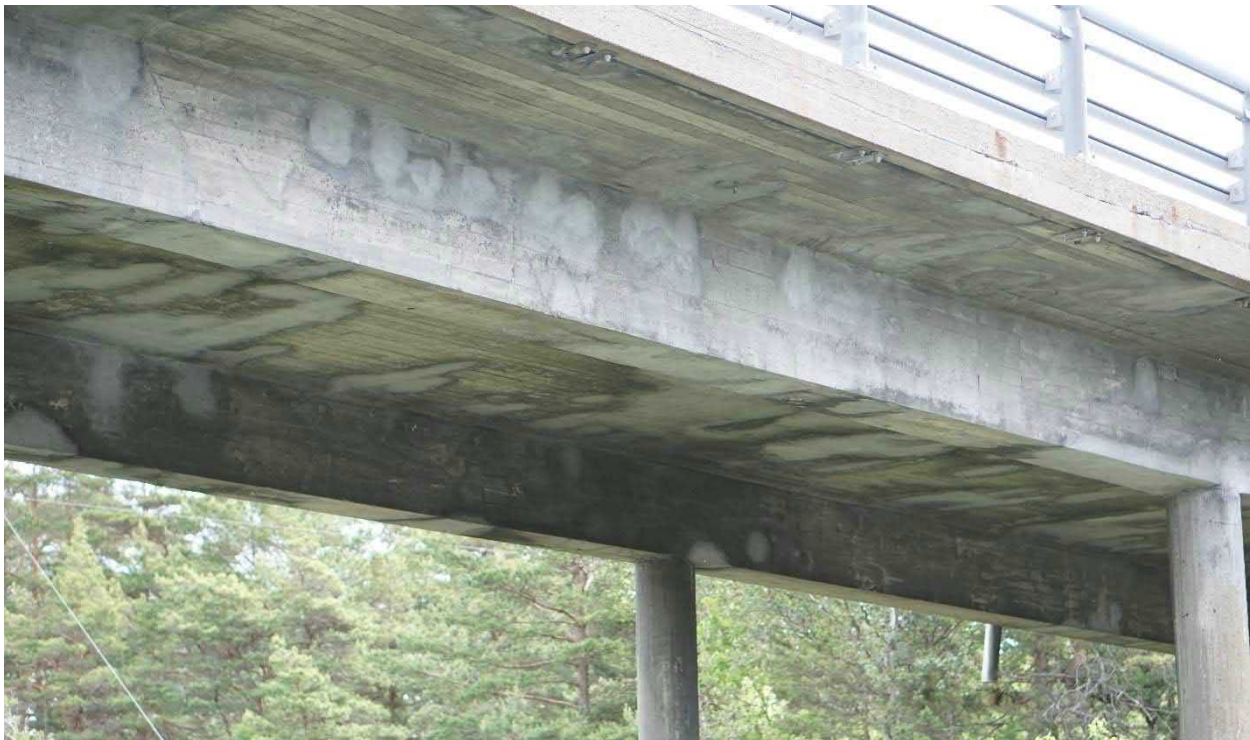
Foto 36. Bru med mange betongreparasjoner, der vi ønsket å vurdere reparasjonene med hjelp av brulift utført av entreprenør.
