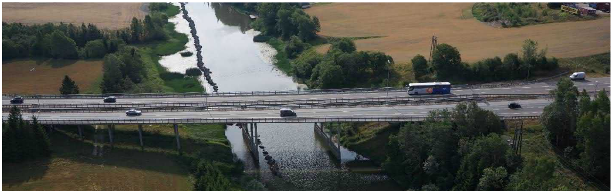
Foto 25. De høytrafikkerte Nitsundbruene ligger tett ved siden av hverandre. Brulift mellom bruene er ikke mulig. Brulift kan bare benyttes på nattestid her. Dette ville gitt deg et mye dårligere bilde av detaljer og omfang.
