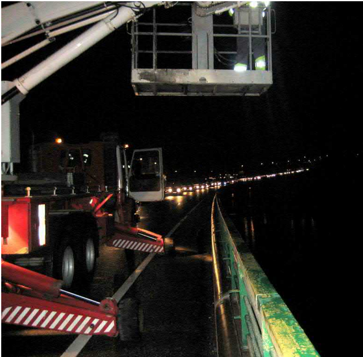
Foto 3. Hovedinspeksjon av Minnesundbrua utført i 2007 med bruk av underbrulift.
