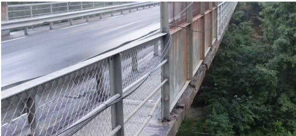
Foto 29. Bru med kantdrageravskallinger. Fotoet er tatt fra bakkenivå ved siden av brua. Bedre bilde kunne vært tatt med kamera på selfie-stang, men best med drone.
