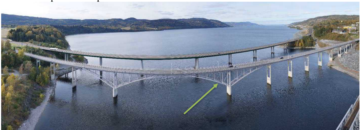
Foto 27. Dronefoto av Langset bru. Underbruliften hadde ikke kommet under stålbuene midt i bildet.
