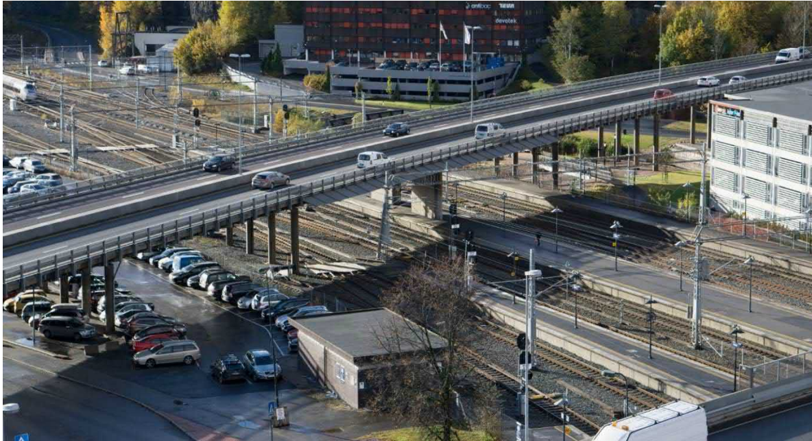
Foto 45. Askerbrua med kompleks infrastruktur rundt brua.
