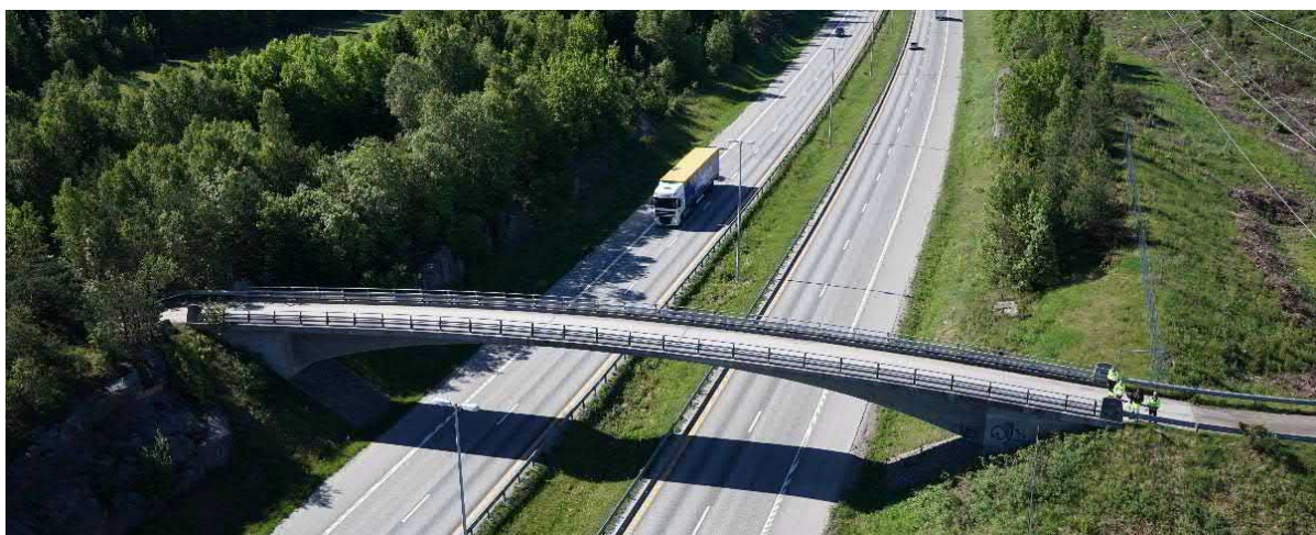
Foto 42. Inspeksjon av Tømt bru over E6. Siden brua går over E6 ville alternativet vært nattinspeksjon.
