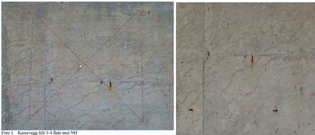
Foto 1 Kassevegg felt 3-4 flate mot NO
