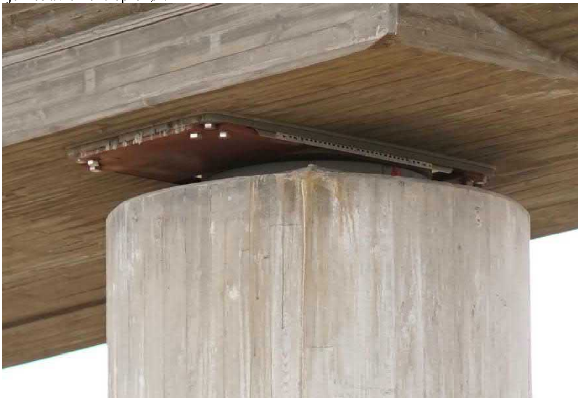
Foto 38. Midlertidig fastholding av glidelagrene ble ikke fjernet etter ferdigstillelsen.
