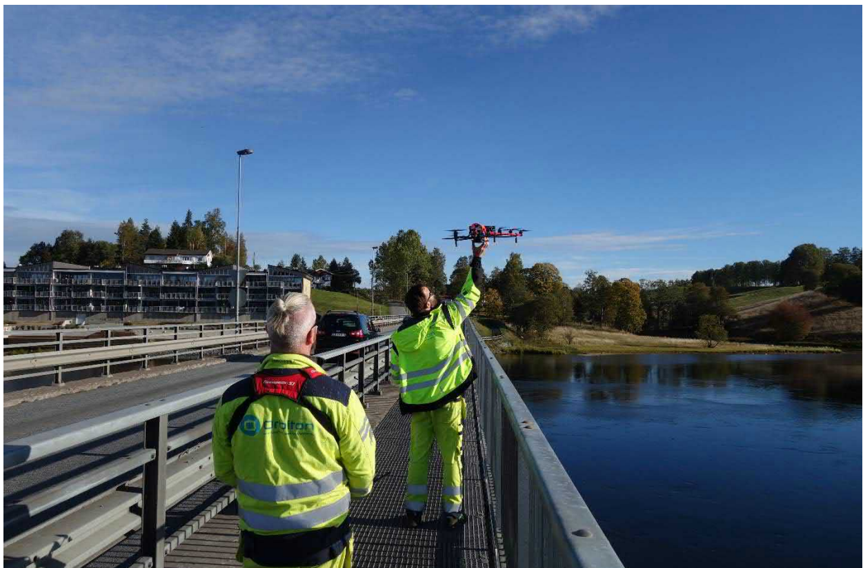
Foto 1. Drone som er benyttet til bruinspeksjon i 2015-2018.
