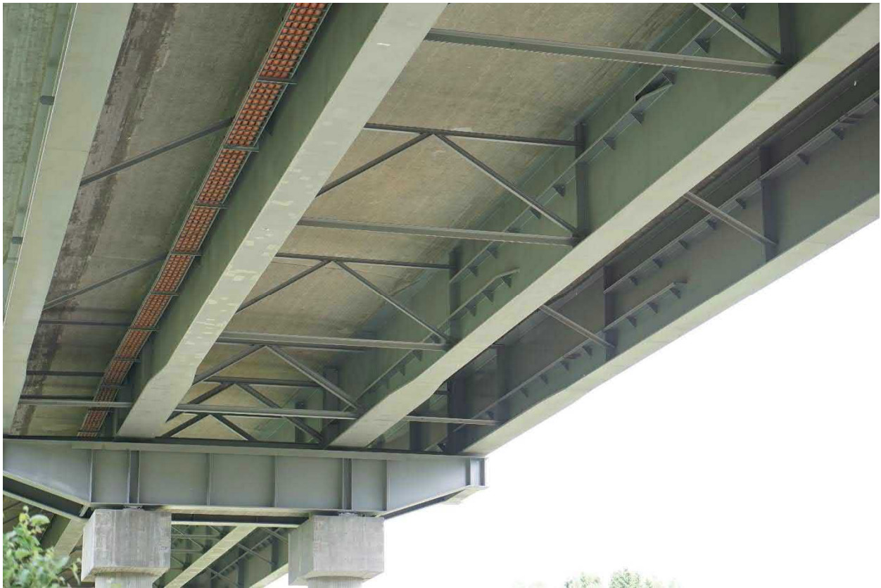
Foto 22. Julsrudbrua kartlagt med kamera fra drone i 2018. Veldig god kvalitet på bildene siden det er gode lysforhold og ingen andre hindringer. Inspeksjon overkant kabler ved den andre hovedbjelke er ikke mulig pga. den første bjelkens høyde. Inspeksjon overkant underflens krever at droneball flys.
